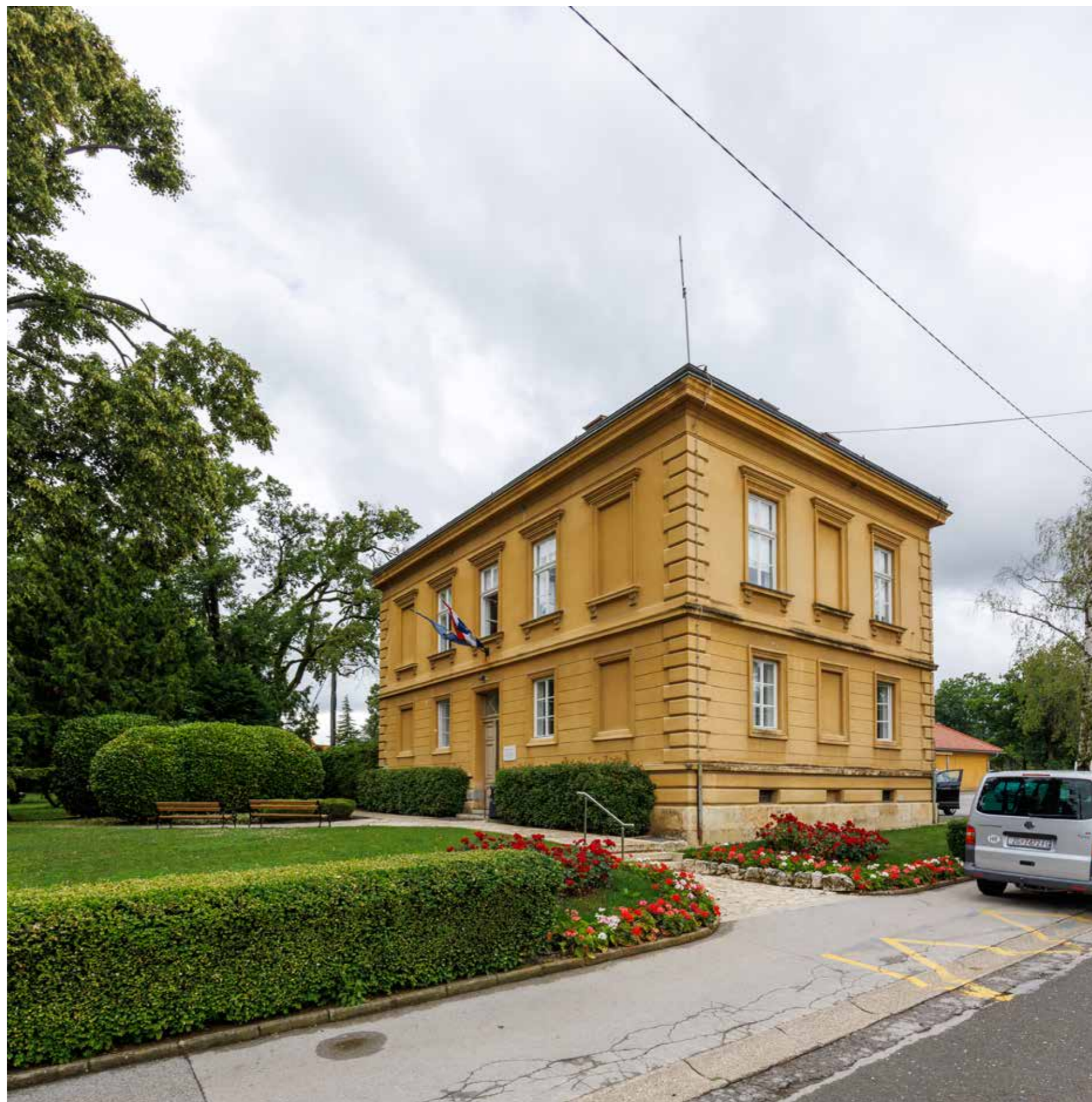
Upravna zgrada groblja Mirogoj
