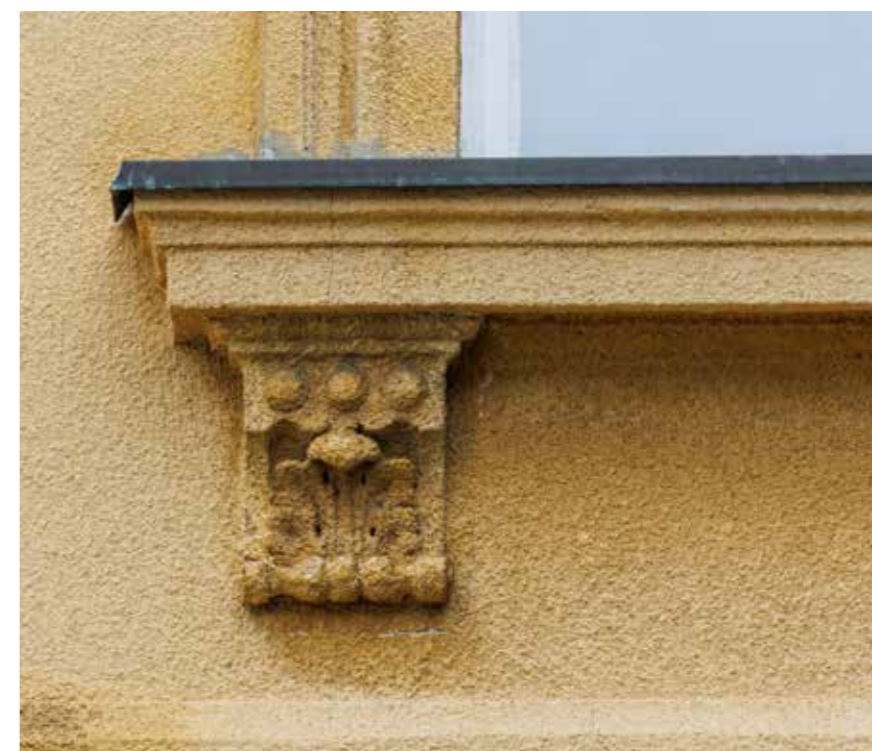
Sjeverno, stražnje pročelje Konzola prozorske klupčice prozora prvog kata
