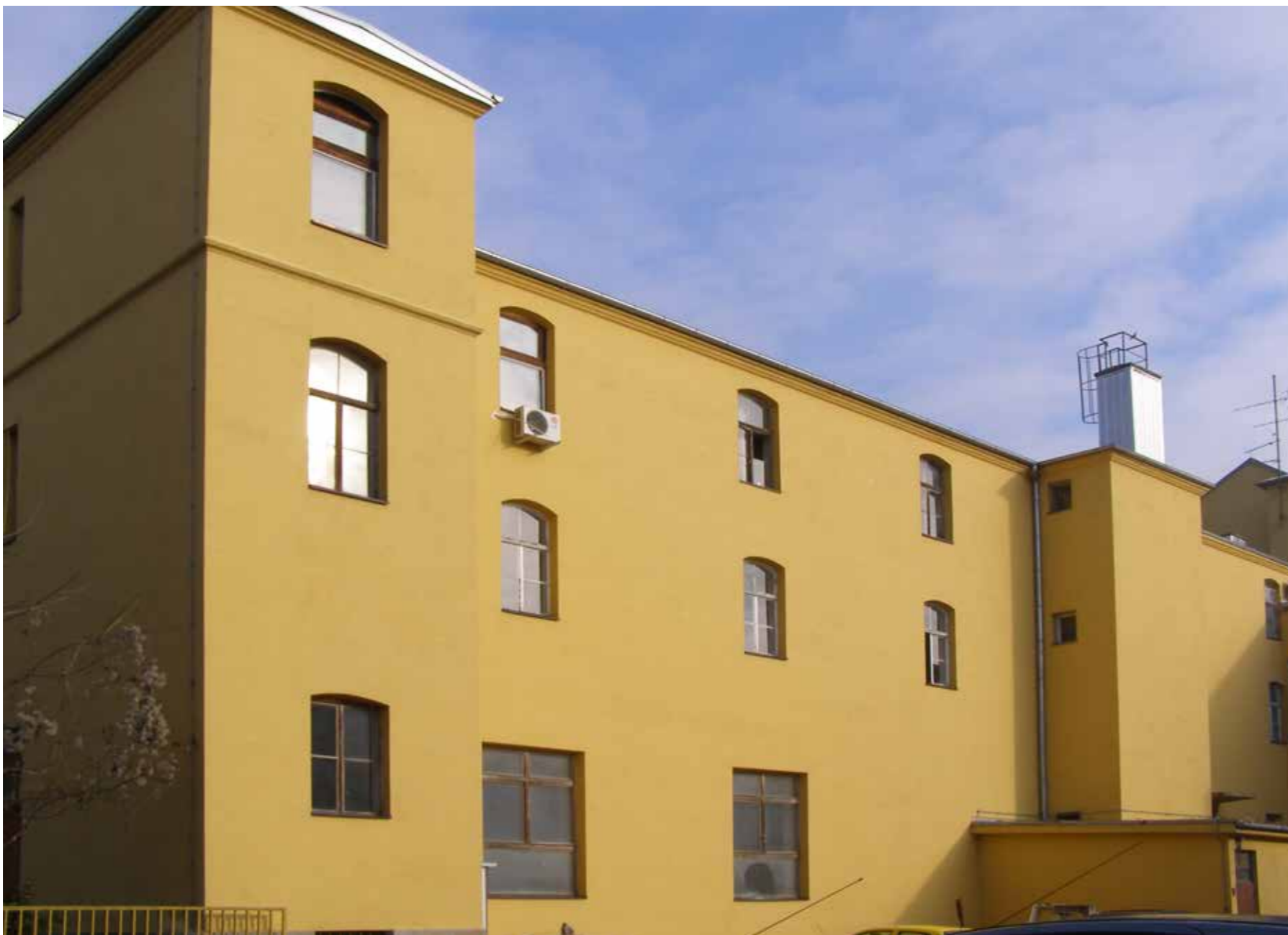
Akademija likovnih umjetnosti u Zagrebu, južno pročelje, pogled na prvu zgradu Umjetničkih atelijera prema projektu Hermana Bolléa
