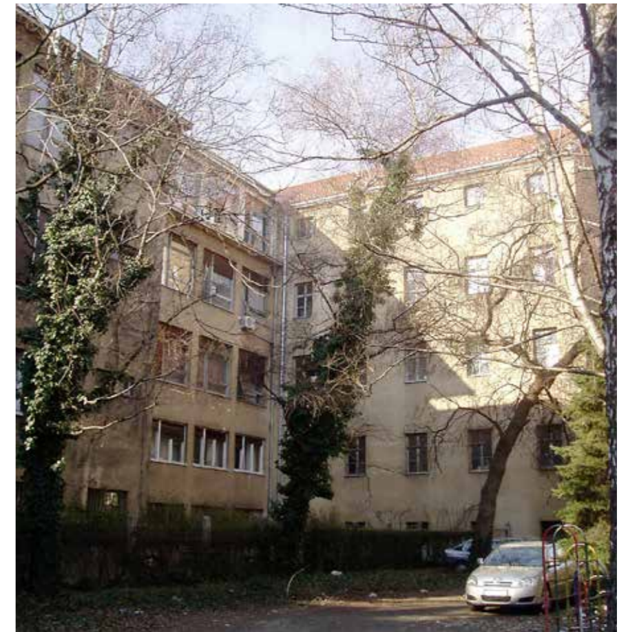
Istočno pročelje Geršićeve dogradnje • Spoj Ivekovićeve i Geršićeve zgrade
