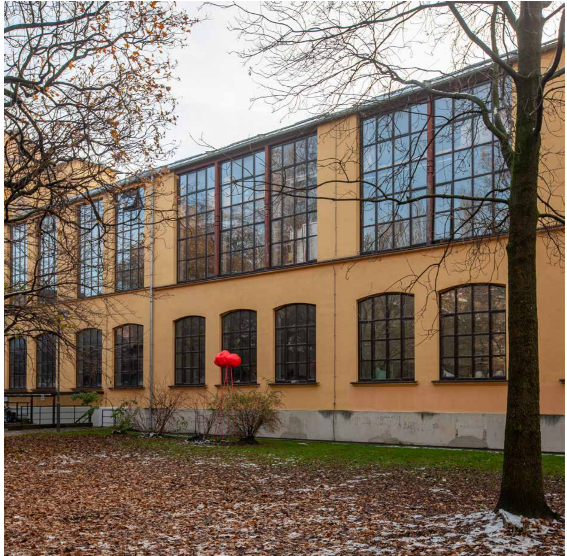
Spoj Bolléove i Grossove zgrade
