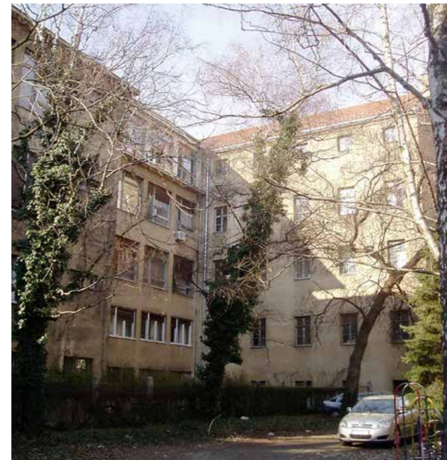
Istočno pročelje Geršićeve dogradnje • Spoj Ivekovićeve i Geršićeve zgrade
