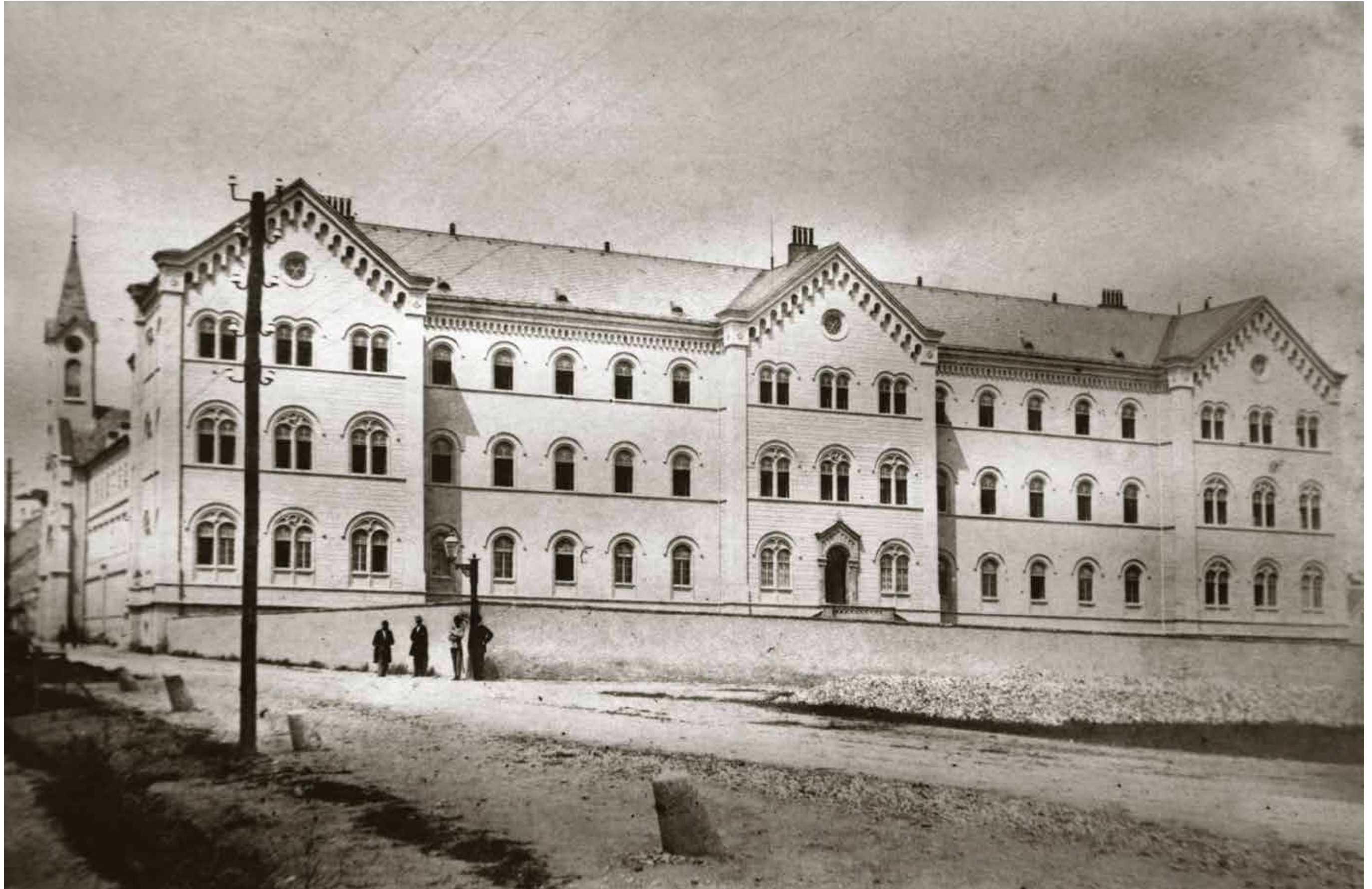
Zgrada Opće bolnice / izložbenog prostora 1864., foto: Ludwig Schwoiser
