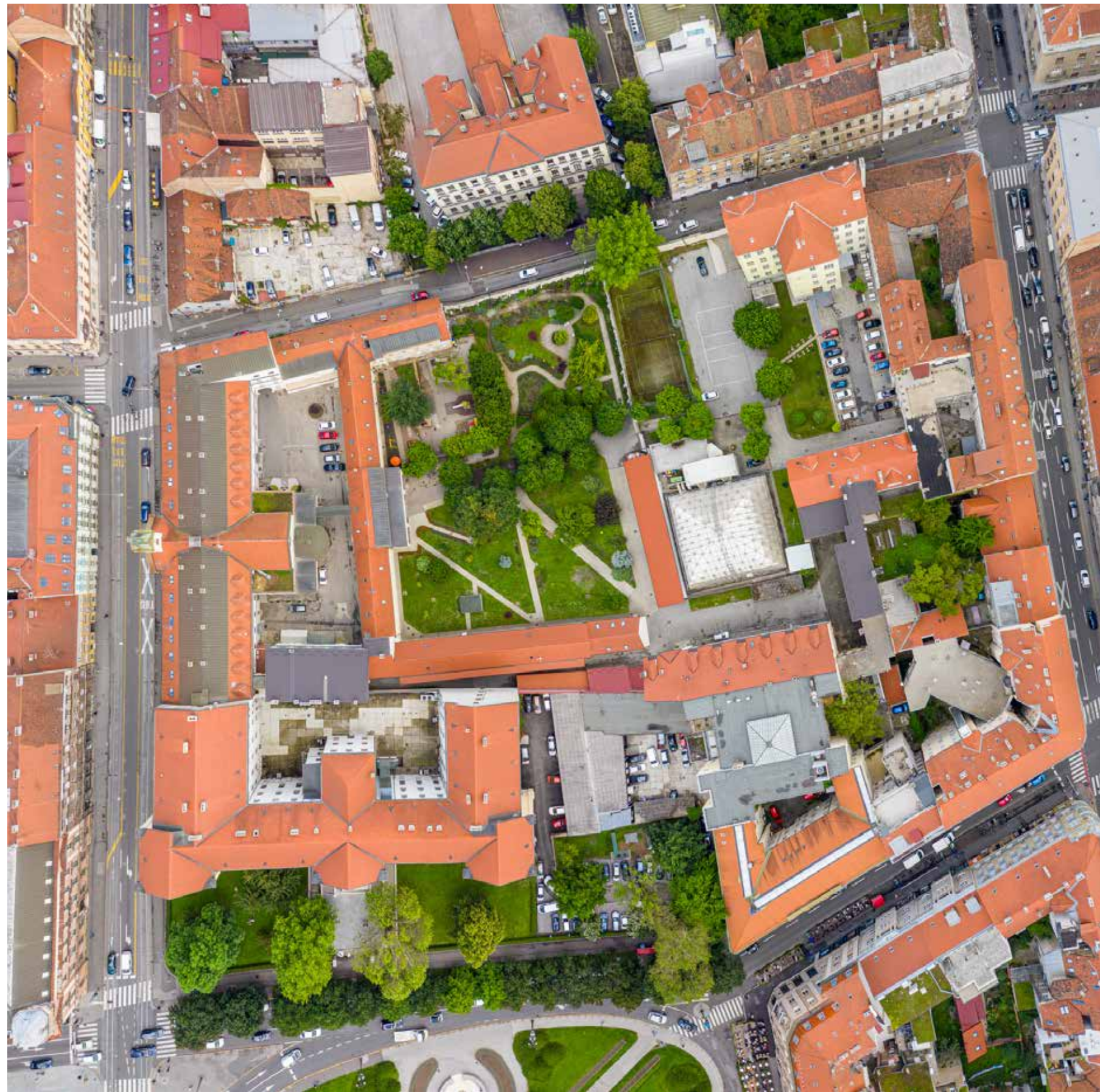
Blok između Gundulićeve, Varšavske, Frankopanske i Trga Republike Hrvatske sa zgradom Sveučilišta u jugozapadnom dijelu
