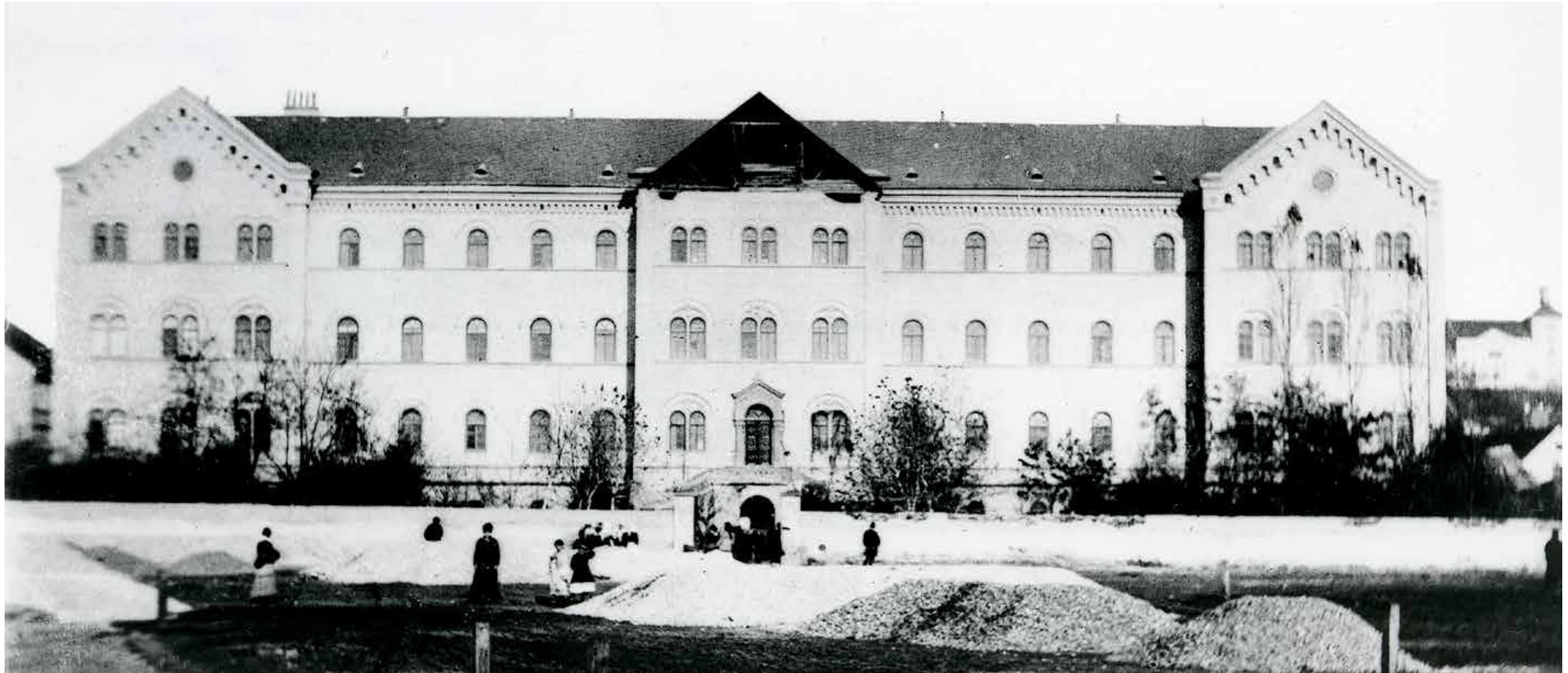
Zgrada Tvornice duhana s vidljivim oštećenjima u potresu 1880., foto: Hermann Fickert, 1882.
