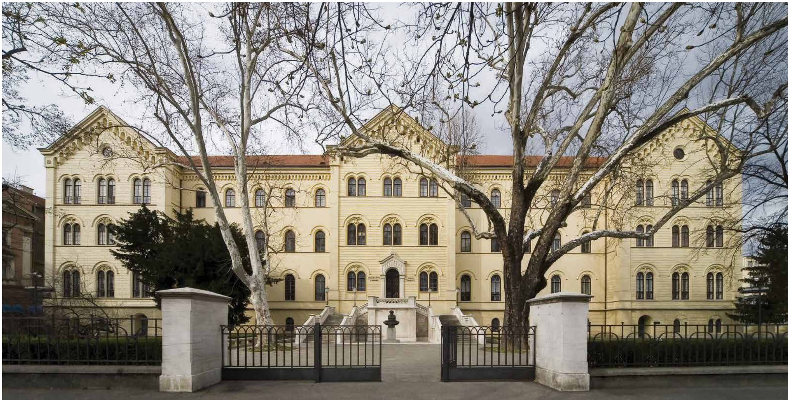
Južno pročelje, foto: Filip Beusan, 2008.
