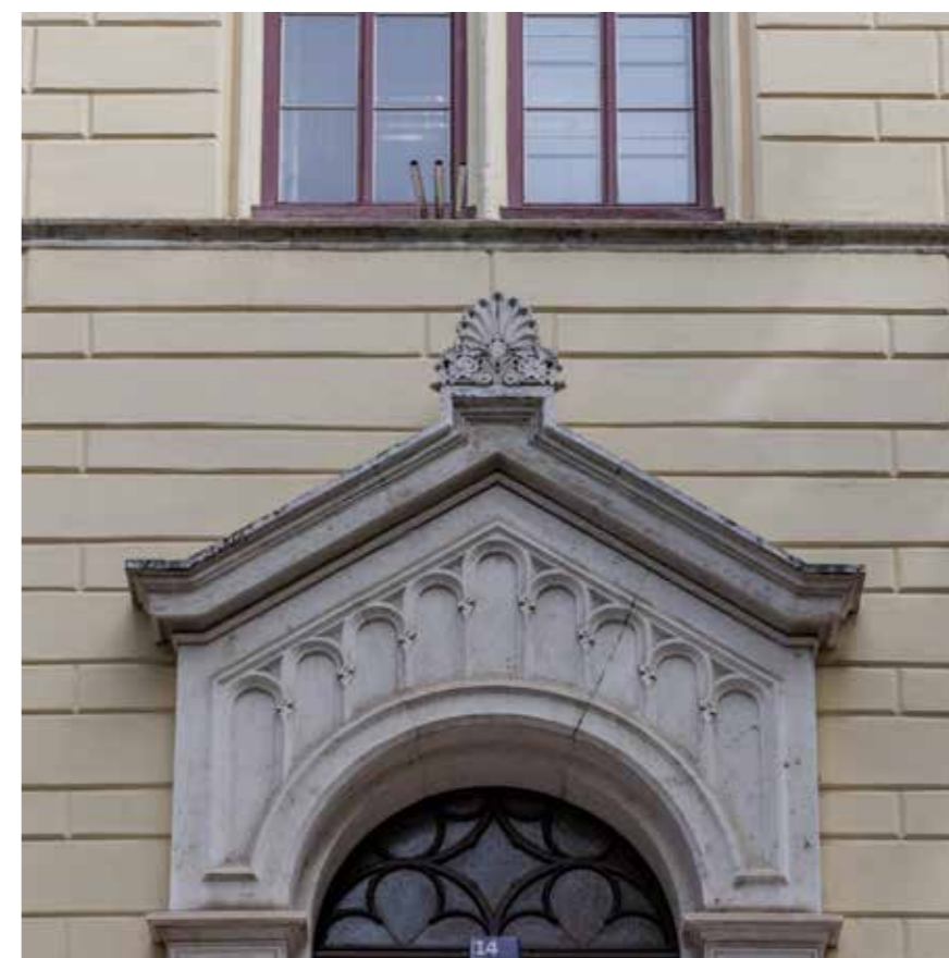
Detalj glavnog portala i bifora
