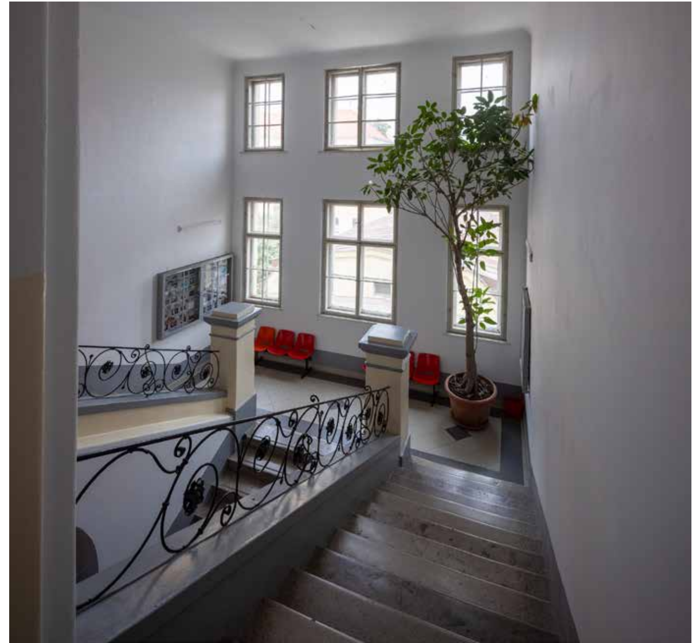
Glavno stubište u Ženskoj stručnoj školi (Rooseveltov trg 6) izvedeno prema projektu Kune Waidmanna 1893.
