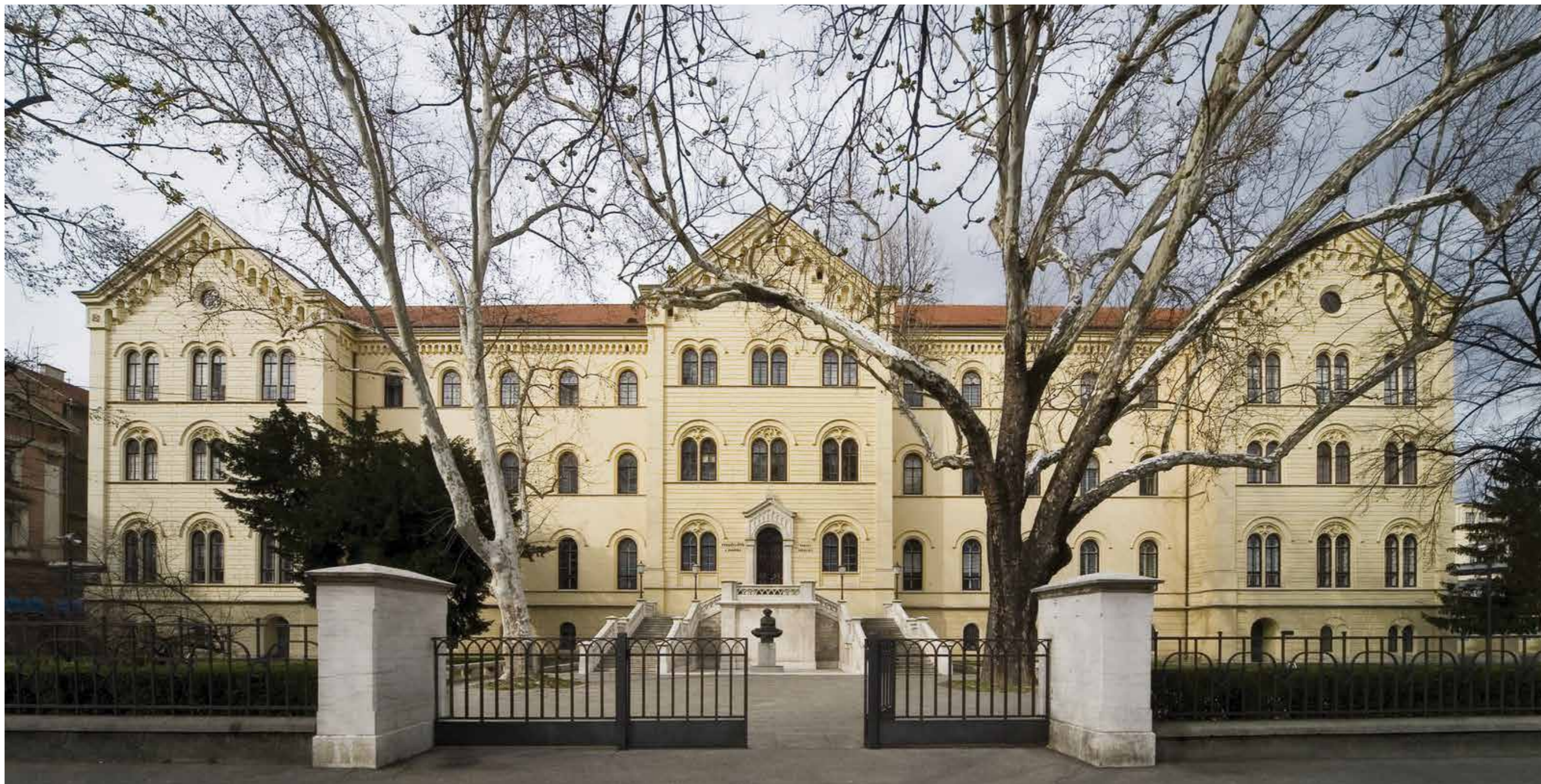
Južno pročelje, foto: Filip Beusan, 2008.
