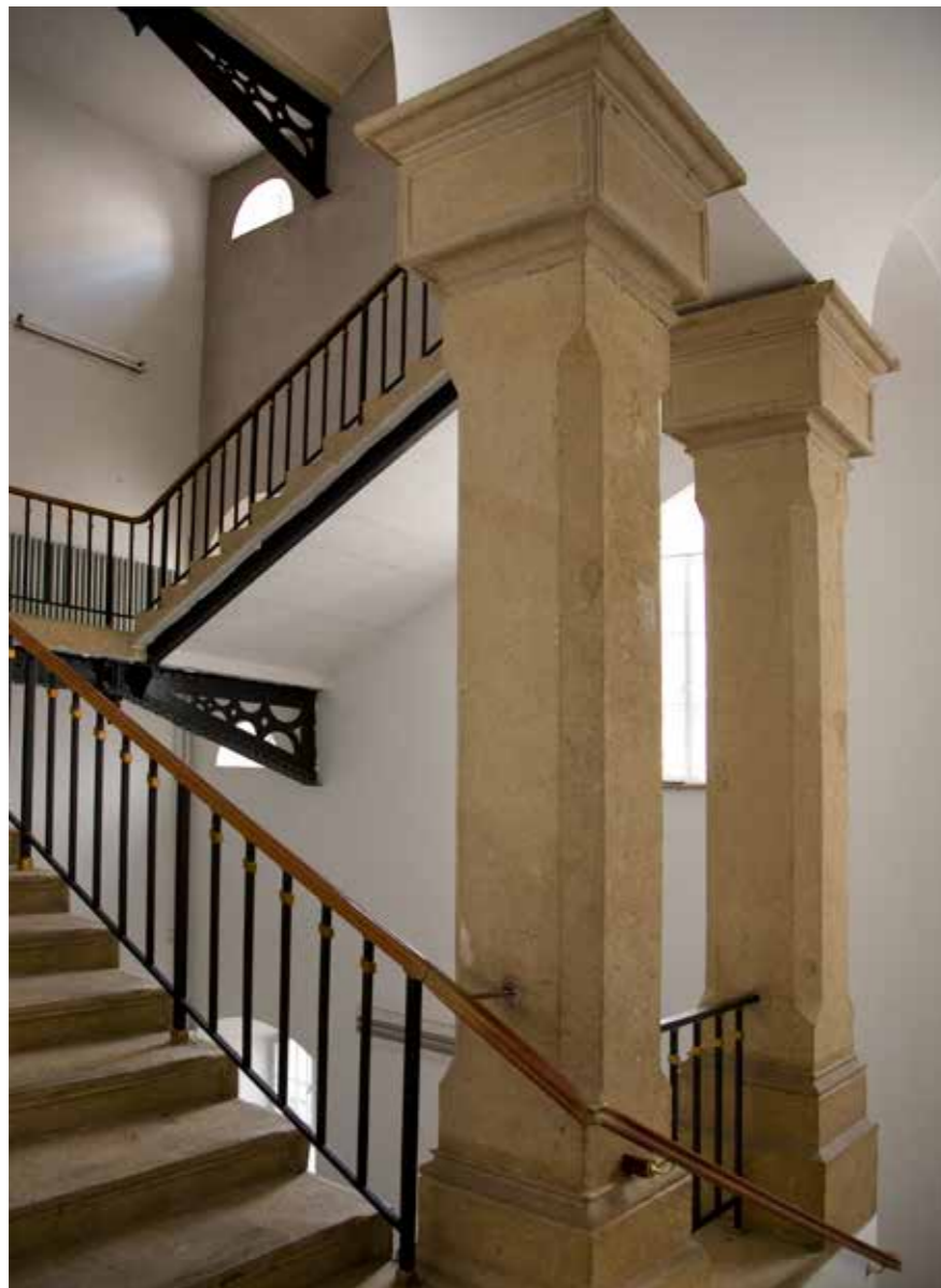
Bočno stubište prije obnove 2009., foto: Danilo Balaban, 2008.
