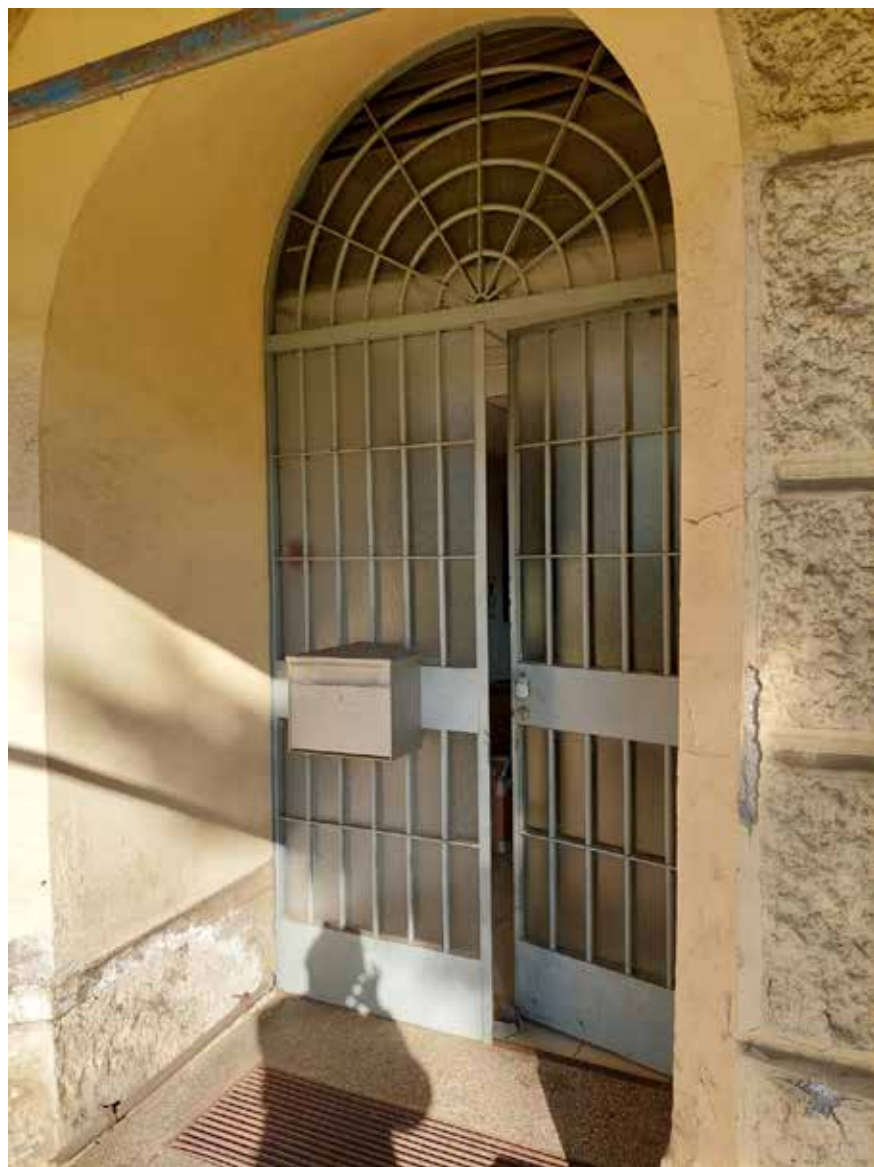
Vratnice ulaza u suteren izvedene prema projektu Jurja Denzlera
