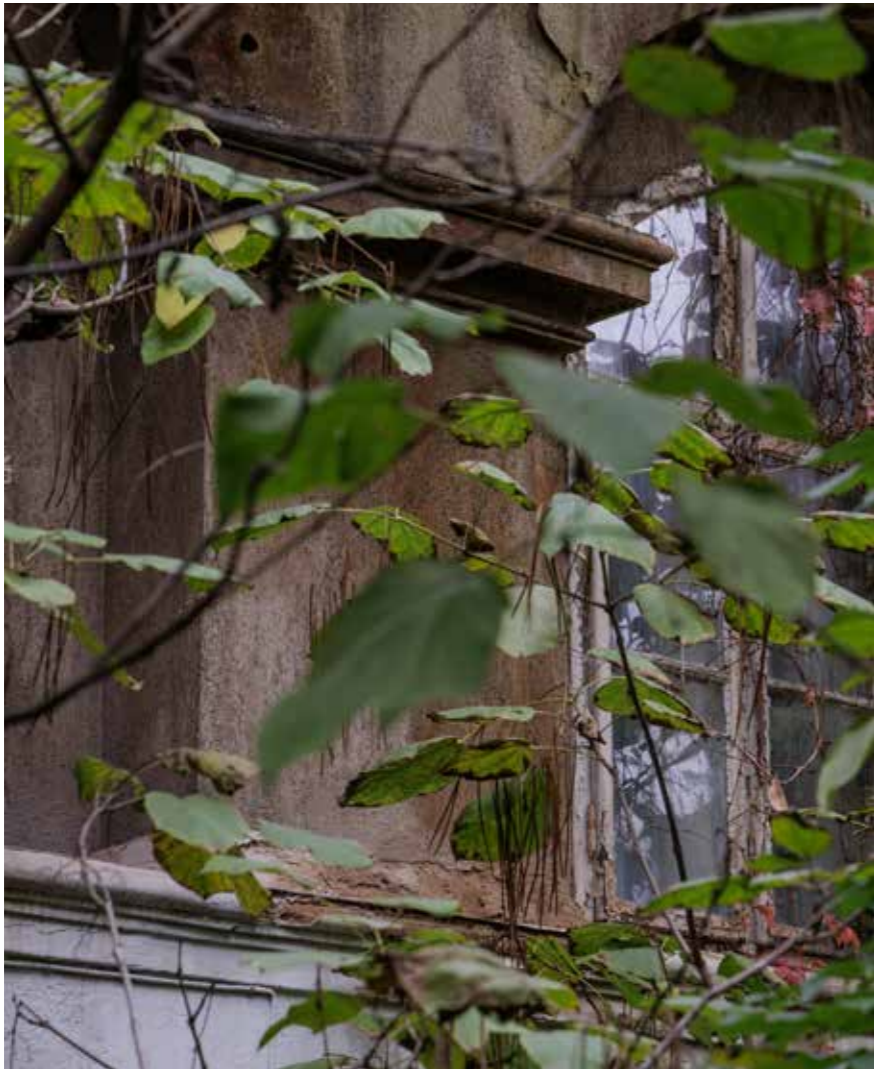
Trijem na dvorišnom pročelju, detalj
