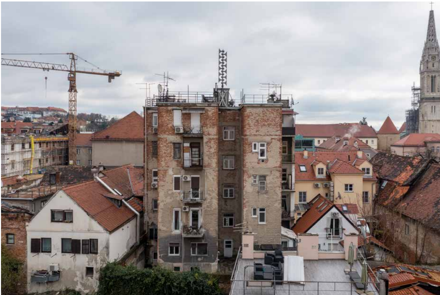
Zapadno začelje poviše gradskog zida
