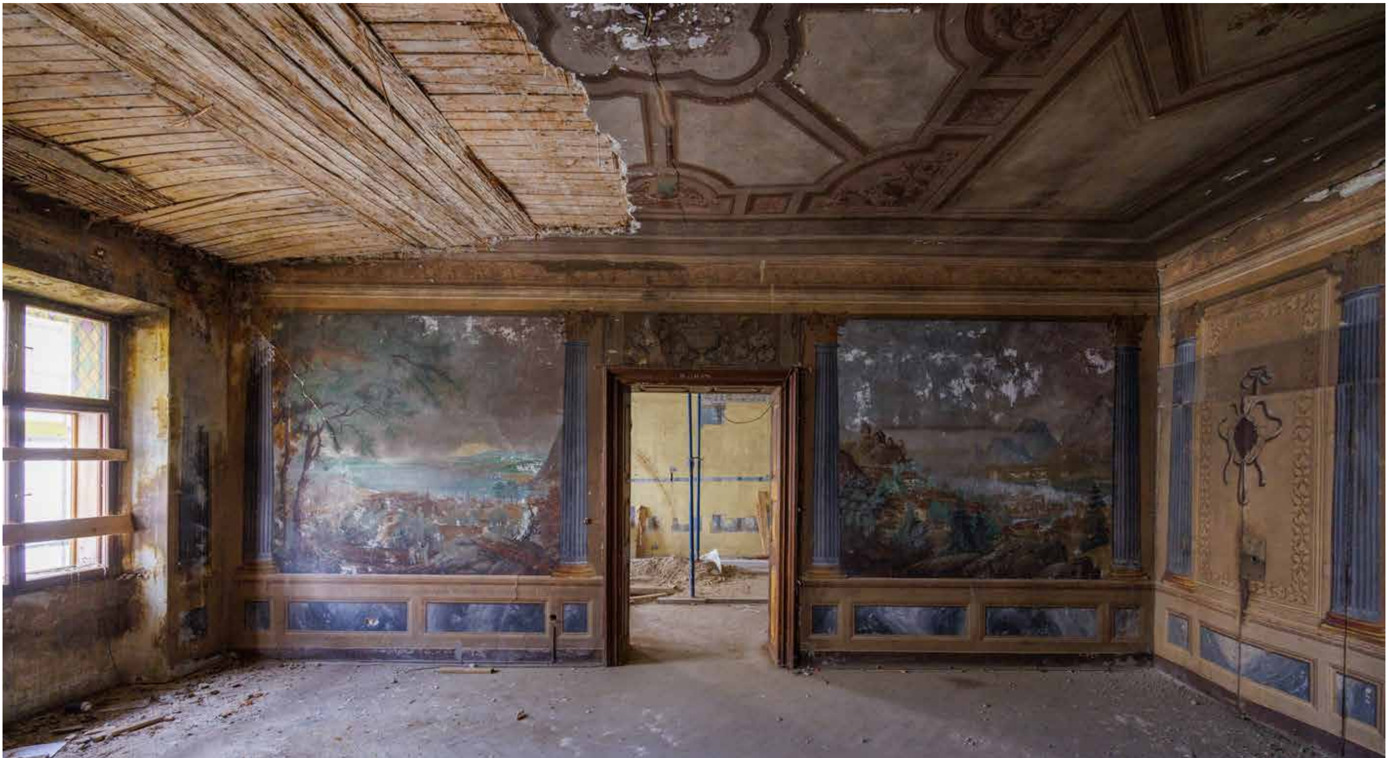
Prostorije na katu sa zidnim slikama
