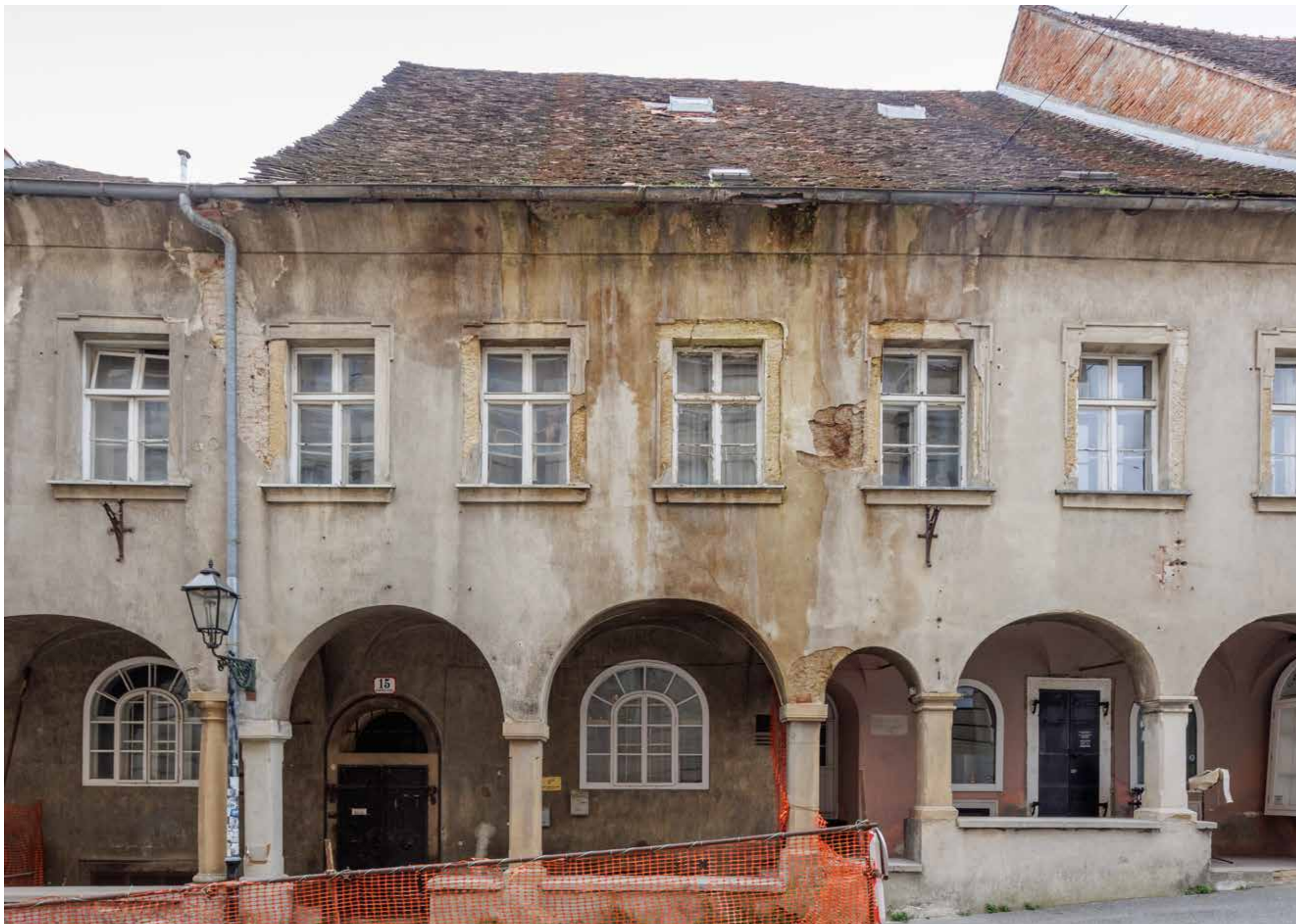
Sjeverno pročelje s trijemom
