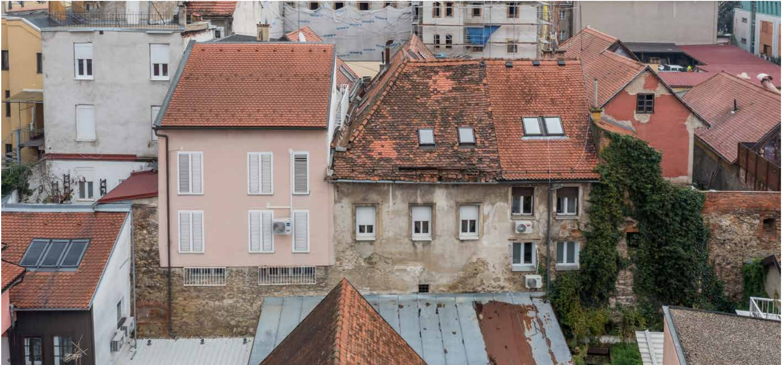
Zapadno začelje na gradskom zidu
