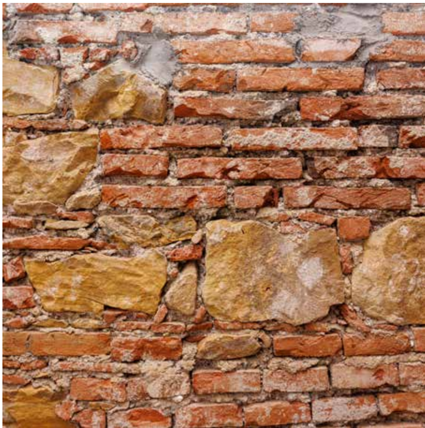
Detalji zida i svoda
