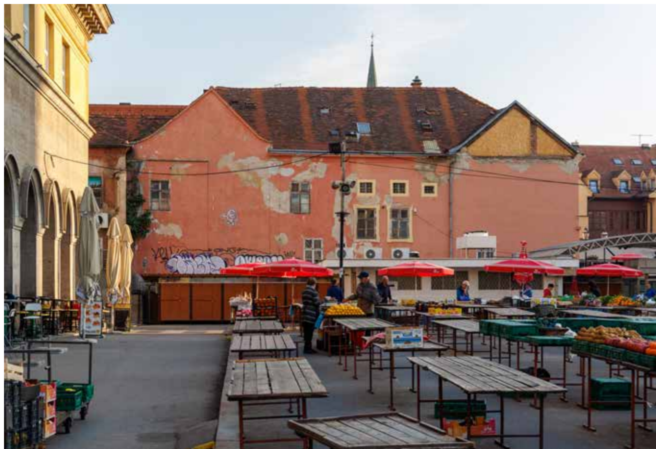
Južno pročelje (oslobođeno rušenjem kuća na Dolcu 1925.)
