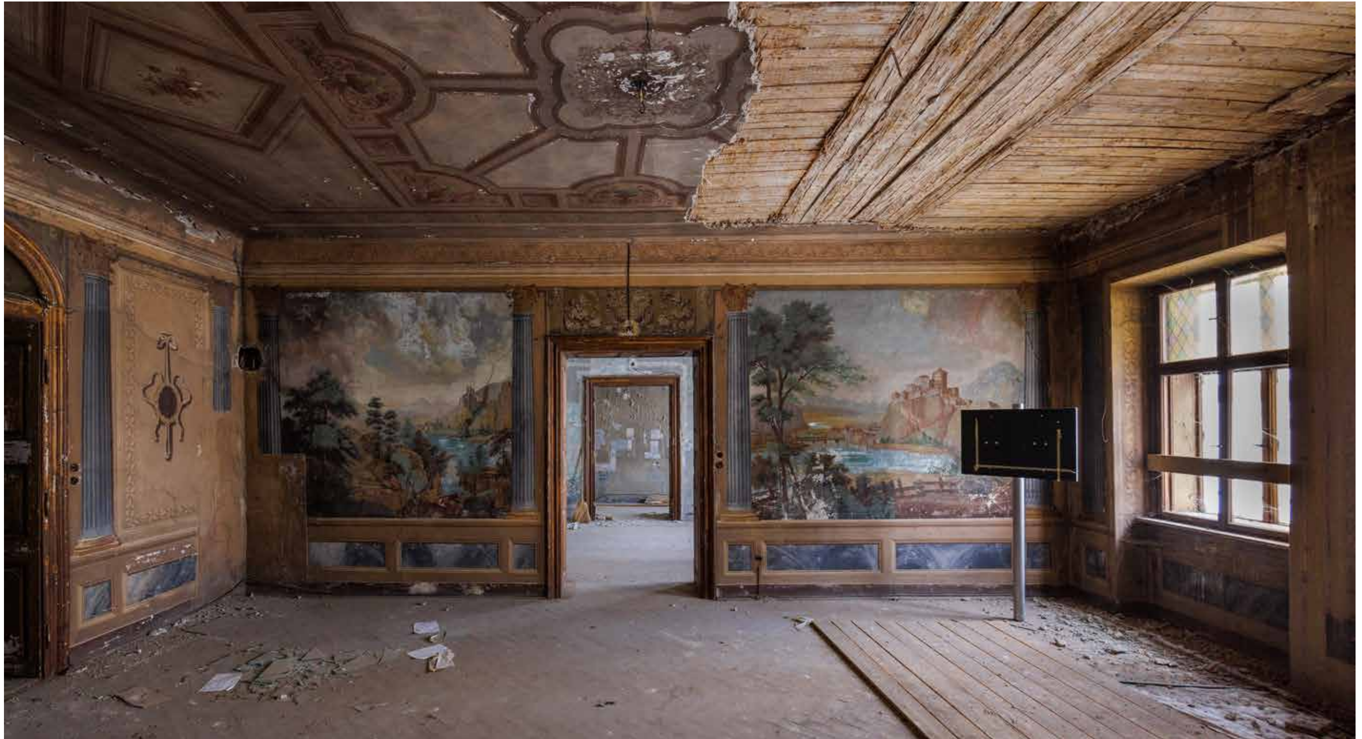
Prostorije na katu sa zidnim slikama
