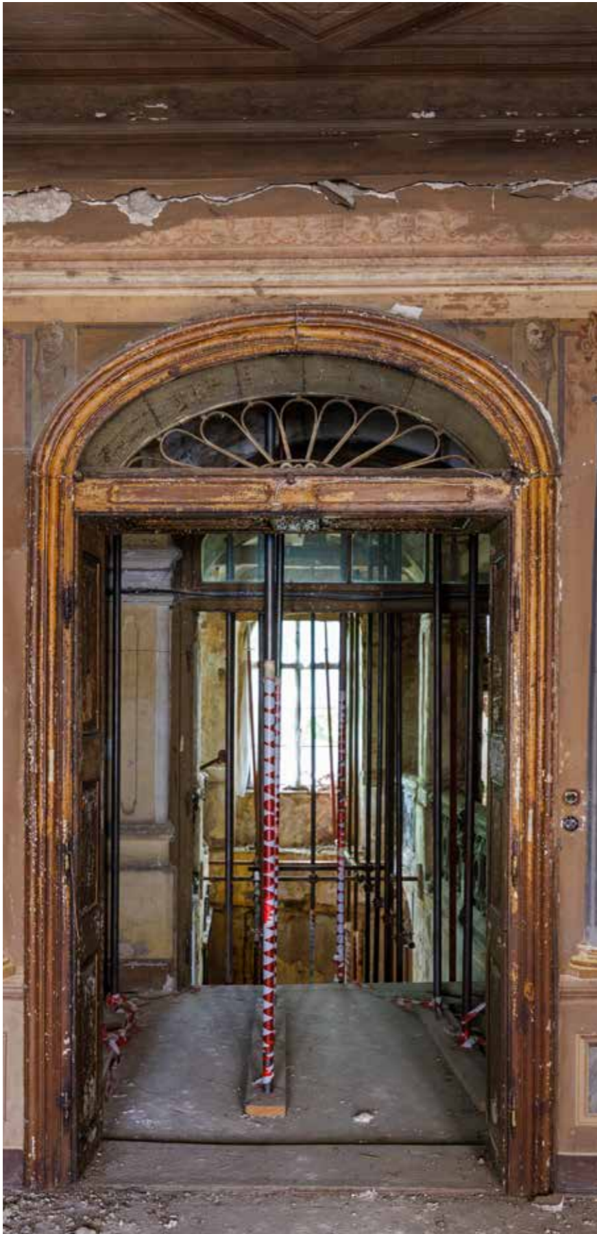
Vrata prema stubištu
