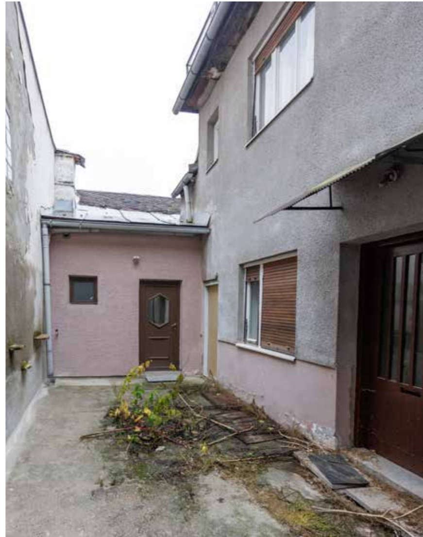
Južno pročelje i prigradnja u dvorištu
