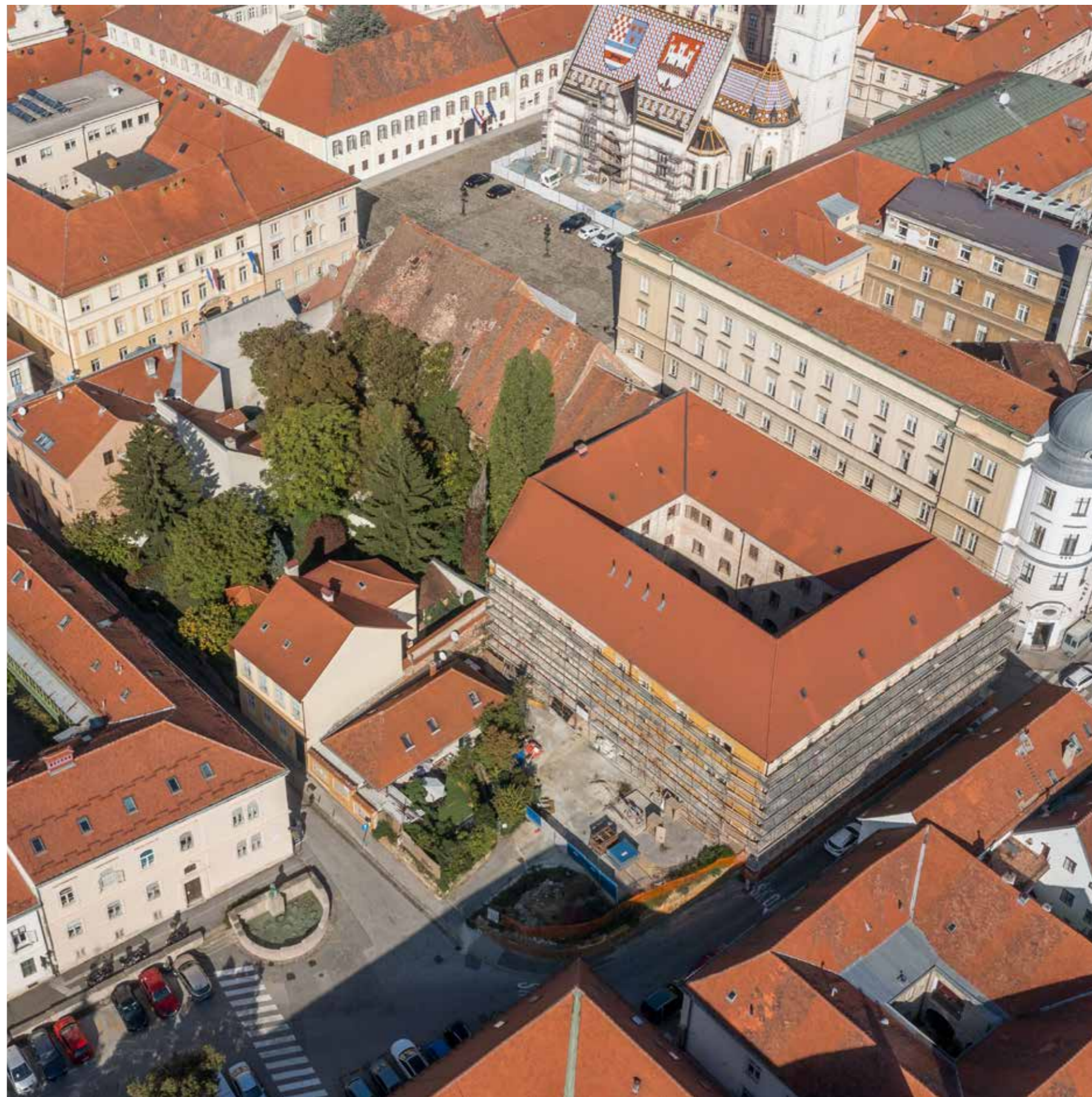
Blok 11, pogled s jugoistoka
