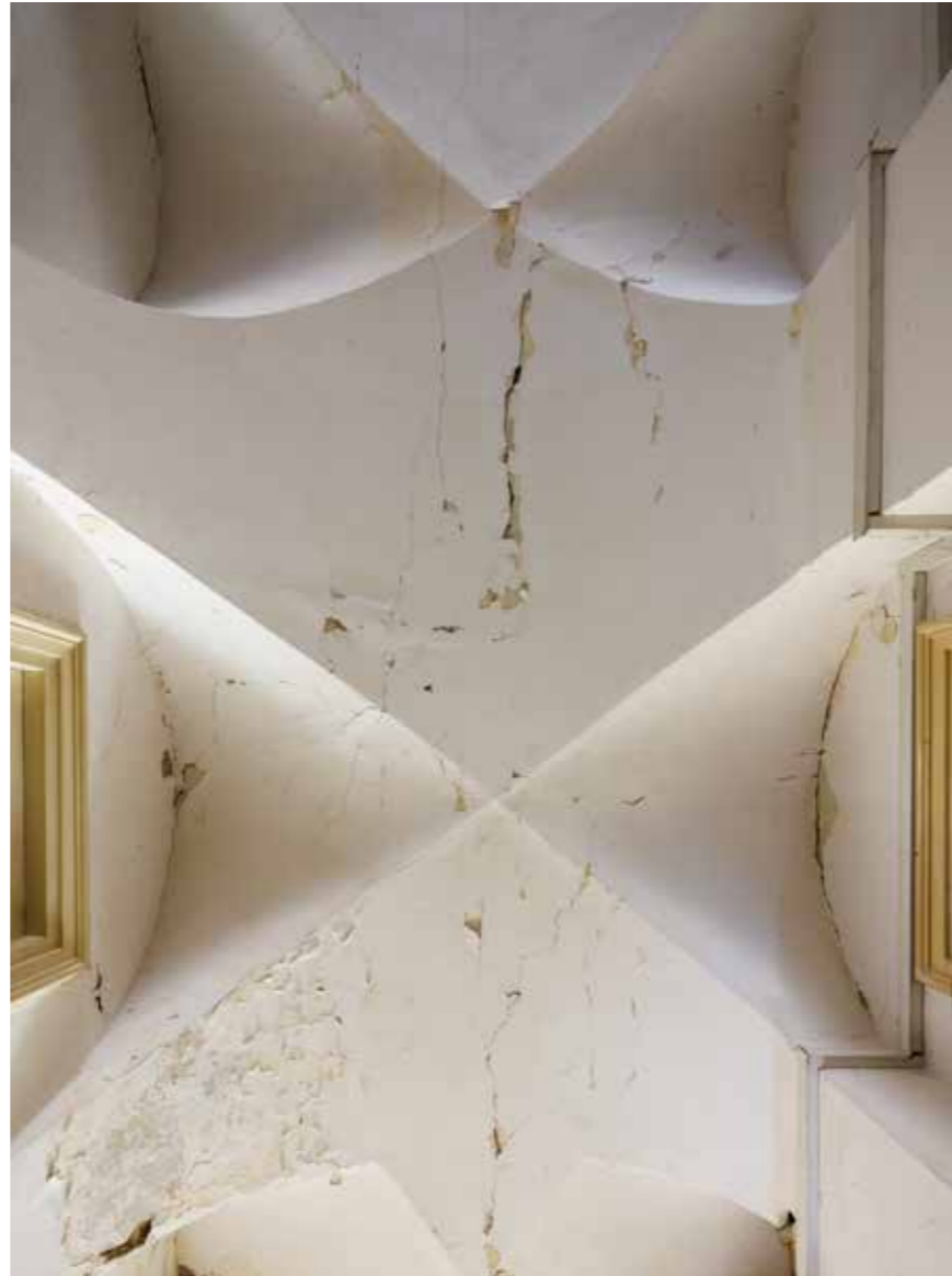
Kuća Miletić (kbr. 11), svodovi u veži
