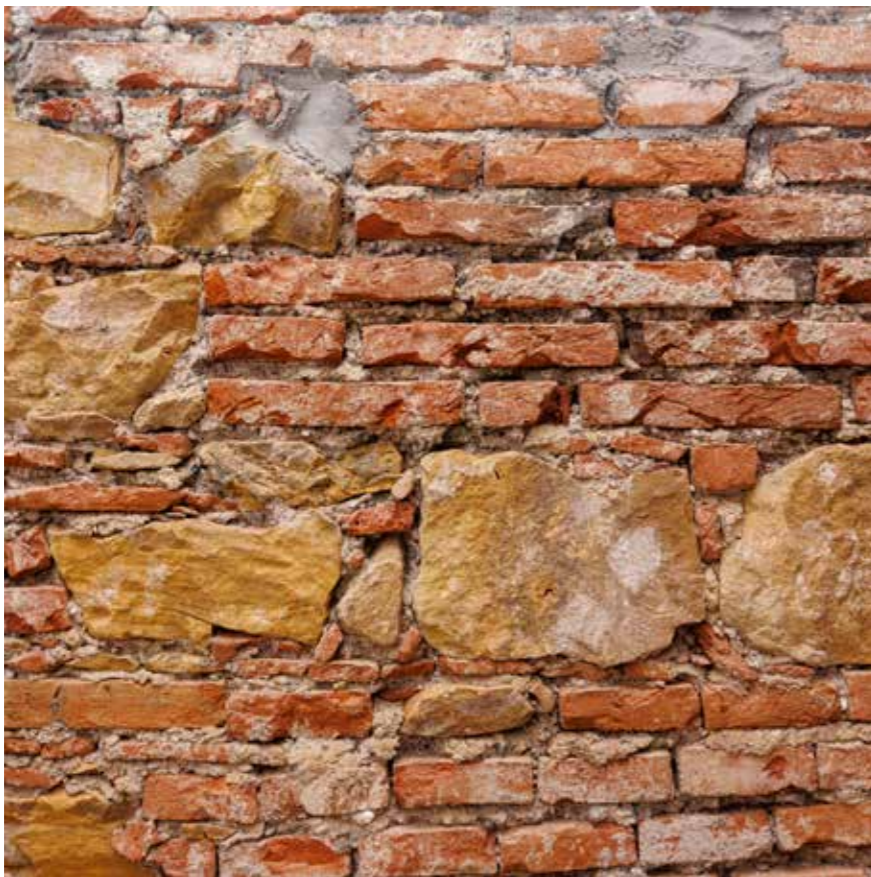
Detalji zida i svoda
