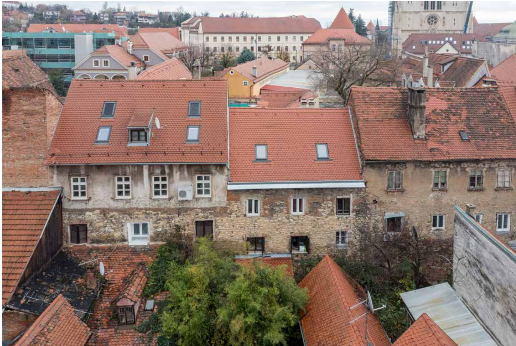
Zapadno začelje na gradskom zidu
