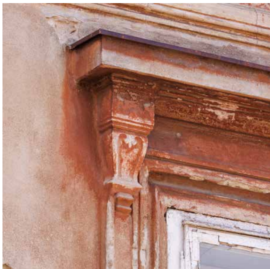
Dograđeno krilo, detalji pročelne plastike
