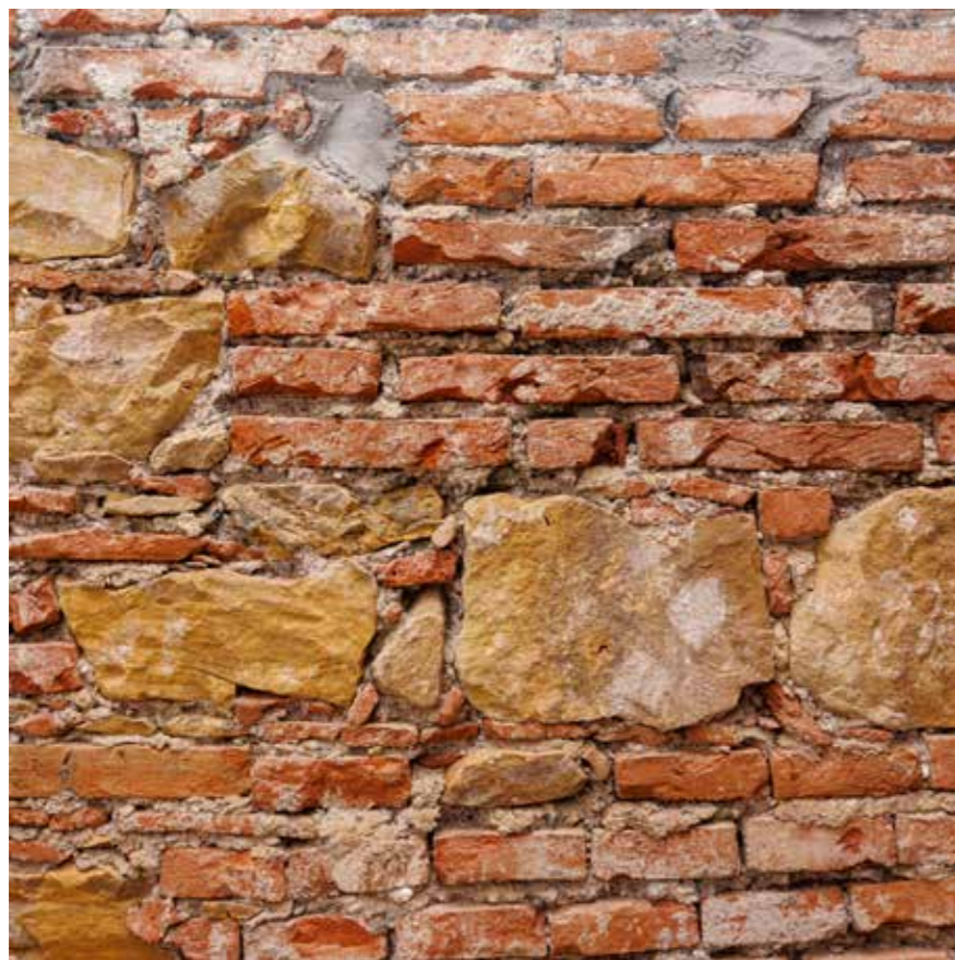
Detalji zida i svoda
