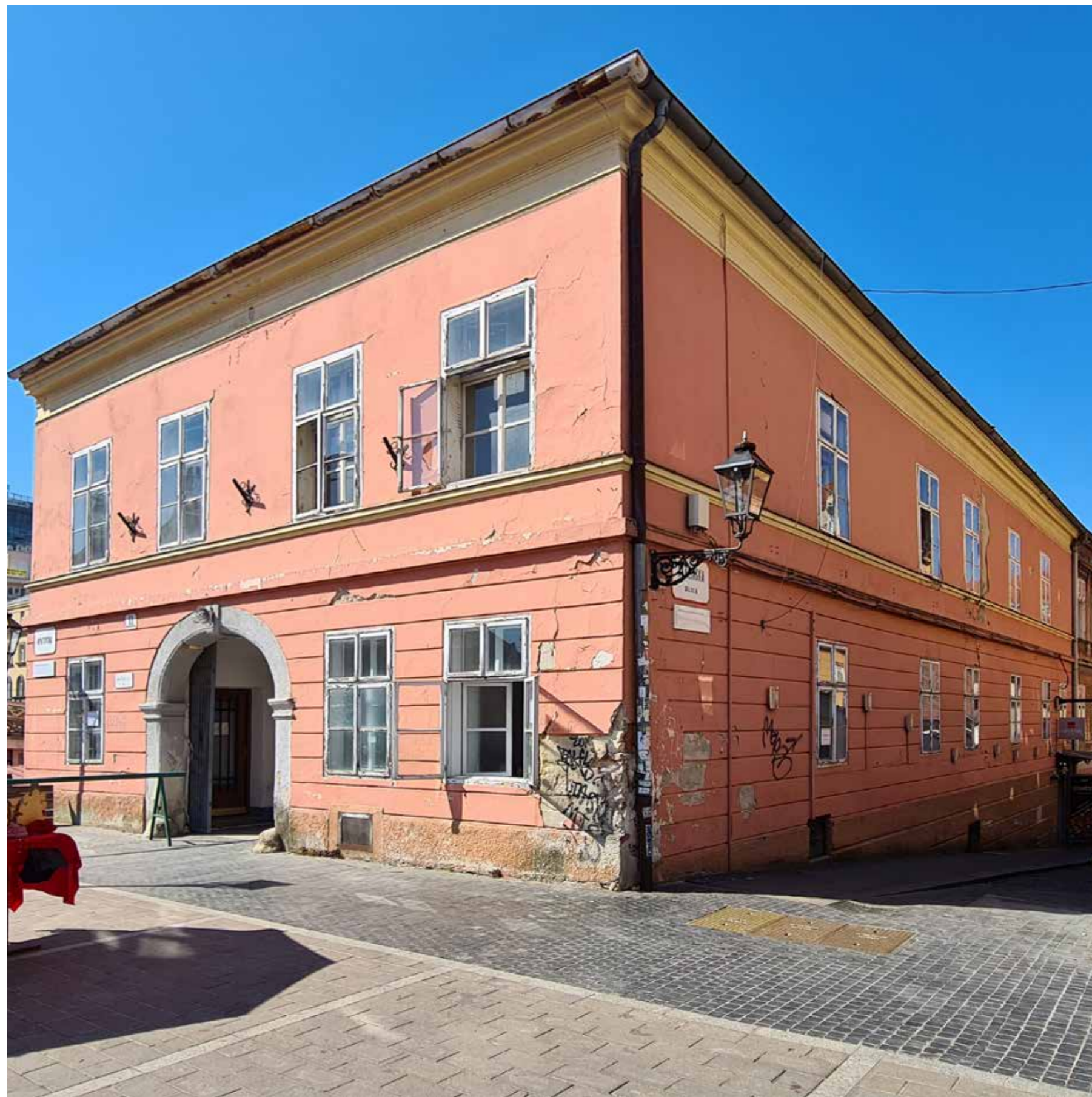
Istočno i sjeverno pročelje
