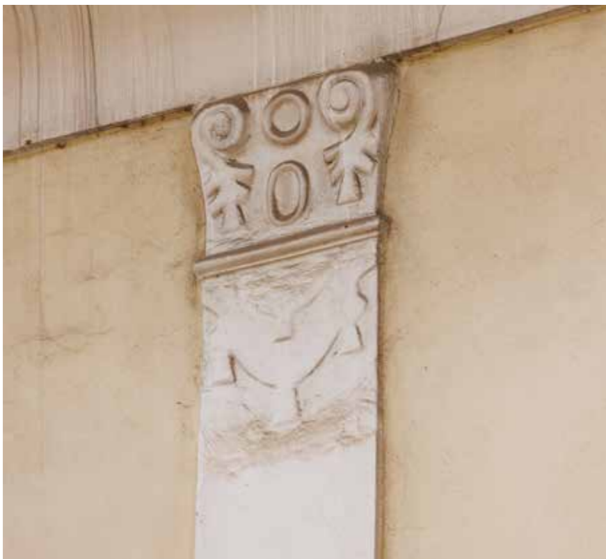
Pročelni pilastar, detalj
