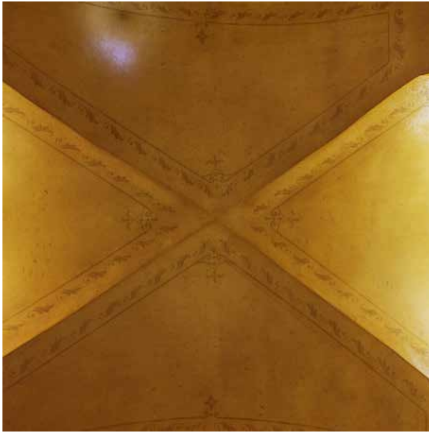
Svod u prizemlju
