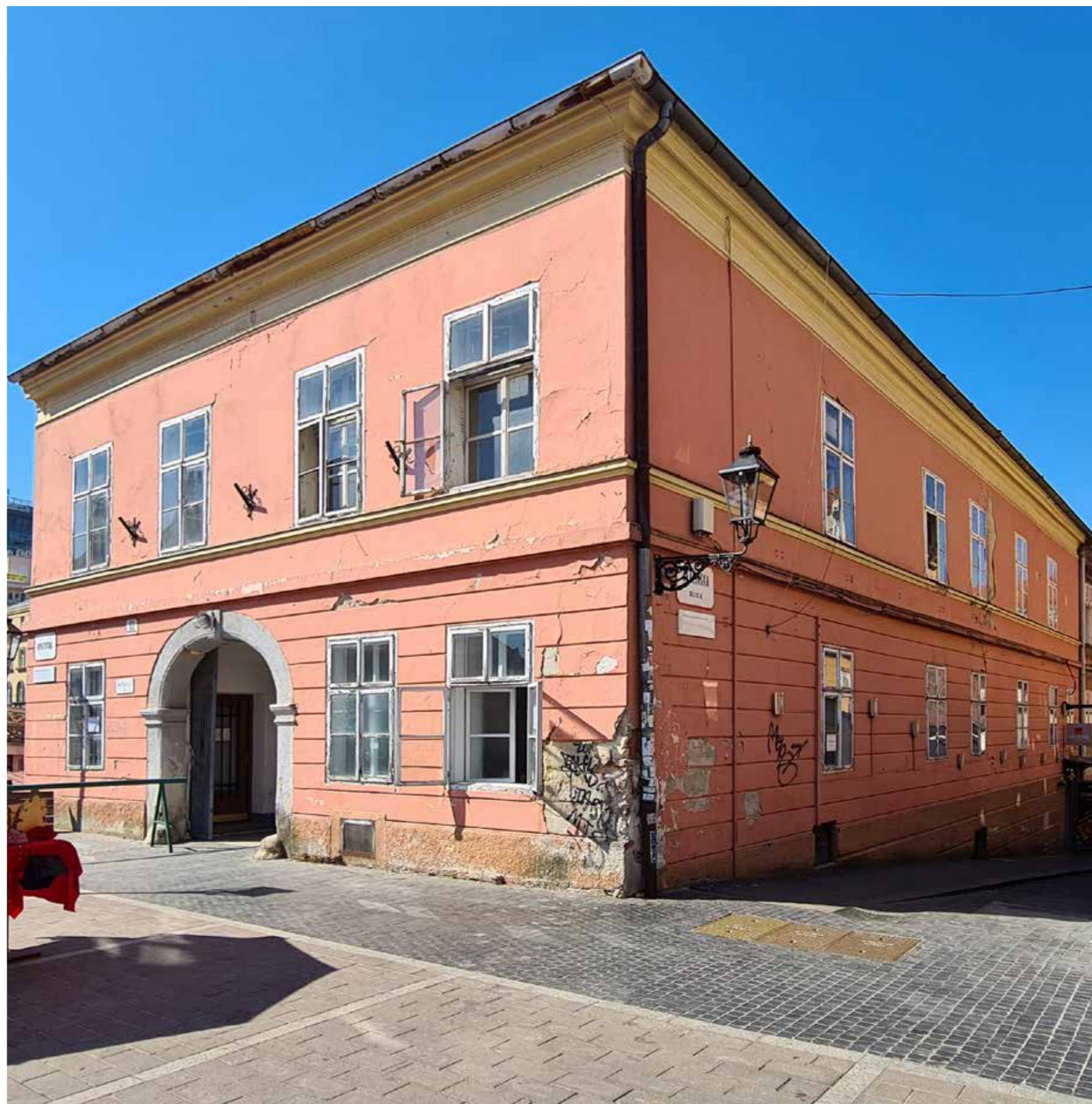
Istočno i sjeverno pročelje
