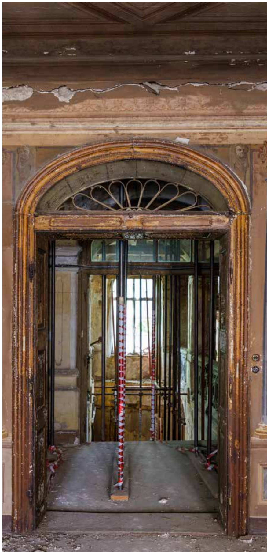
Vrata prema stubištu
