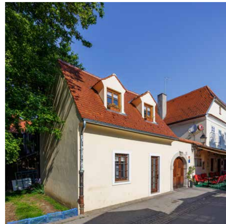
Istočno pročelje bočnog krila
