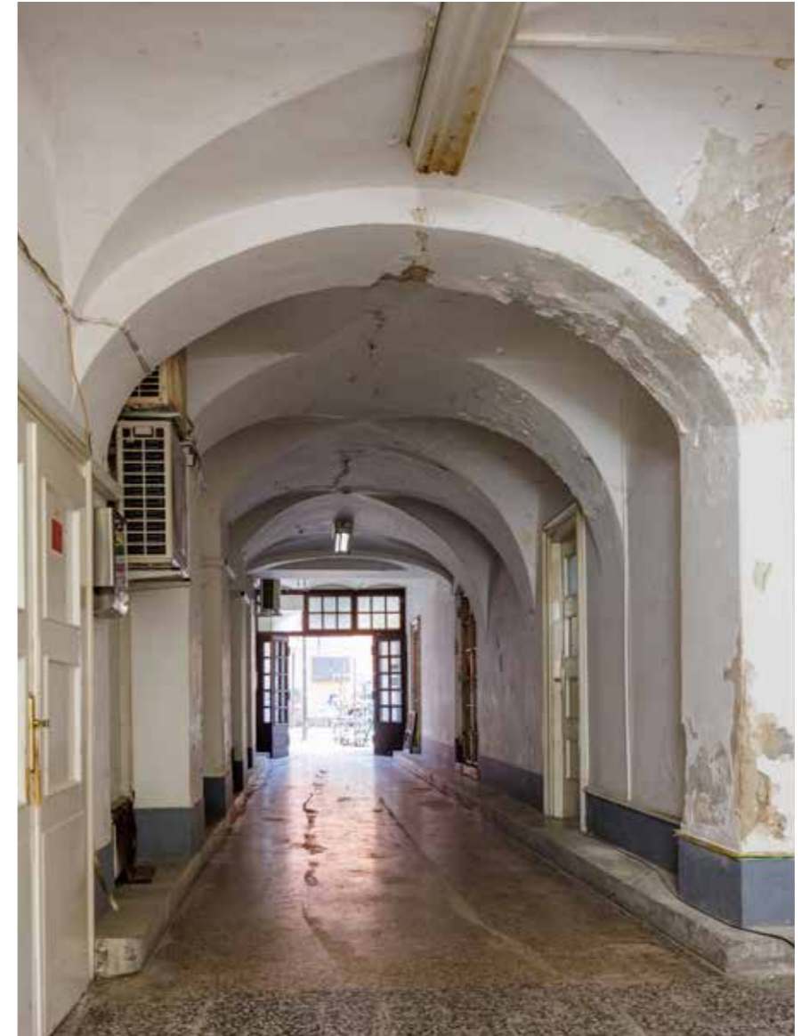
Kuća Miletić, veža
