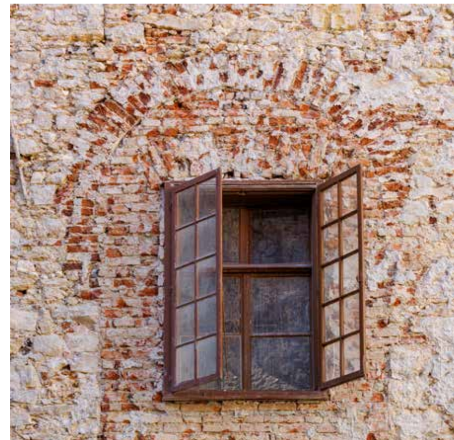
Detalj zazidanoga lučnog otvora trijema na katu
