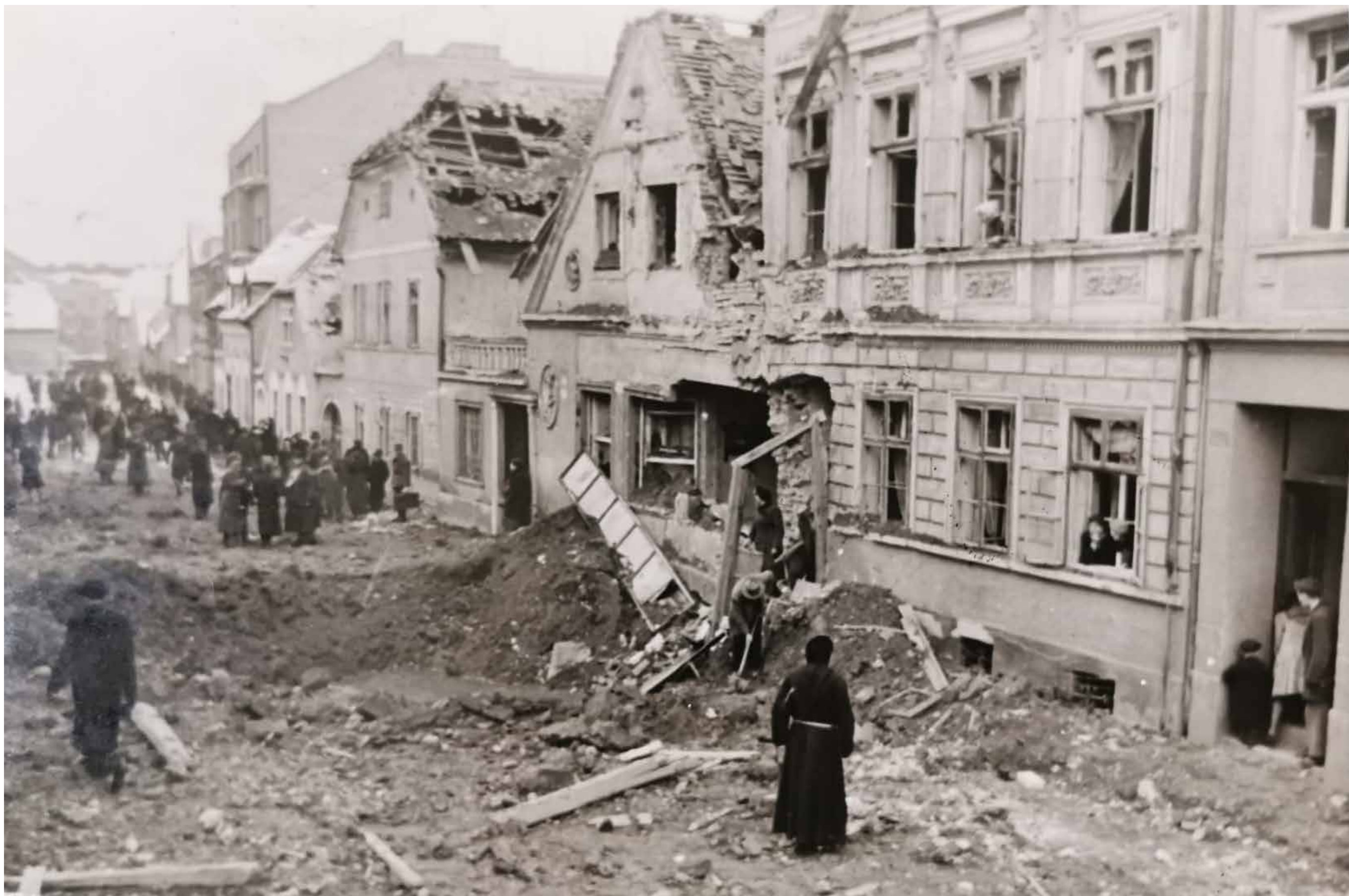
Opatovina (kbr. 31–37), oštećenja nastala u bombardiranju 1944. godine
