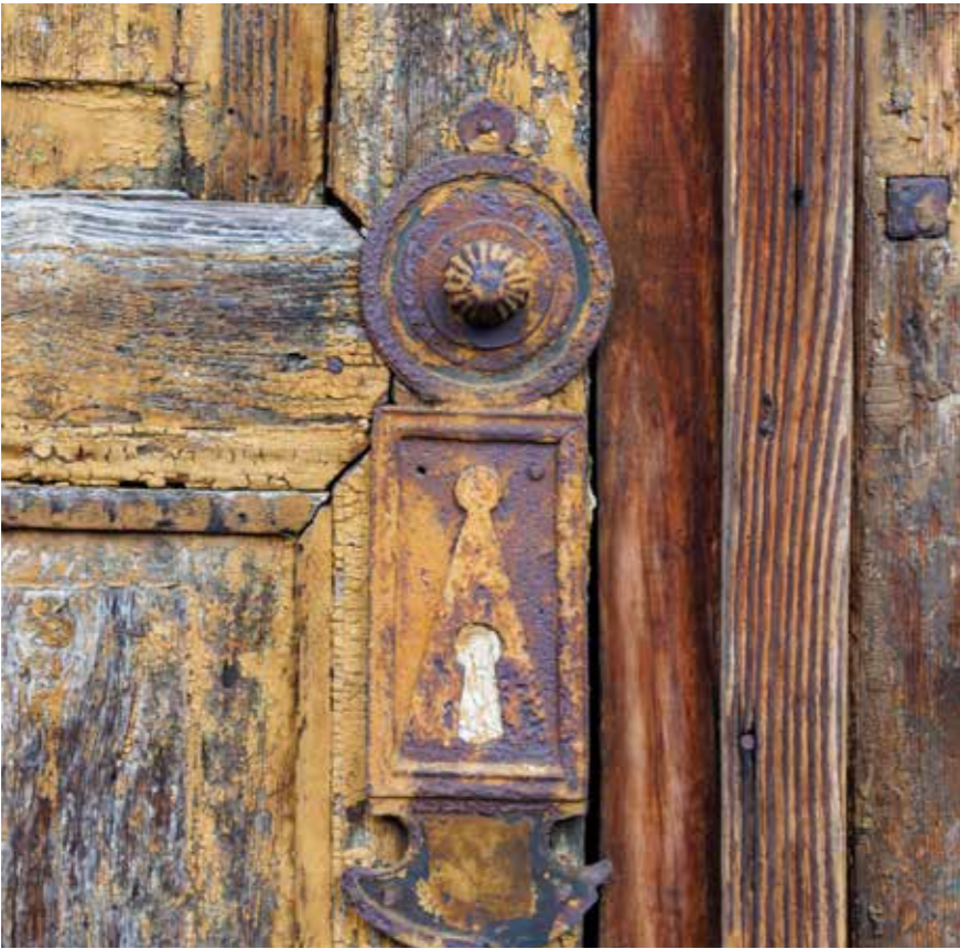
Ulaz u dvorište, detalji vratnica
