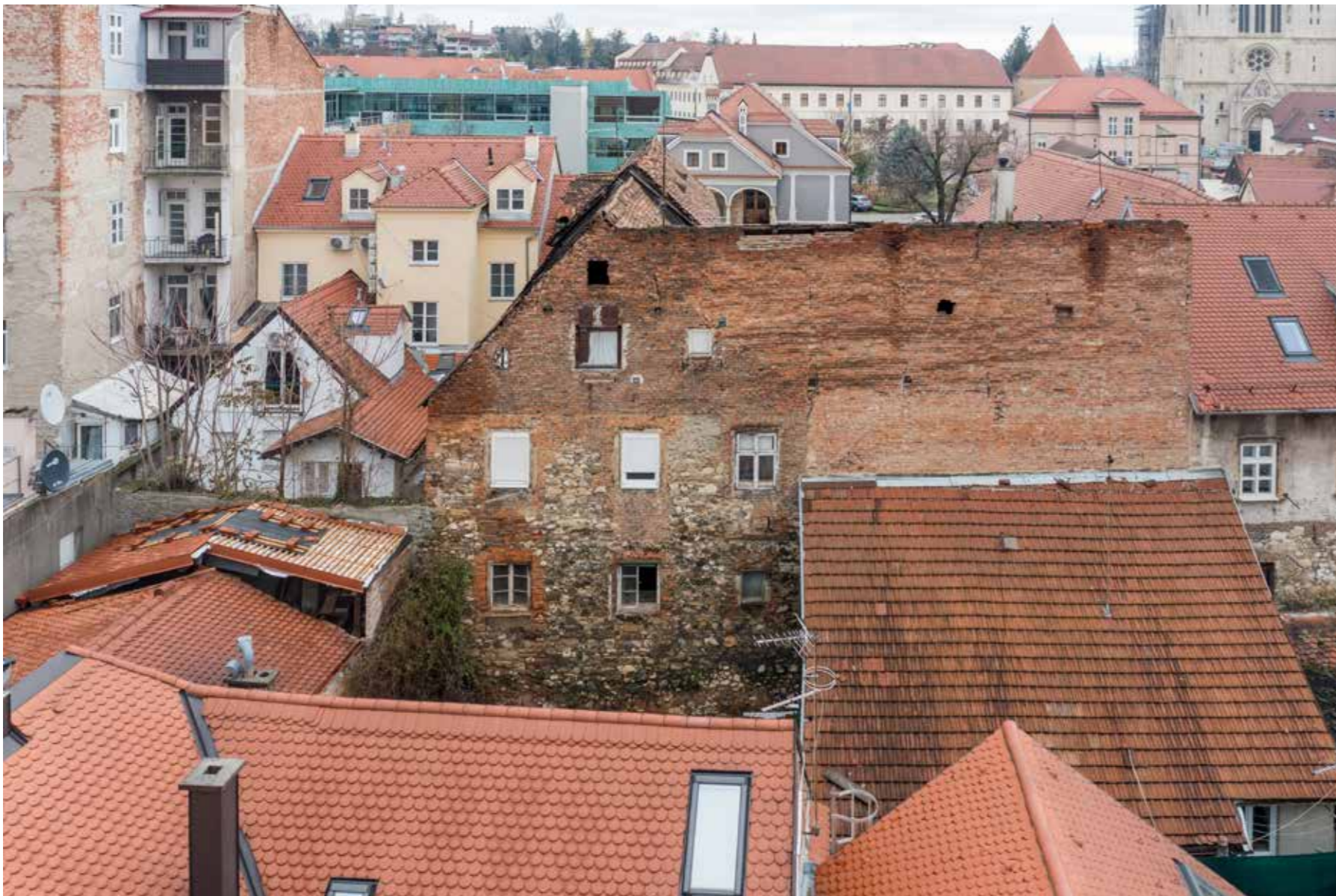
Zapadno začelje na gradskom zidu
