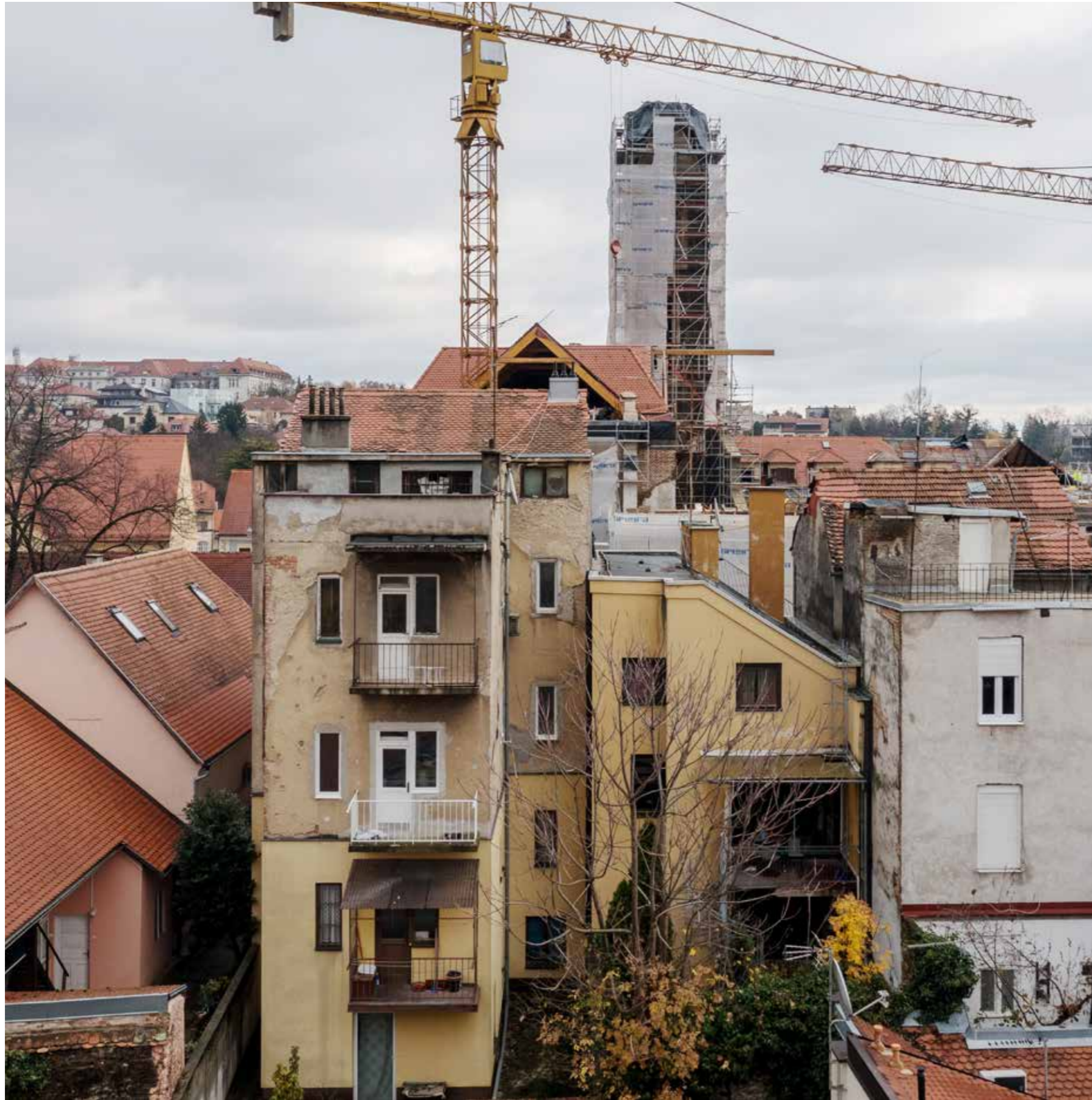
Zapadno začelje poviše gradskog zida
