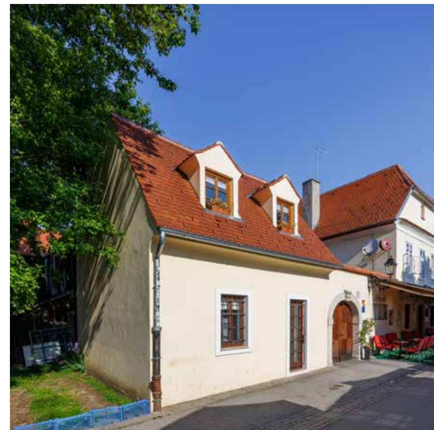
Istočno pročelje bočnog krila
