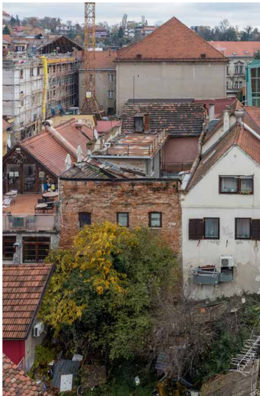
Zapadno začelje na gradskom zidu
