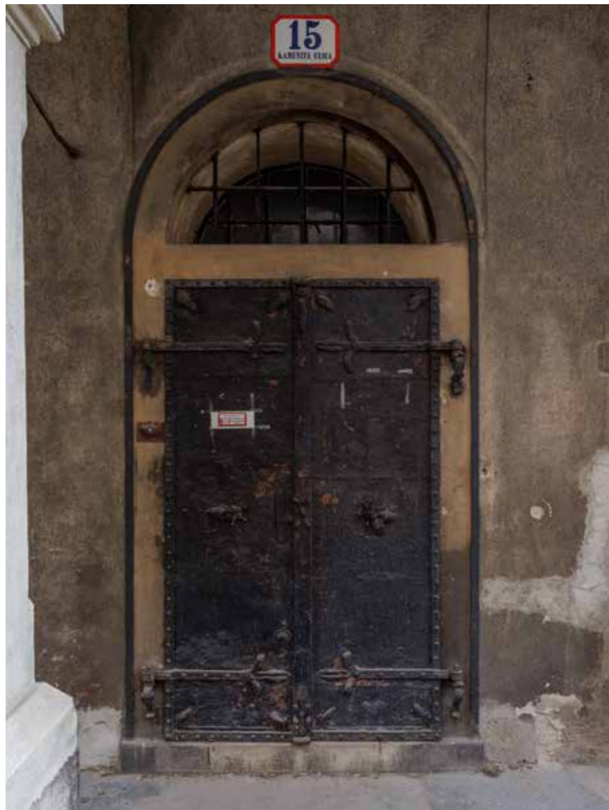
Glavni portal s metalnim vratnicama
