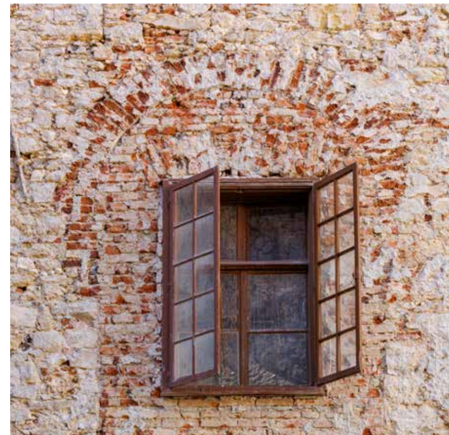
Detalj zazidanoga lučnog otvora trijema na katu
