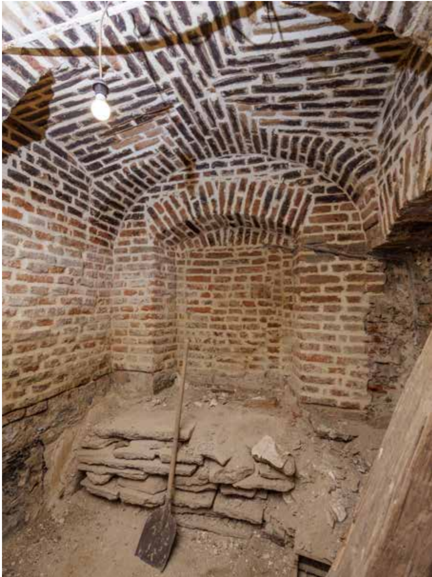
Kuća Fuchs-Devidé (kbr. 25), nadsvođena prostorija u podrumu
