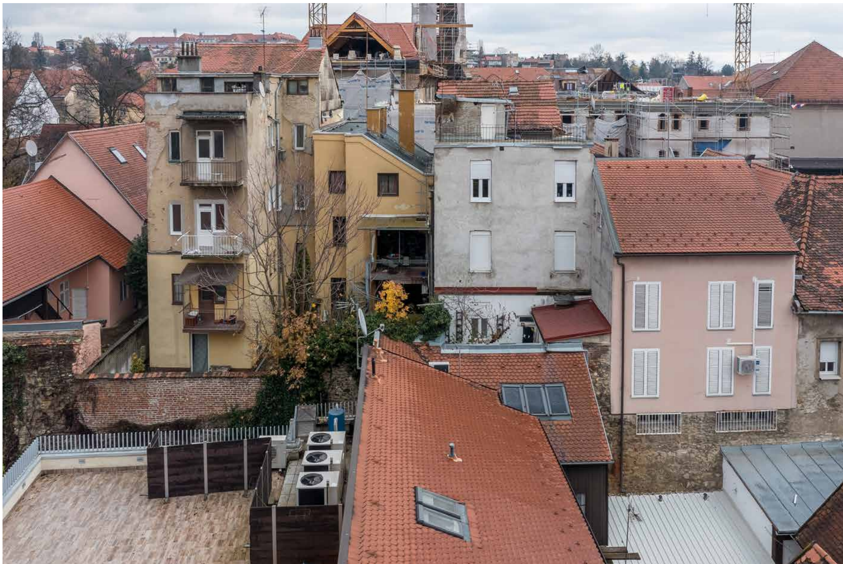
Zapadno začelje poviše gradskog zida
