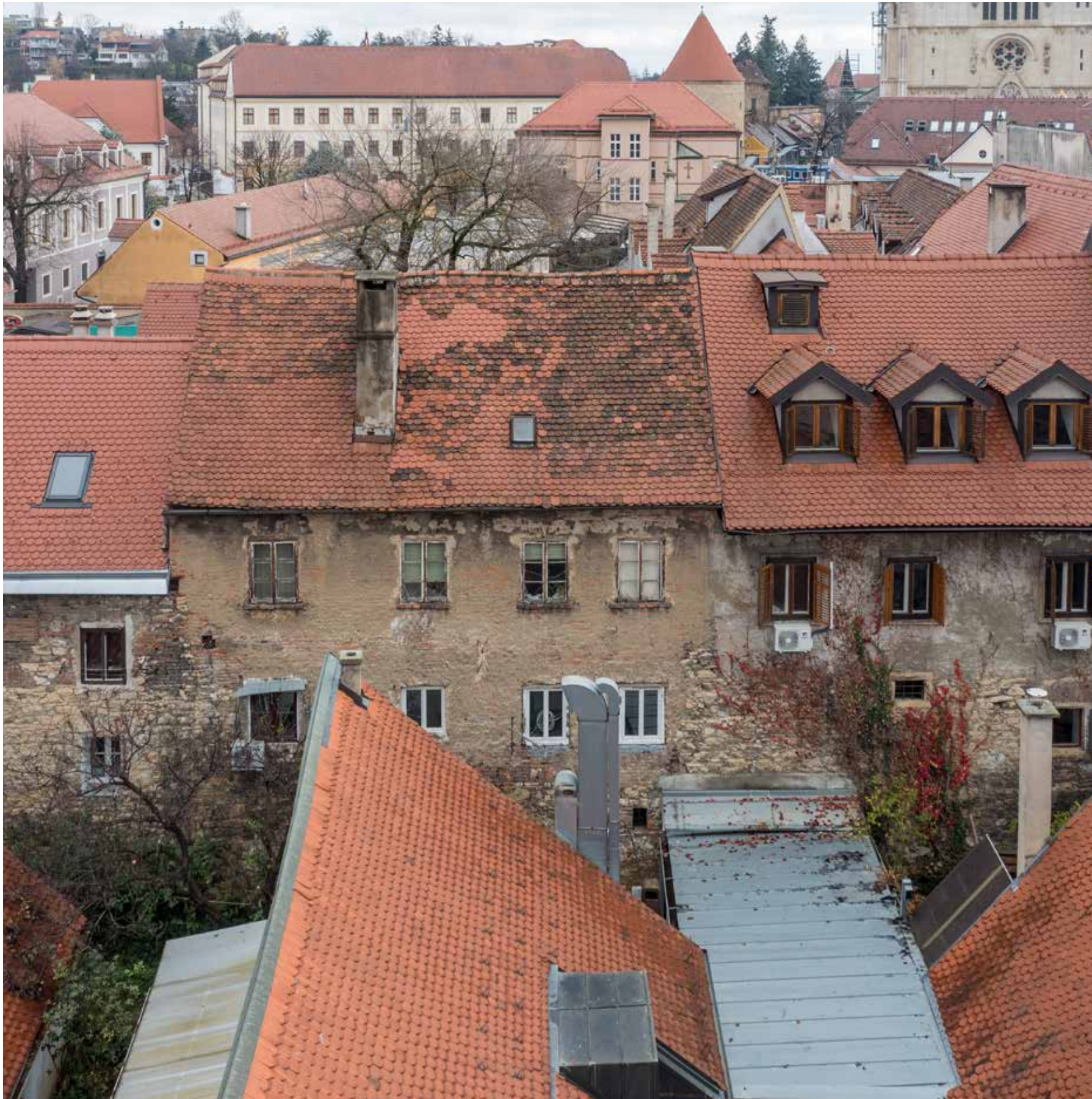
Zapadno začelje na gradskom zidu
