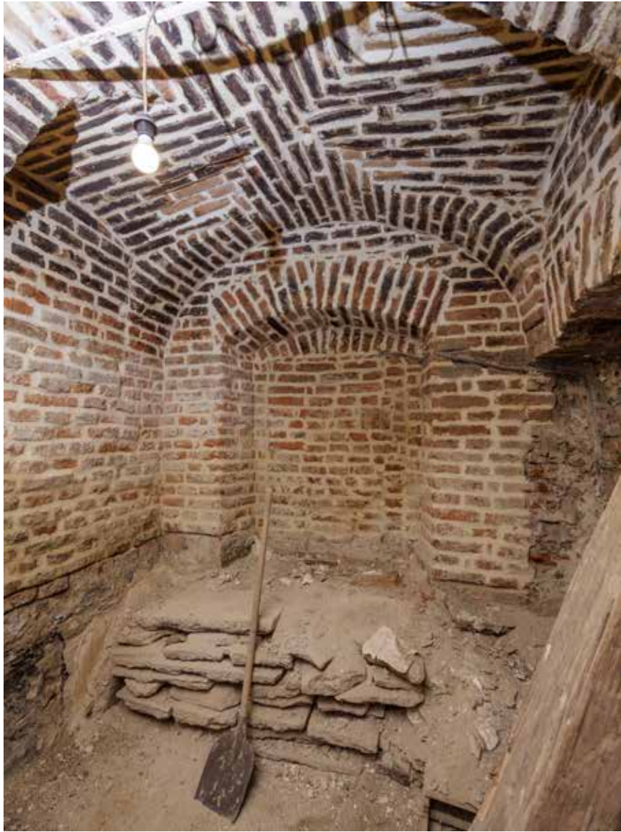
Kuća Fuchs-Devidé (kbr. 25), nadsvođena prostorija u podrumu
