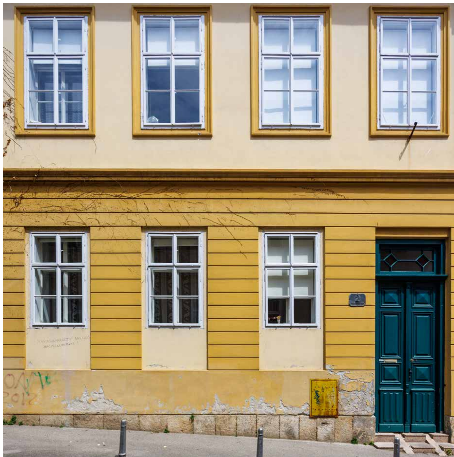
Južno pročelje, detalj
