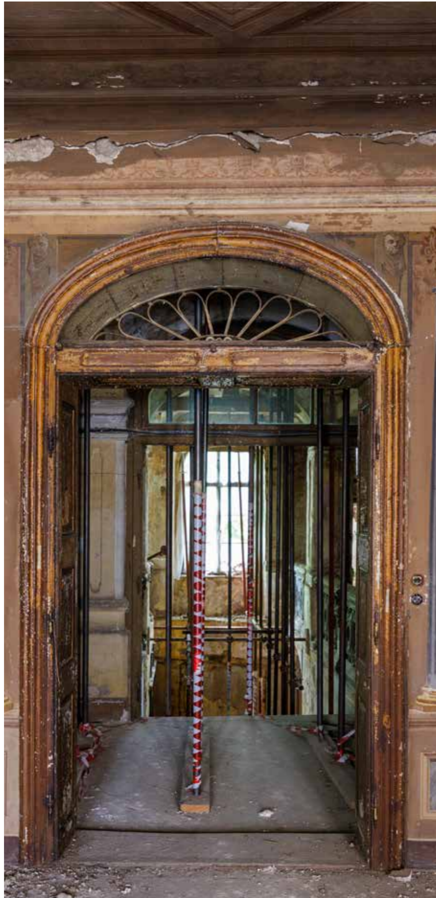
Vrata prema stubištu
