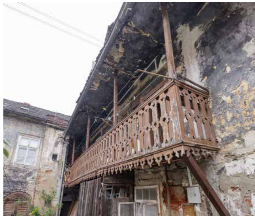
Kuća Fuchs-Devidé, dvorišni trijem
