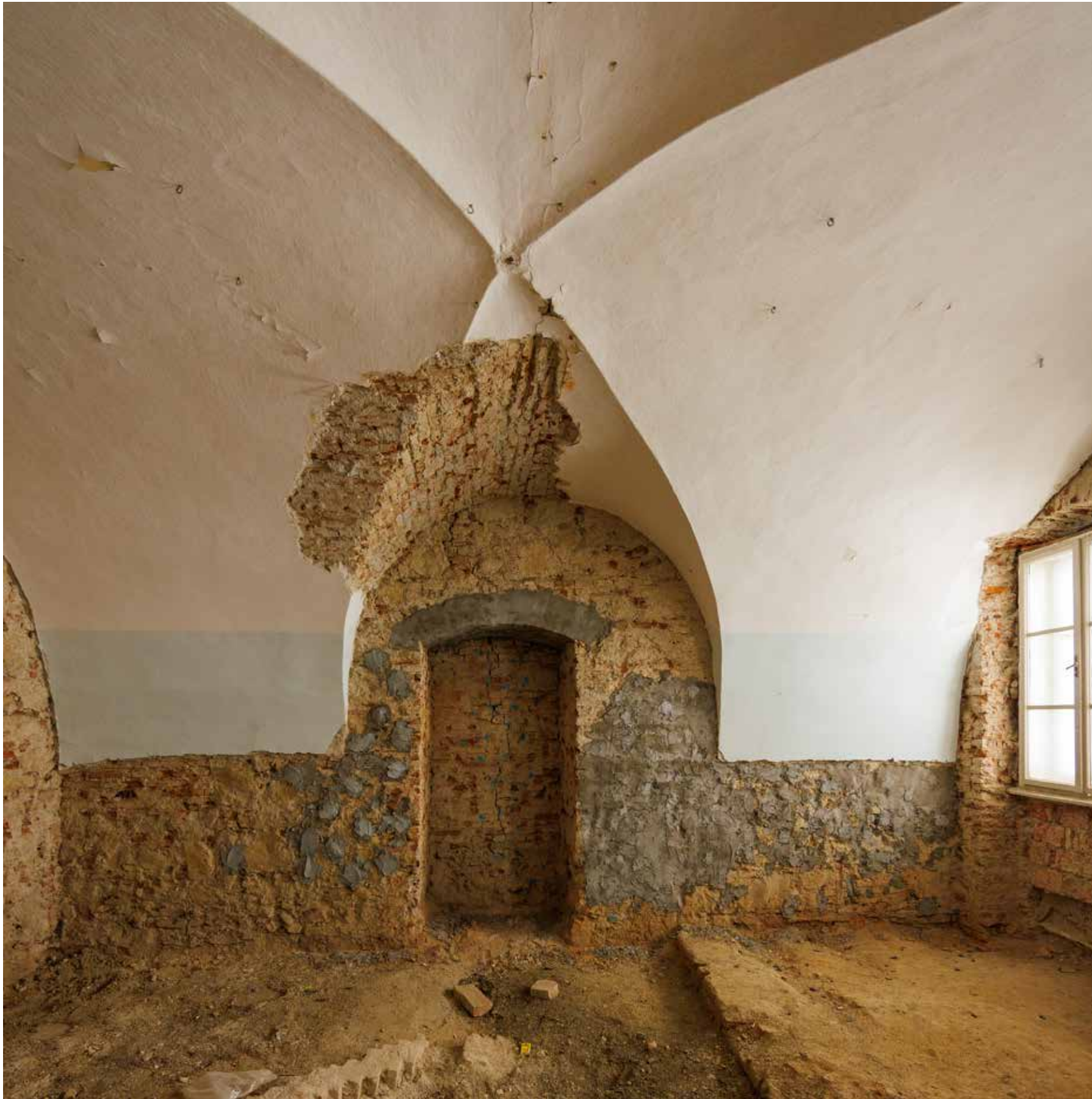
Svod u prizemlju
