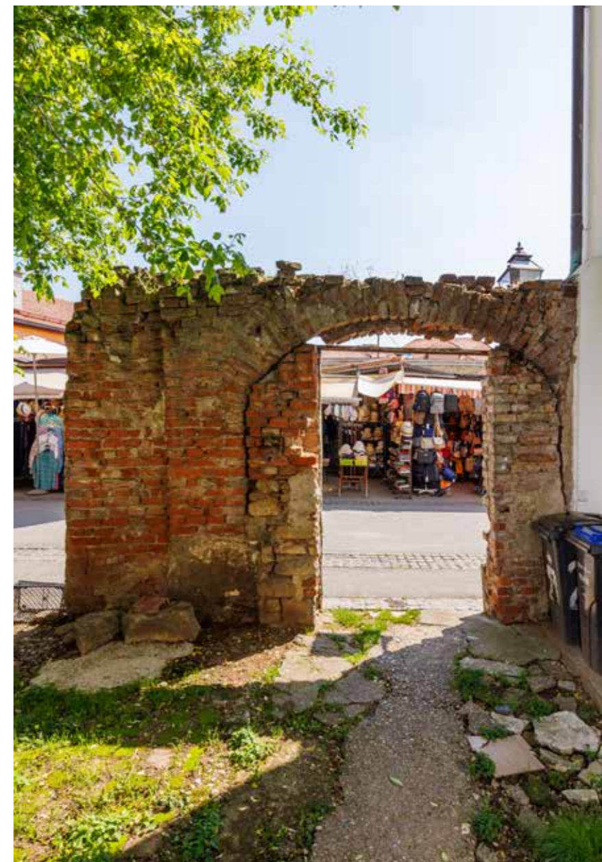
Ulični zid s ulazom u dvorište
