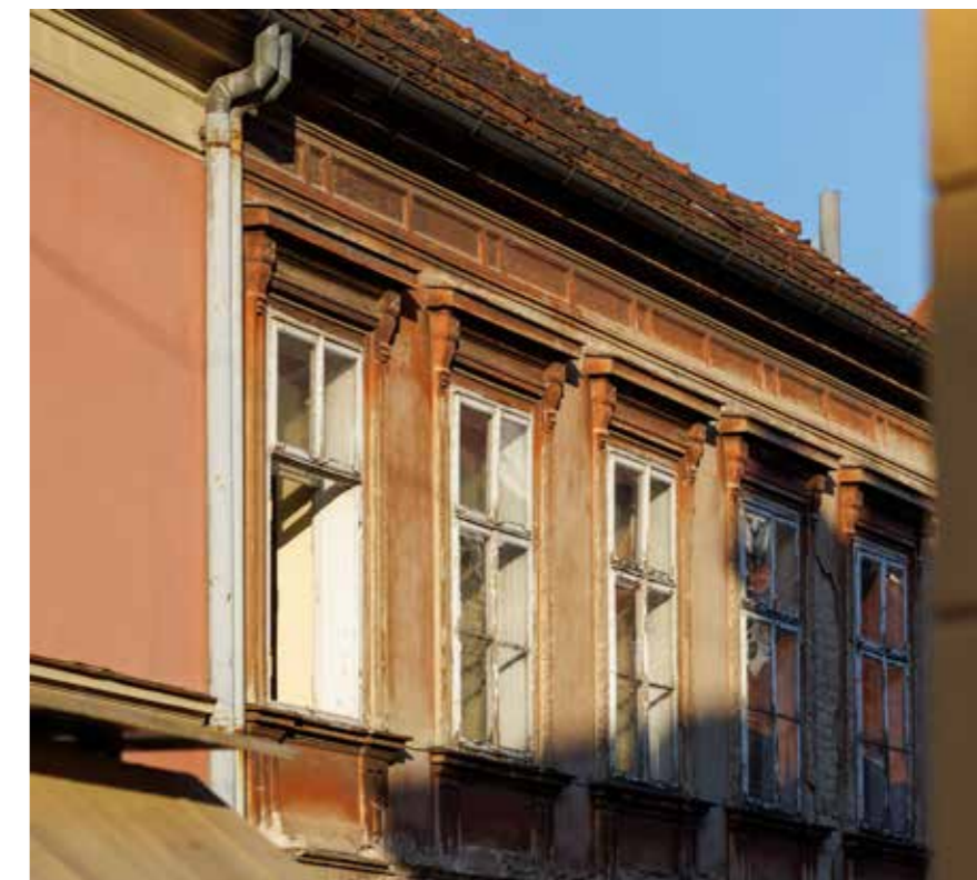
Sjeverno pročelje, dograđeno krilo
