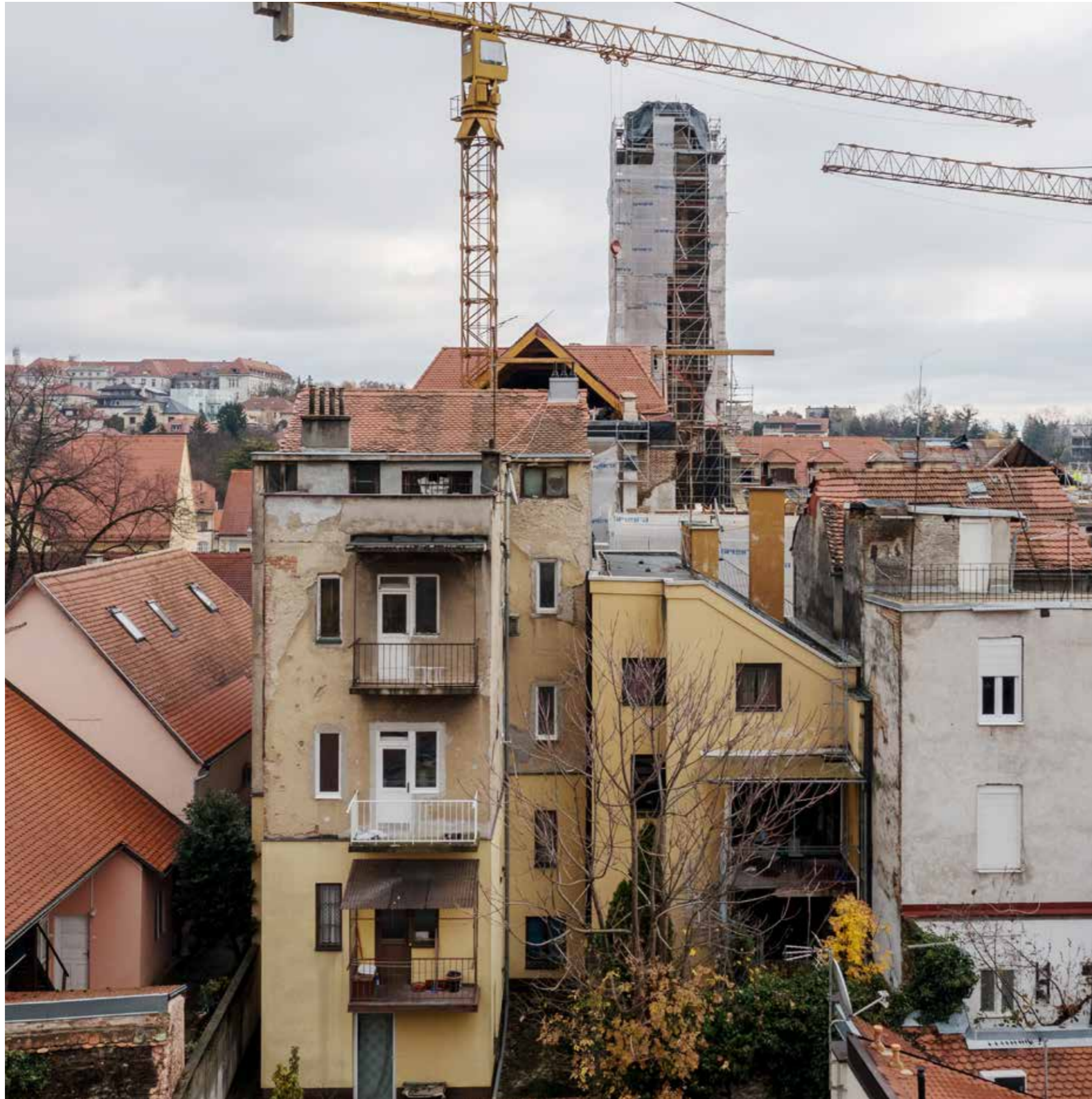
Zapadno začelje poviše gradskog zida
