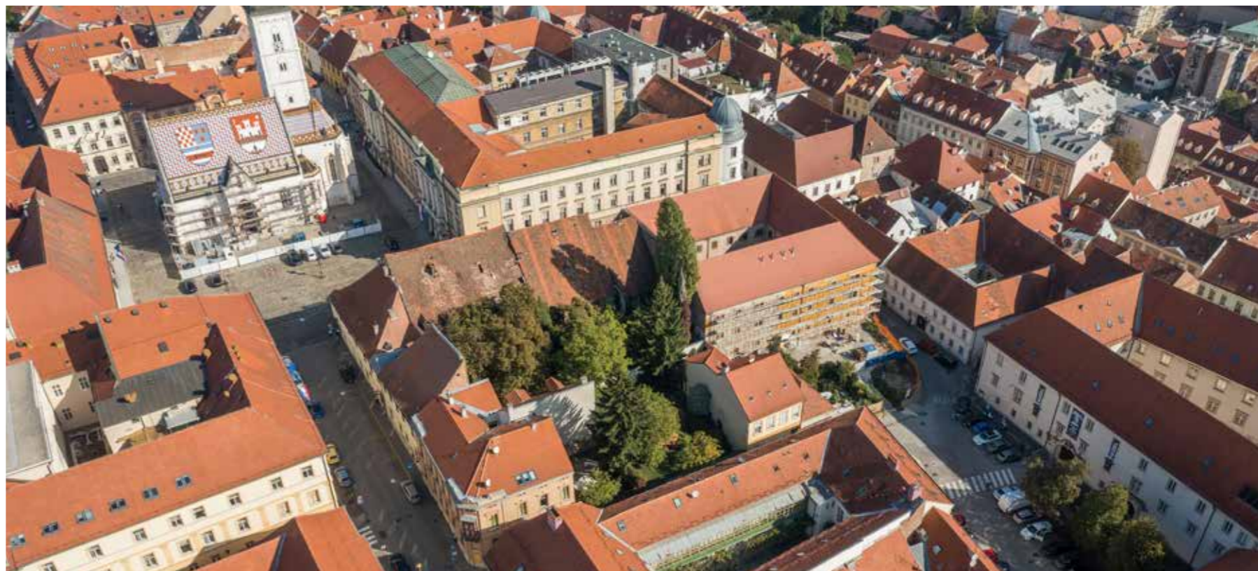
Blok 11, pogled s jugozapada
