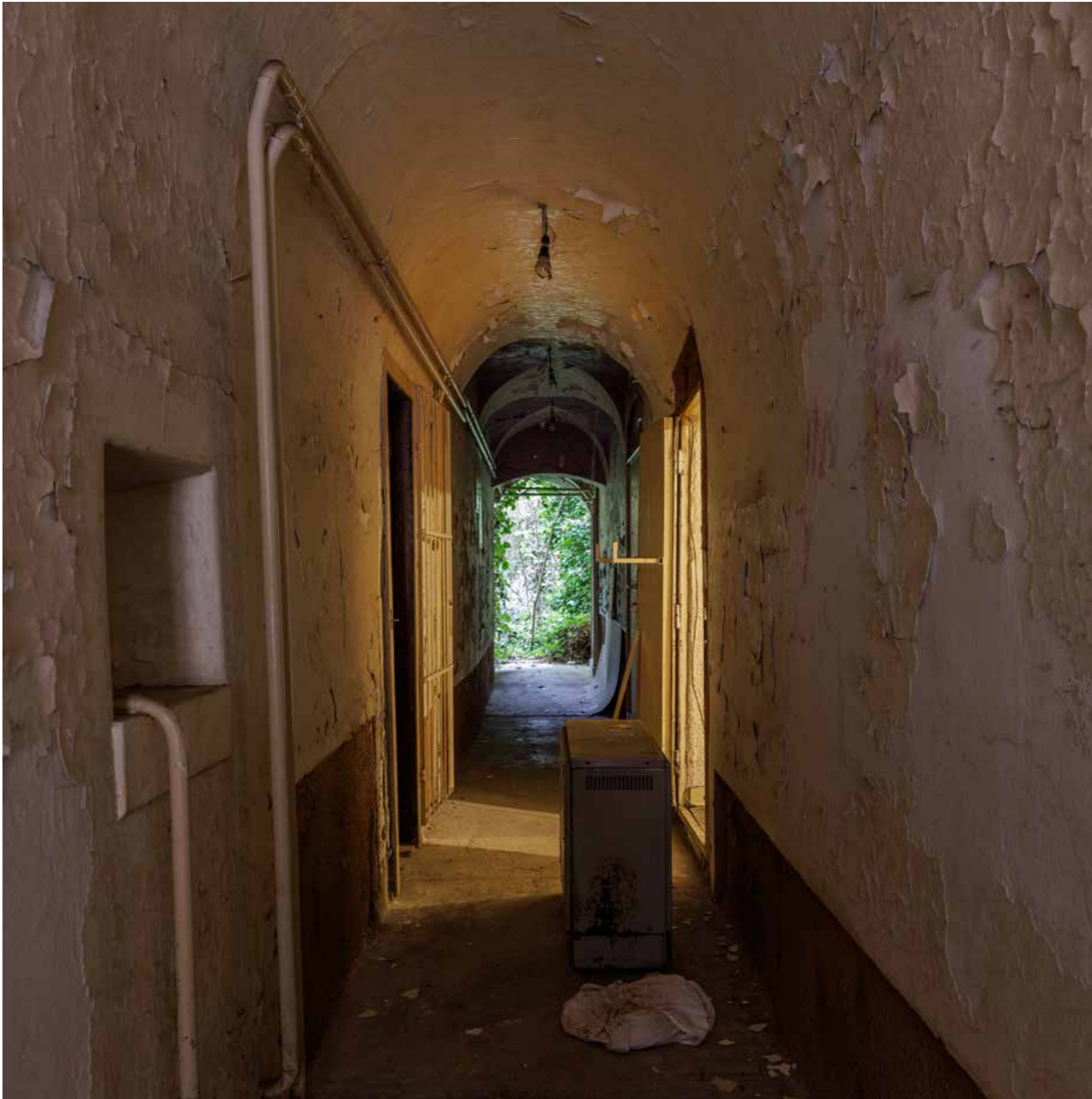
Veža u zapadnom dijelu prizemlja
