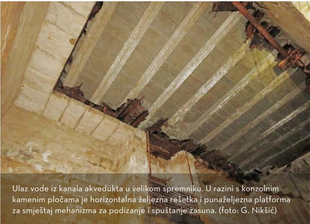
Ulaz vode iz kanala akvedukta u velikom spremniku. U razini s konzolnim kamenim pločama je horizontalna željezna rešetka i punaželjezna platforma za smještaj mehanizma za podizanje i spuštanje zasuna. (foto: G. Nikšić)
