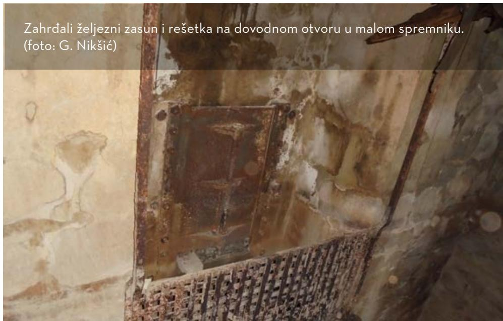
Zahrdali željezni zasun i rešetka na dovodnom otvoru u malom spremniku.
