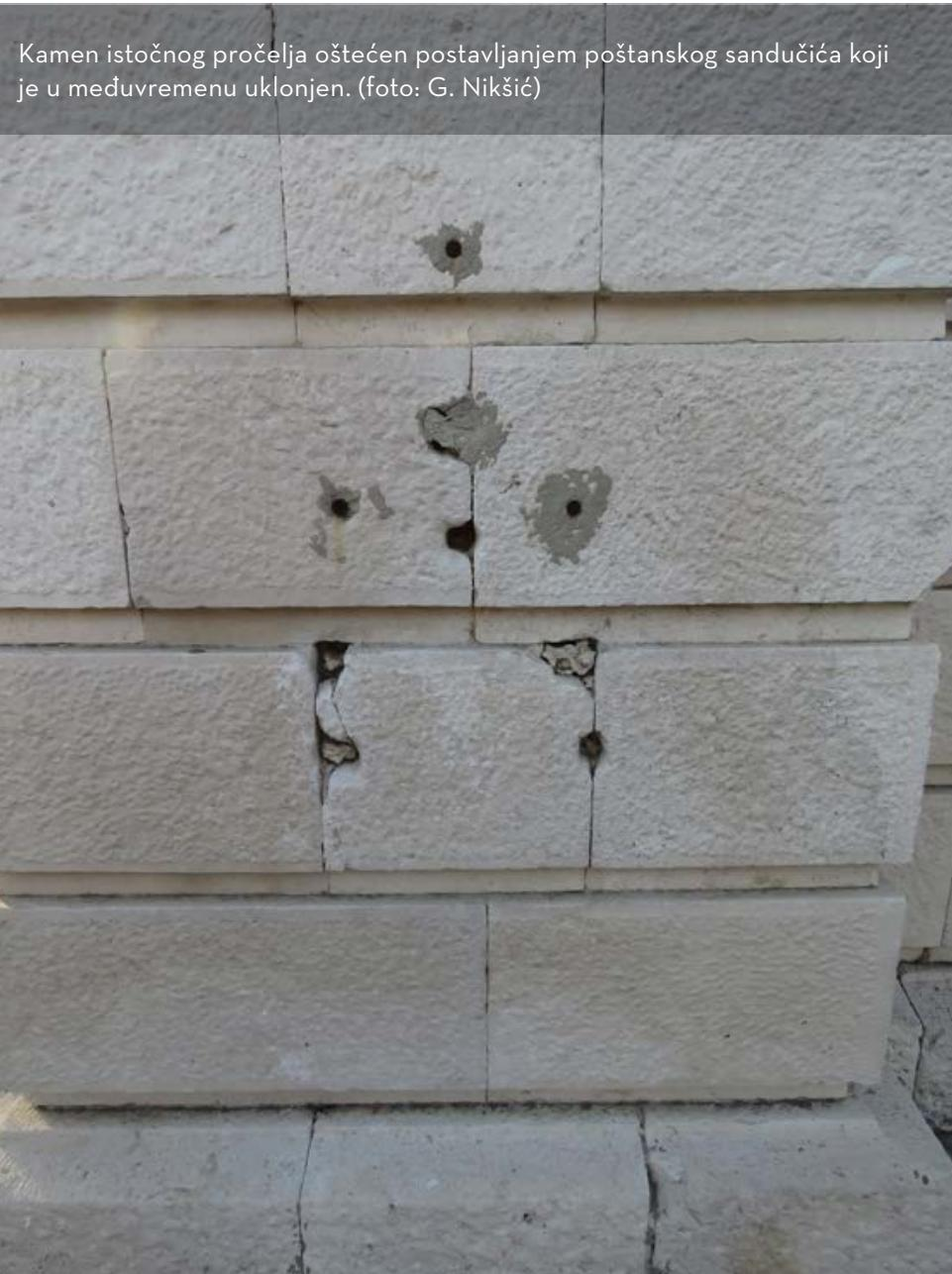
Kamen istočnog pročelja oštećen postavljanjem poštanskog sandučića koji je u međuvremenu uklonjen. (foto: G. Nikšić)
