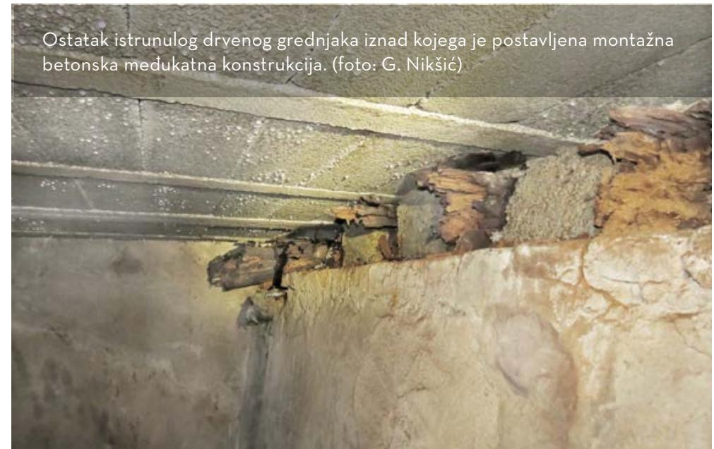
Ostatak istrunulog drvenog grednjaka iznad kojega je postavljena montažna betonska međukatna konstrukcija. (foto: G. Nikšić)
