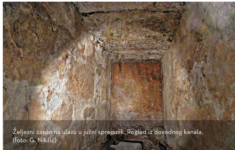
Pogled iz dovodnog kanala kroz otvor u sjeverni spremnik. U donjem dijelu slike je vrh željezne rešetke koja je zadržavala krupni otpad (granje, lišće i sl.). U sredini slike je montažna konstrukcija koja je nosila pod šalter sale. U gornjem dijelu slike je metalna rešetka poda ophoda, iznad koje su ostaci istrunule drvene međukatne konstrukcije. (foto: G. Nikšić)
