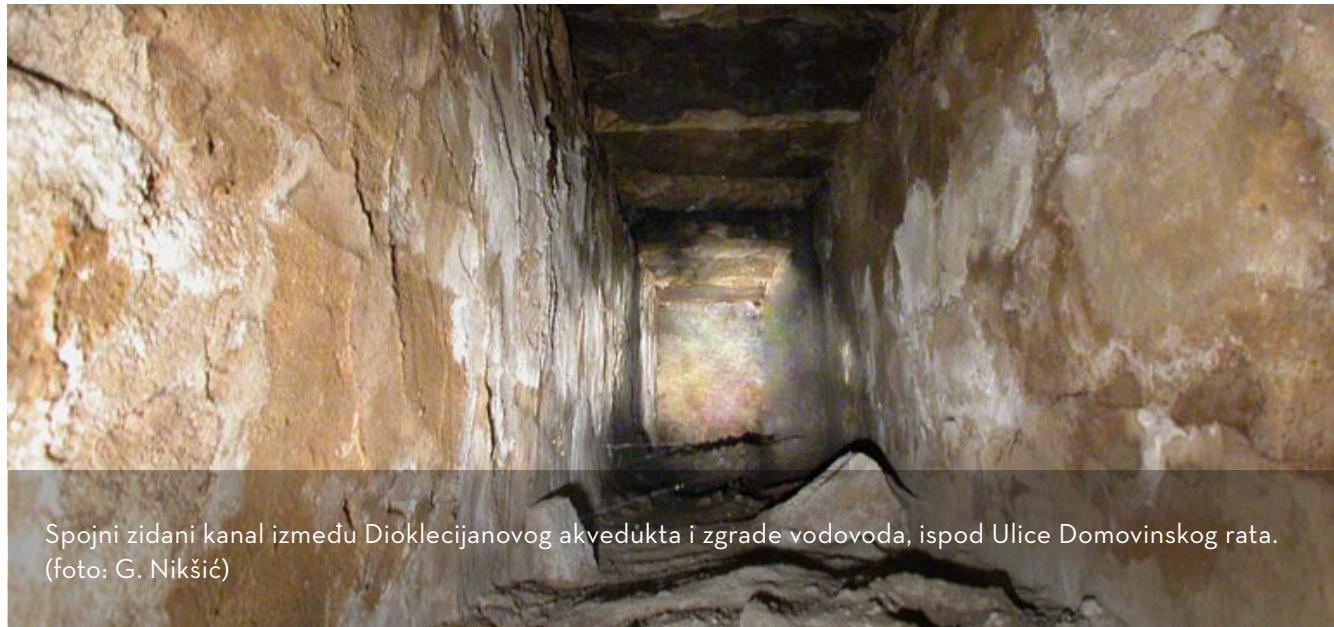
Spojni zidani kanal između Dioklecijanovog akvedukta i zgrade vodovoda, ispod Ulice Domovinskog rata.
