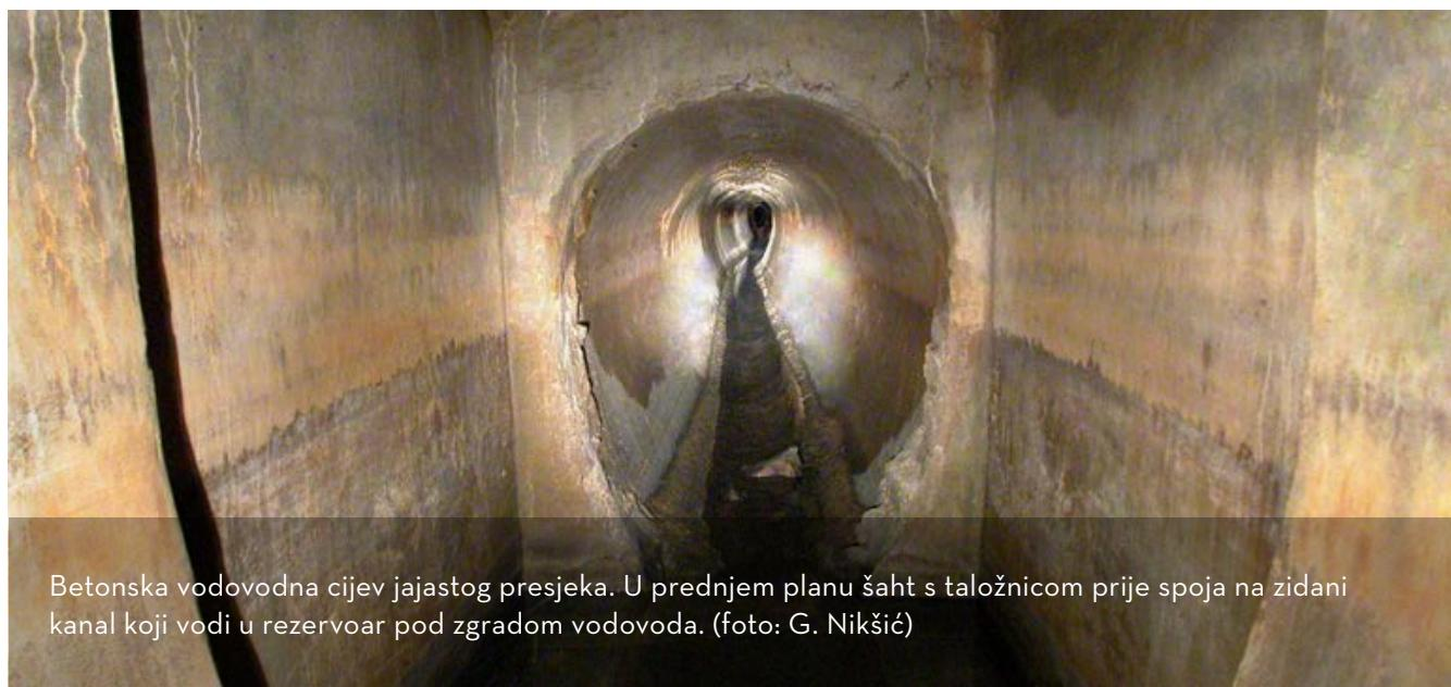
Betonska vodovodna cijev jajastog presjeka. U prednjem planu šahrt s taložnicom prije spoja na zidani kanal koji vodi u rezervoar pod zgradom vodovoda. (foto: G. Nikšić)
