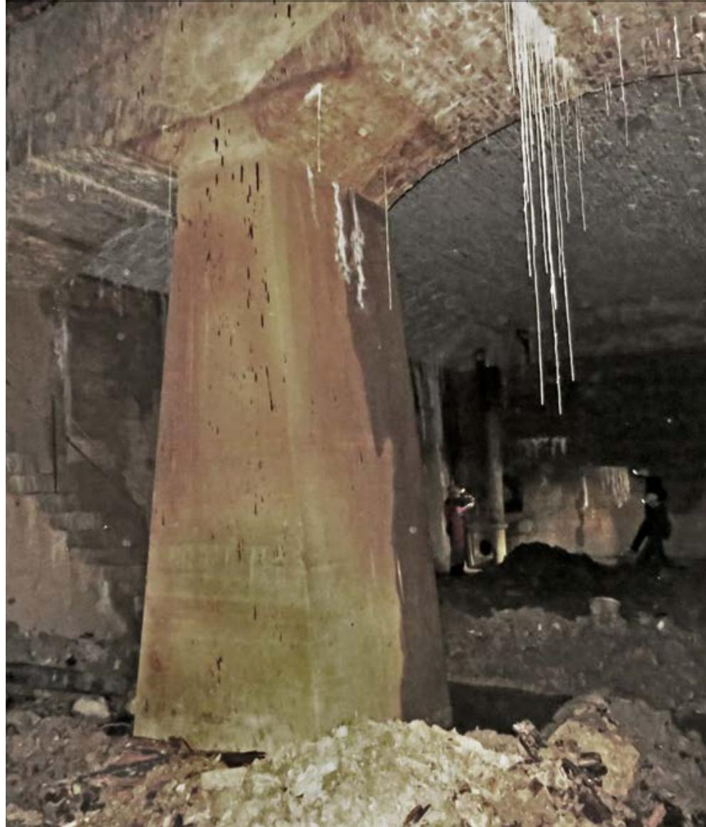
Veliki (sjeverni) spremnik s plitkim svodom u kojem se vidi otvor za ventilaciju. (foto: G. Nikšić)
