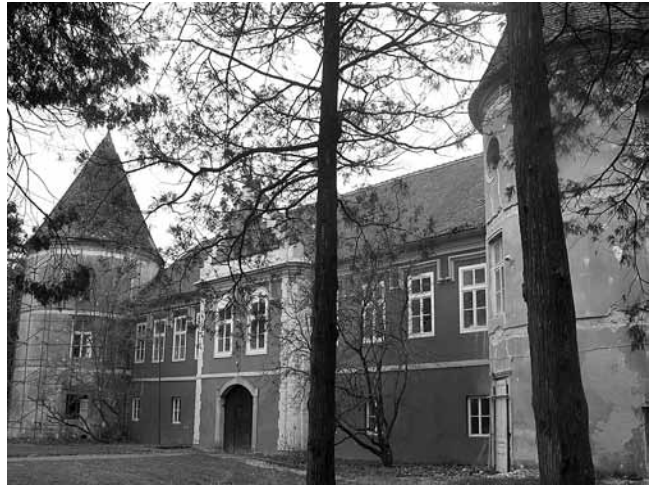
1. Pogled na glavno, istočno pročelje, sadašnje stanje
