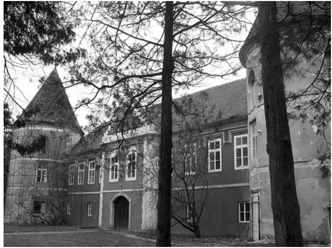
1. Pogled na glavno, istočno pročelje, sadašnje stanje
