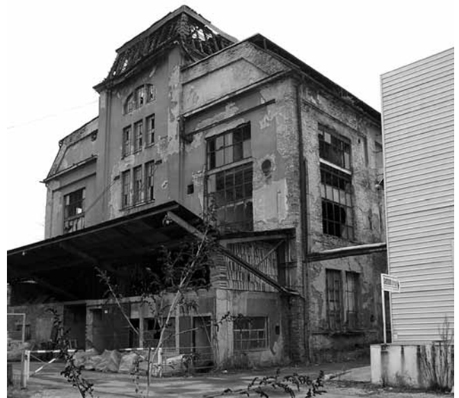
5. Ignjat Fischer, zgrada tvornice pjenice, 2010.
