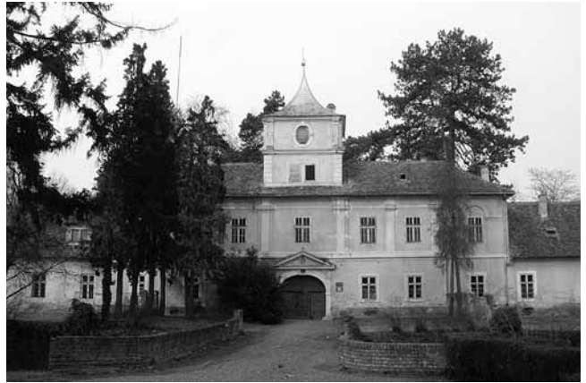
1. Dvorac Bilje, pročelje (snimio Ž. Predojević)
