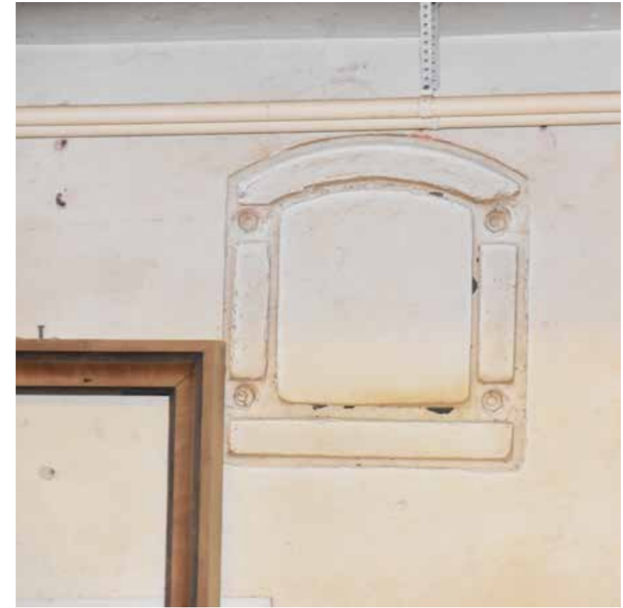
Željezni otvor, zapadna zgrada
