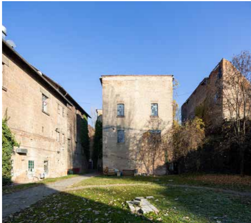
Istočna dvorišna zgrada, pogled na južno pročelje i park skulptura
