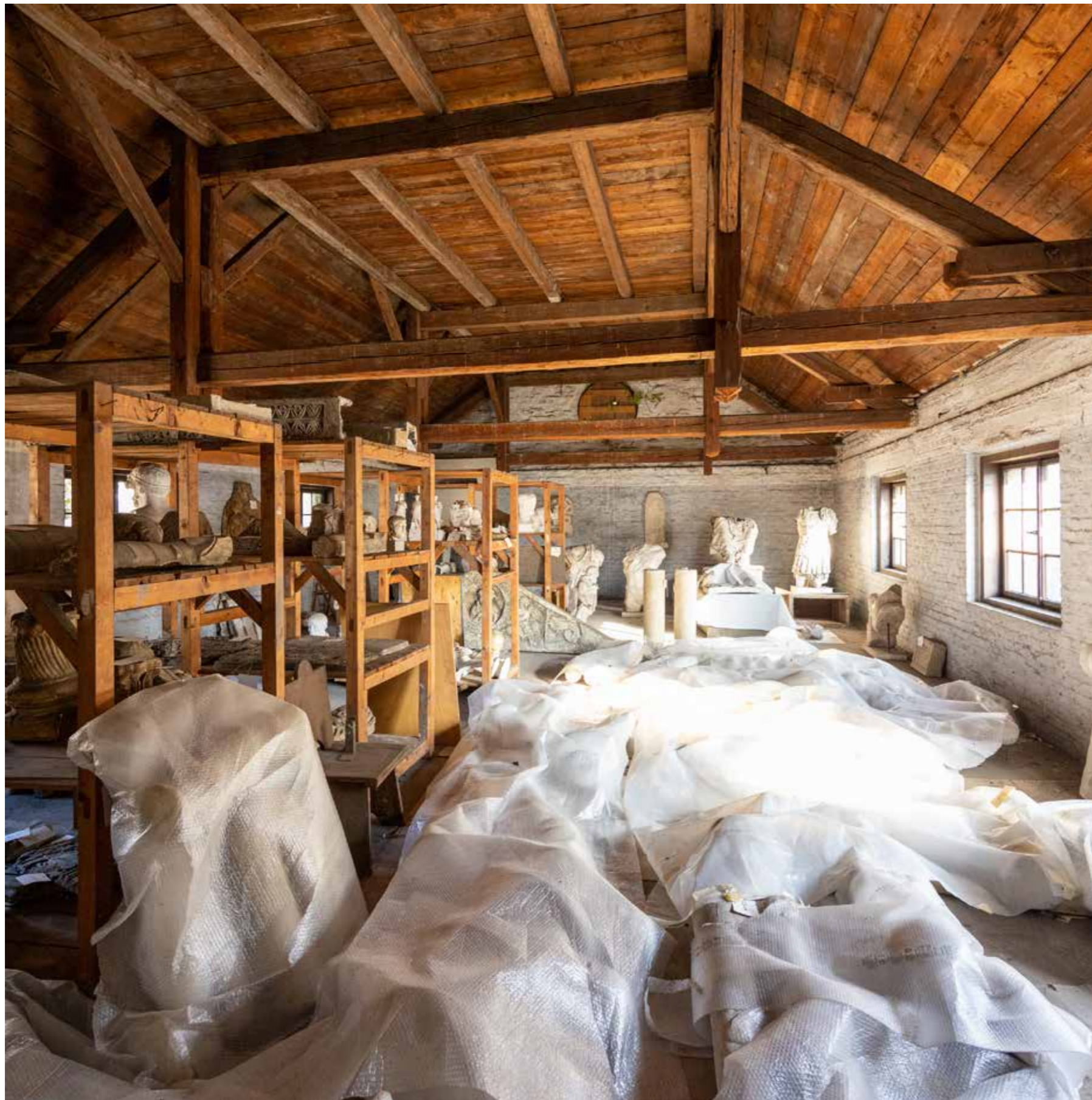
Južna zgrada Antika, krovište južnog krila
