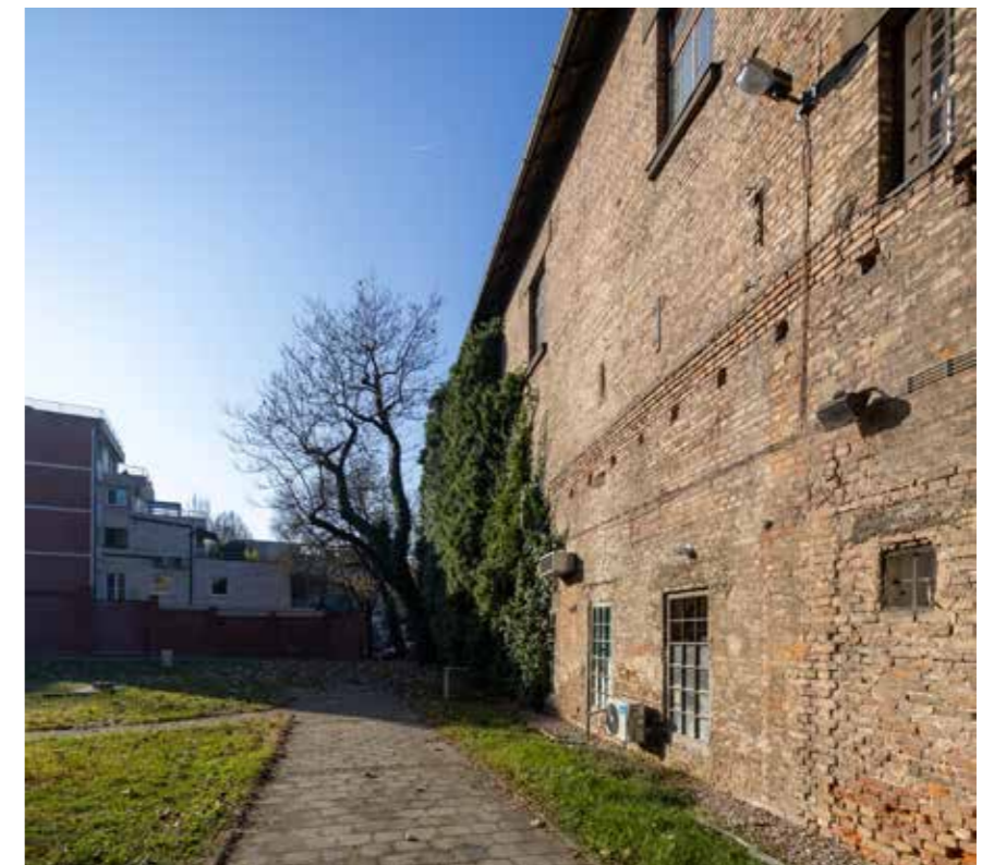
Južna zgrada Antika, pogled na južno pročelje
