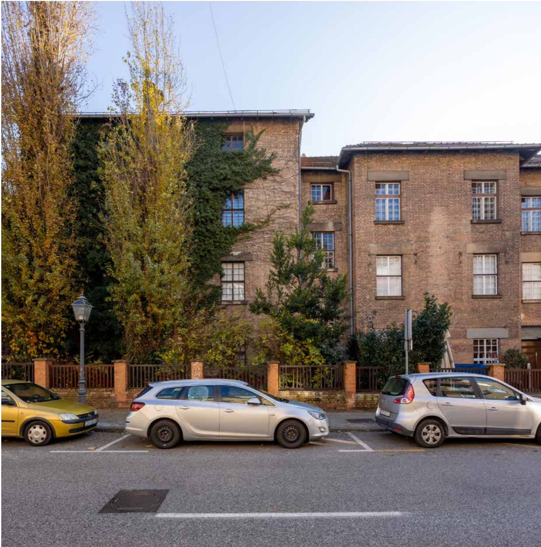
Južna zgrada Antika, pogled na zapadno ulično pročelje
