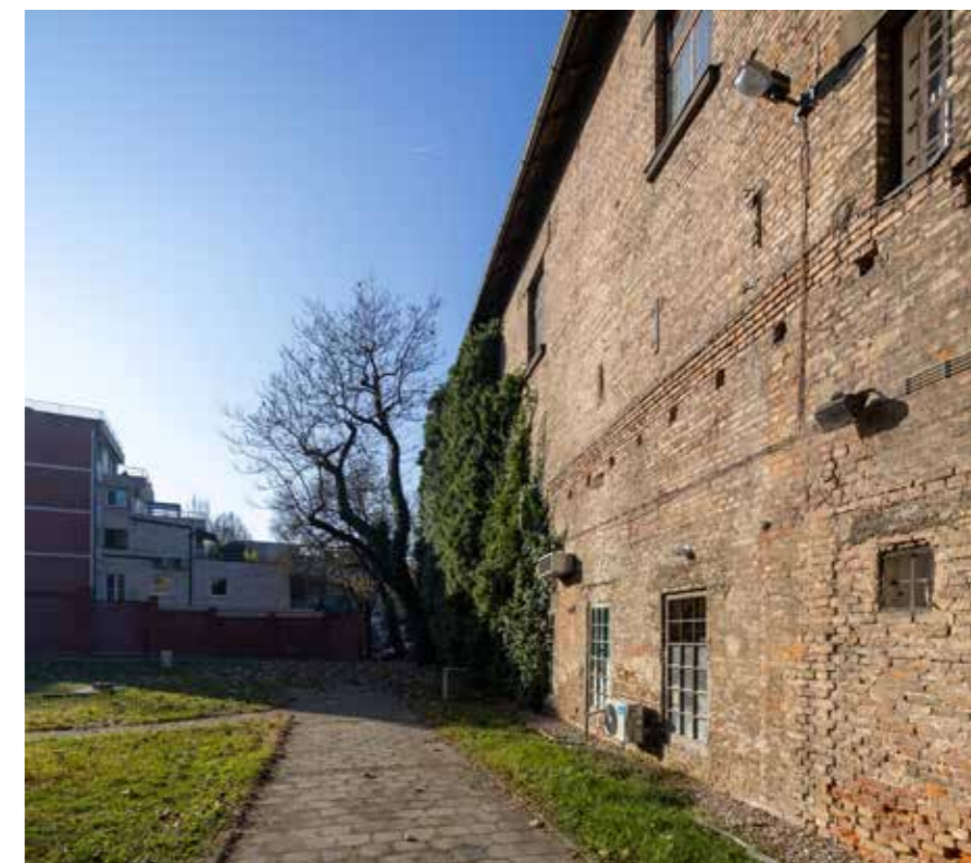
Južna zgrada Antika, pogled na južno pročelje
