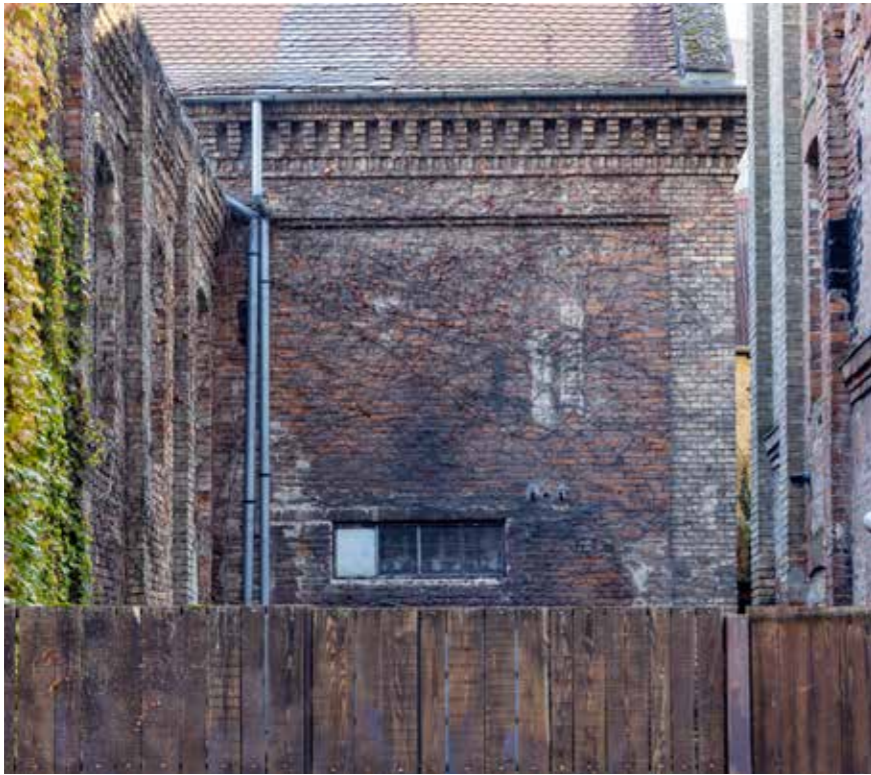
Sjeverna zgrada Šibenik, pogled na zapadno pročelje objekta kotlovnice i servisno dvorište sa zapada
