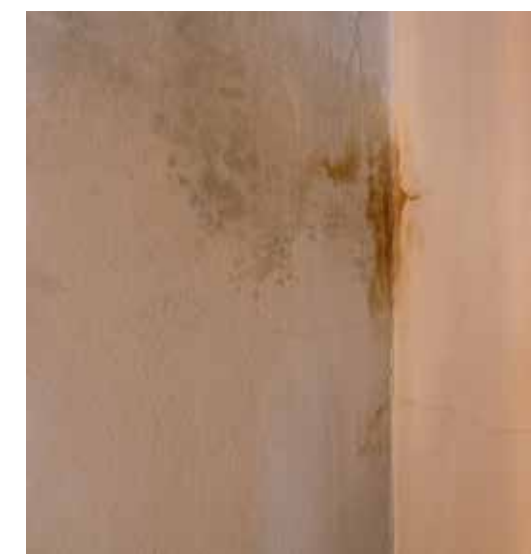
Pogled na južni zid galerije Ilirske dvorane, oštećenje zatečenog žbuknog i slikanog sloja, detalj
