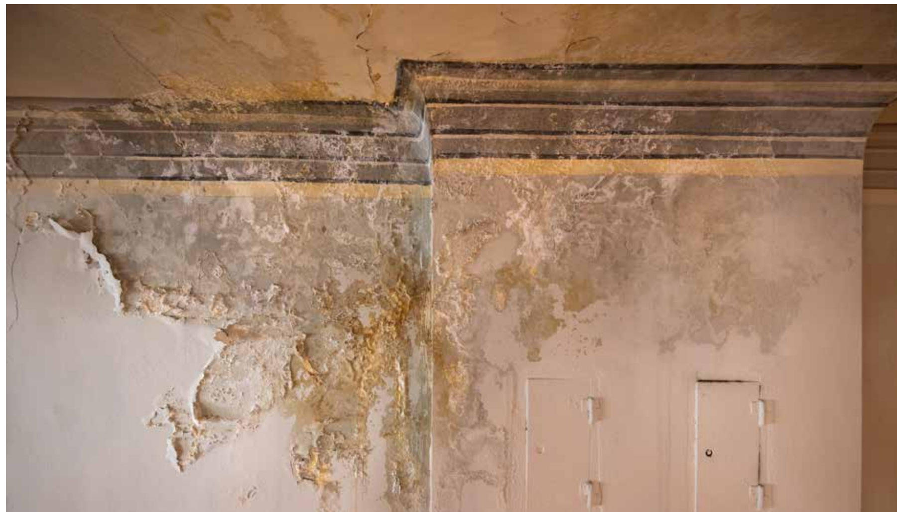
Pogled na južni zid galerije Ilirske dvorane, oštećenje zatečenog žbuknog i slikanog sloja
