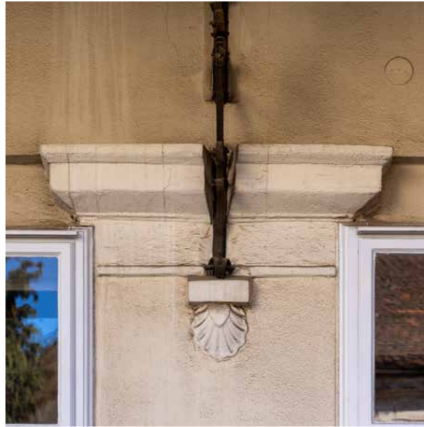
Zapadno pročelje, detalj prizemlja središnjeg rizalita
