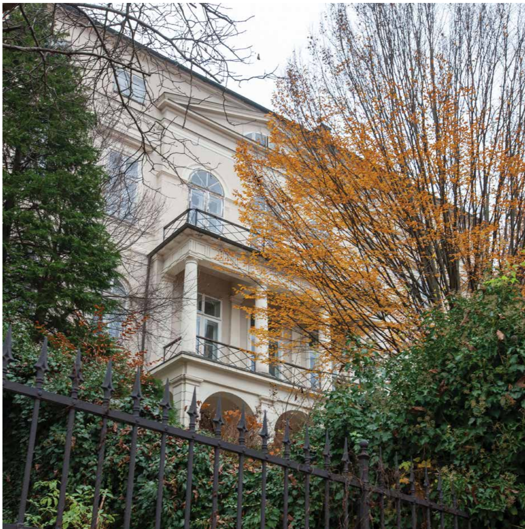
Istočno pročelje s altanom
