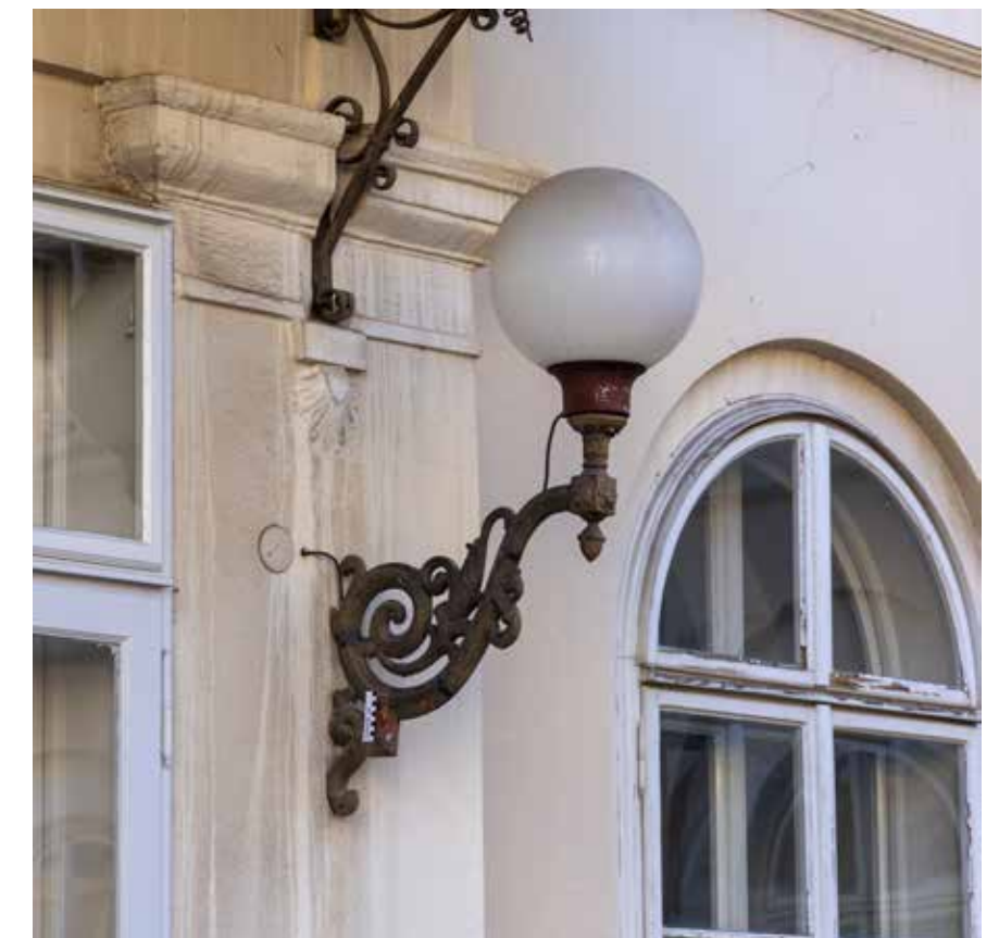
Zapadno pročelje, detalj prizemlja središnjeg rizalita
