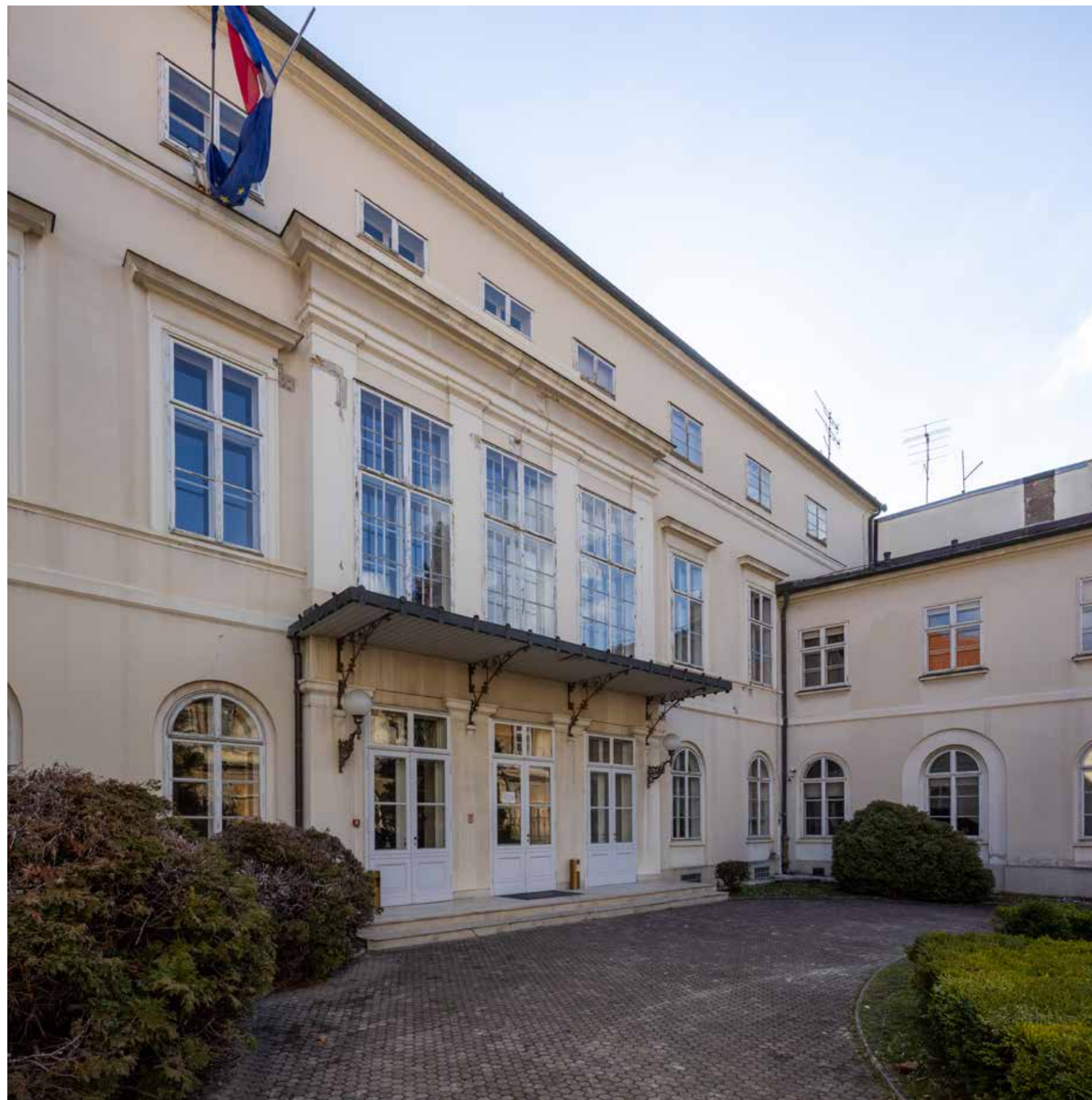
Pogled na zapadno pročelje
