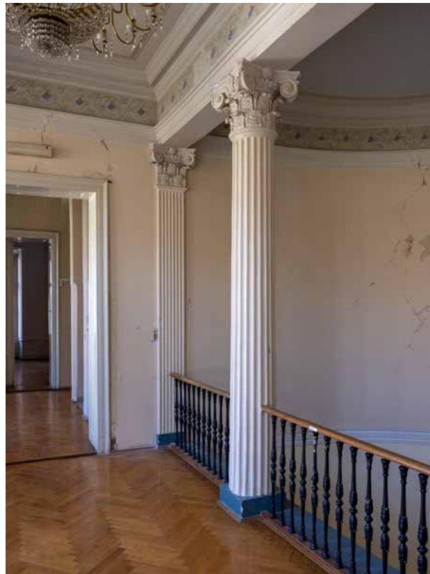
Pogled na sjeverni zid galerije stubišta, detalj izvornog oblikovanja stupova i metalne ograde
