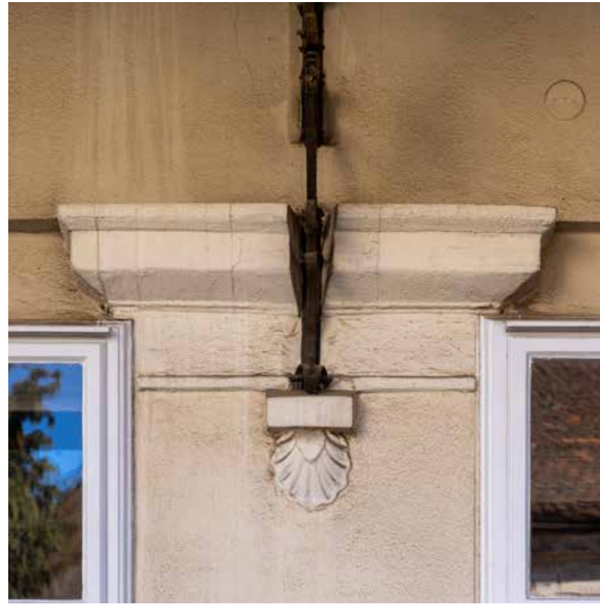
Zapadno pročelje, detalj prizemlja središnjeg rizalita
