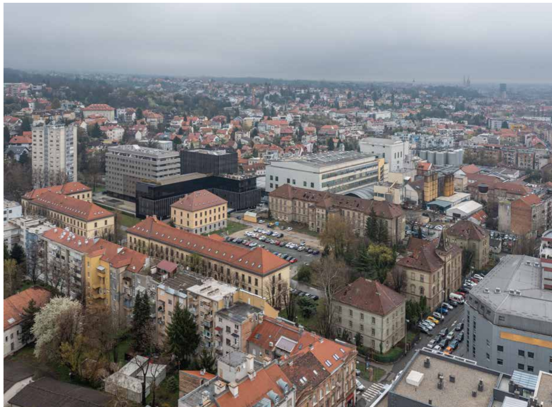
Hrvatsko katoličko sveučilište, pogled s jugozapada
