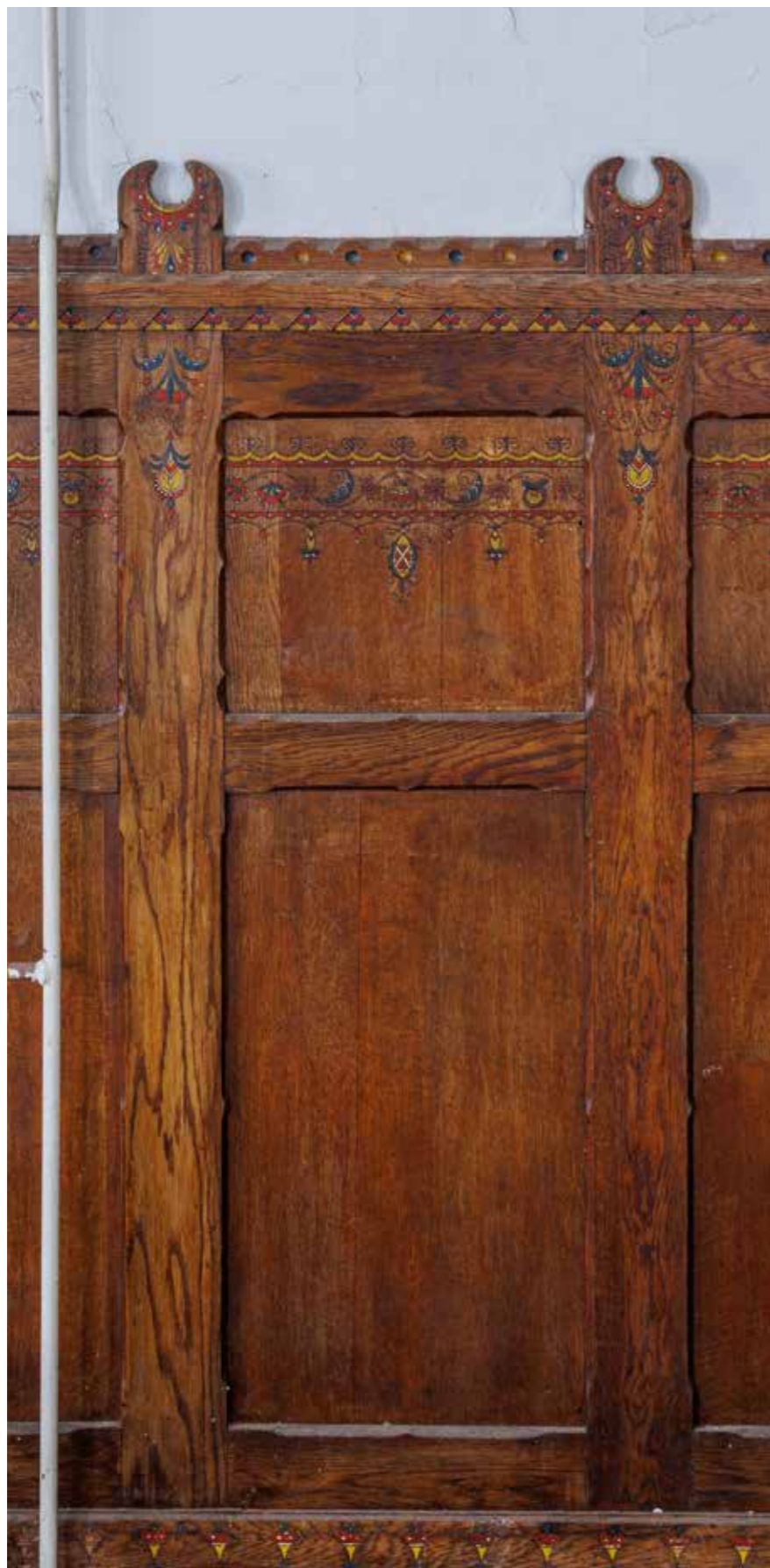
Drvena oplata na drugom katu
