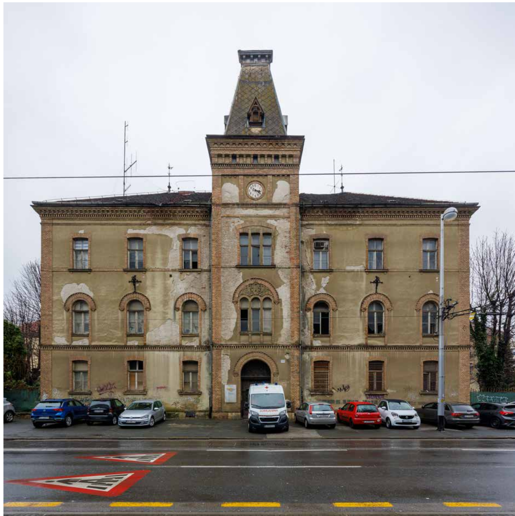
Zgrada pisarnice, južno pročelje
