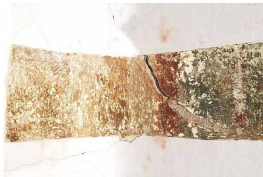
Sonde na zidu i stropu
