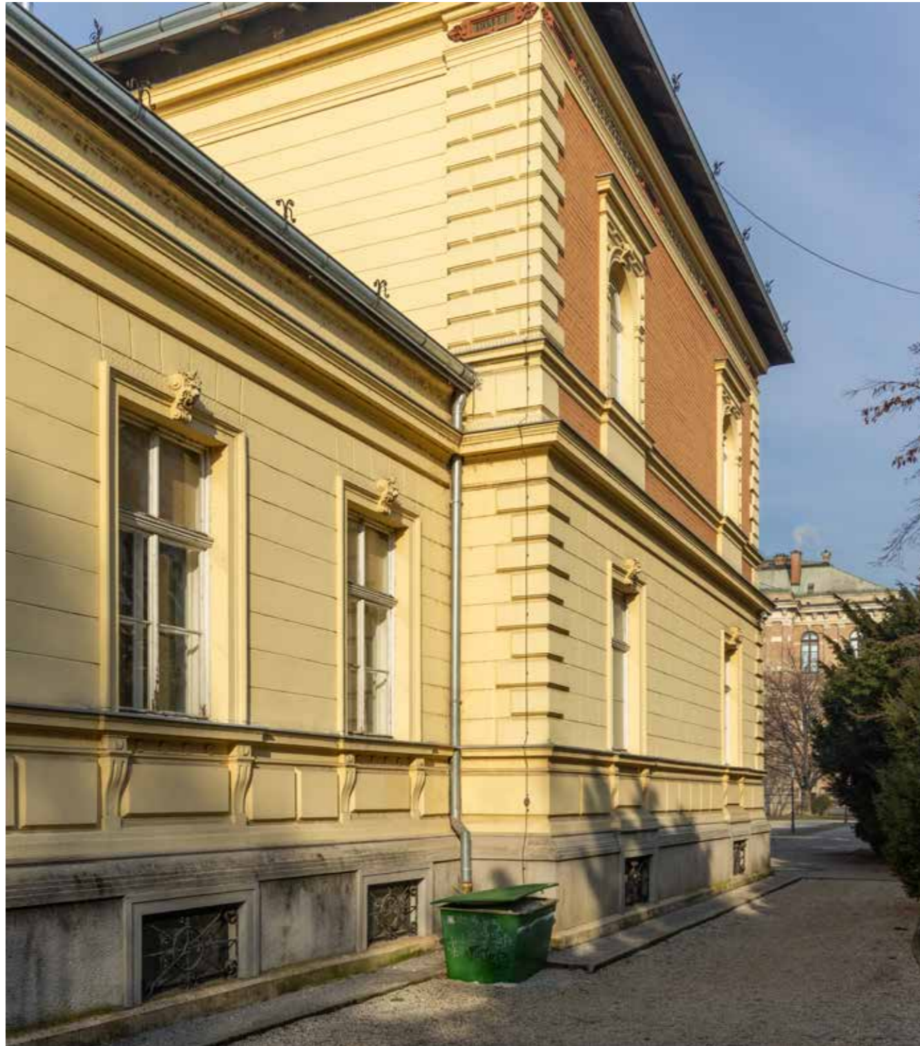
Istočna bočna fasada, pogled prema sjevernom jednokatnom krilu
