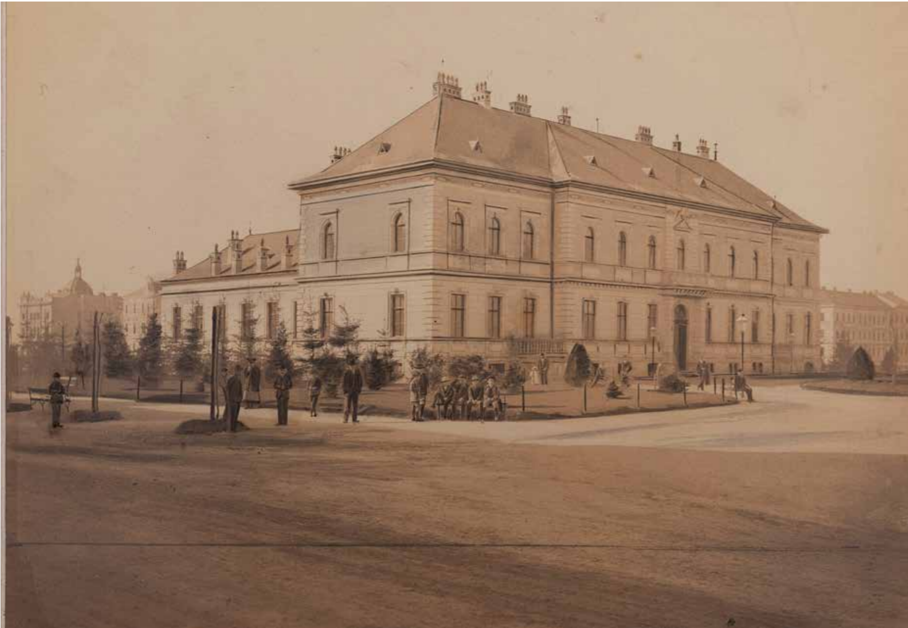
Nova zgrada Kemijskog laboratorija u Zagrebu, prije 1900., HDA
