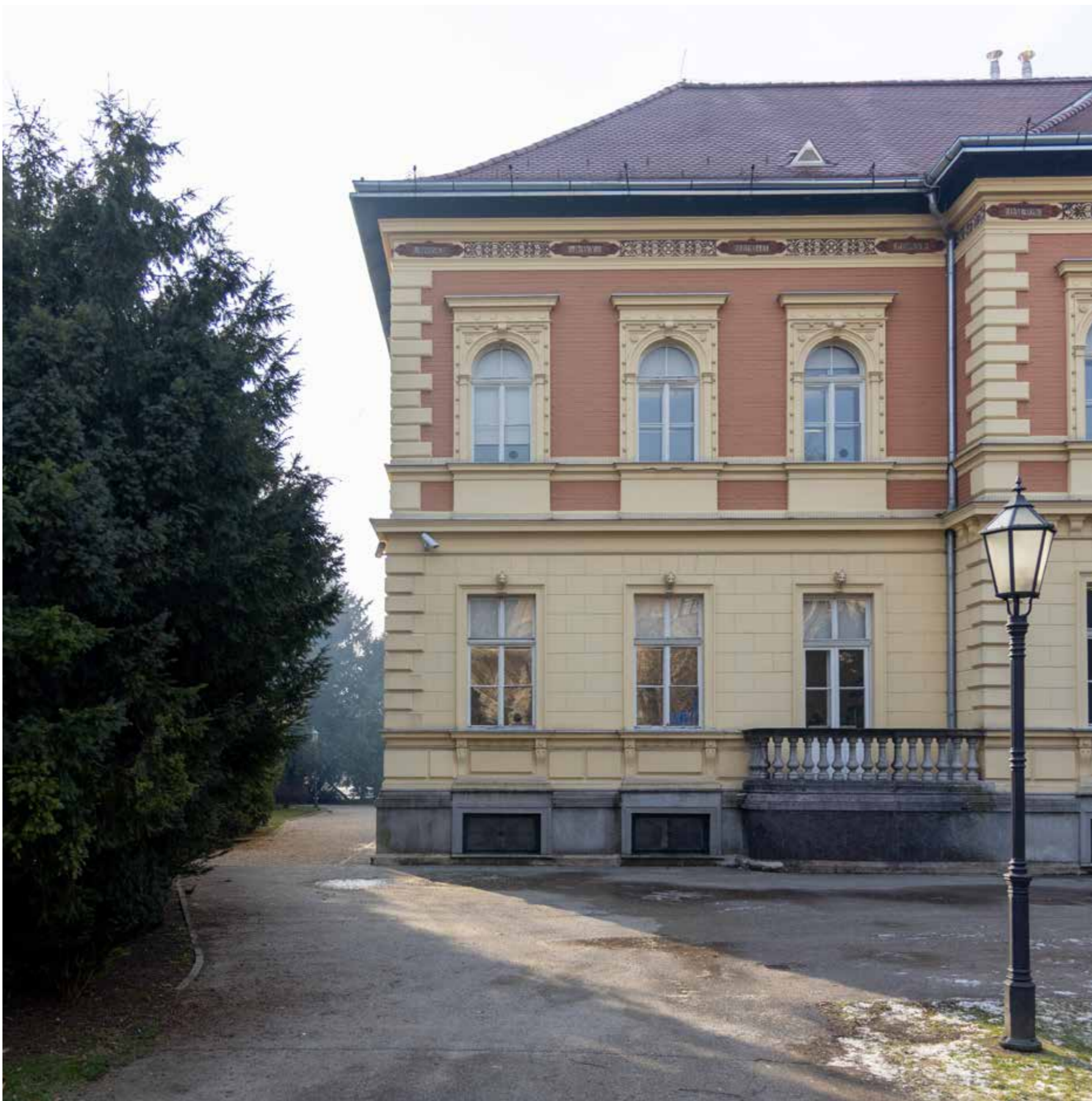
Sjeverno pročelje, detalj
