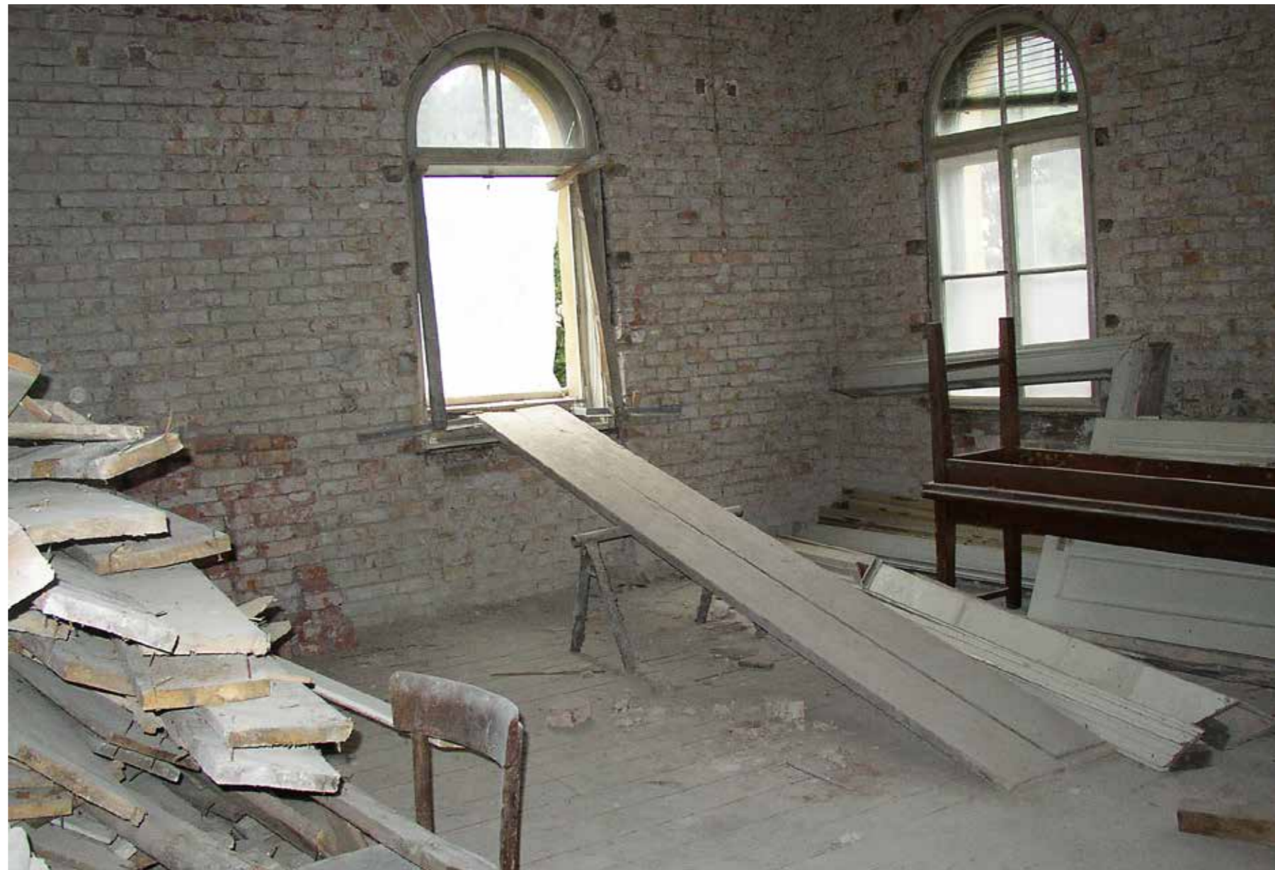
Građevinski radovi nakon iseljenja, prvi kat, snimila Aleksandra Stuparić, 2006.
