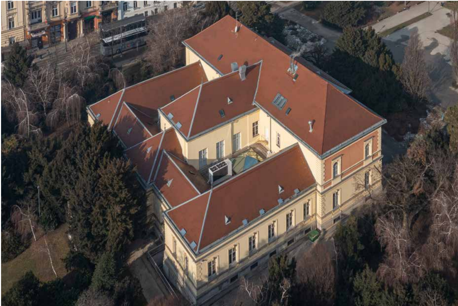
Pogled na krovšte
