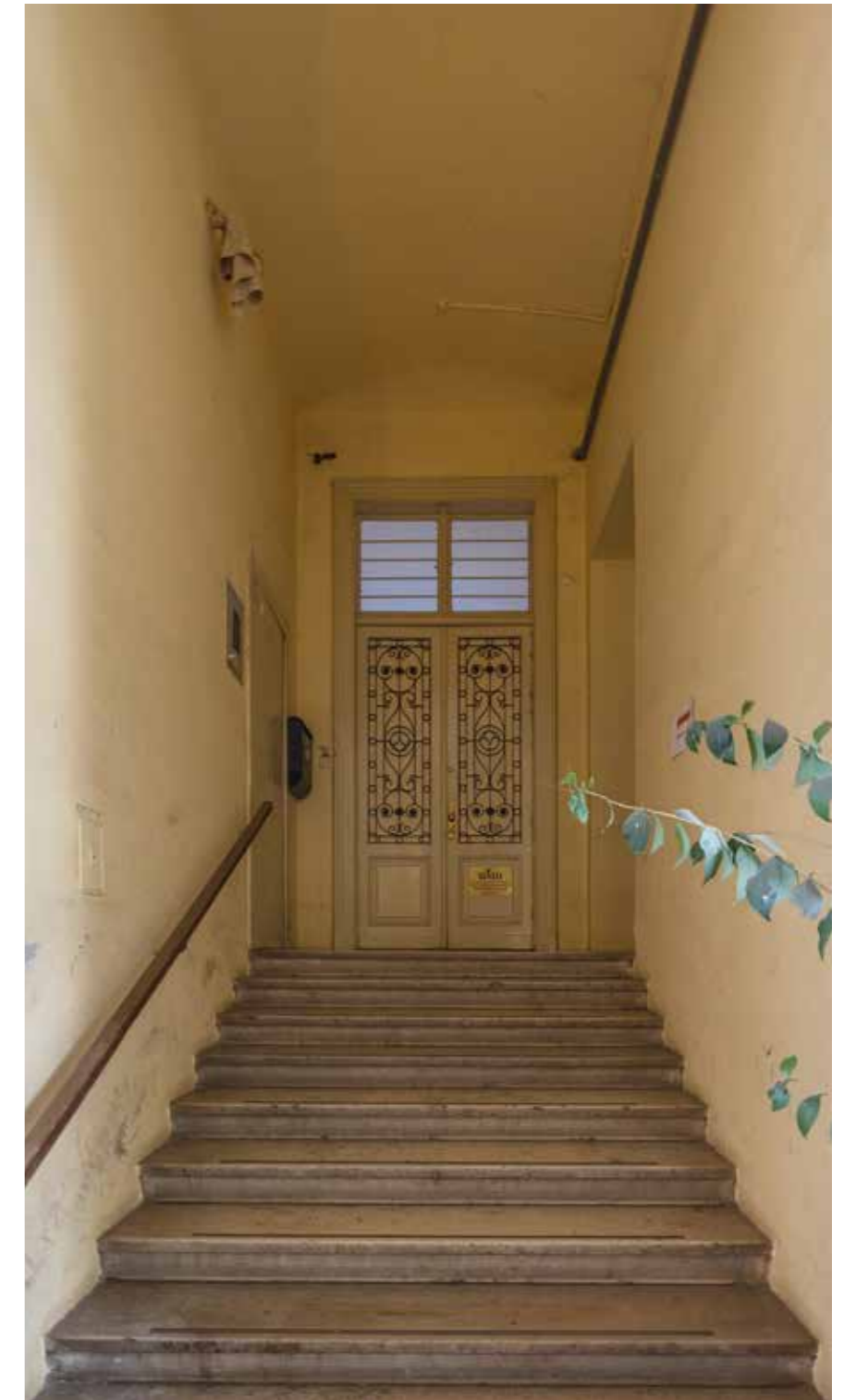
Ulaz iz veže u zapadni dio prizemlja
