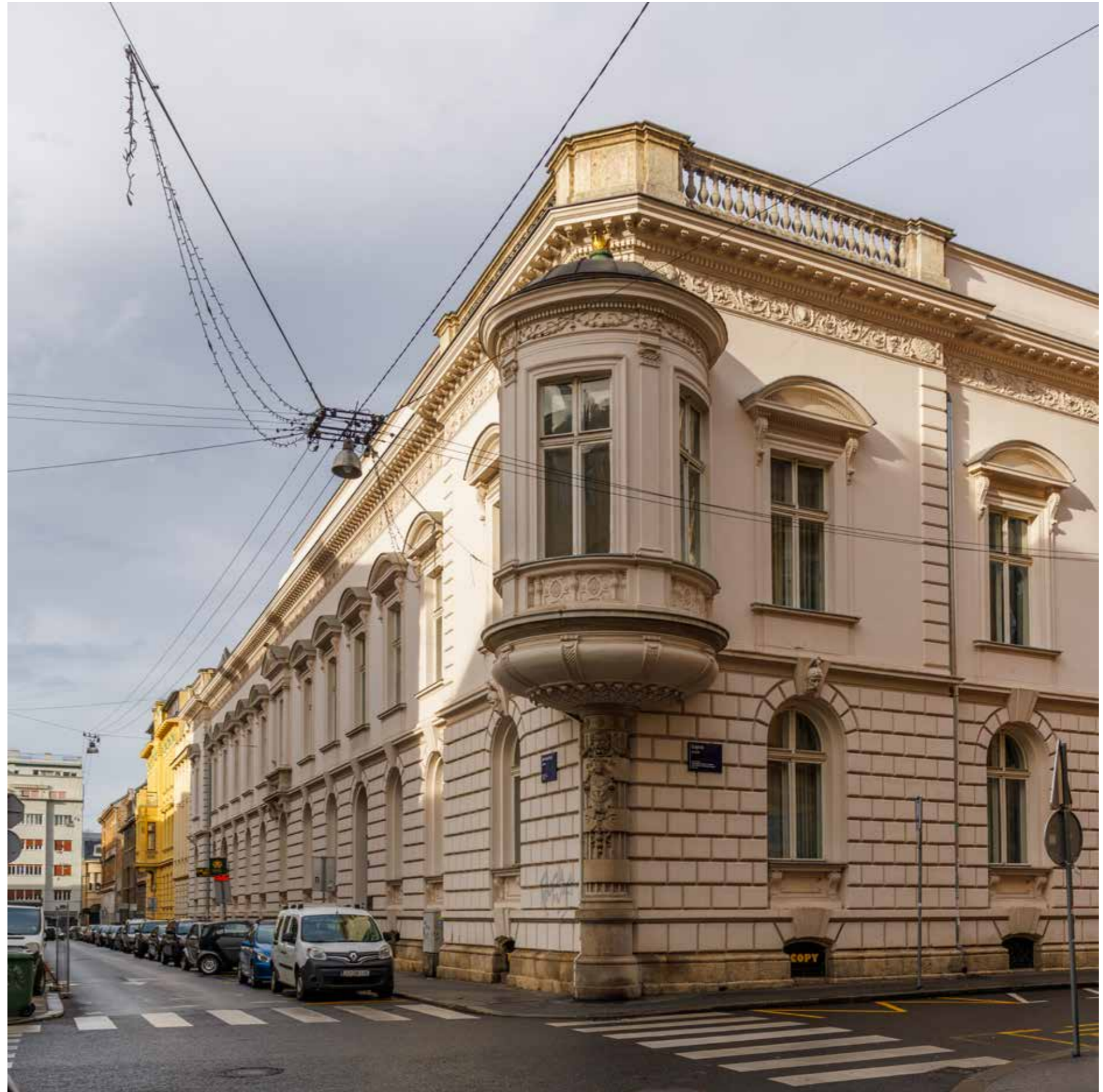
Južno i istočno pročelje s ugaonim erkerom
