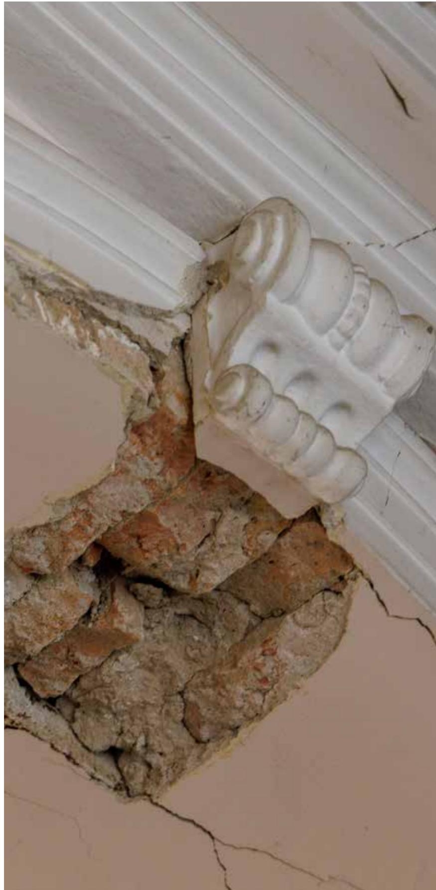
Oštećenja od potresa u interijeru
