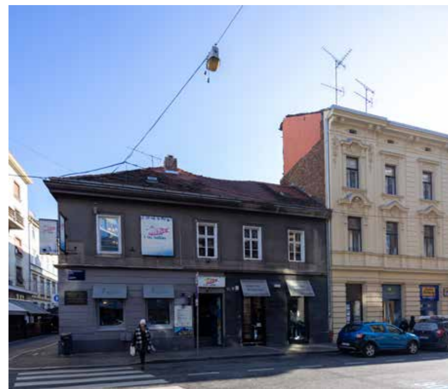
Kuća u Teslinoj ulici 9 adaptirana 1870. prema projektu Janka Jambrišaka
