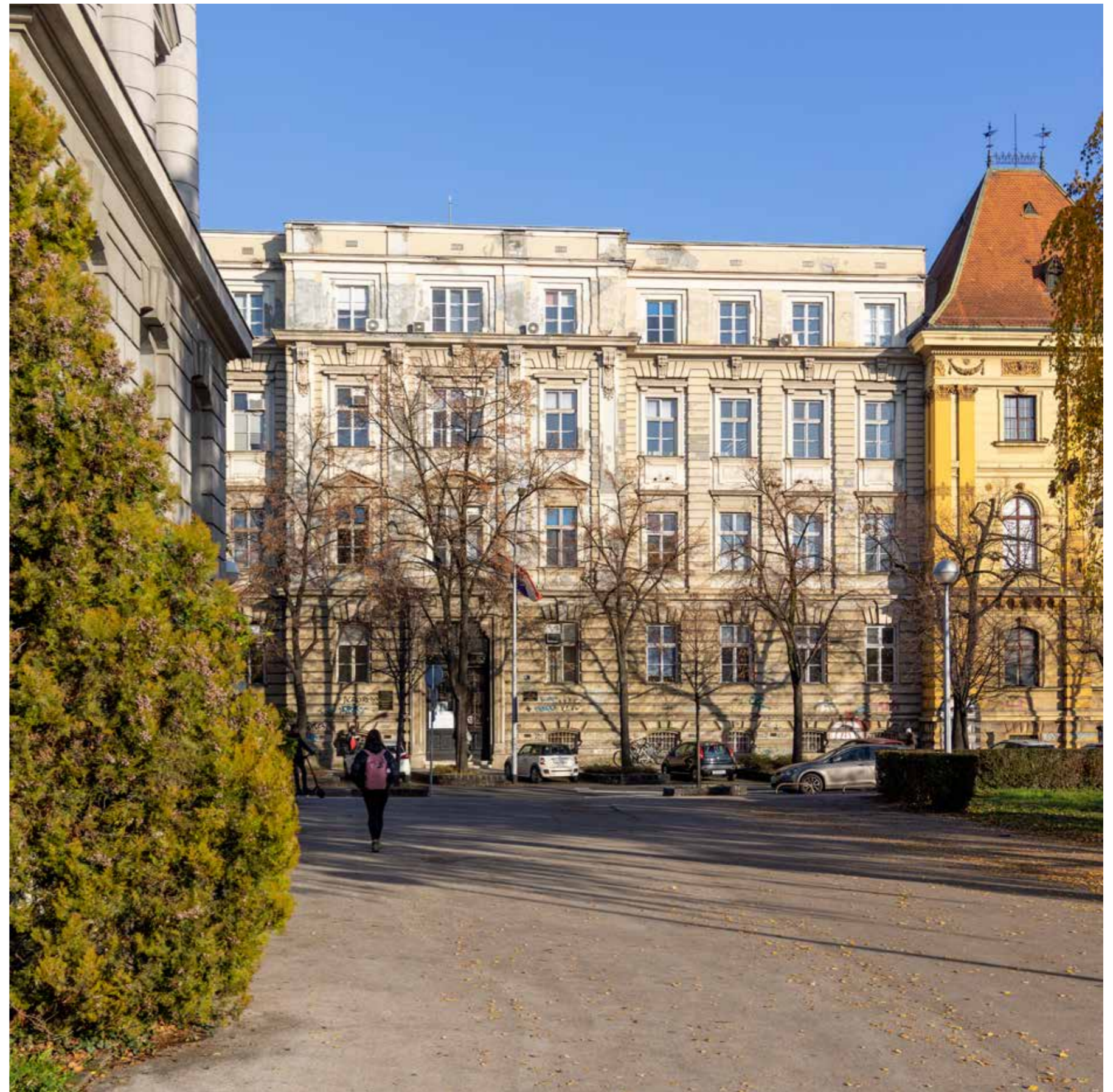
Glavna zgrada – južno ulično pročelje
