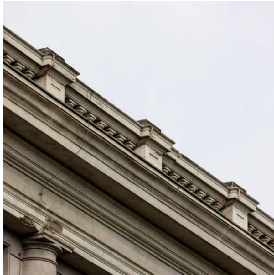
Detalj nadozida na istočnom pročelju
