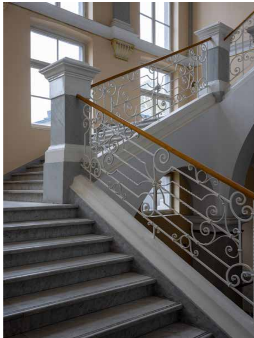
Ograda u stubištu
