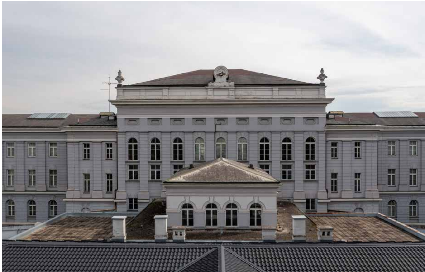
Zapadno pročelje Muzeja Mimara
