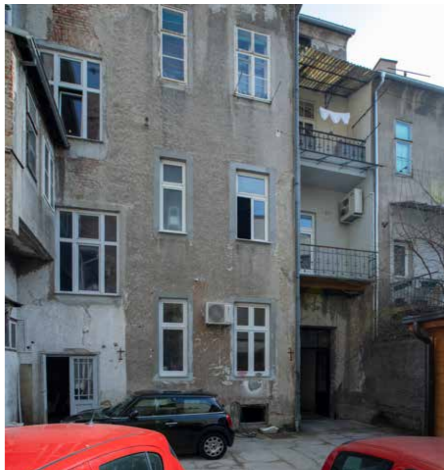
Dvorišno zapadno začelje
