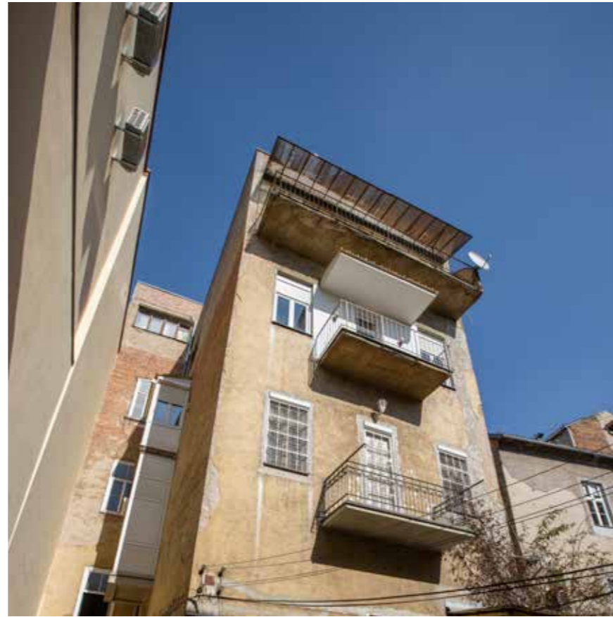
Dvorišno južno začelje
