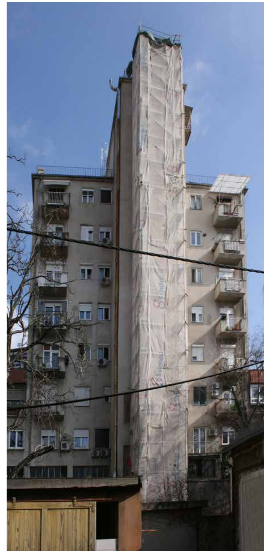
Prva dvorišna zgrada, zapadno pročelje
