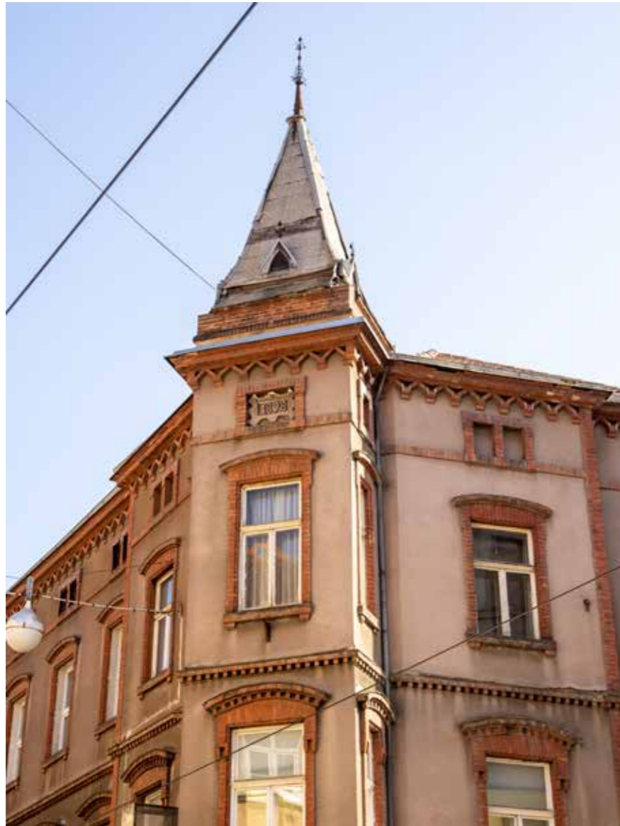
Kuća Rossipal, Medulićeva 2, ugaoni toranj
