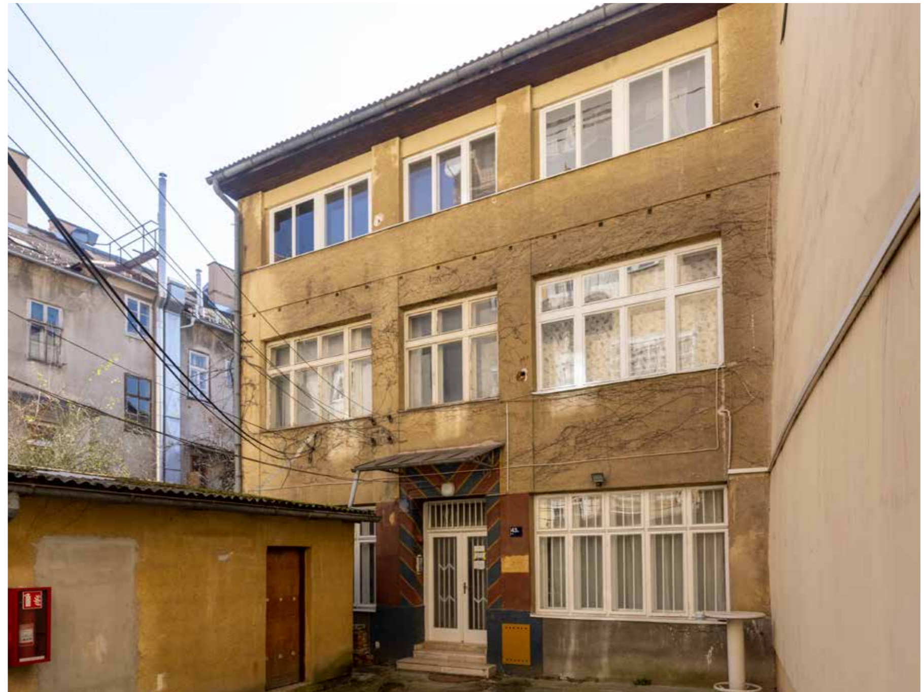
Dvorišno sjeverno pročelje
