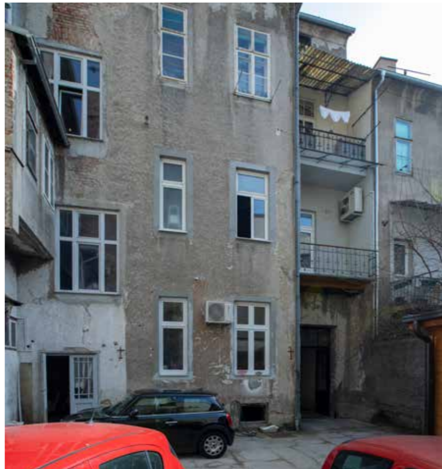
Dvorišno zapadno začelje
