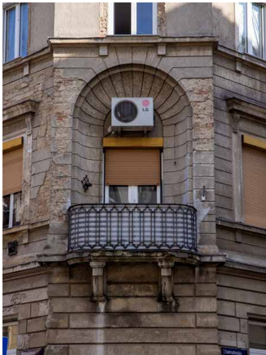
Ugaoni rizalit s balkonom
