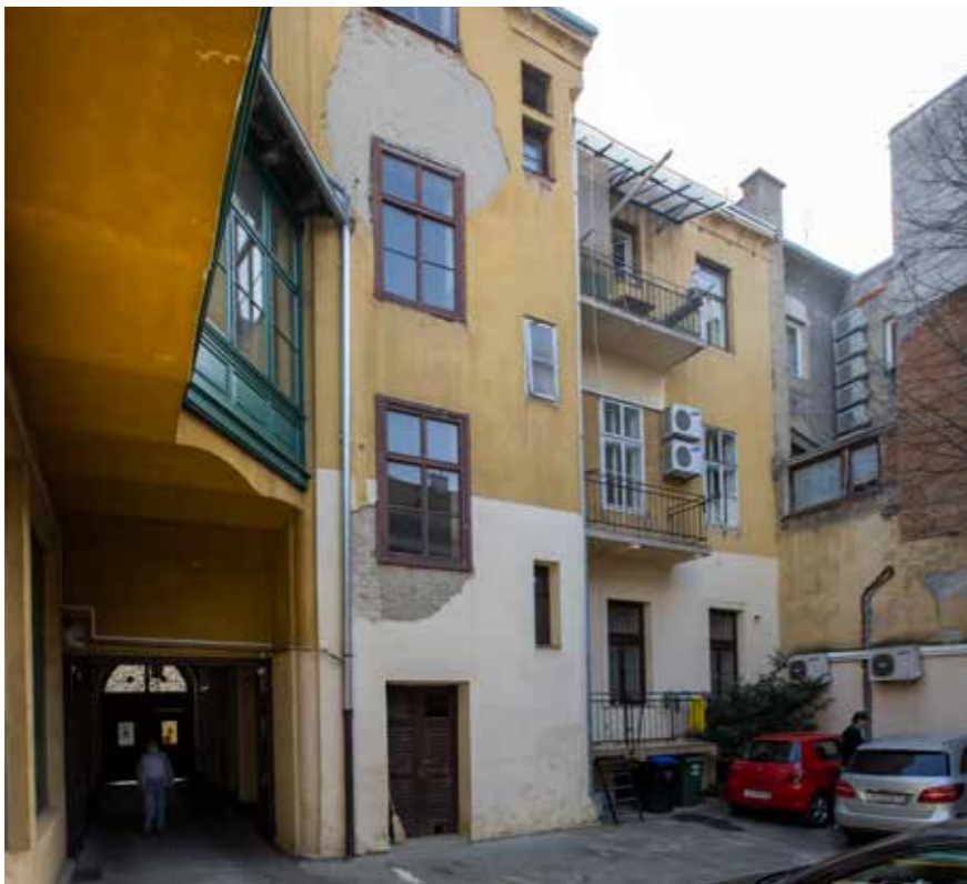
Dvorišno zapadno začelje
