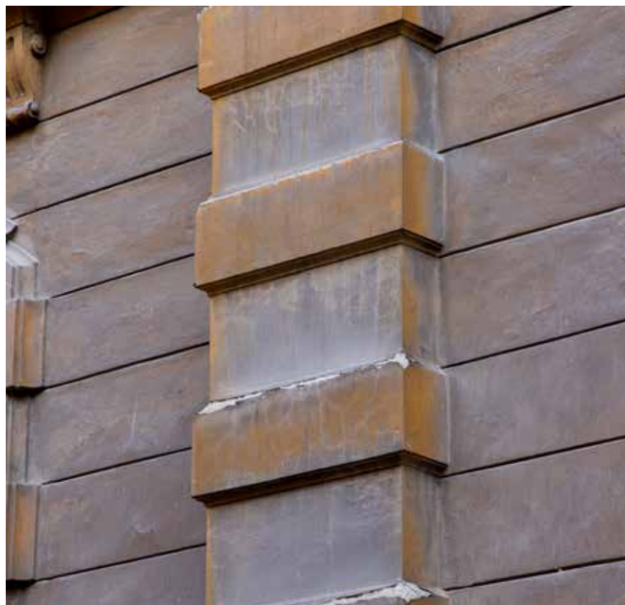
Pilastar u prizemnoj zoni pročelja
