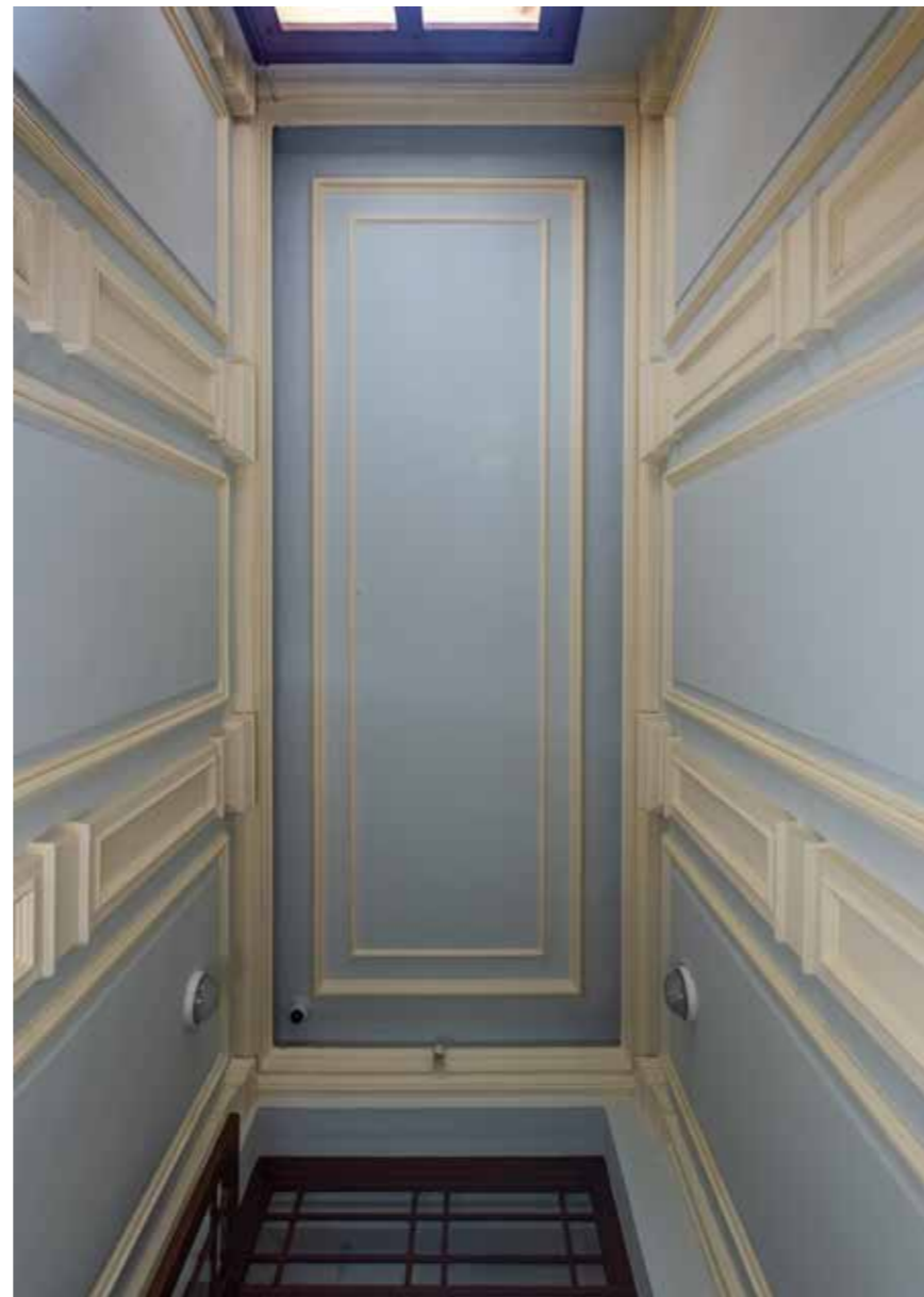
Strop u ulaznom prostoru
