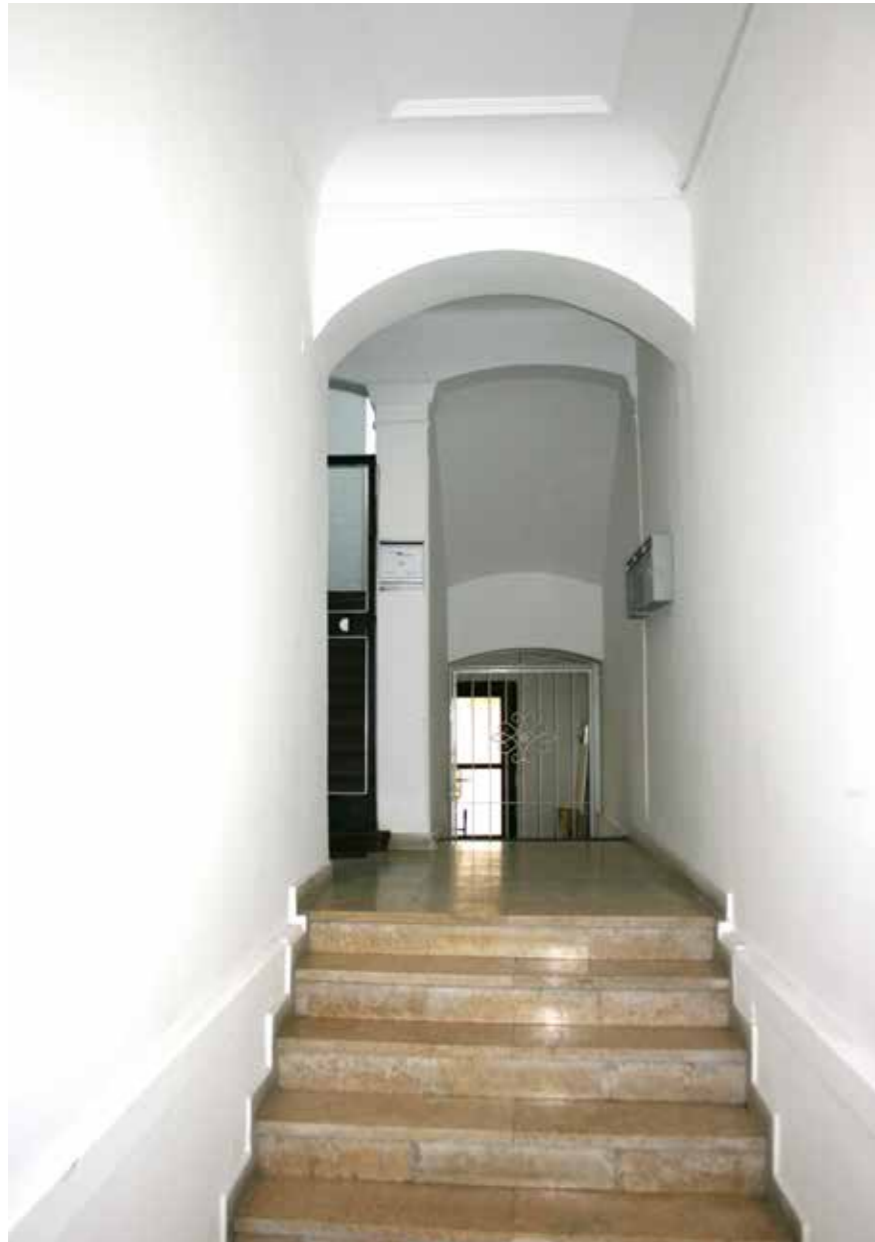
Ulazni prostor i stubište
