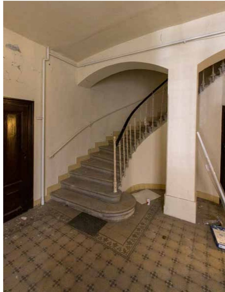
Predvorje sa stubištem unutrašnjeg (dvorišnoga) krila
