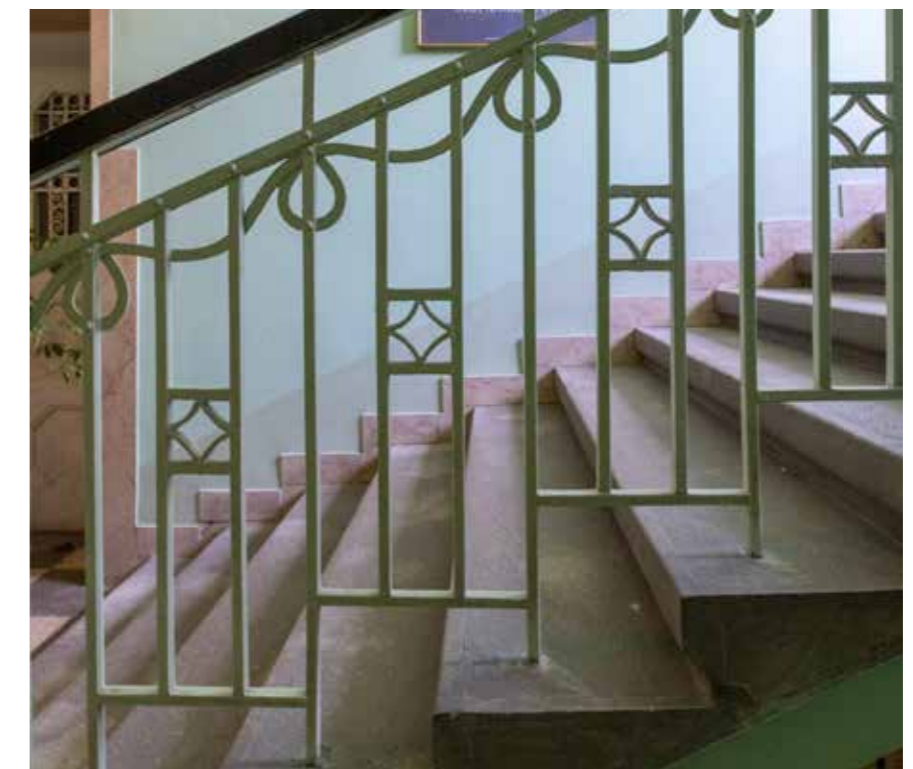
Ograda u stubištu
