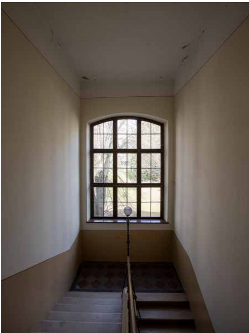
Prozor u stubištu
