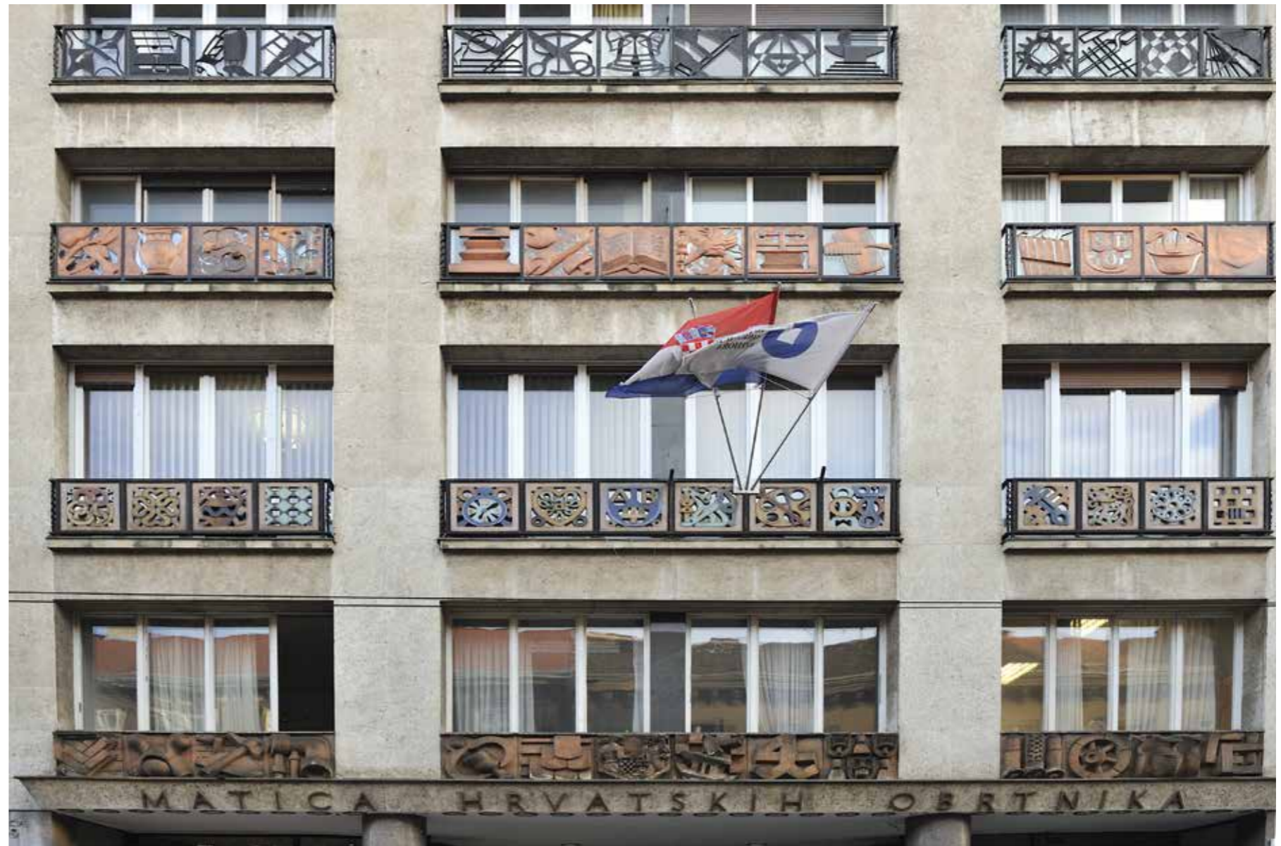
Ulično sjeverno pročelje, detalj s reljefima i balkonskim ogradama
