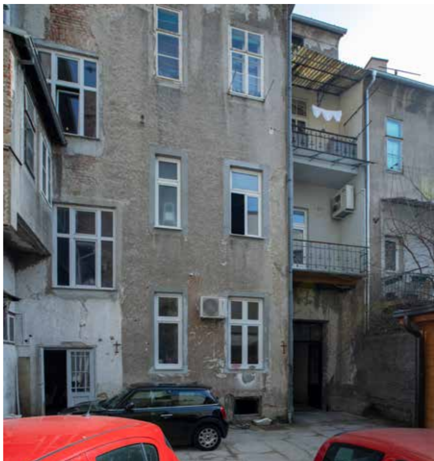
Dvorišno zapadno začelje
