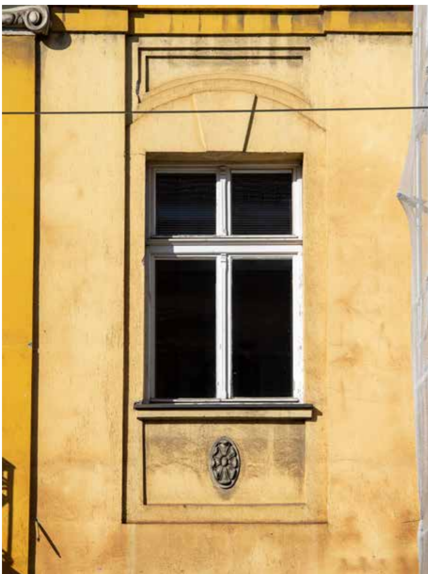
Prozor na prvom katu • Akroterij • Pilastar
