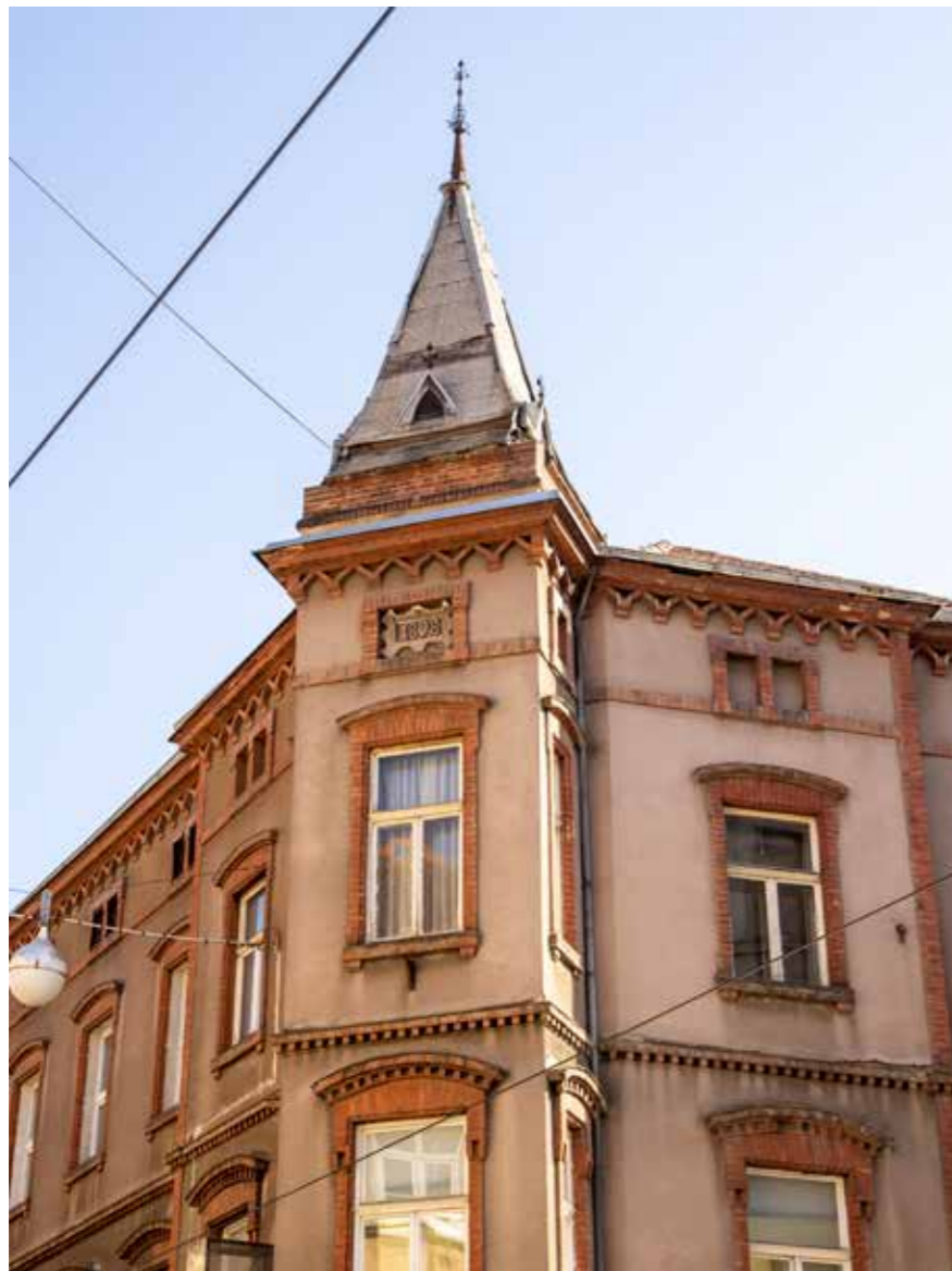
Kuća Rossipal, Medulićeva 2, ugaoni toranj
