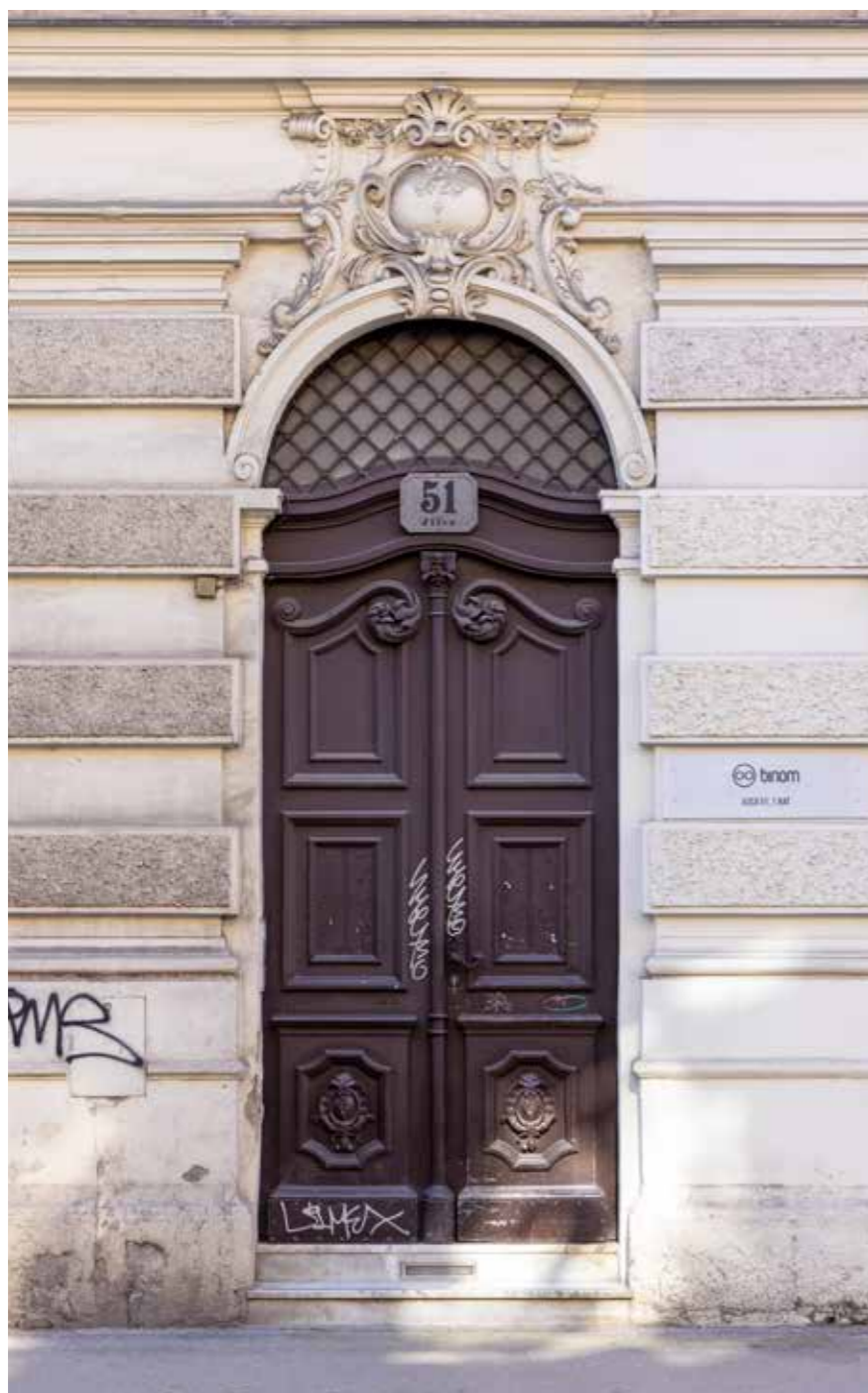
Pročelni portal • Prozor na prvom katu
