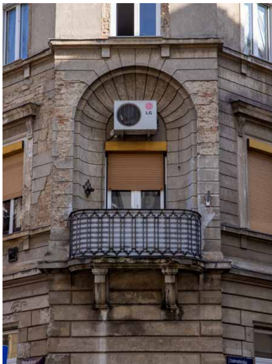
Ugaoni rizalit s balkonom
