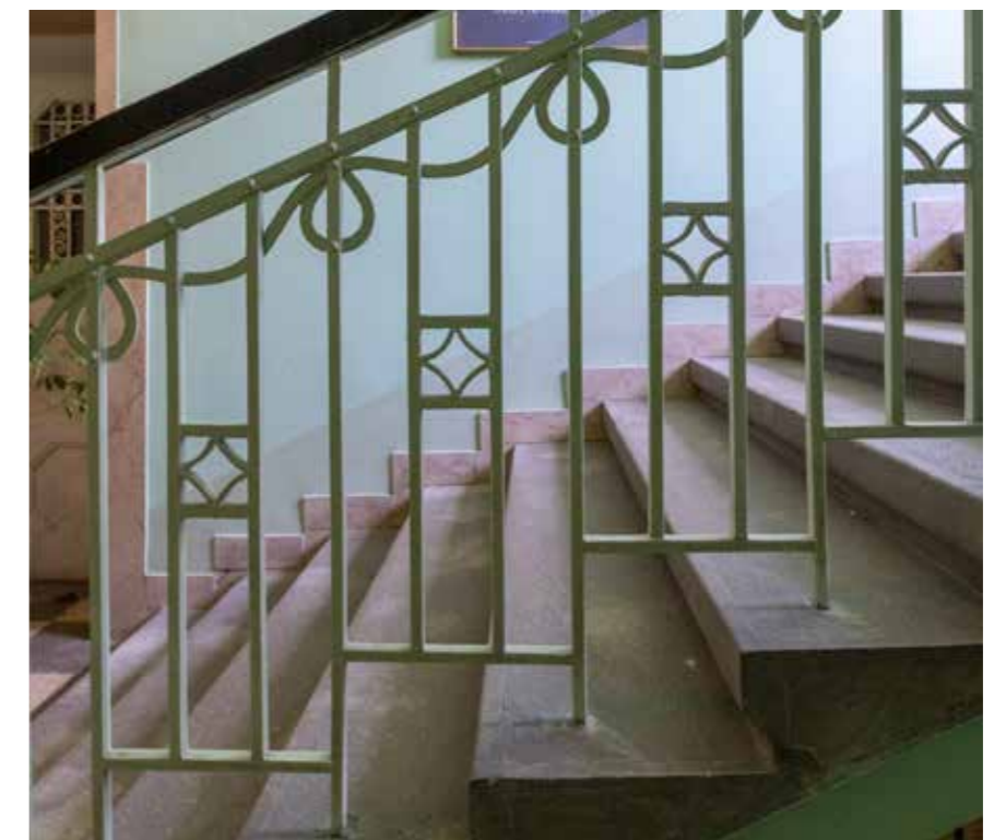
Ograda u stubištu
