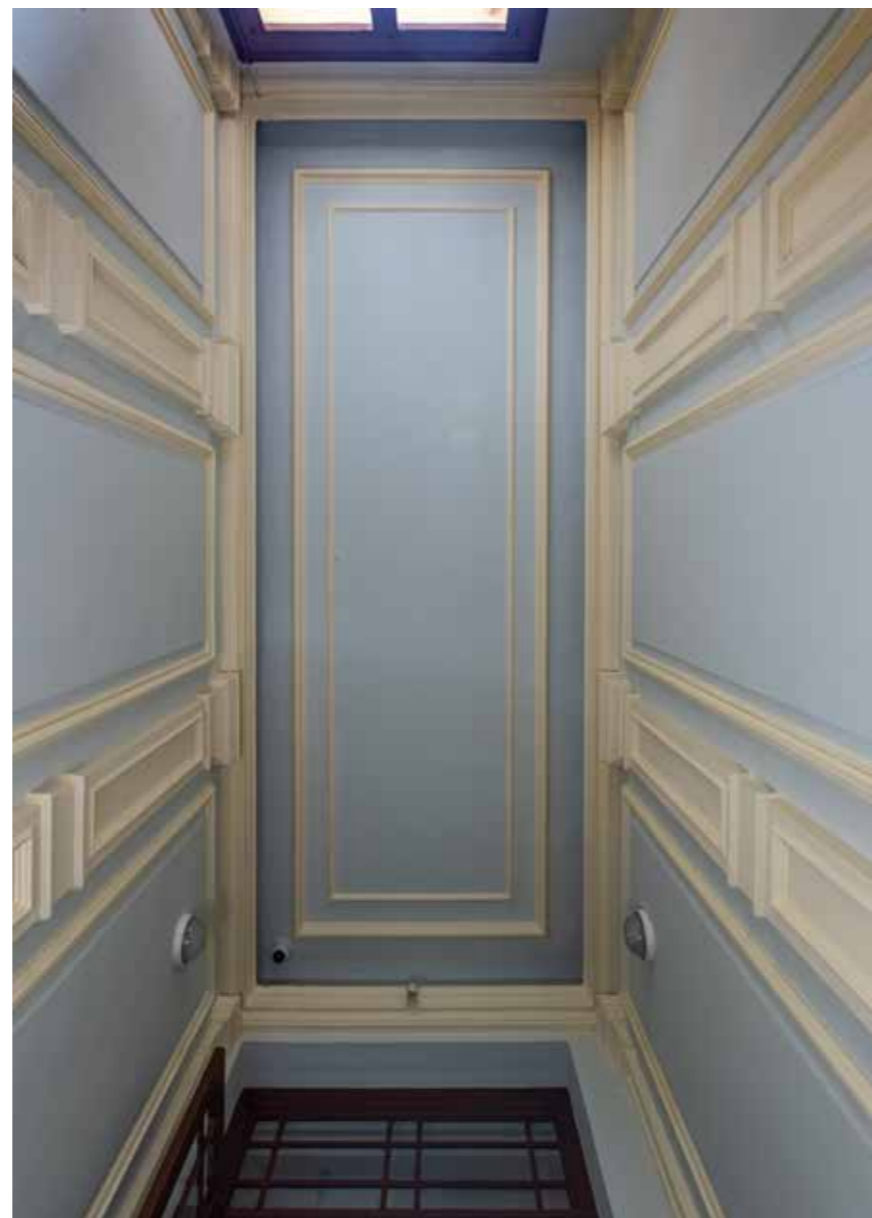
Strop u ulaznom prostoru
