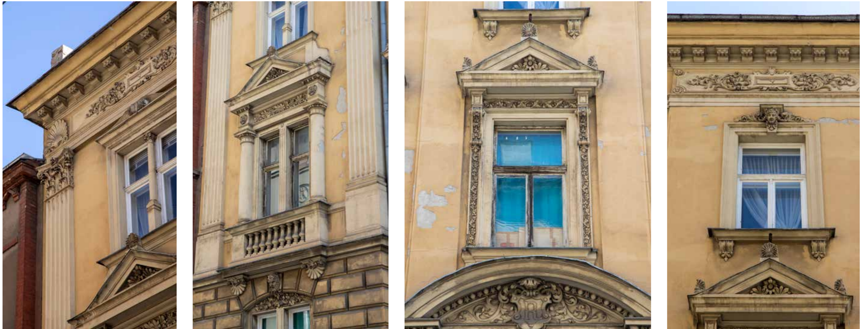
Dvojni prozori na rizalitu • Prozor na prvom katu • Prozor na drugom katu
