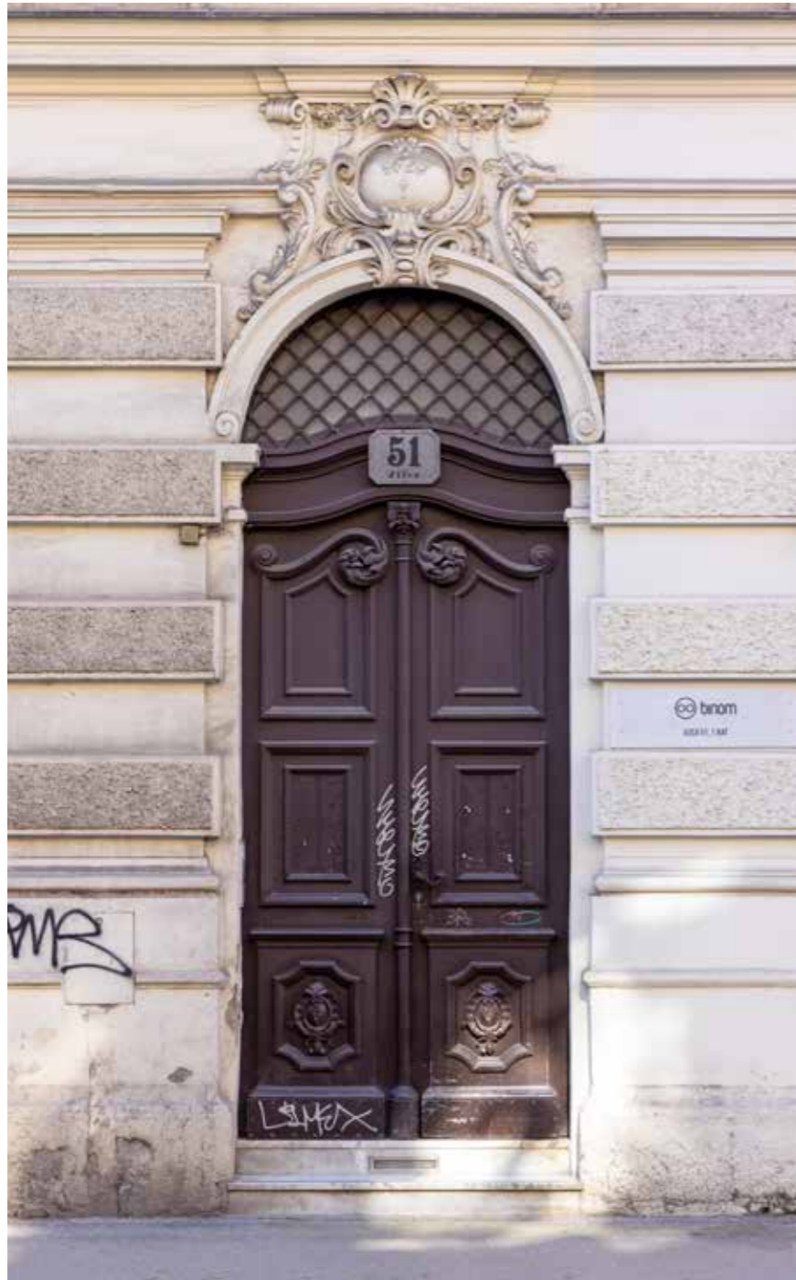
Pročelni portal • Prozor na prvom katu
