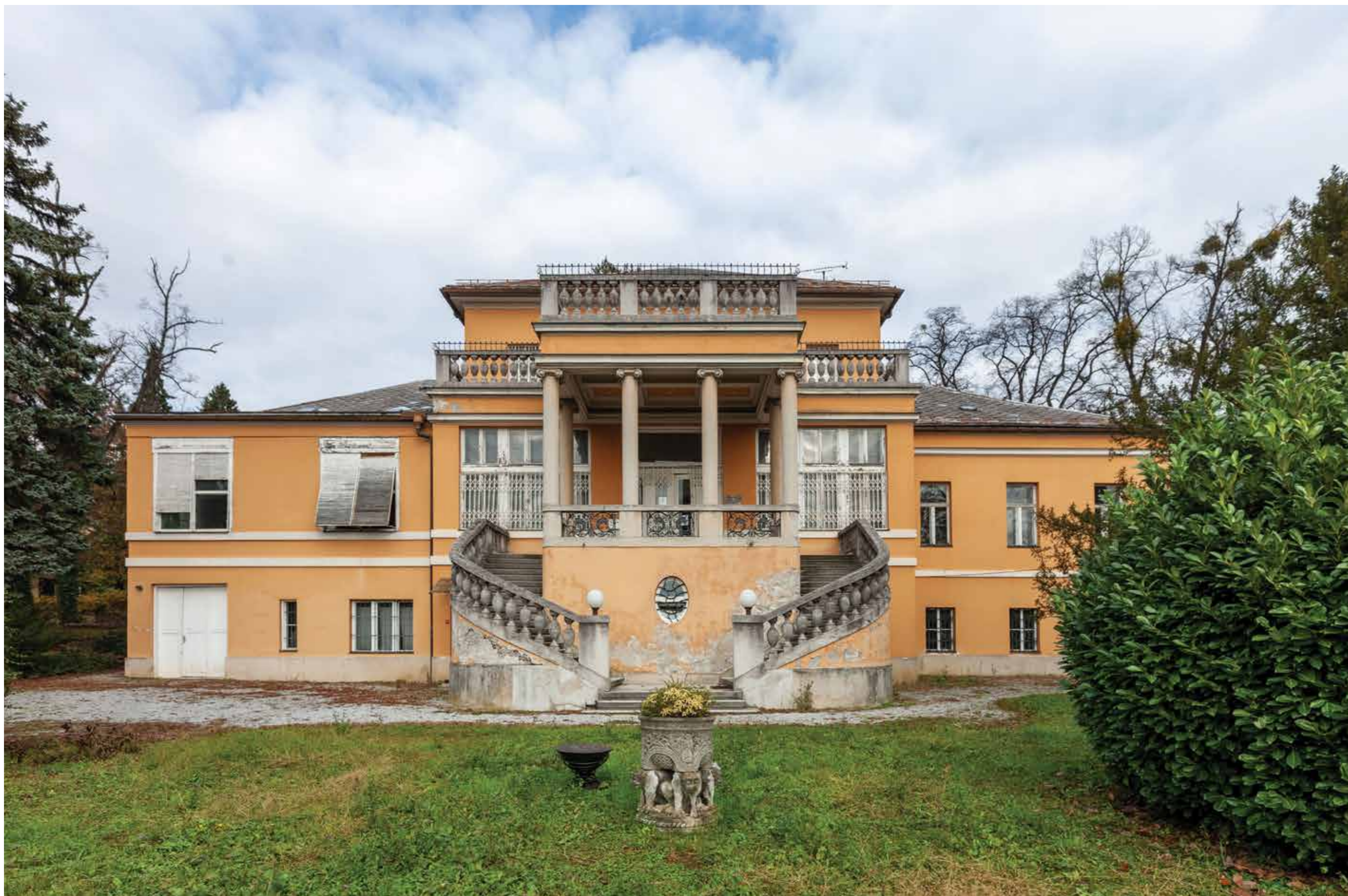
Južno ulazno pročelje
