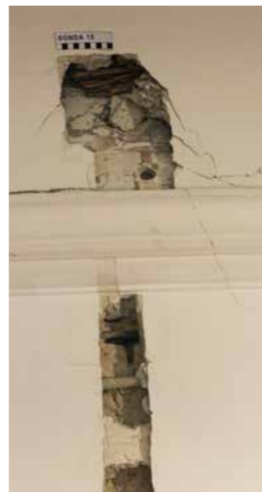
Sonda 15 iznad vrata na južnom zidu sjeverozapadnog salona u prizemlju s tragovima dekorativnih naliča koji pokazuju drukčije oblikovanje svoda prostorije
