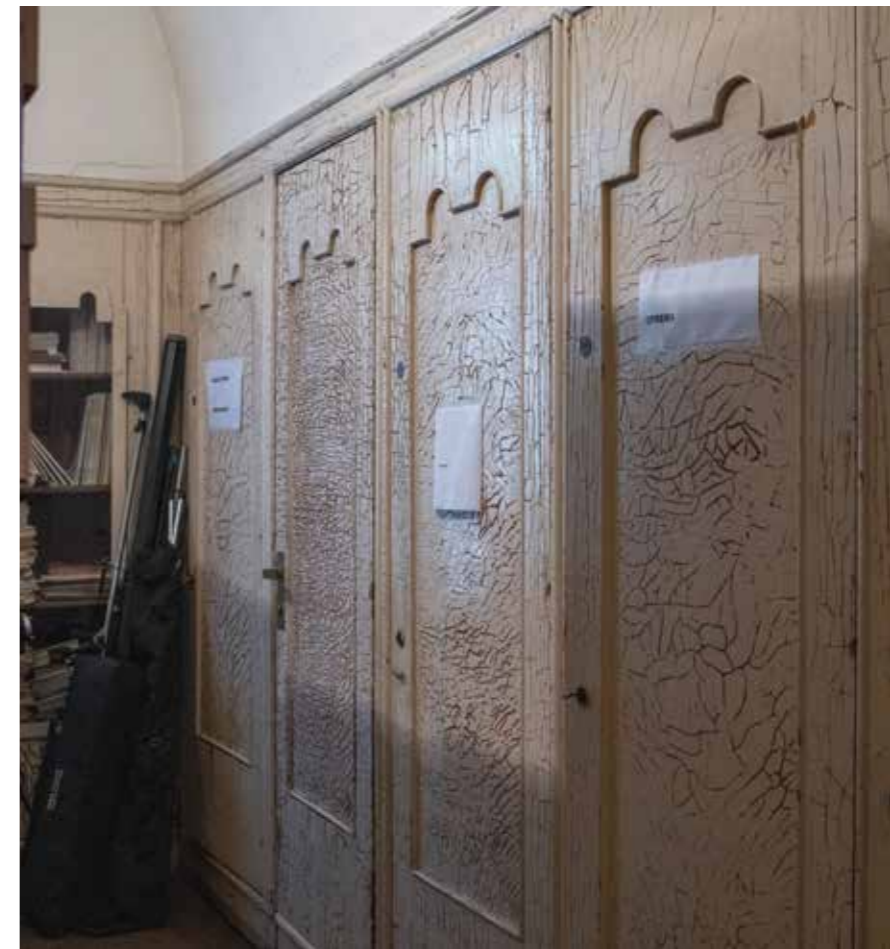
Prizemlje, drveni ormari i obloga garderobe
