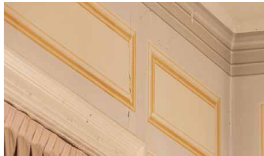
Tipični primjeri oštećenja nastalih u potresu
