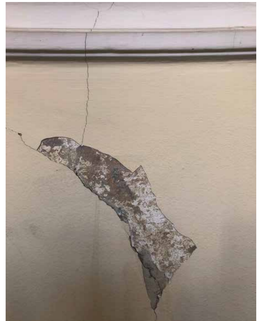
Tipični primjeri oštećenja nastalih u potresu
