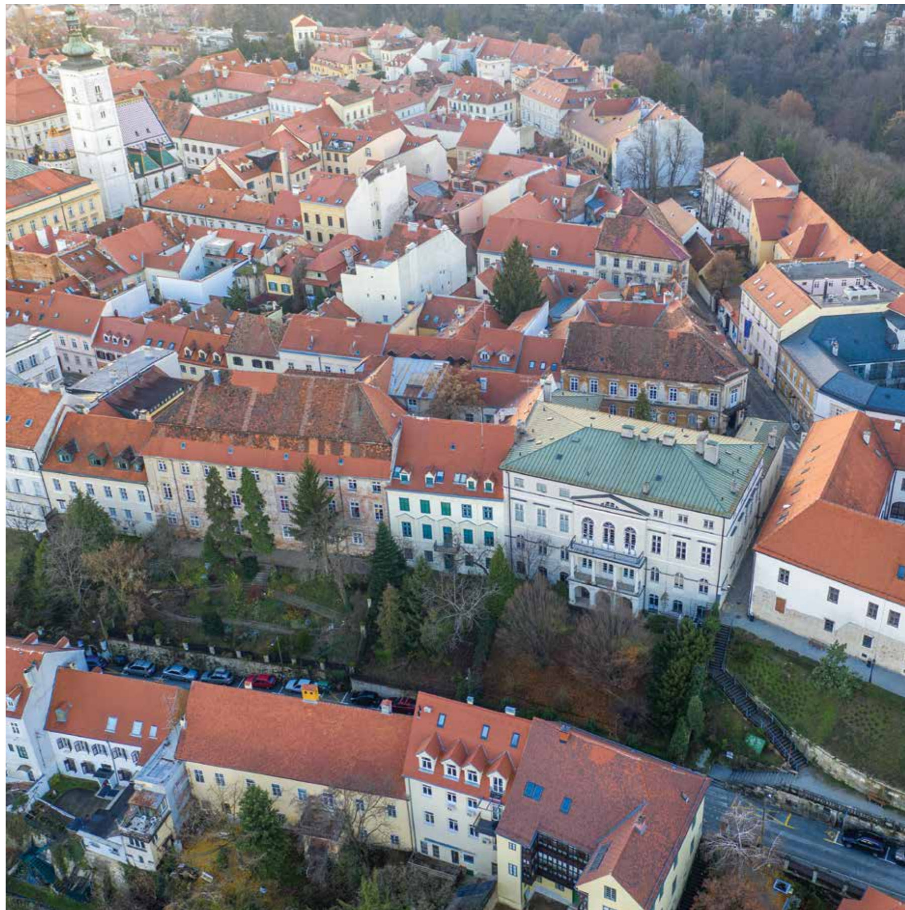
Pogled na palaču Drašković / Narodni dom HAZU sa sjeveroistoka
