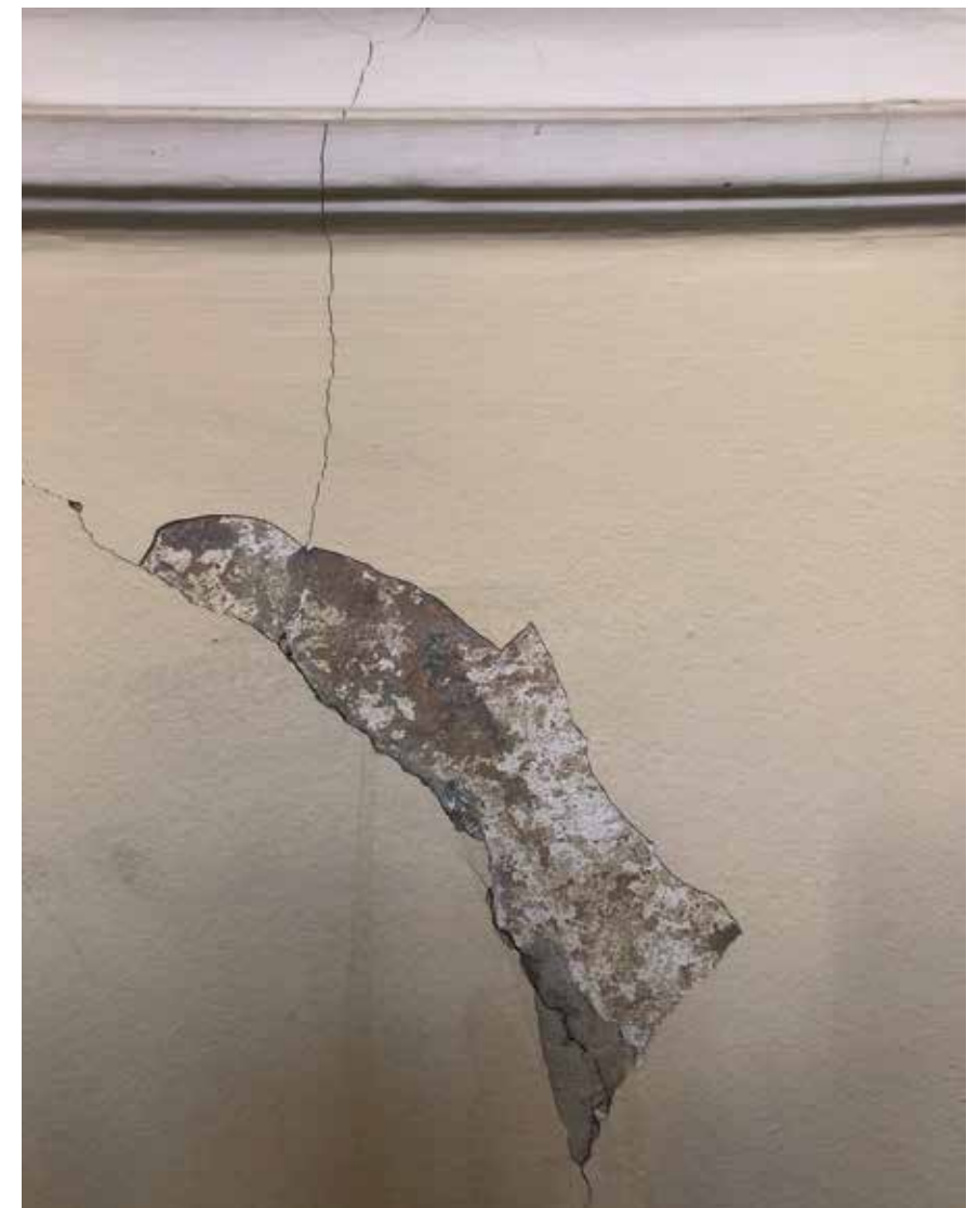
Tipični primjeri oštećenja nastalih u potresu
