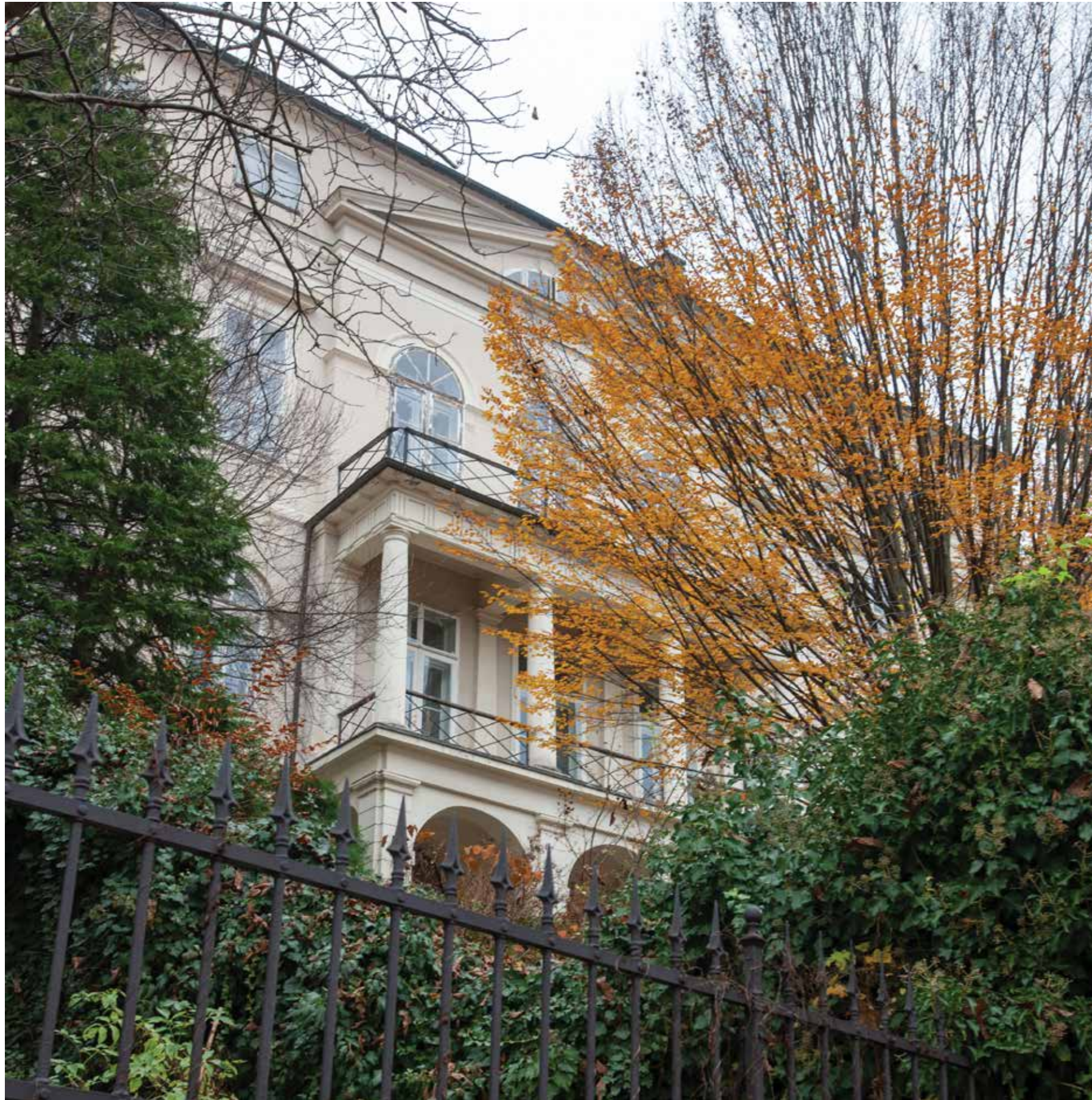
Istočno pročelje s altanom
