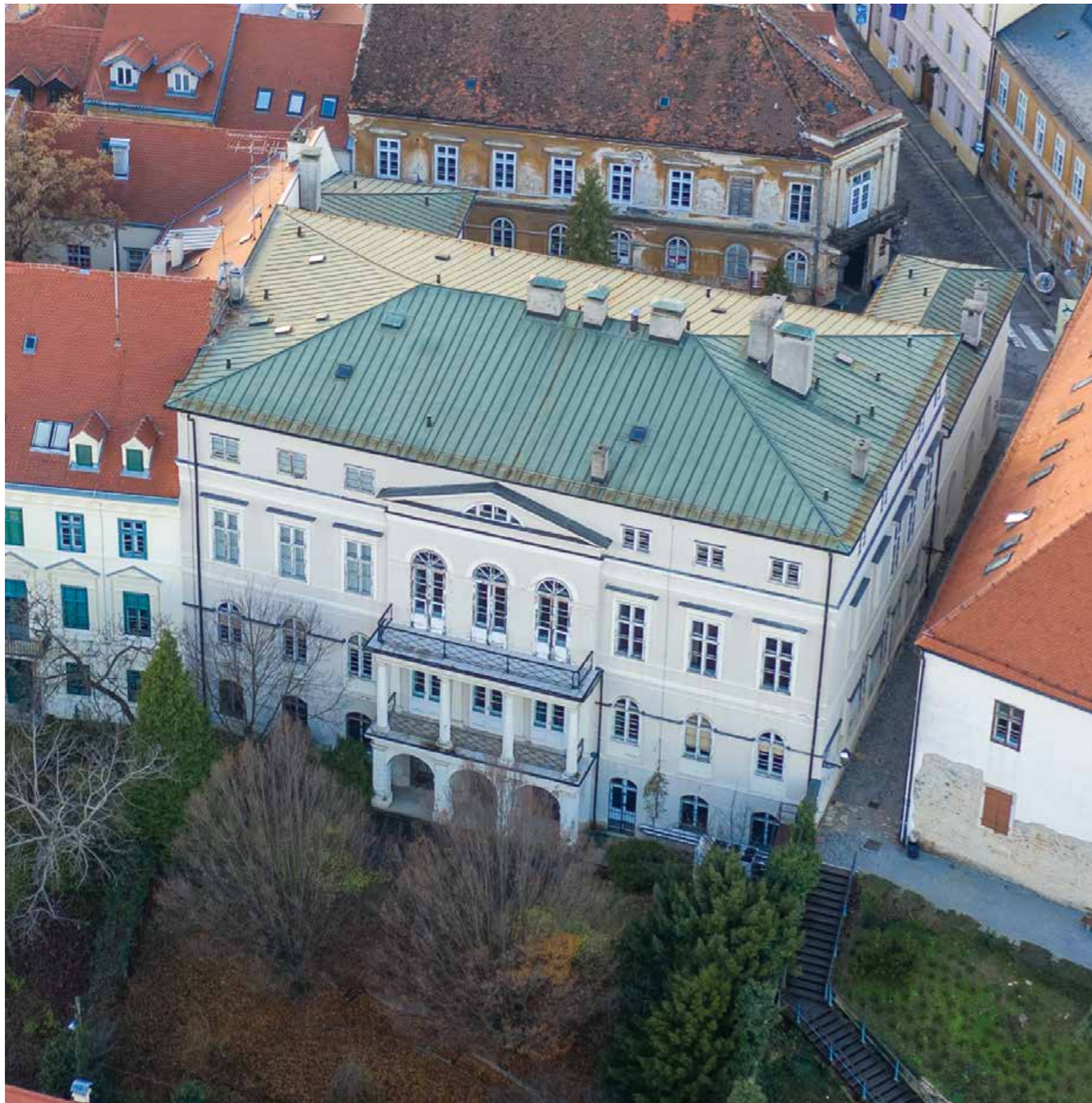
Istočno pročelje s altanom
