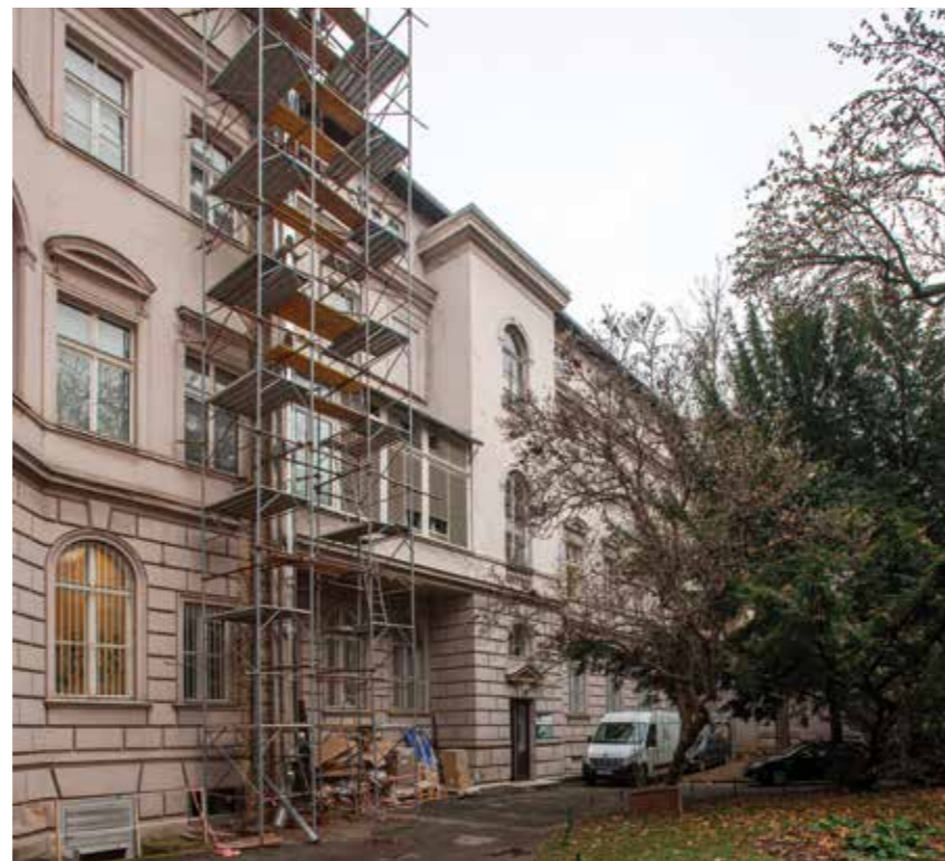
Dvorišna pročelja sjevernog i istočnog krila
