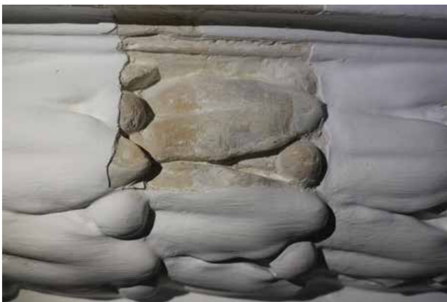
Sonda 2 u vestibulu s nalazom izvornog oker naliča
