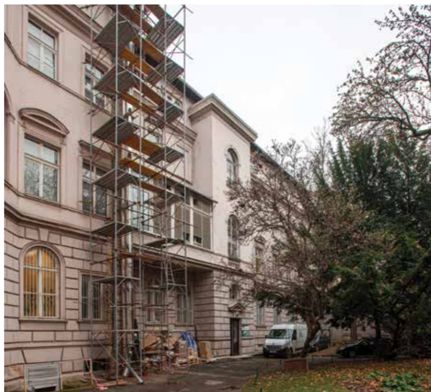
Dvorišna pročelja sjevernog i istočnog krila
