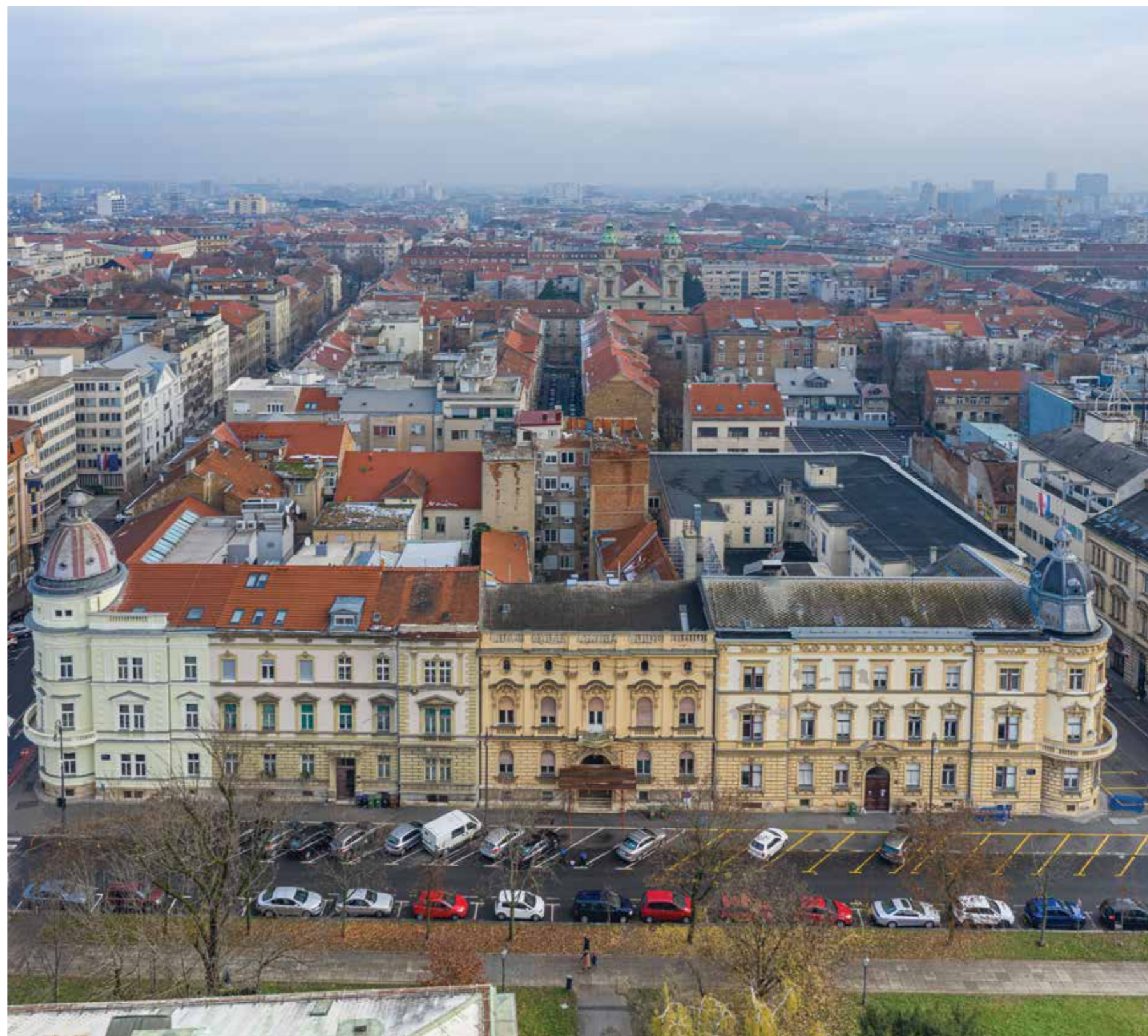
Ortogonalni pogled na blok s kompleksom palače Prister izvorno od Strossmayerova trga do Petrinjske ulice
