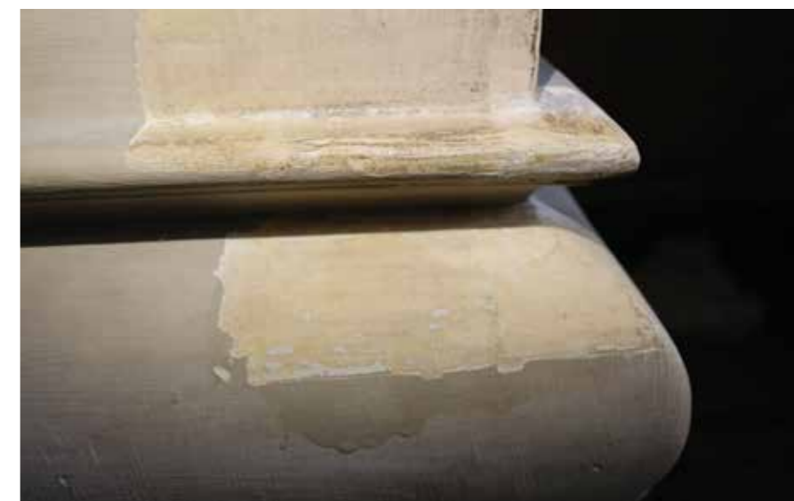
Sonde 19 i 20 na balustrima u stubištu s vidljivom izvornom marmorizacijom
