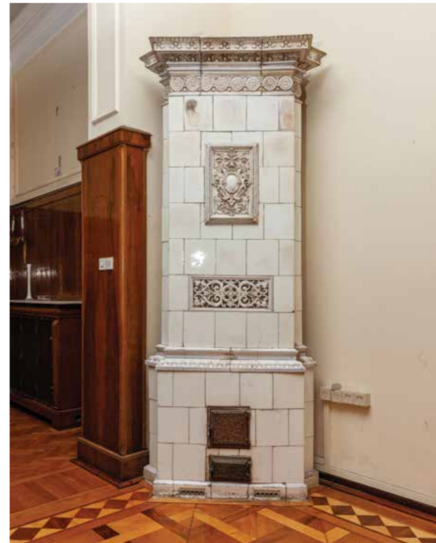
Kaljeva peč u sjevernoj dvorani
