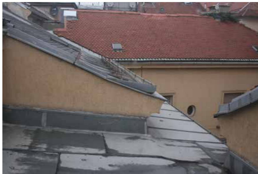
Središnji dio krovišta sa svjetlikom
