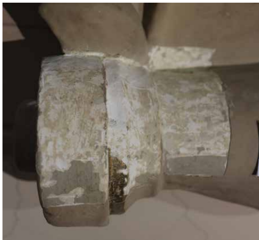
Sonda 17 na kapitelu u galeriji na drugom katu atrija (južni zid) s vidljivom izvornom pozlatom
