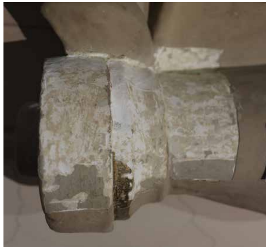
Sonda 17 na kapitelu u galeriji na drugom katu atrija (južni zid) s vidljivom izvornom pozlatom
