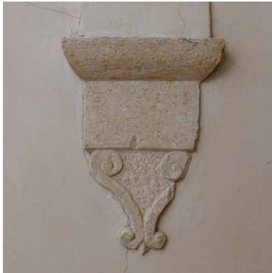
Konzola na podestu na prvom katu
