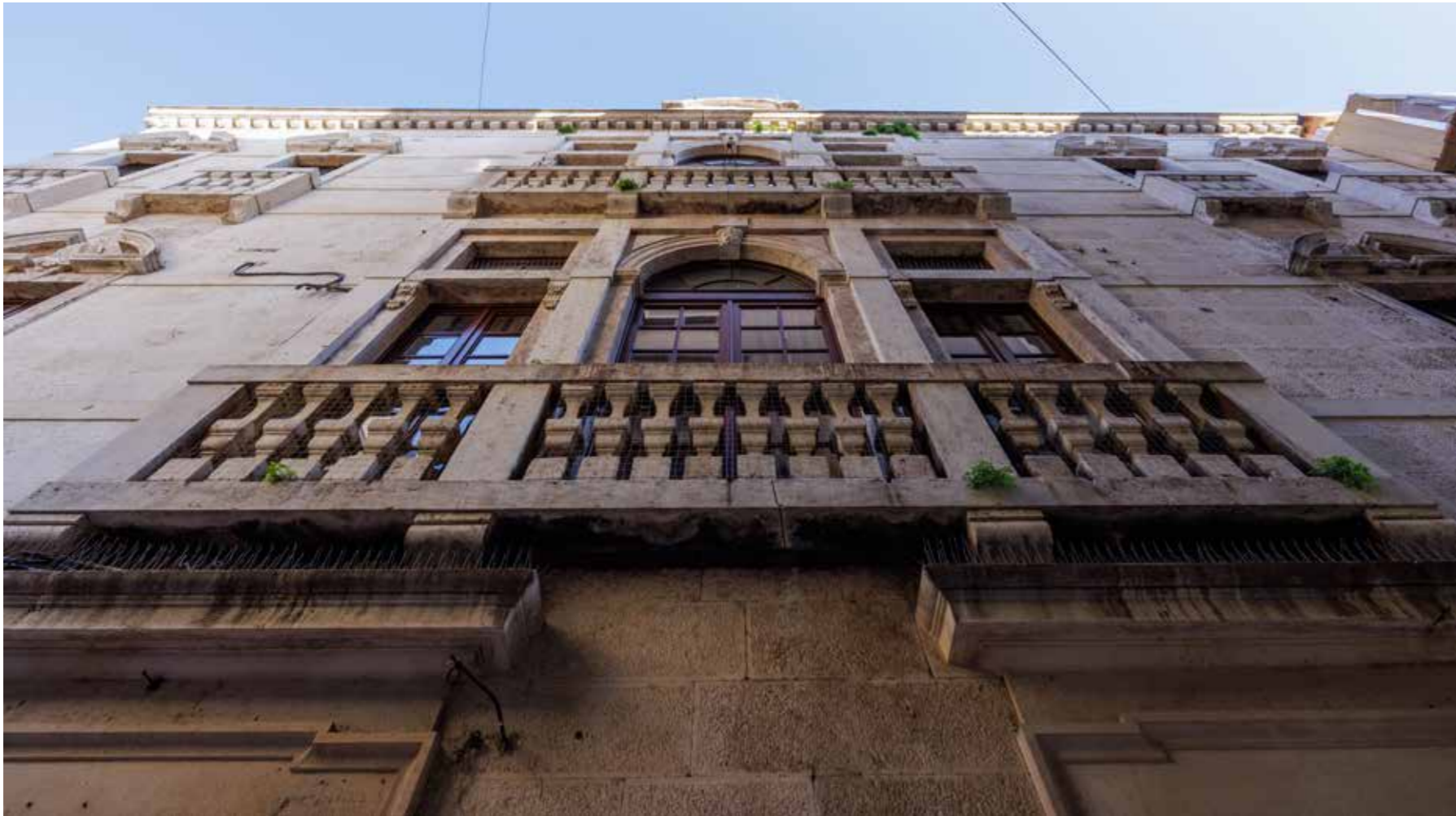
Split, palača Cindro, pročelje
