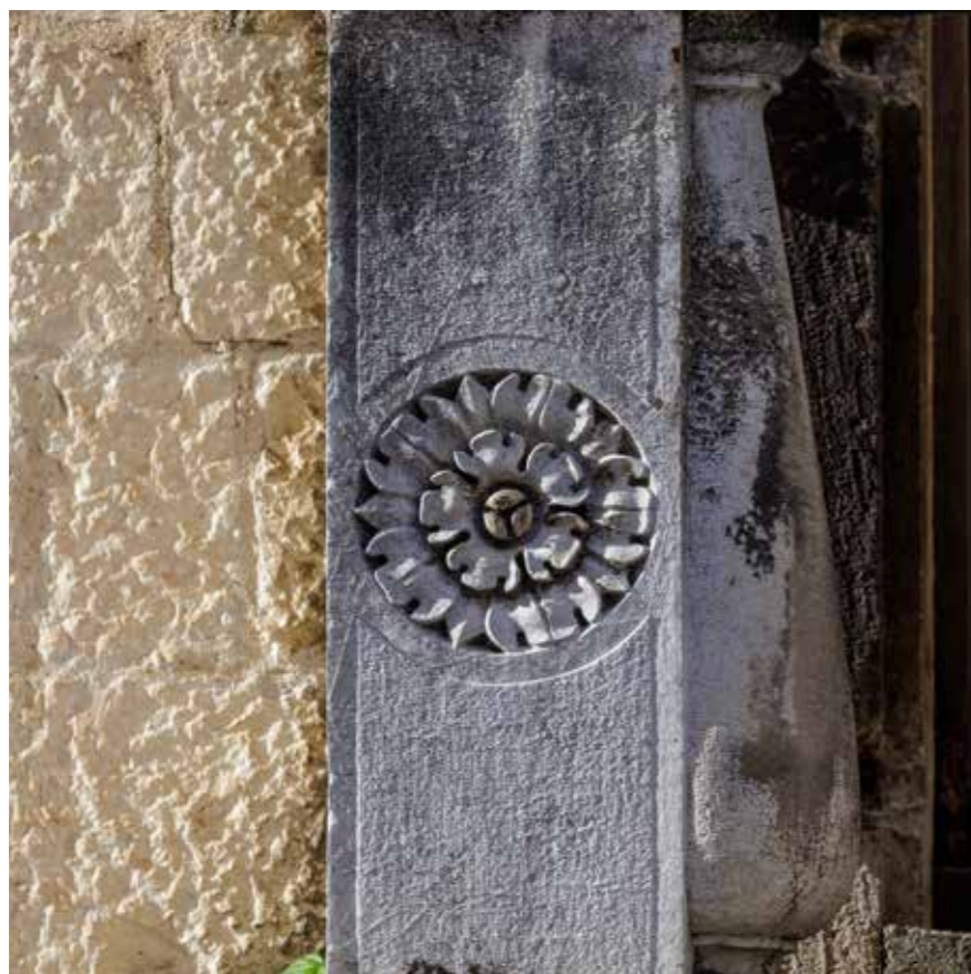
Balkon na prvom katu, detalj
