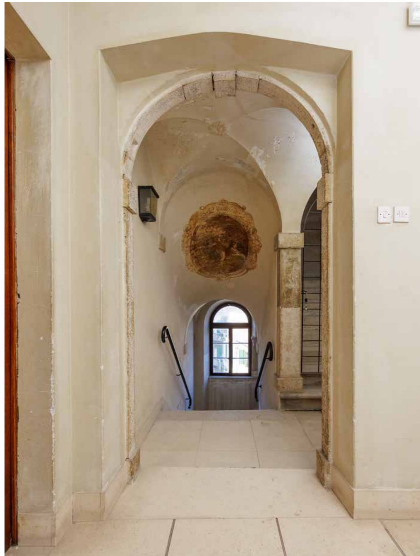
Pogled iz trećeg kata na stubište
