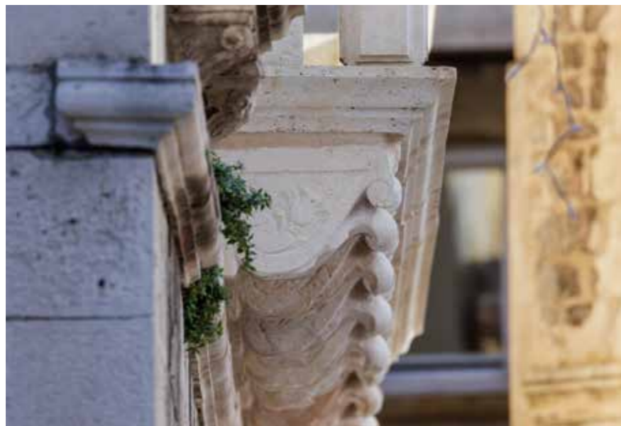
Konzole balkona na prvom katu
