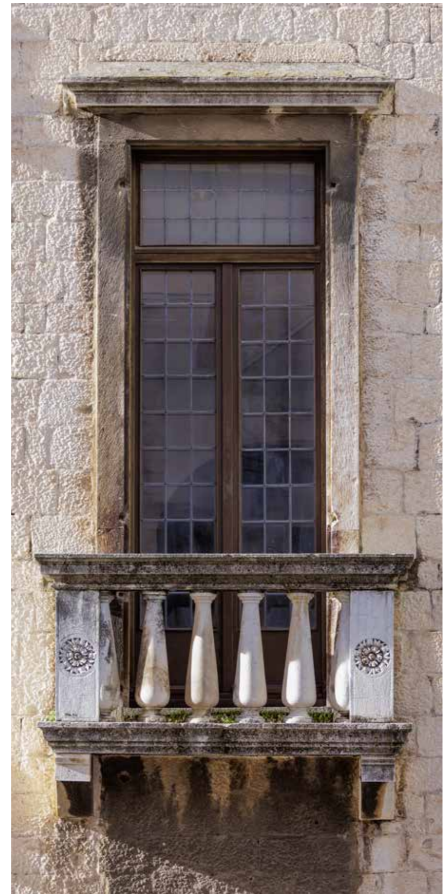
Istočno pročelje, balkon na prvom katu
