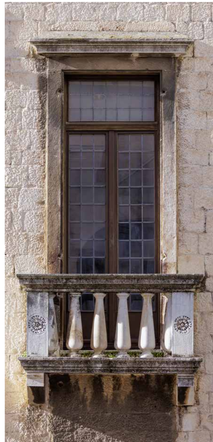
Istočno pročelje, balkon na prvom katu
