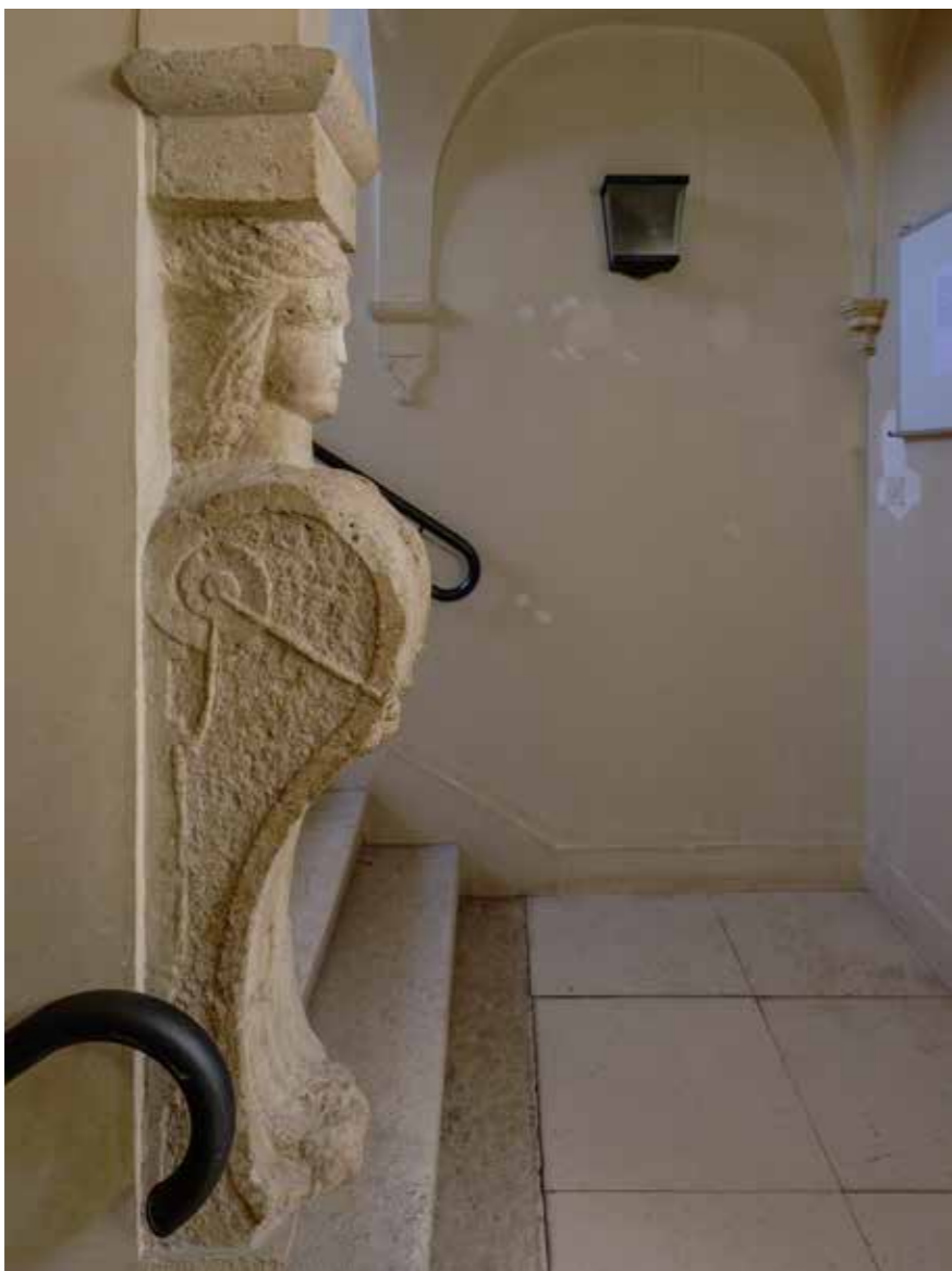
Herme u stubištu, detalji
