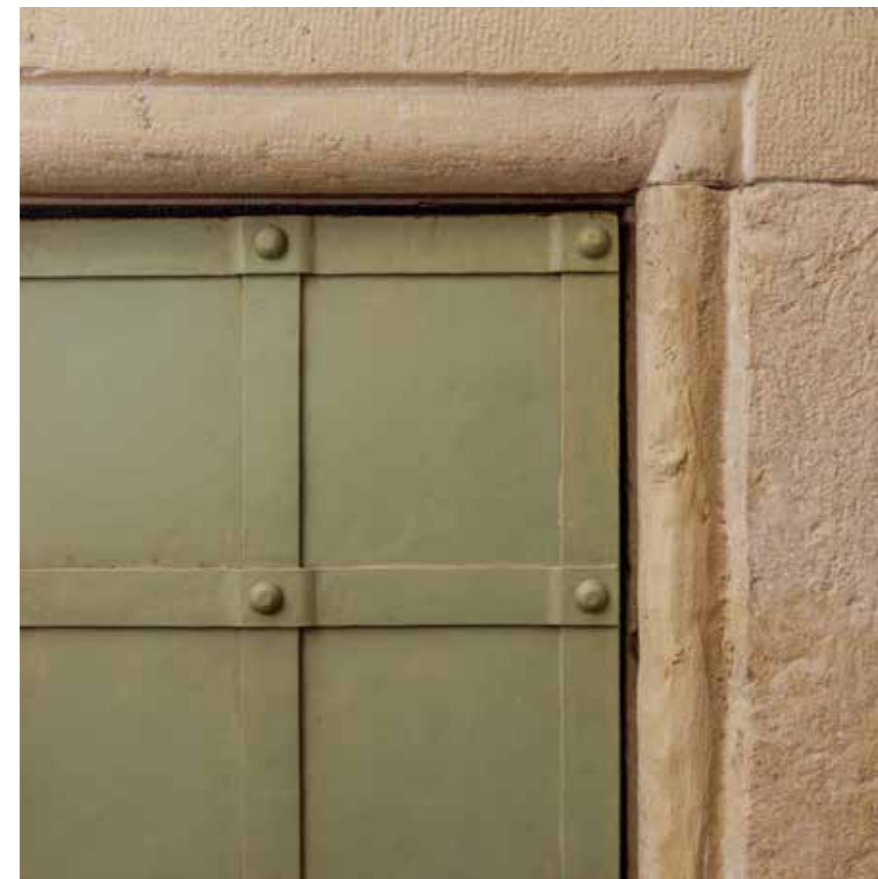
Portal spremišta ispod stuba, detalj
