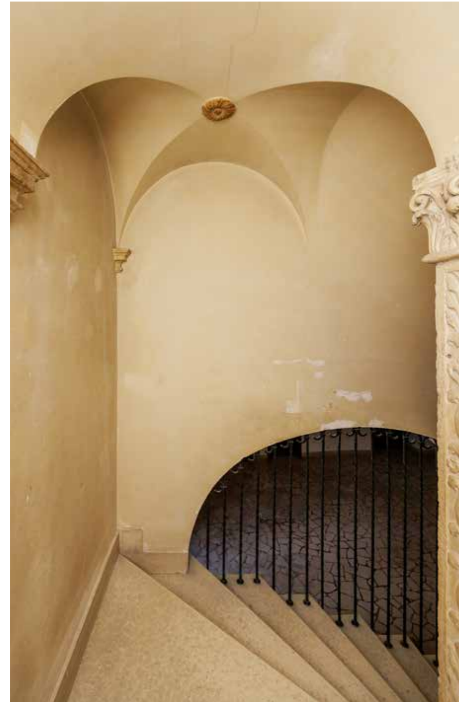
Podest između prizemlja i prvog kata
