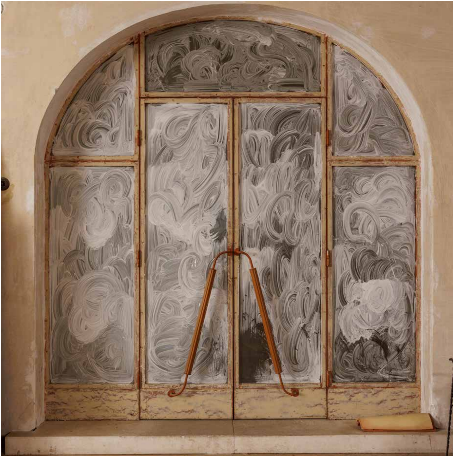
Vrata između dvorane i predsoblja na trećem katu
