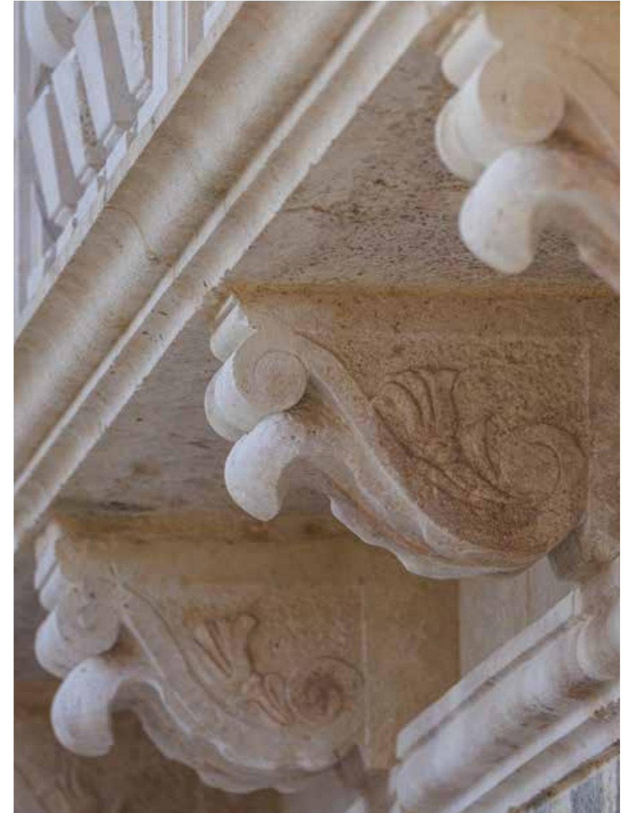
Konzole balkona na južnom pročelju nakon restauracije
