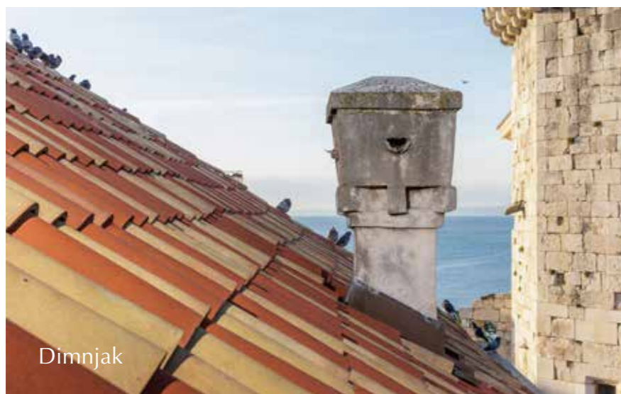
Krovište i terasa iznad nekadašnjeg atrija
