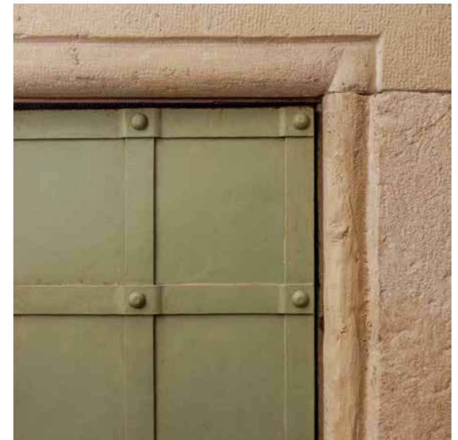
Portal spremišta ispod stuba, detalj
