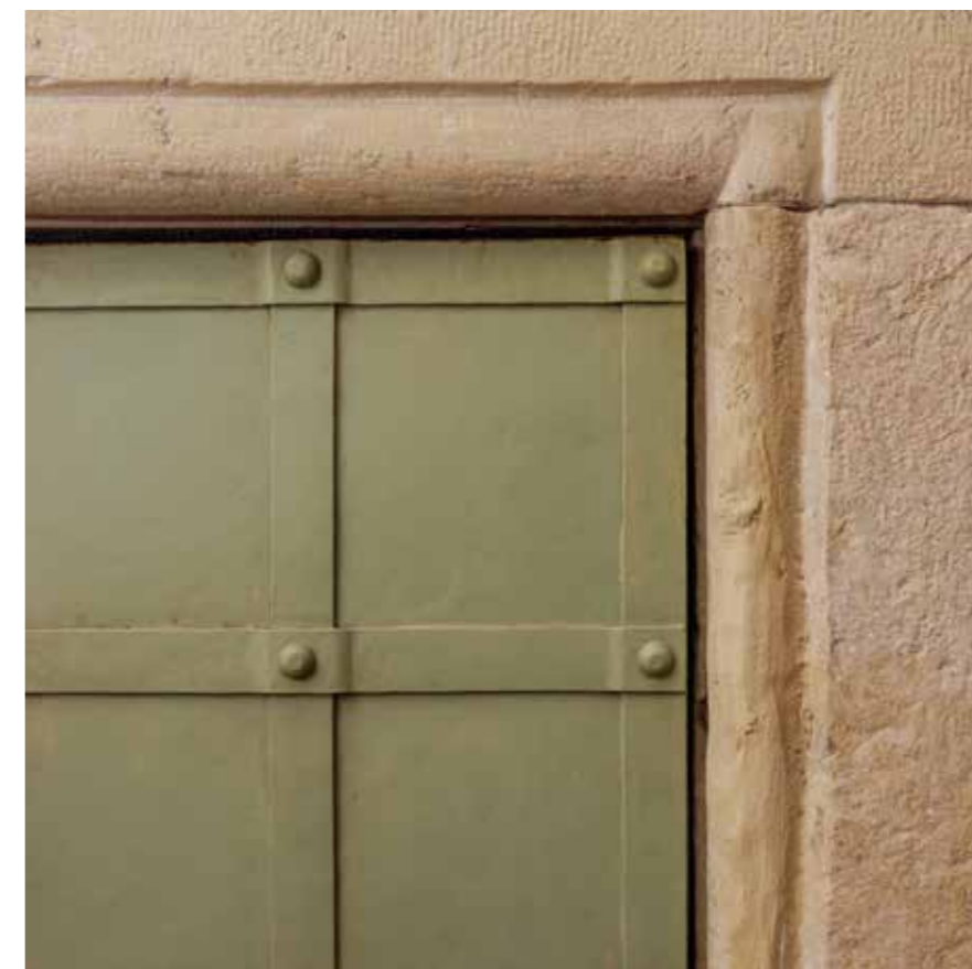
Portal spremišta ispod stuba, detalj
