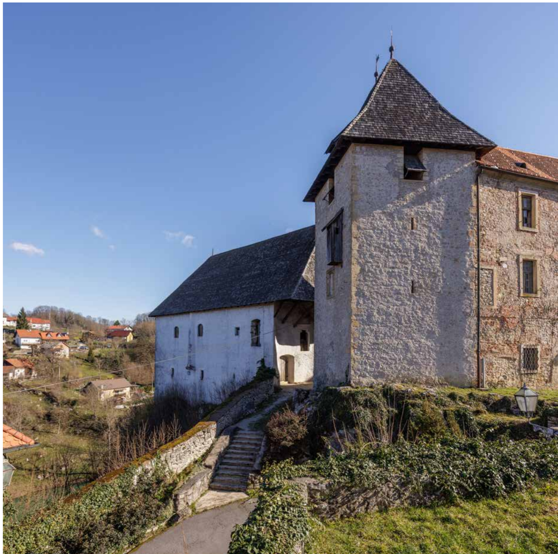
Pogled na južno i zapadno pročelje branič-kule
