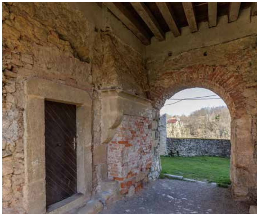
Zazidani gotički kamin u baroknom prolazu prema Žitnici Niša u istočnom zidu prolaza prema Žitnici
