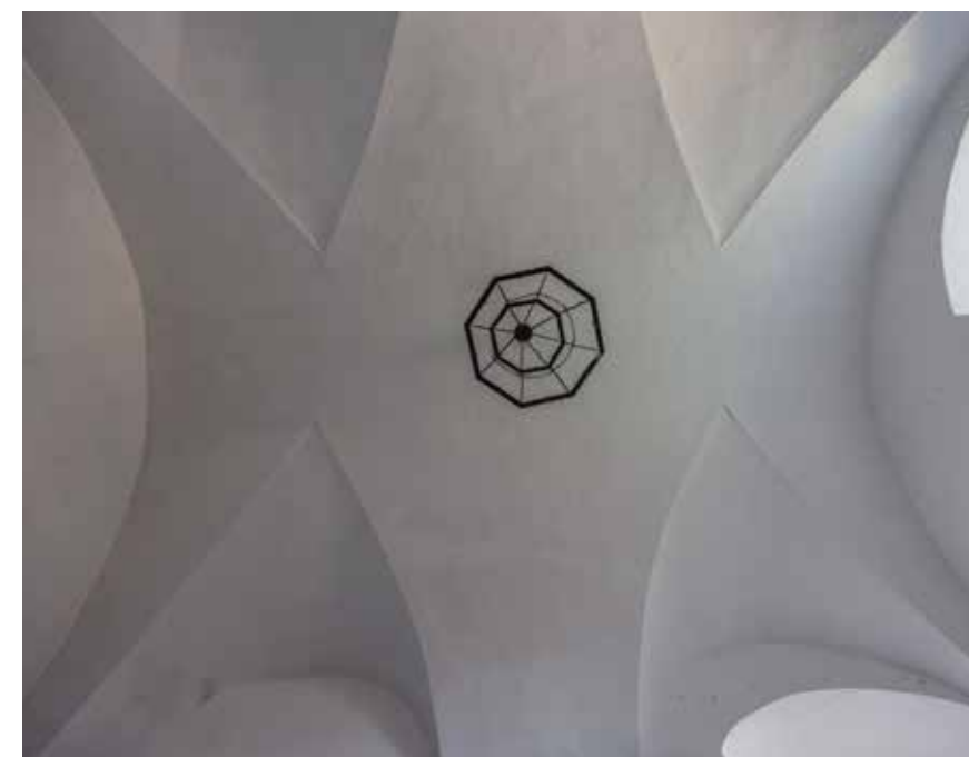
Prizemlje istočnog dijela sjevernog krila
