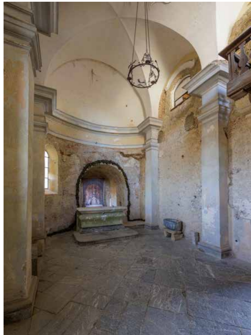
Pogled na južni zid
