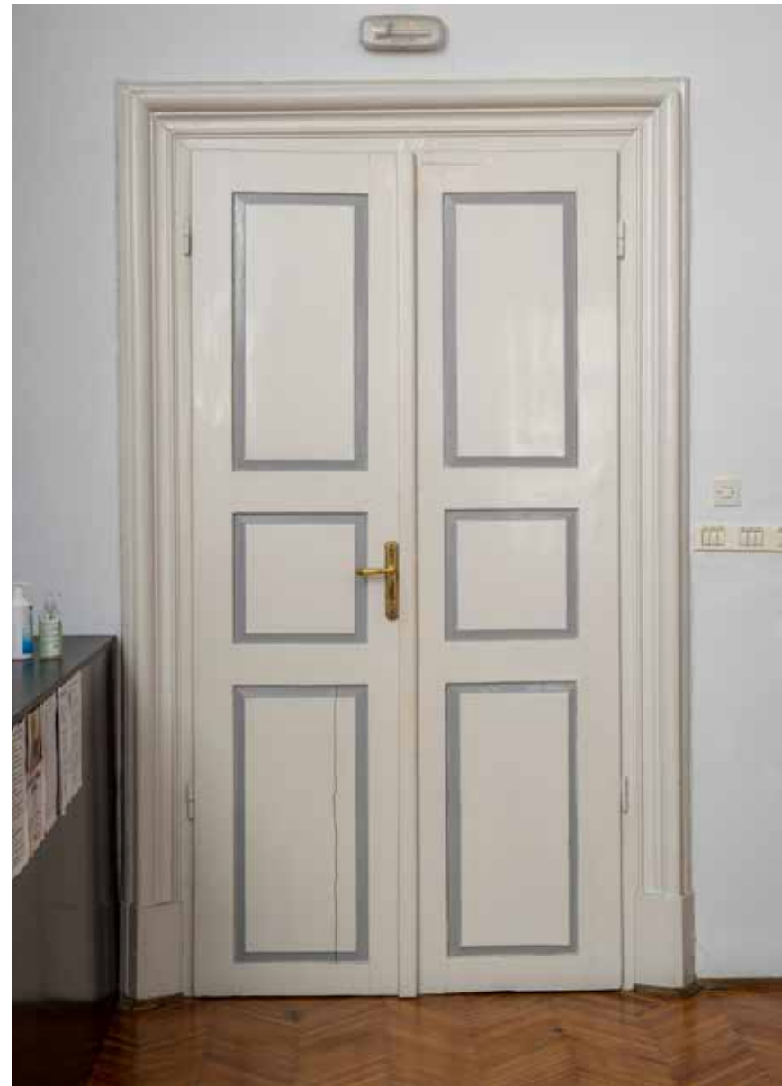
Drvene vratnice prvog kata
