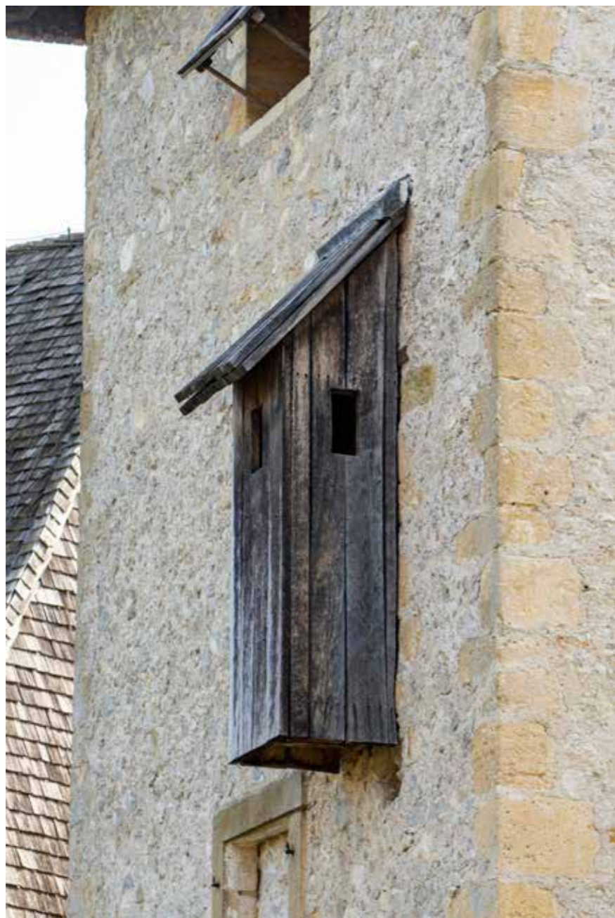
Zahod na zapadnom pročelju
