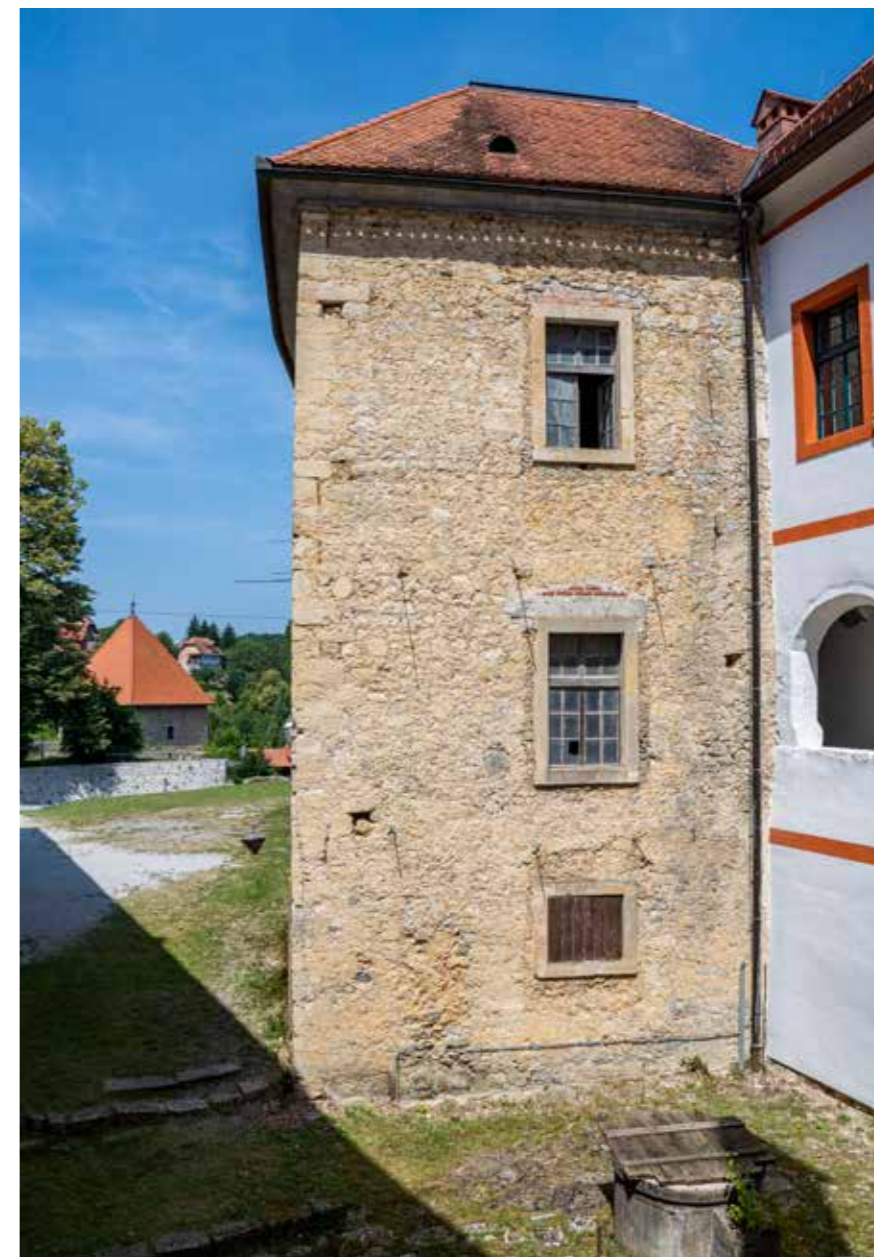
Istočno pročelje stubišta sjevernog krila
