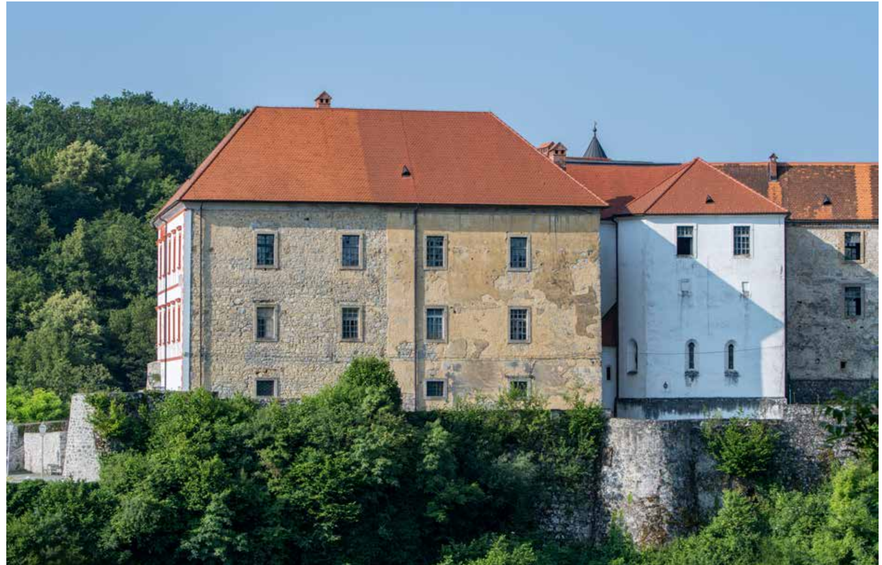
Sjeverno pročelje sjevernog krila
