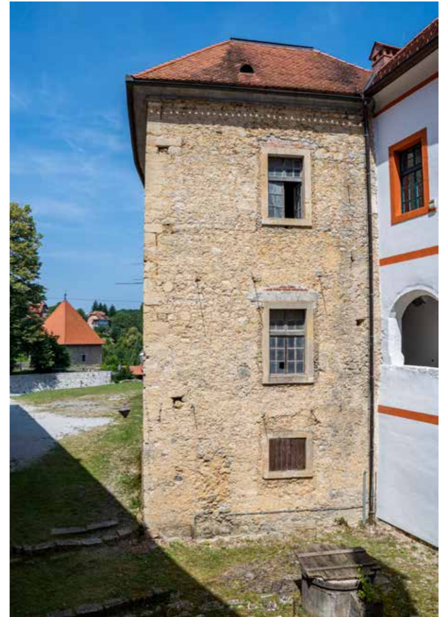
Istočno pročelje stubišta sjevernog krila
