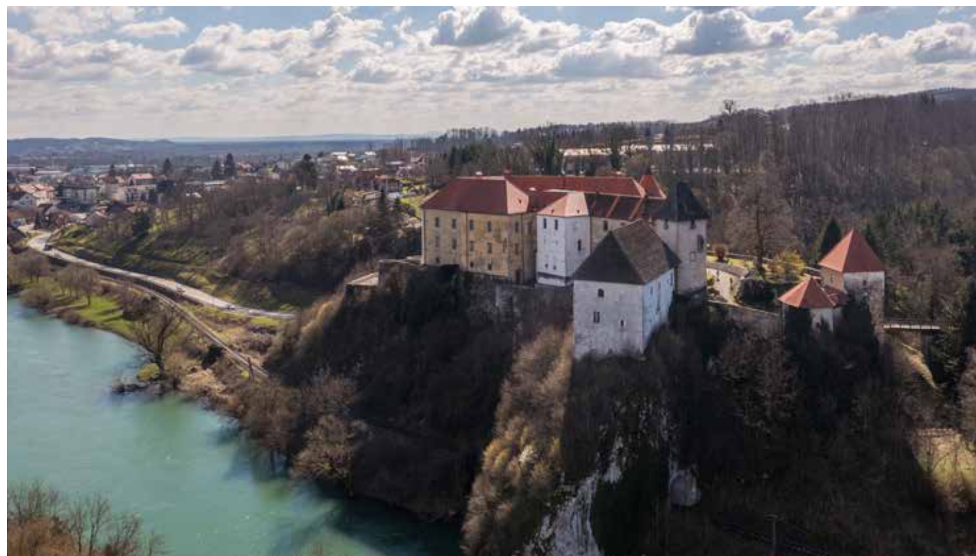
Pogled na Žitnicu sa sjeverozapada
