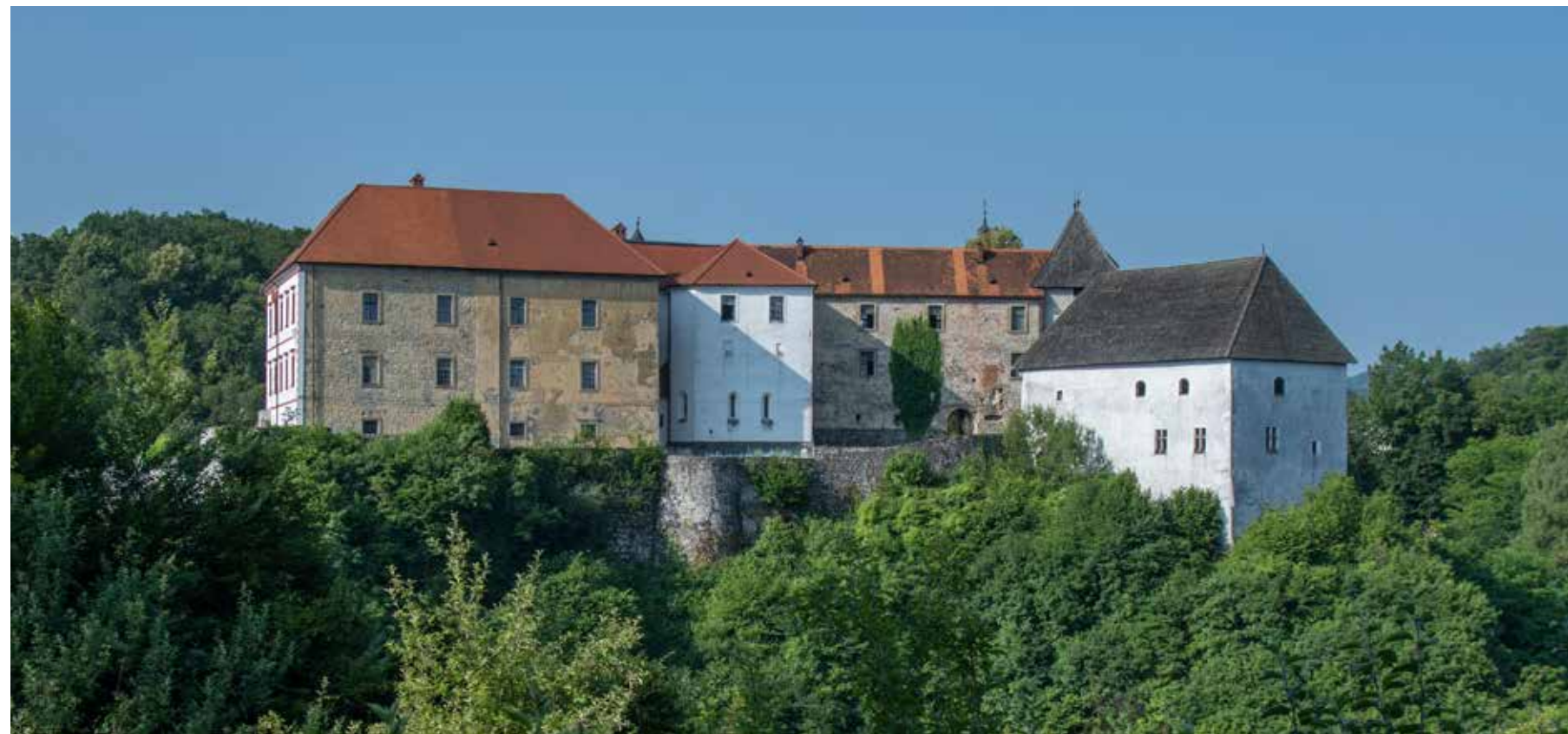
Pogled na kapelu sa sjevera
