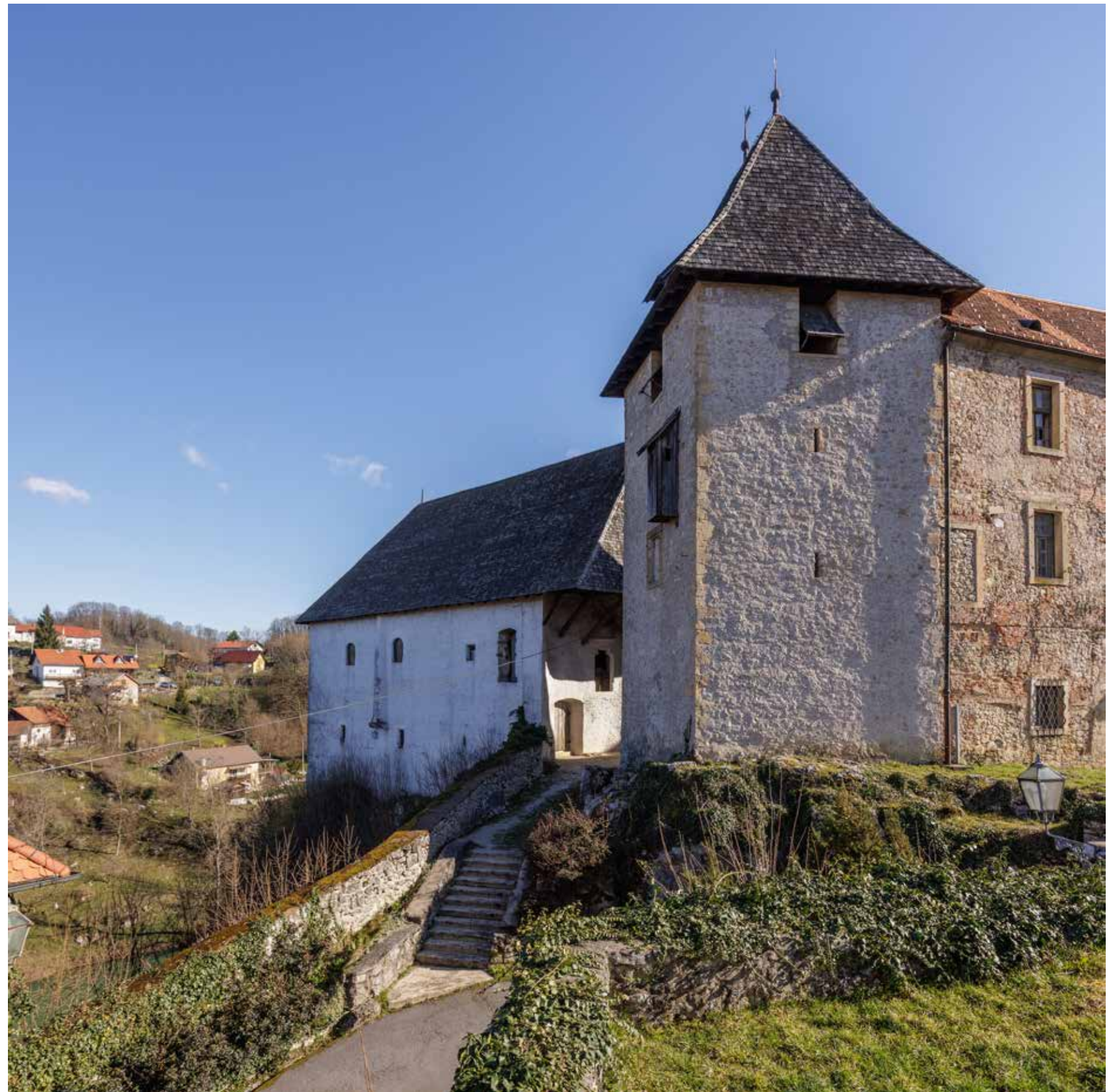
Pogled na južno i zapadno pročelje branič-kule
