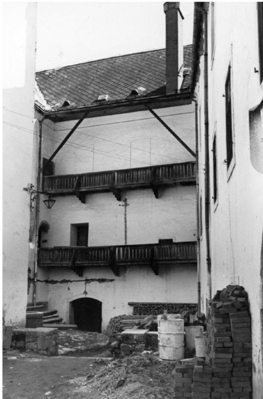
Istočno dvorište s ganjkom na prvom i drugom katu, naknadno uklonjenim (MKM)
