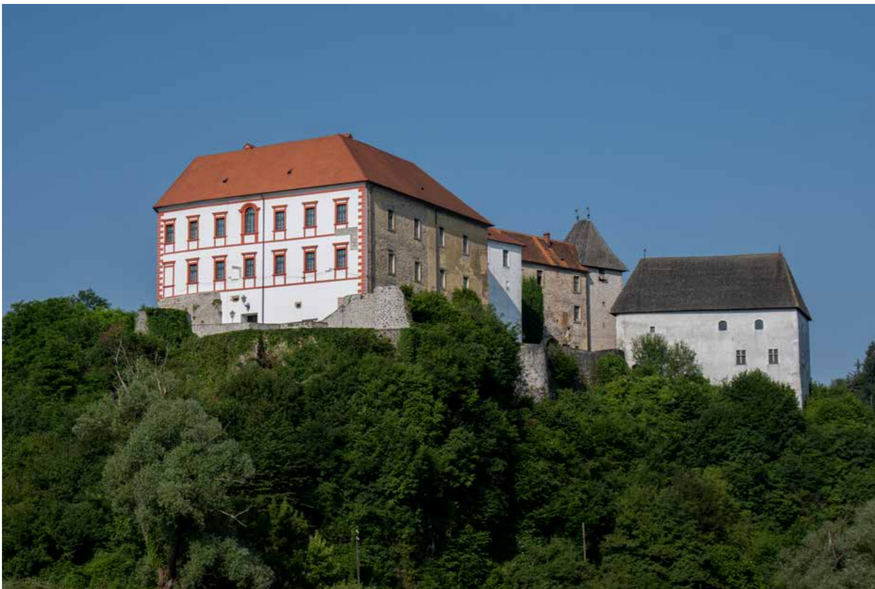
Pogled na istočno rezidencijalno krilo
