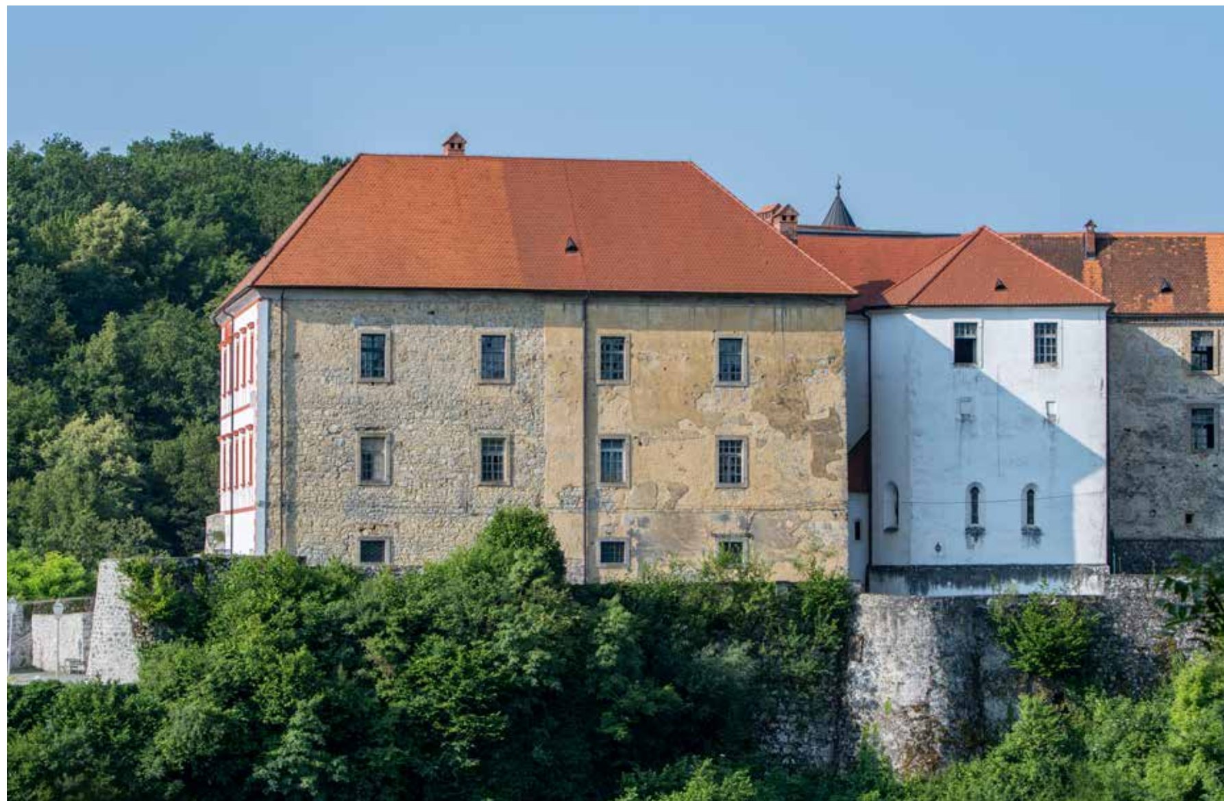
Sjeverno pročelje sjevernog krila
