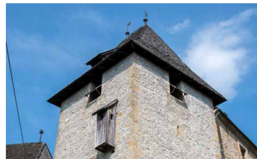
Pogled na sjeverno pročelje Dio zapadnog pročelja
