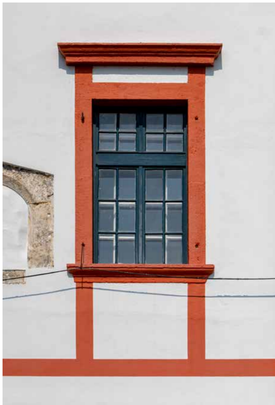
Prozor istočnog pročelja
