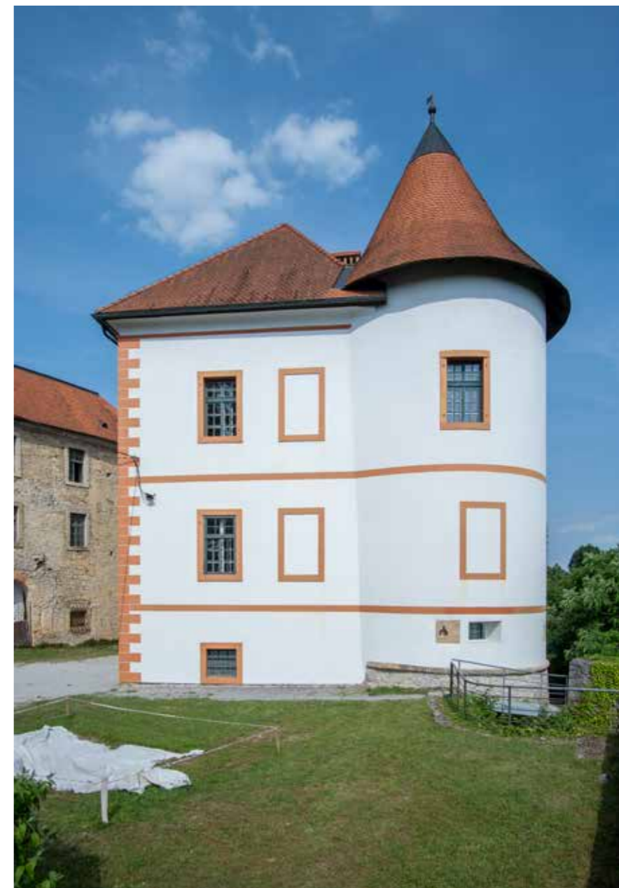
Zapadno pročelje južnog krila
