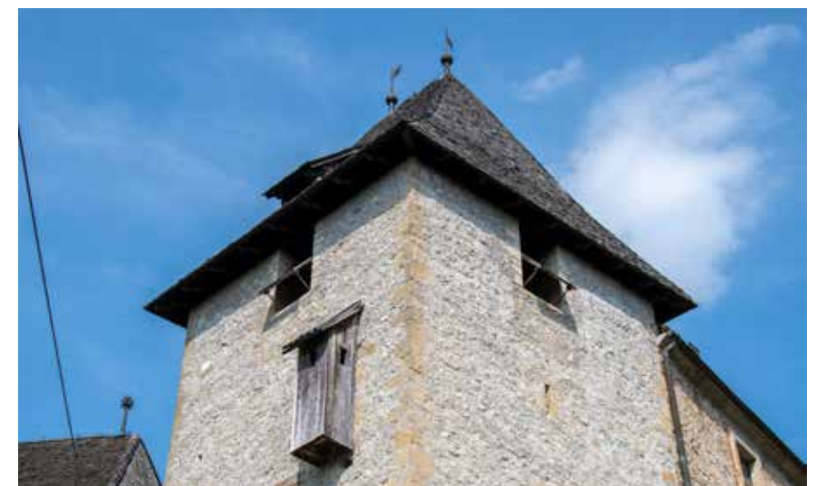
Pogled na sjeverno pročelje Dio zapadnog pročelja
