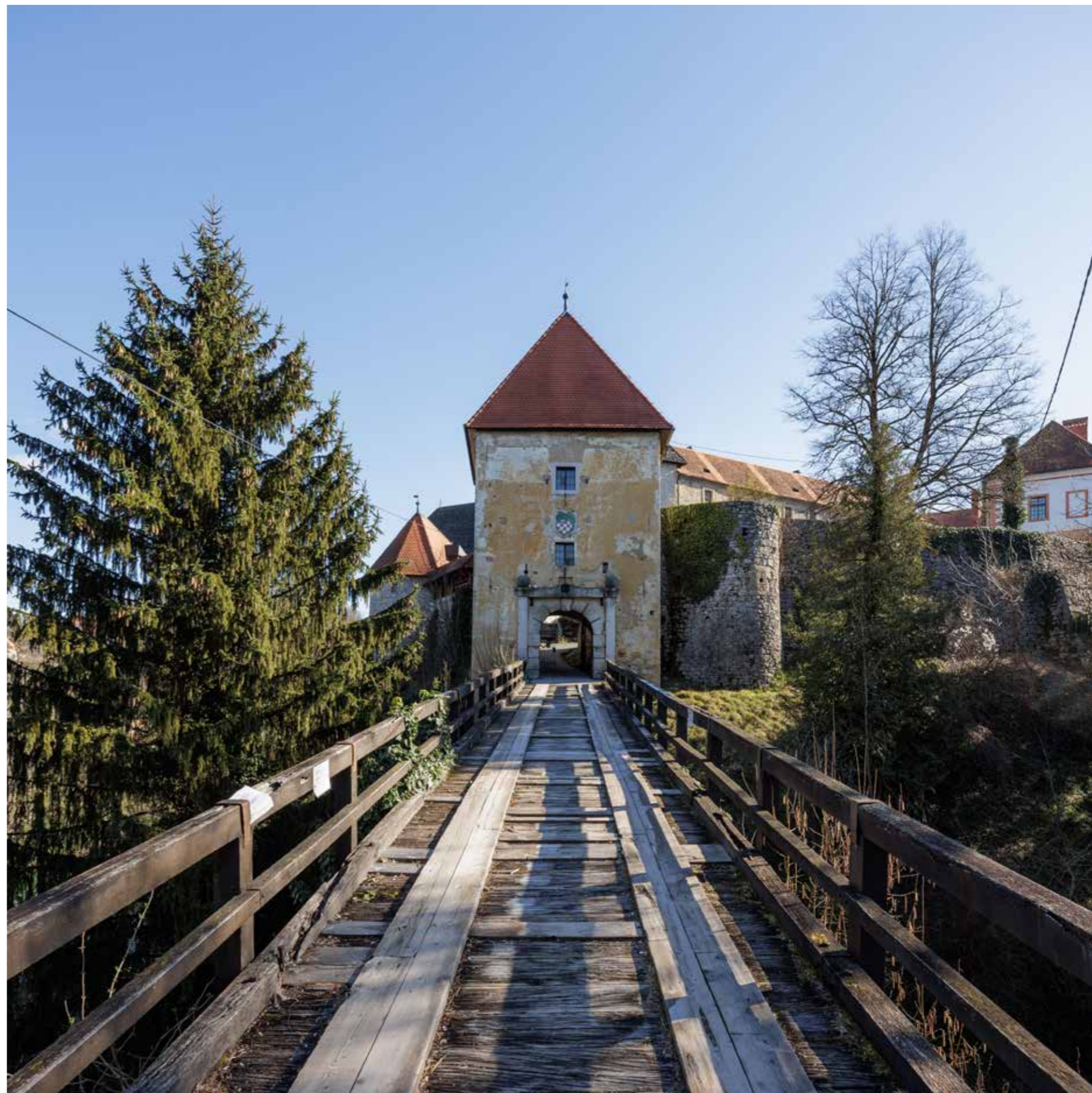
Pristupni, drveni most Staroga grada Ozlja
