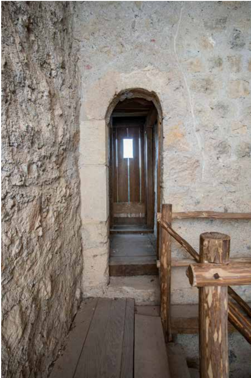
Otvor zahoda u zapadnom zidu
