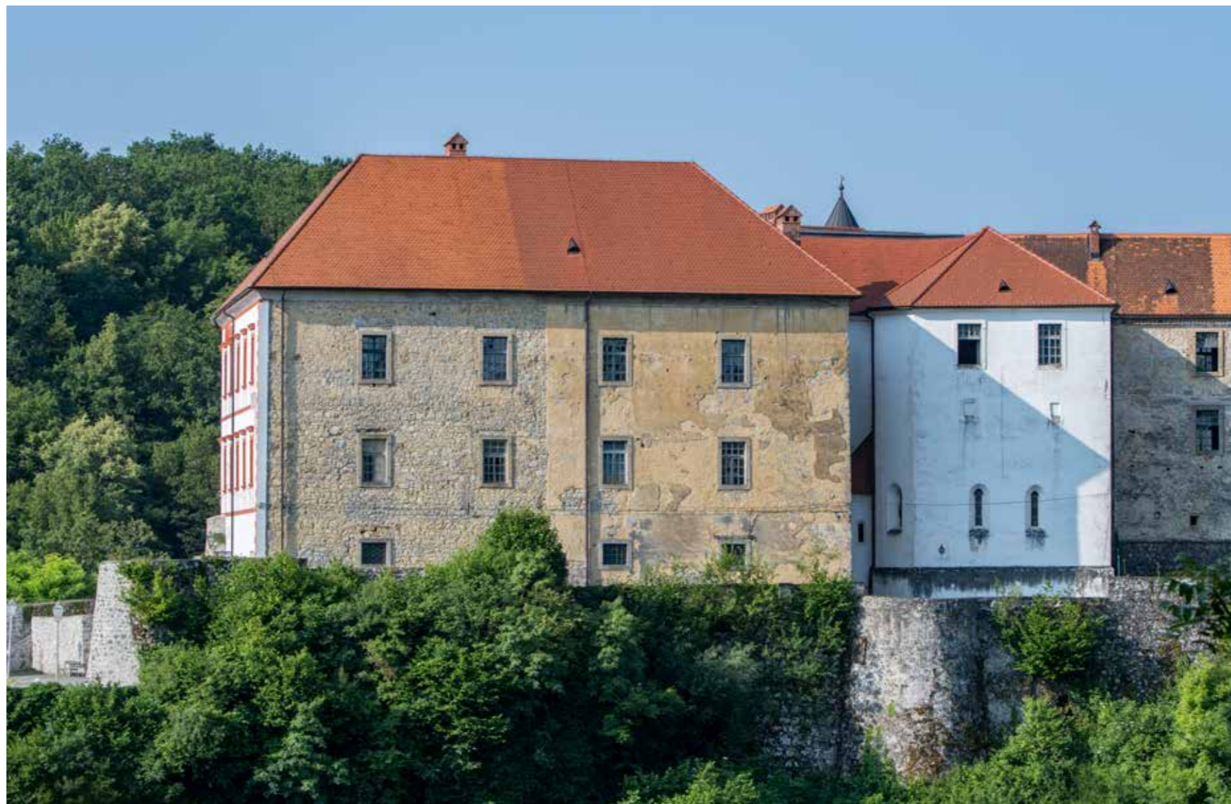
Sjeverno pročelje sjevernog krila
