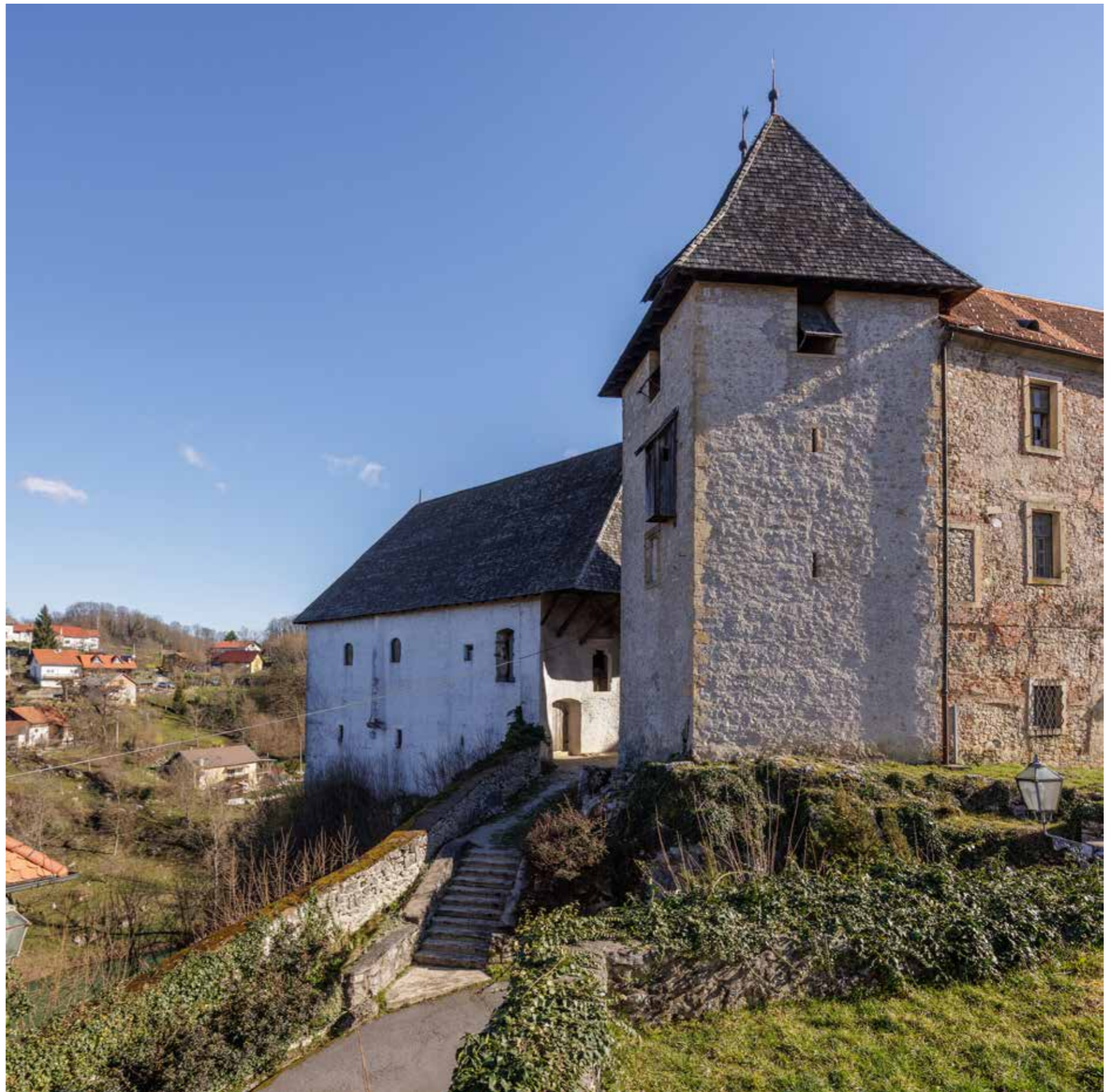
Pogled na južno i zapadno pročelje branič-kule
