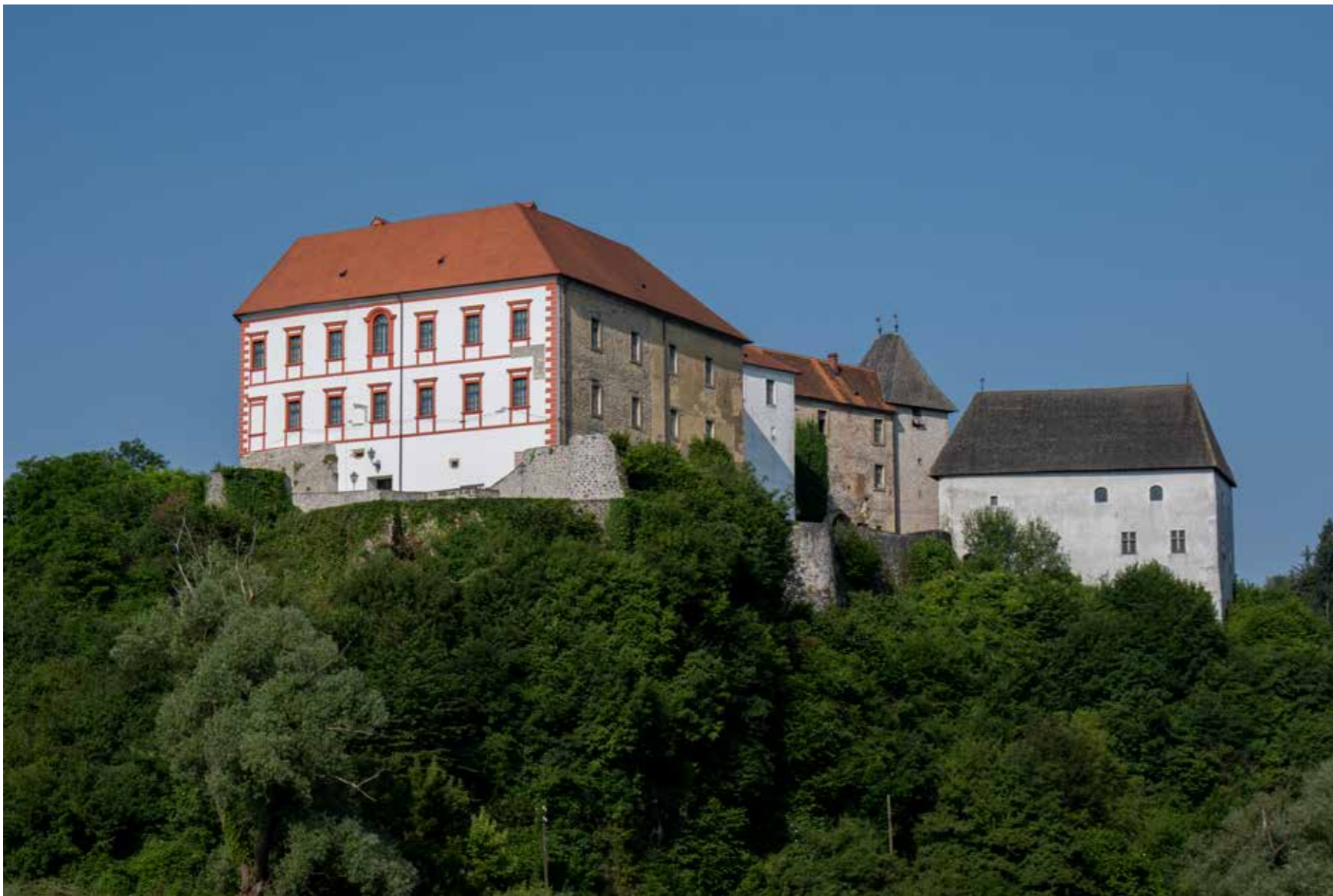
Pogled na istočno rezidencijalno krilo
