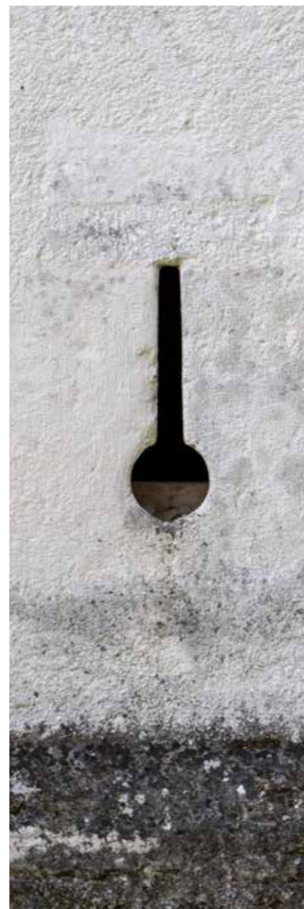
Puškarnica u obliku ključanice na zapadnom pročelju
