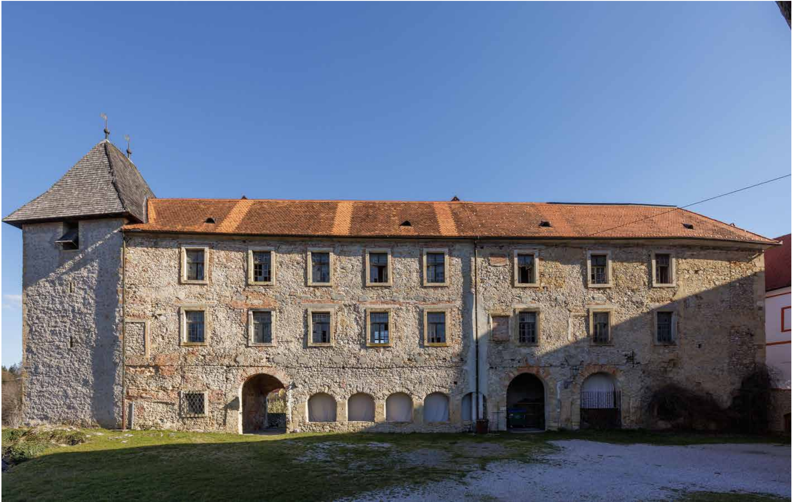
Južno pročelje sjevernog rezidencijalnog krila
