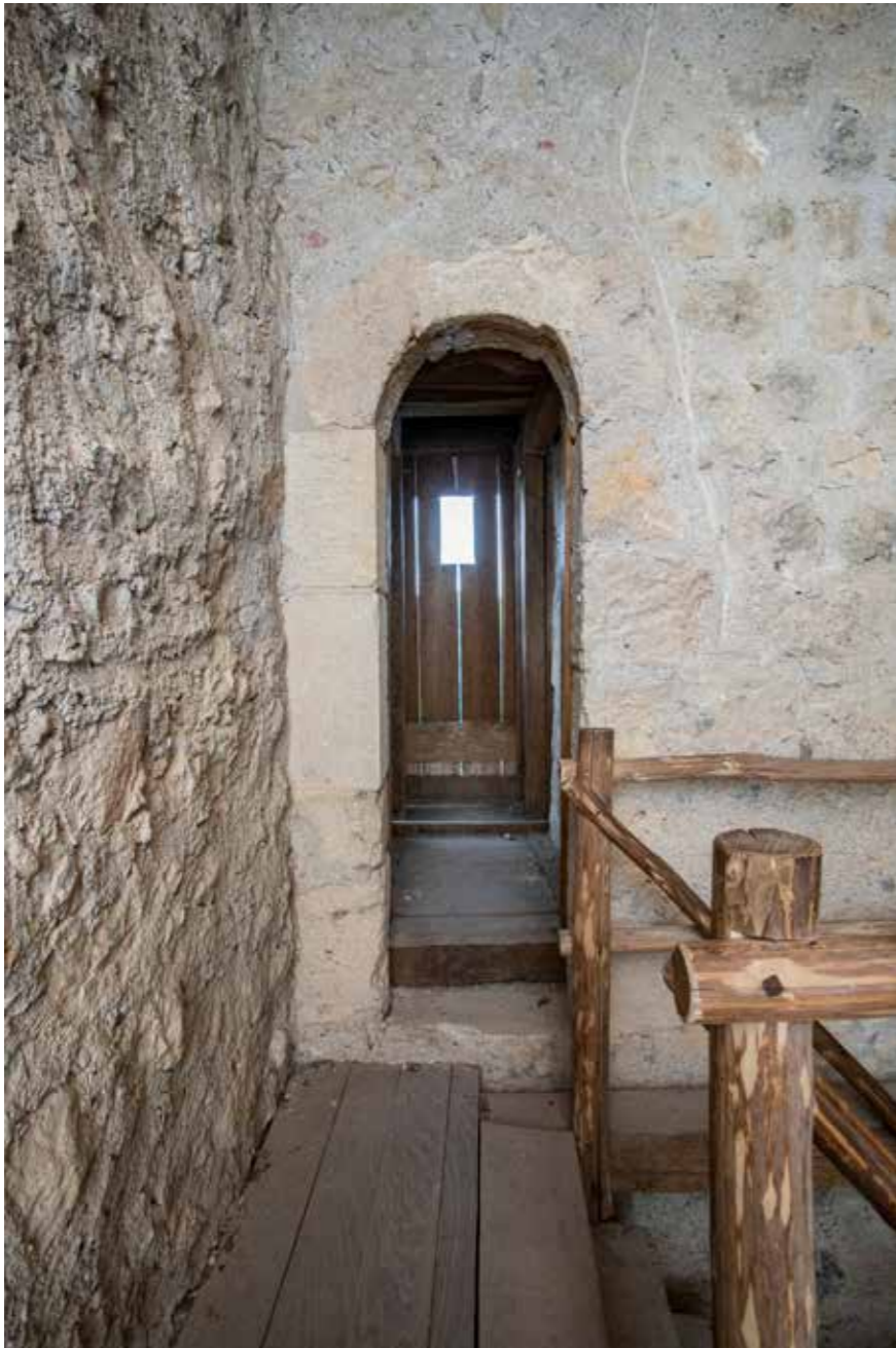
Otvor zahoda u zapadnom zidu
