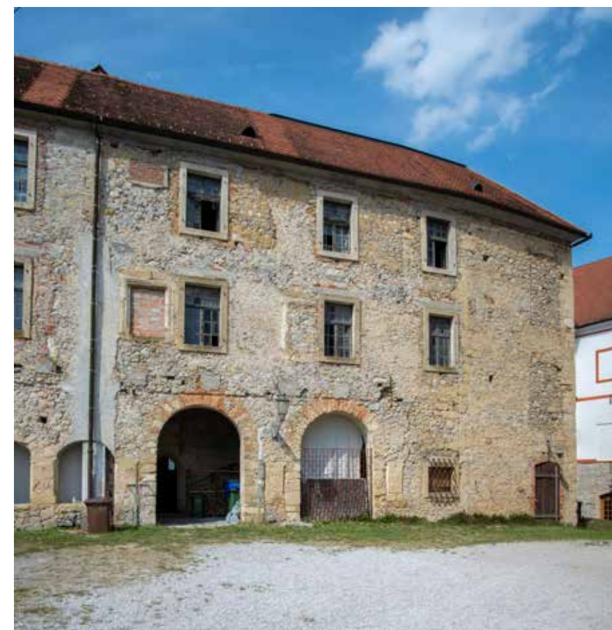
Južno pročelje sjevernog krila uz branič-kulu
