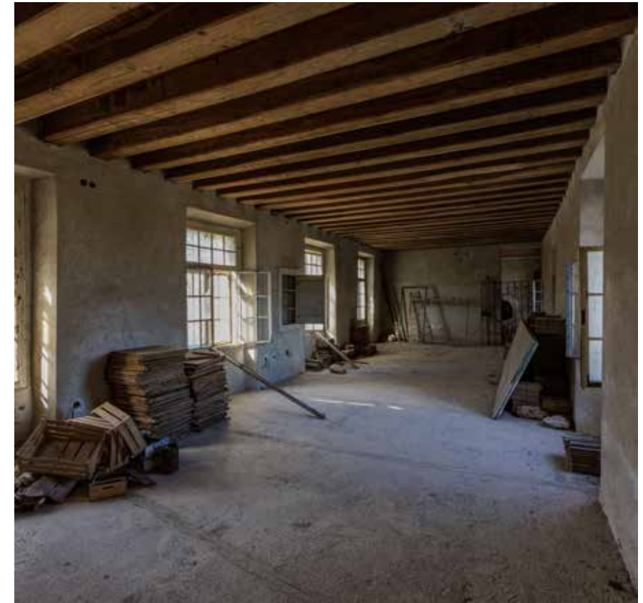
Prostorija prvog kata u zapadnom dijelu sjevernog krila
