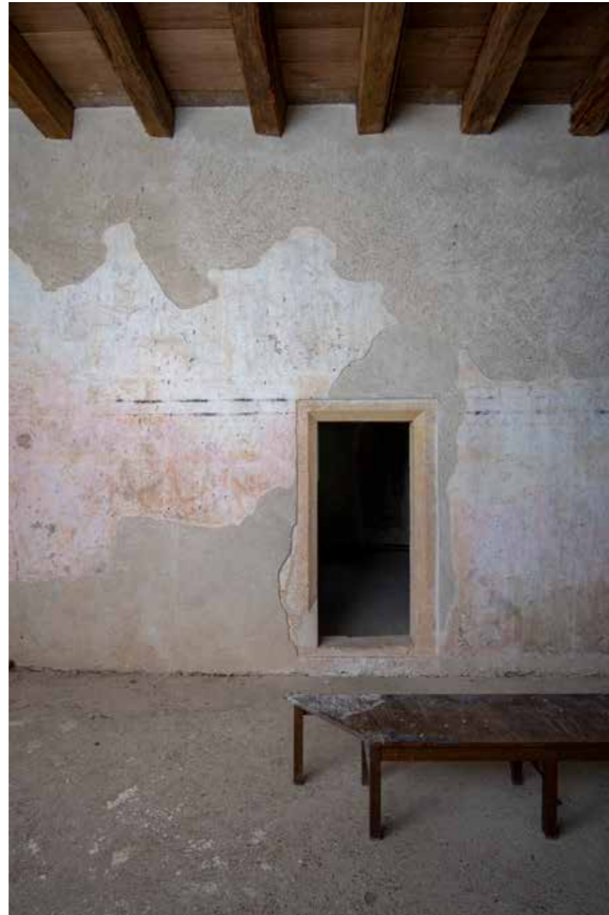
Razdjelni zid između prostorija prizemlja
