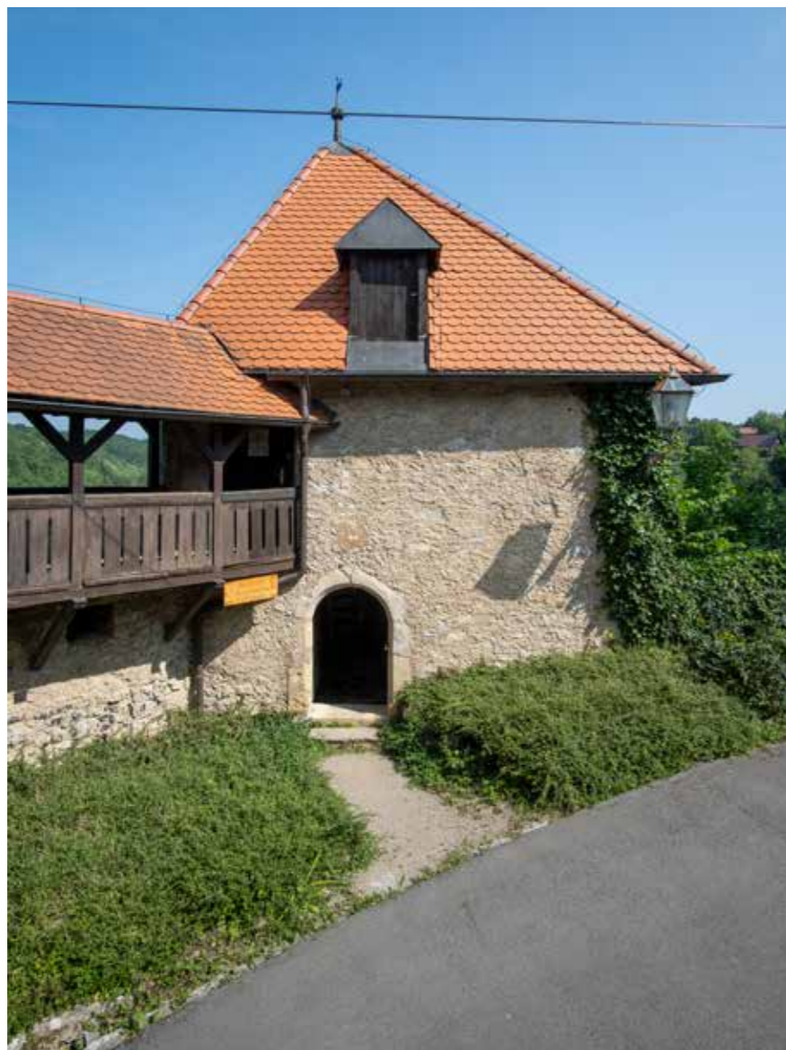
Južno pročelje oružarnice
