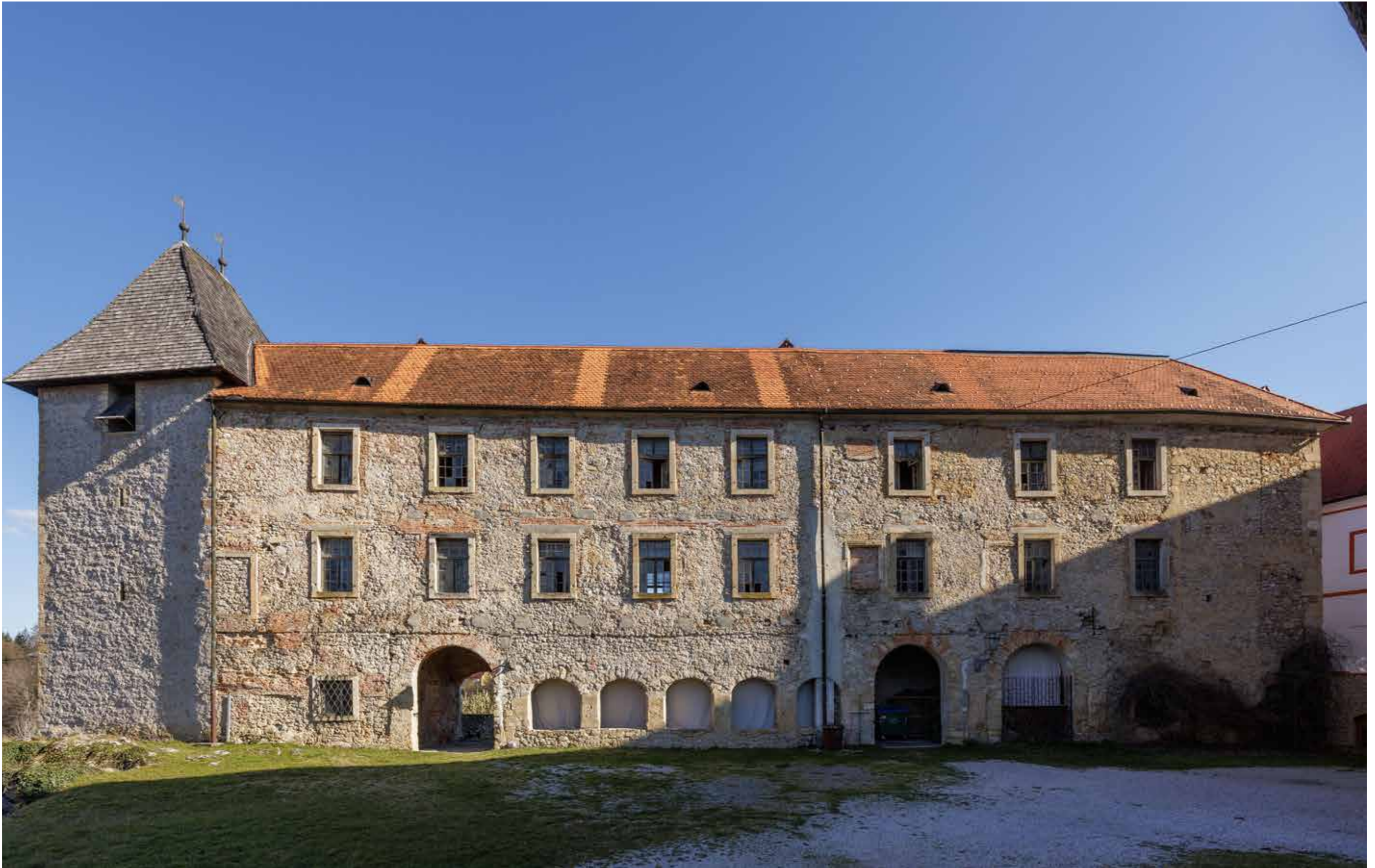
Južno pročelje sjevernog rezidencijalnog krila
