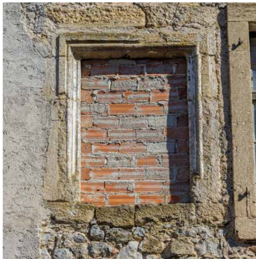
Okvir gotičkog prozora na prvom katu južnog pročelja
