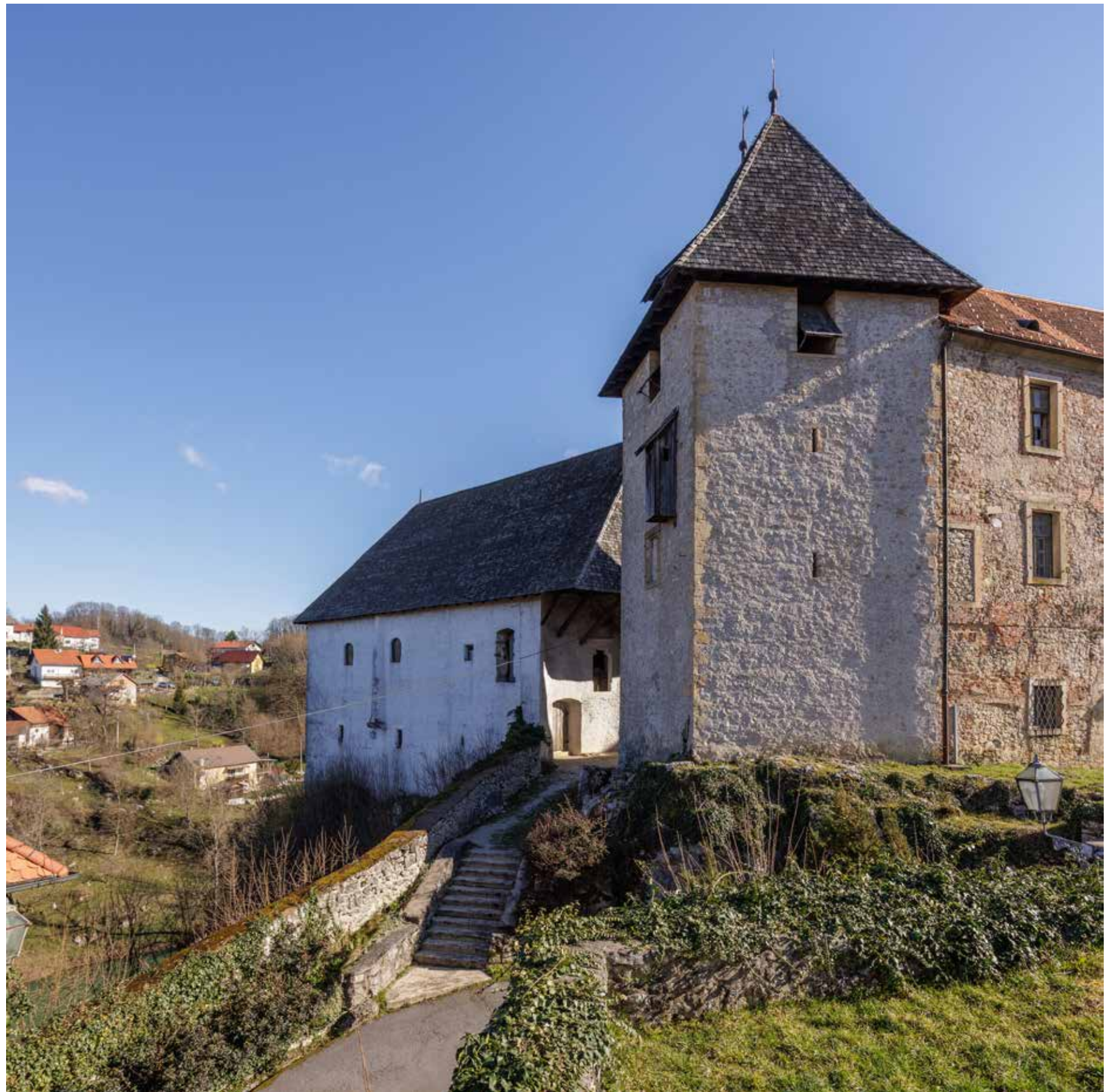
Pogled na južno i zapadno pročelje branič-kule
