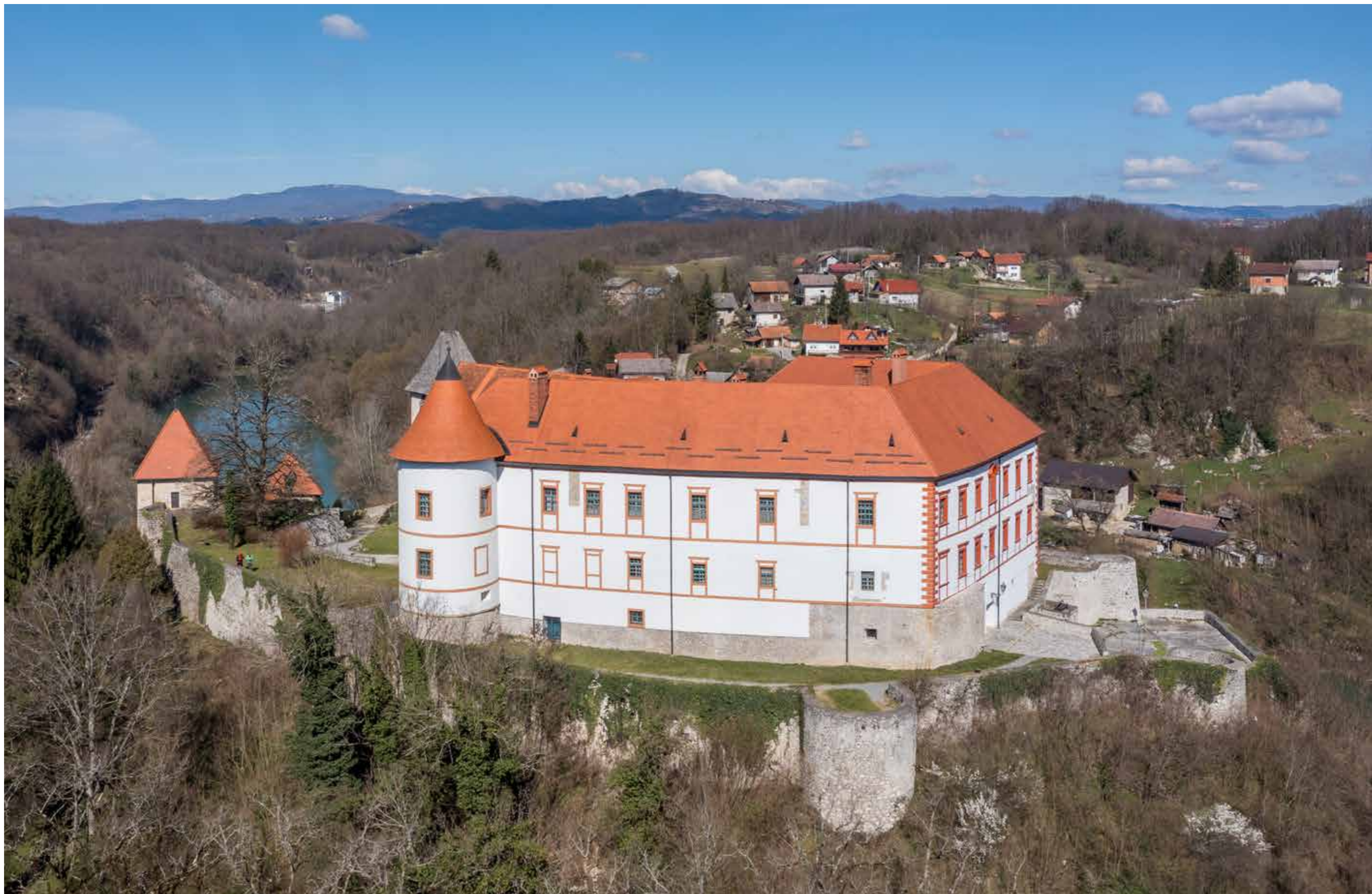
Pogled na Stari grad i okolni prostor sa zidinama
