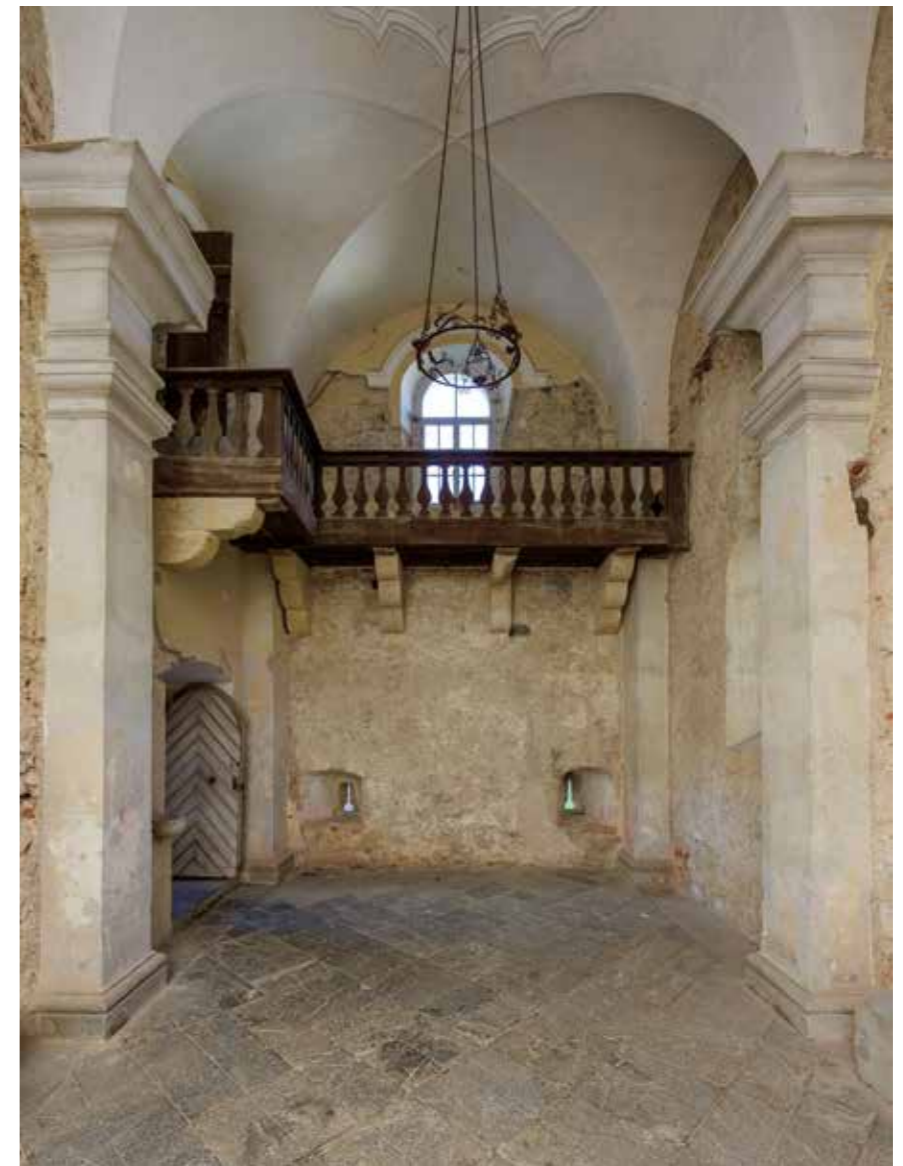
Pogled na zapadni zid
