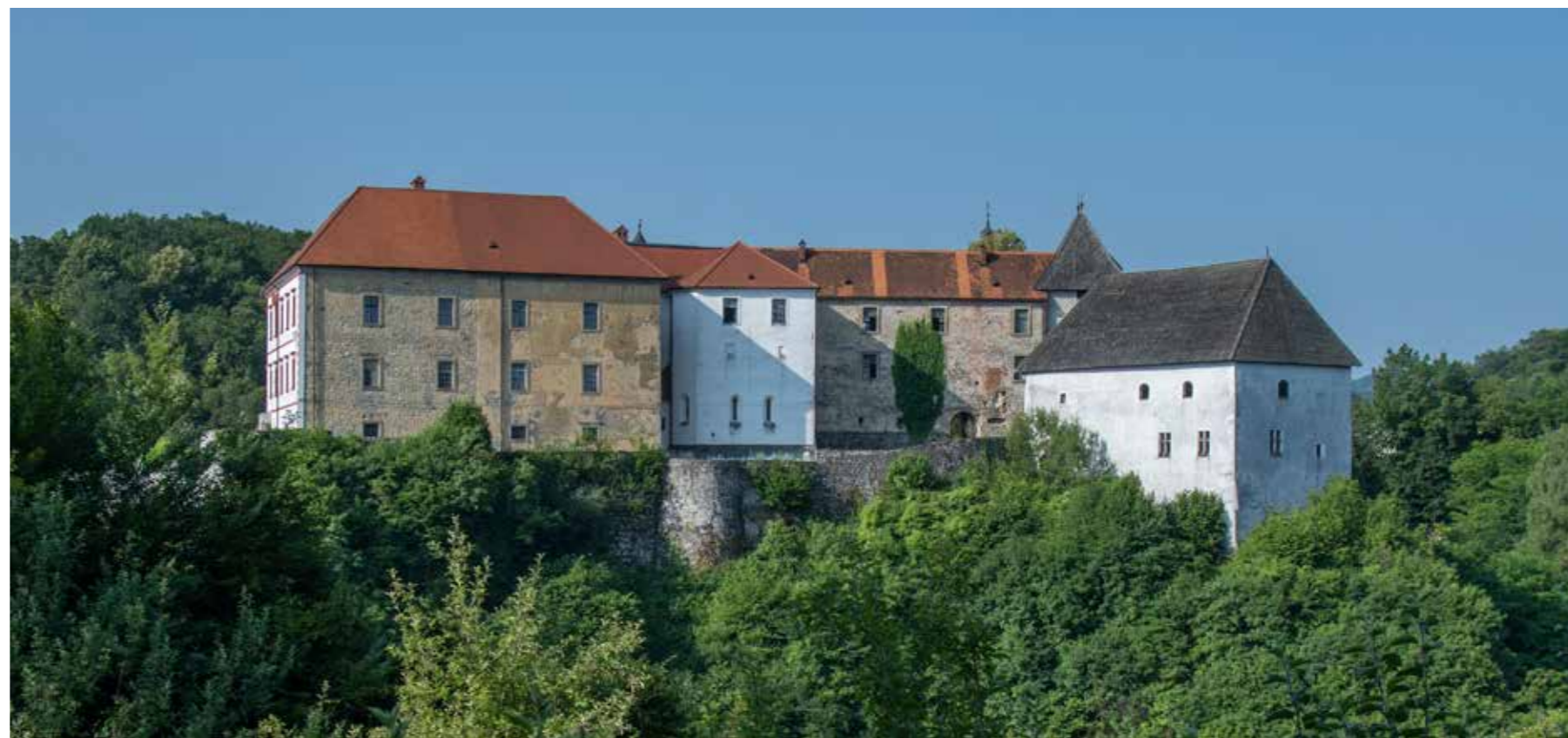
Pogled na kapelu sa sjevera
