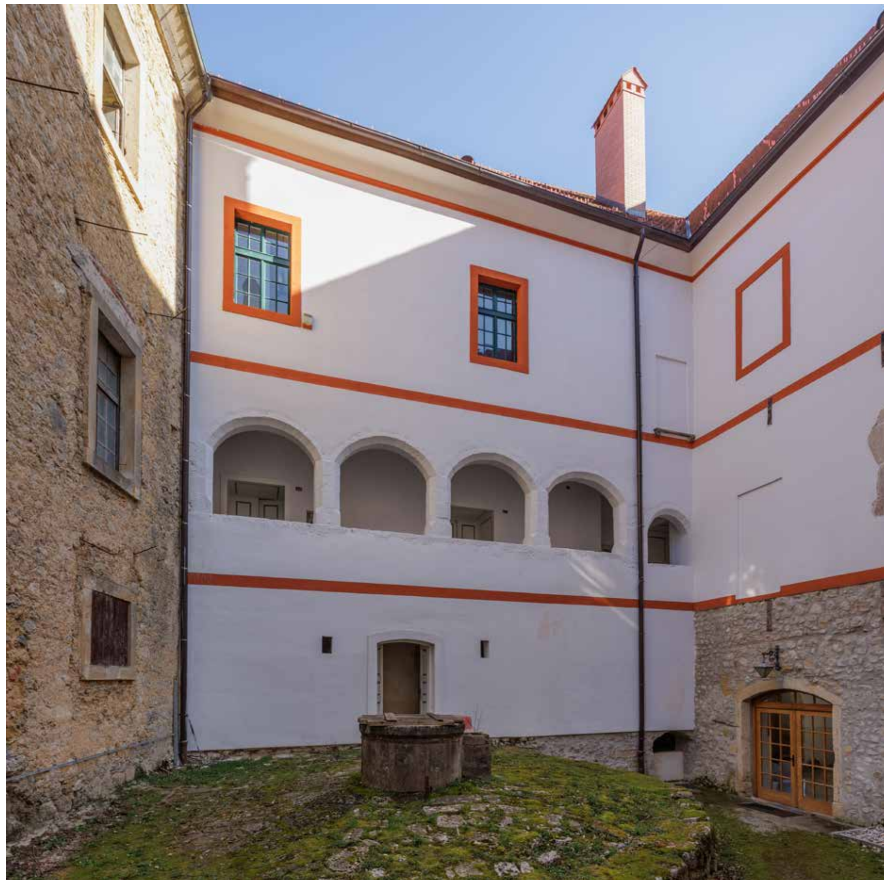
Istočni dio južnog pročelja sjevernog krila
