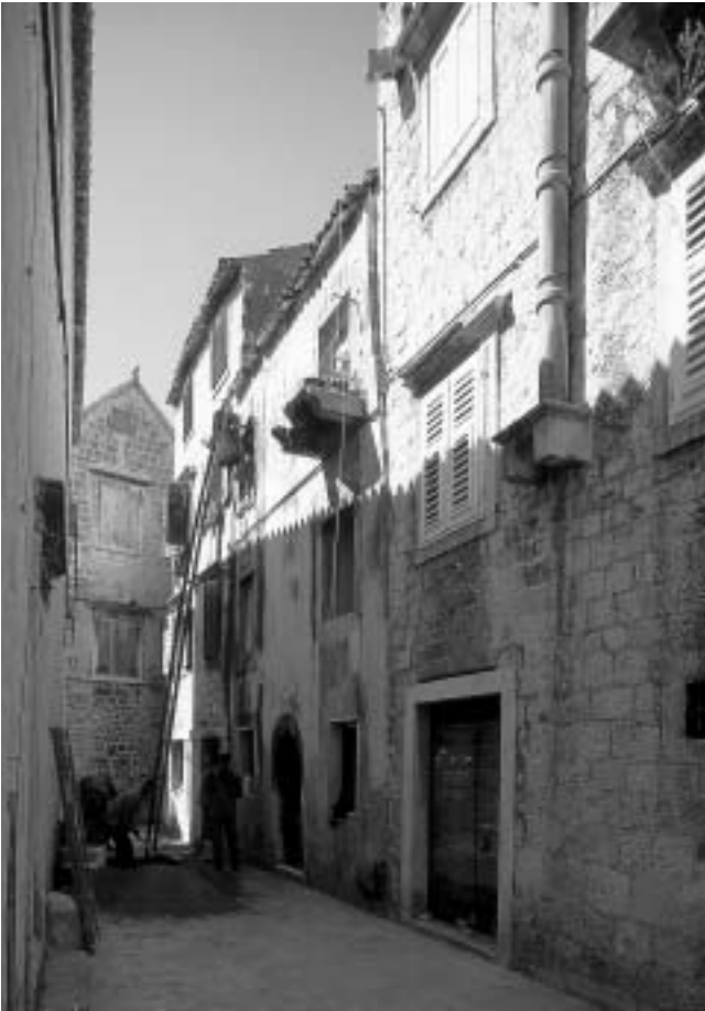
Romanička kuća prije i poslije obnove.
