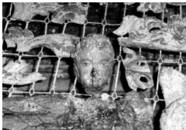
Kamensko, Pavlinski samostan — detalji oštećenih oltara. Crkva demolirana, srušeni svodovi i toranj za okupacije. Obnavlja Hrvatski restauratorski zavod. (Foto: Konzervatorski odjel Karlovac, 1996.)
