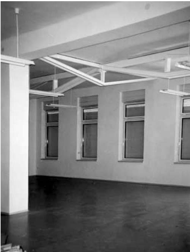
11. Državni arhiv Rijeka, Vodovodna ulica 2, Rijeka, ojačana konstrukcija stropova
