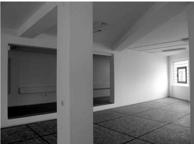
12. Državni arhiv Rijeka, Vodovodna ulica 2, Rijeka, aluminijska prozorska bravarija, sačuvani podni taraco
