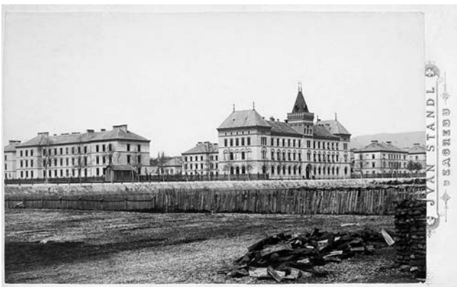
9. Pješaka vojarna, neposredno poslije izgradnje, foto: Ivan Standl
