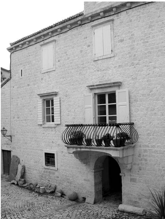
5. Južno pročelje obnovljenog dijela palače Garagnin-Fanfogna.
