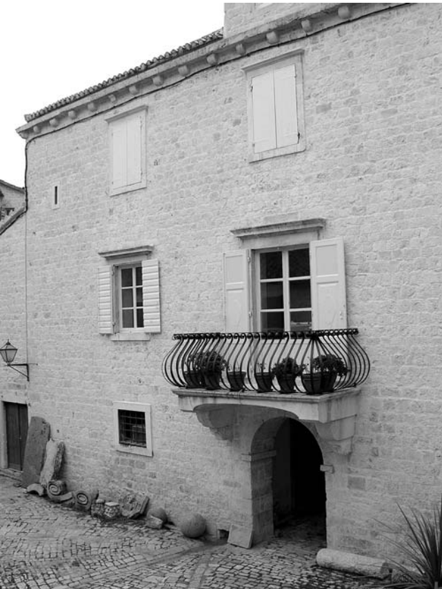
5. Južno pročelje obnovljenog dijela palače Garagnin-Fanfogna.
