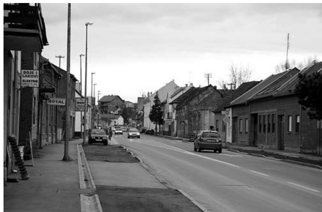
6. Vukovar, Radićeva ul., individualne stambene kuće u povijesnoj jezgri grada: obnova uličnih poteza minornom »novom arhitekturom« bez kreativne vrijednosti (foto: Đ. Šimičić, HRZ, 2007.)
