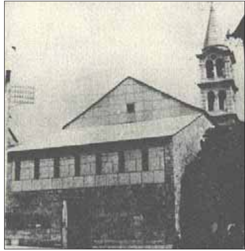
Sanacija porušenog pročelja 1945.
