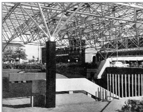
Konstrukcija nad sjevernim ulazom
