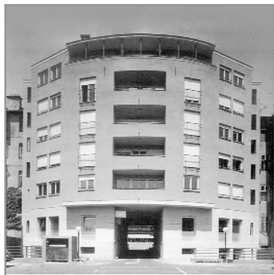
Ilica 147, stambena zgrada (Boris Duplančić, 1988.-1993.), dvorišno pročelje
