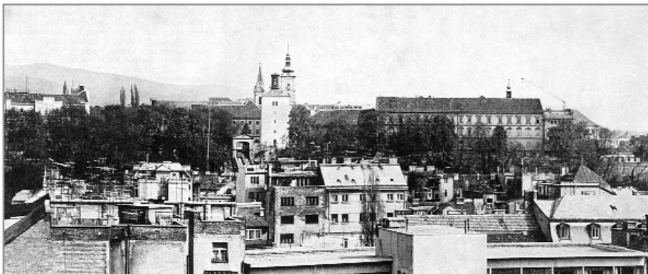
Južna fronta Gradeca, pogled s krovne terase u Masarykovoј ulici, stanje iz 1983.
