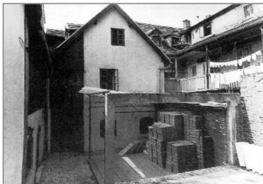
Tkalčićeva 48-50, spremište u rekonstruiranom dvorištu (1976.)
