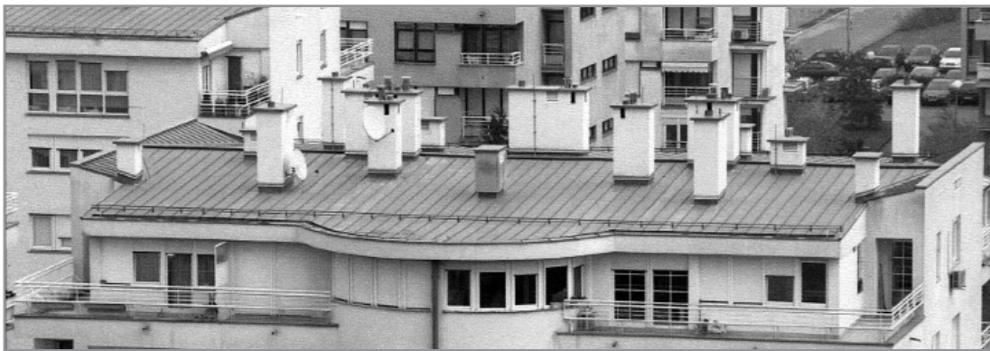
Miramarska 107-109, nova izgradnja (Anamarija Semenčić, 1998.), šuma dimnjaka i ventilacijskih otvora
