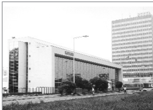
Slavonska avenija 4, poslovna zgrada Vjesnika (Duško Rakić, 1987.), sjeverno pročelje
