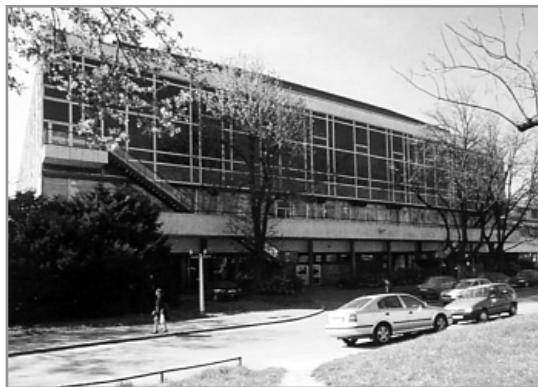
Spoj sa zgradom Matice iseljenika
