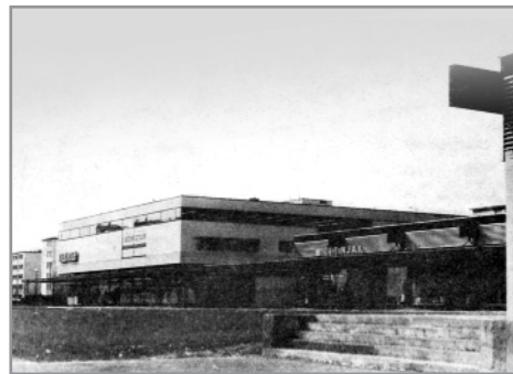
Trnsko, robna kuća Na-Ma s opskrbnim centrom (Aleksandar Dragomanović, Radovan Nikšić, Edo Šmidihen, 1967.-1969.)
