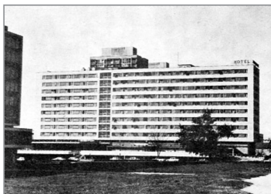
Vukovarska-Miramarska 24, Hotel “Internacional” (Božidar Tušek, 1959.), istočno pročelje
