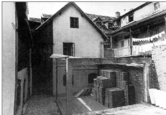
Tkalčićeva 48-50, spremište u rekonstruiranom dvorištu (1976.)
