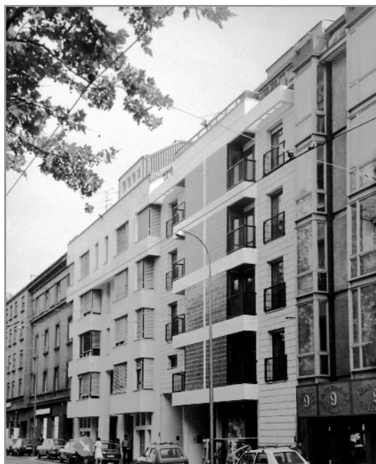
Republike Austrije, tri višestambene zgrade (Branko Kincl, 1976.-1983.)
