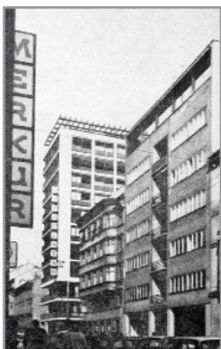
Martićeva 13, kuća Welisch (Drago Ibler, 1930.), u pozadini Iblerov “drveni” neboder
