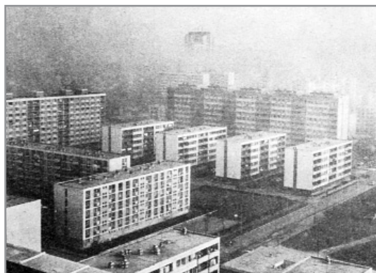
Naselje na Knežiji - pogled s nebodera na gustu izgradnju sjeverno od Ulice Tina Ujevića
