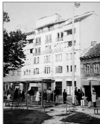
Ilica 158, stambena zgrada (Boris Duplančić, 1989.-1993.)
