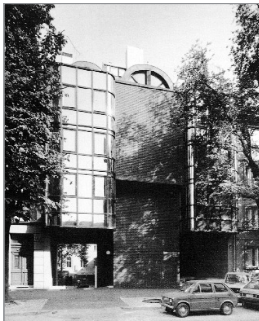
Vodovodna 7, ulično pročelje (Radovan Tajder, 1983.)
