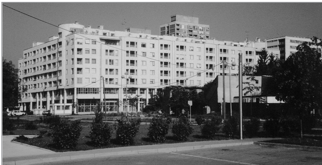
Miramarska 26-38/Čazmanska, stambena zgrada (Benedetto Tardozi, 1997.-1998.), istočno pročelje
