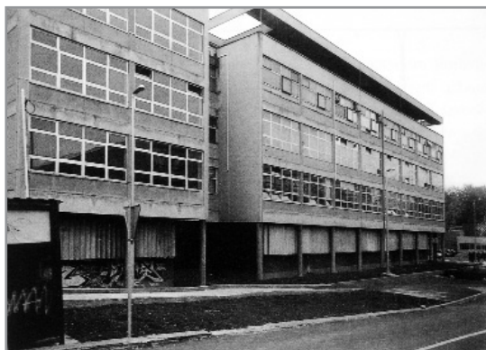
Lučićeva ulica 3, Visoka tehnička škola (danas Fakultet strojarstva i brodogradnje, Marijan Haberle, 1962.), južno pročelje s djelomično izmijenjenom stolarijom prozora
