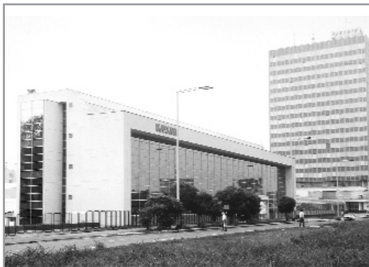
Slavonska avenija 4, poslovna zgrada Vjesnika (Duško Rakić, 1987.), sjeverno pročelje
