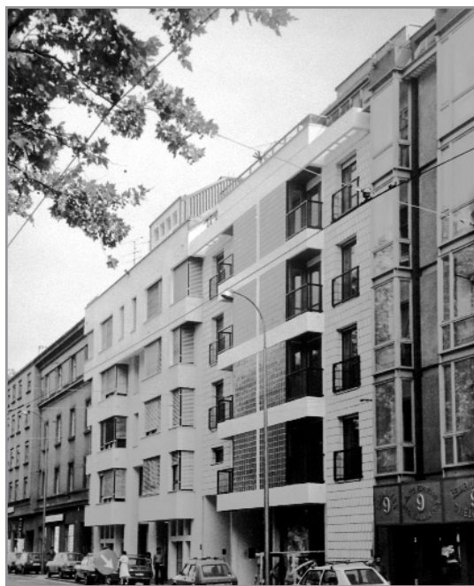
Republike Austrije, tri višestambene zgrade (Branko Kincl, 1976.-1983.)
