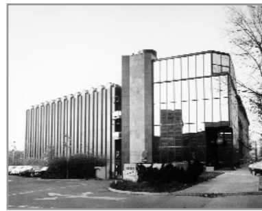
Kršnjavoga 7, Elektra Zagreb (Milan Šosterić, 1975.-1981.), istočno pročelje
