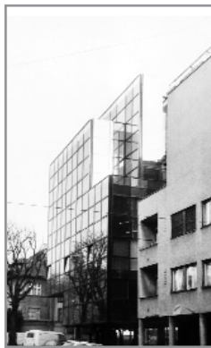
Vončinina 2, poslovna zgrada (Grujo Golijanin, 1968.-1983.), detalj pročelja
