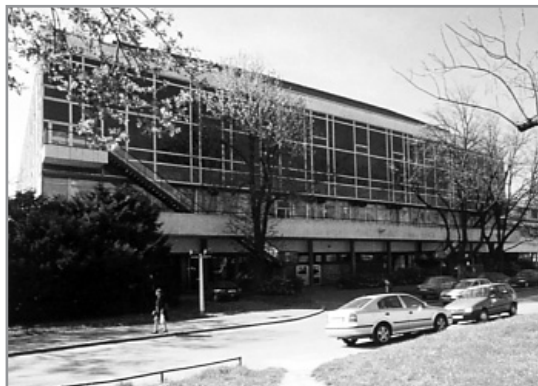
Spoj sa zgradom Matice iseljenika
