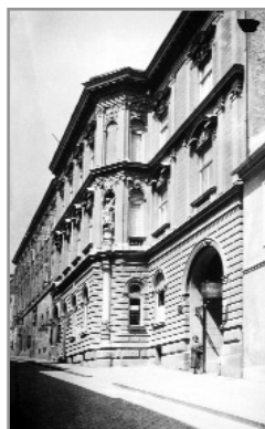
Radićeva 30, zgrada Prve hrvatske štedionice (J. J. Grahor, 1880.-1882.)
