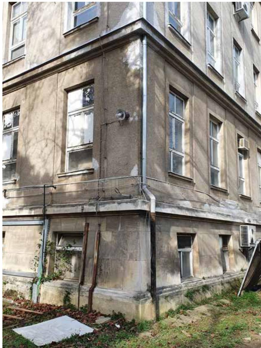
Detalji pročelja Epidemiološkog zavoda sa stanjem u proljeće 2022.
