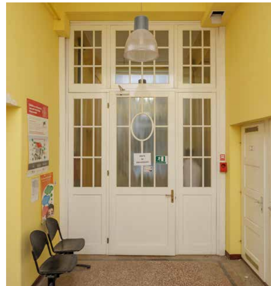
Pogled prema prostoru međukata stubišta prvog i drugog kata
