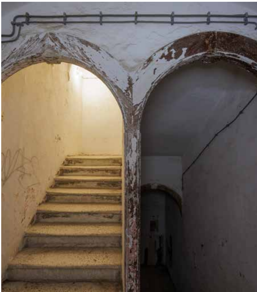
Detalji drvenih lukova u stubištu
