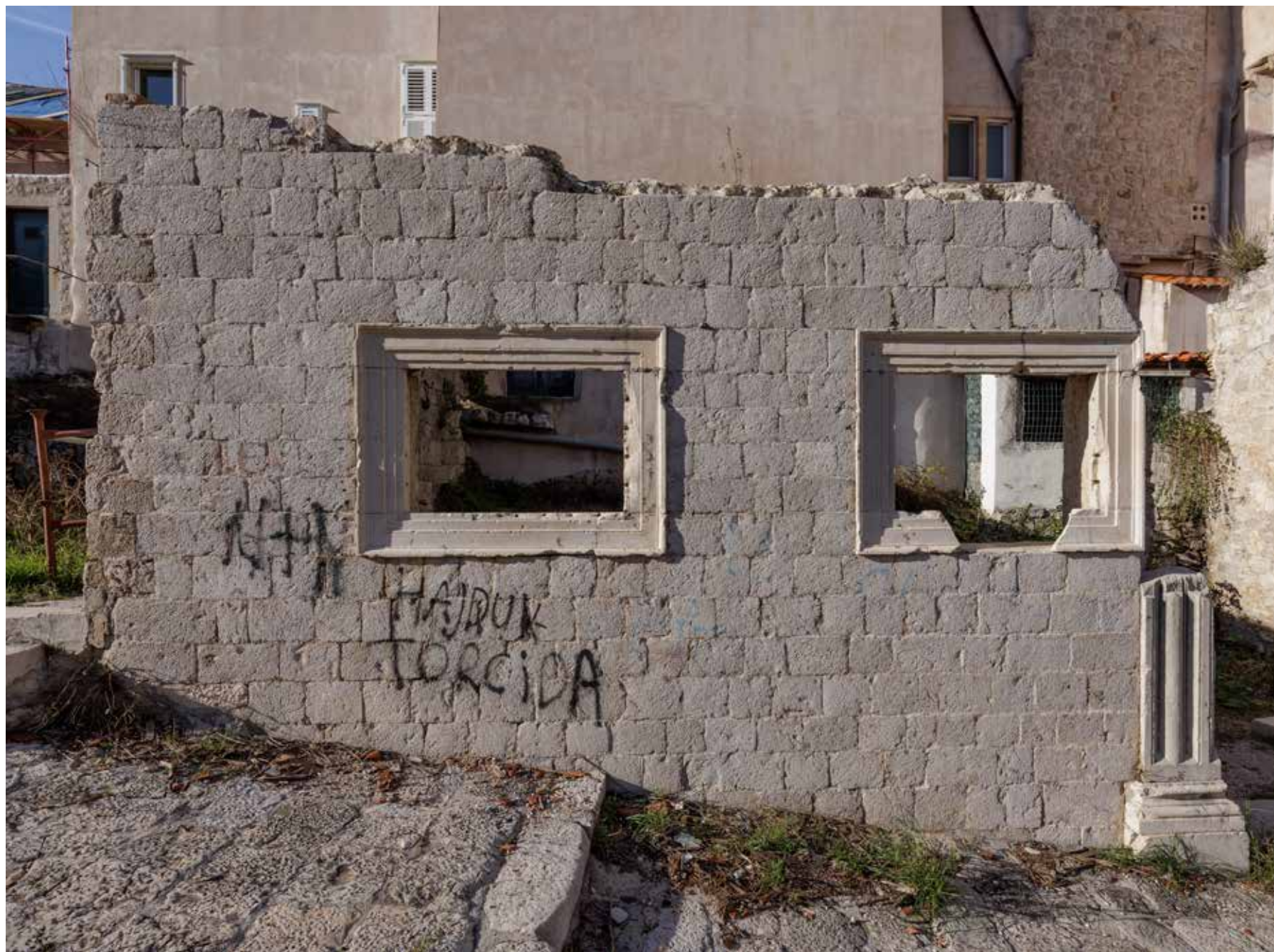
Renesansna palača na arheološkoj zoni, istočno pročelje u novootkrivenoj ulici
