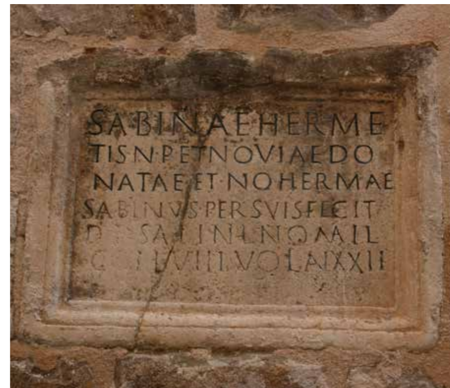
Rimska ploča sekundarno ugrađena u zapadno pročelje
