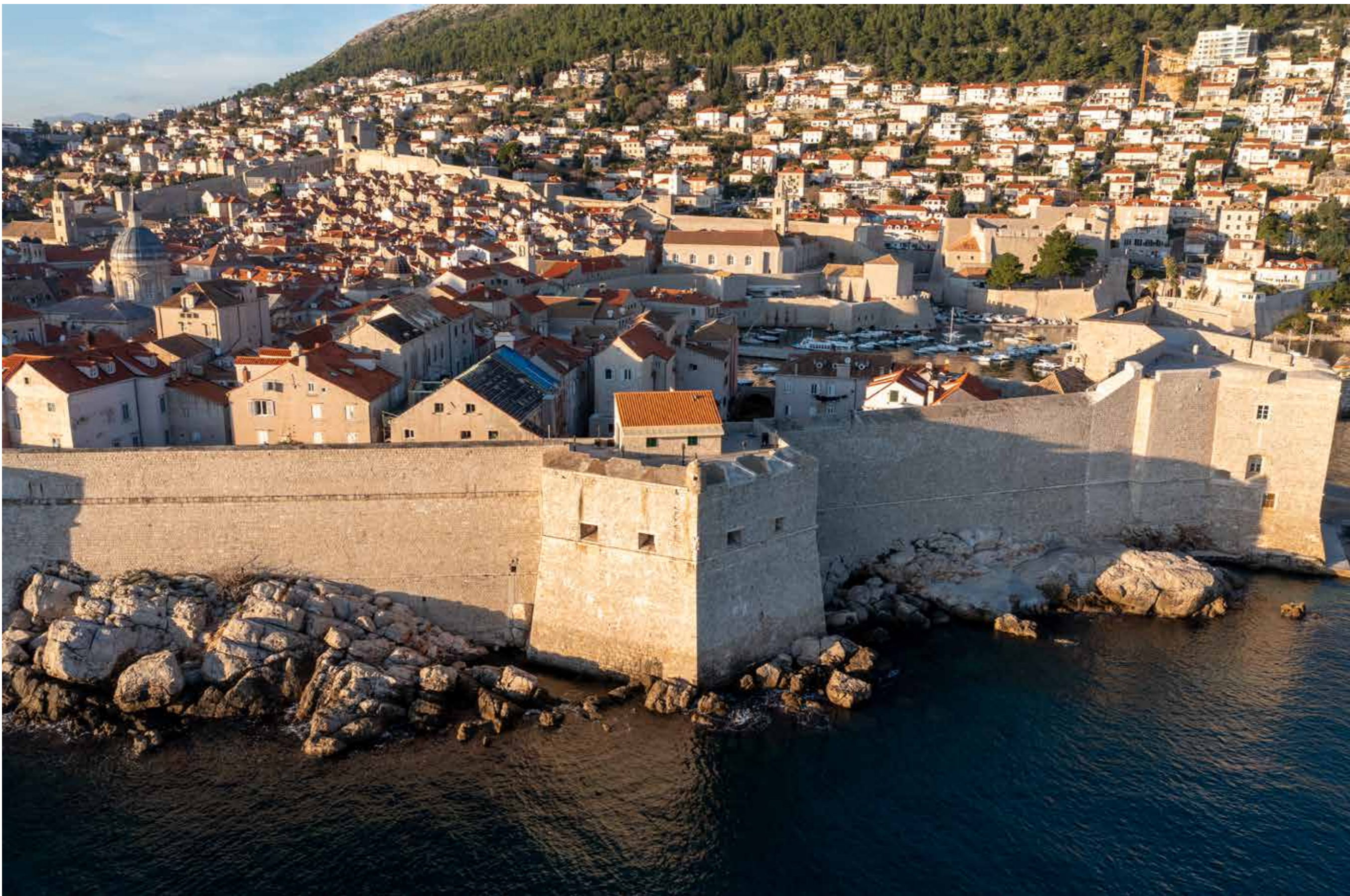
Pogled na bastion Sv. Spasitelja
