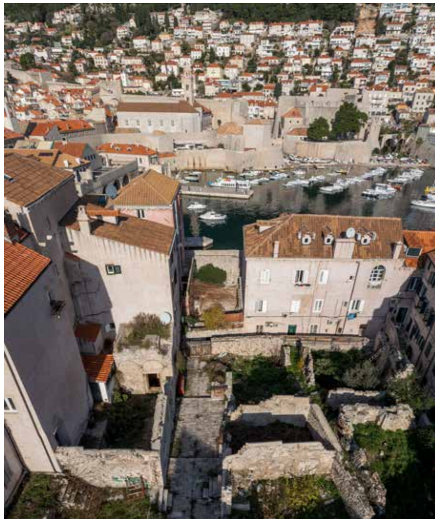
Pogled na novootkrivenu ulicu
