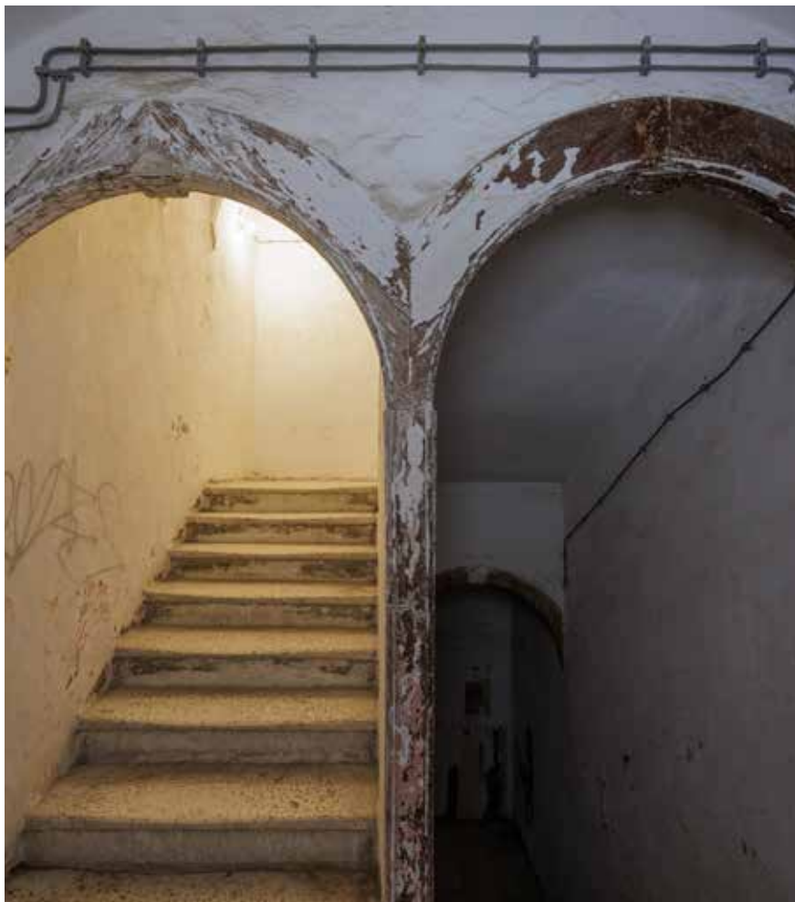
Detalji drvenih lukova u stubištu
