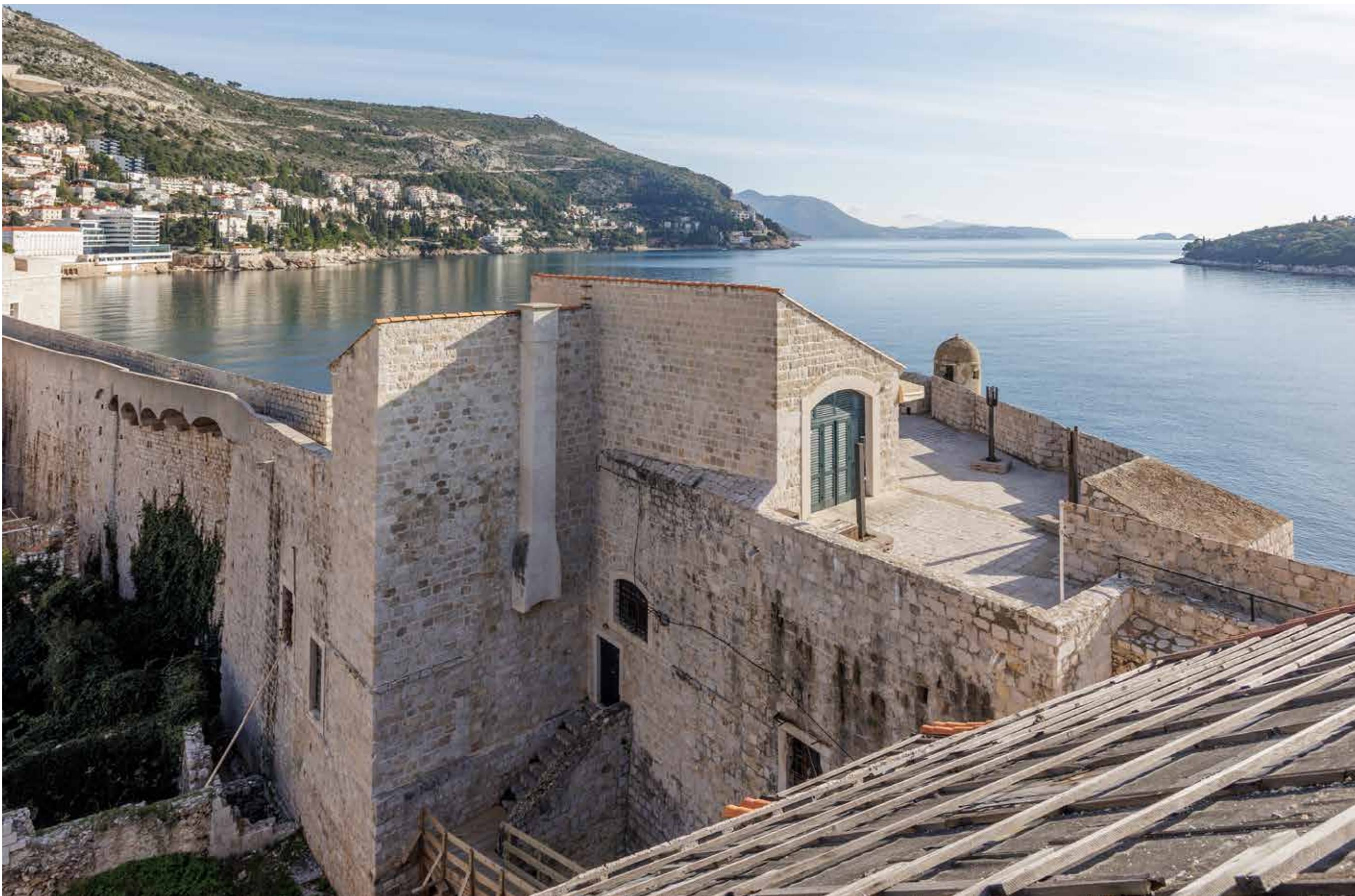
Pogled na bastion Sv. Spasitelja s dogradnjom iz 19. stoljeća
