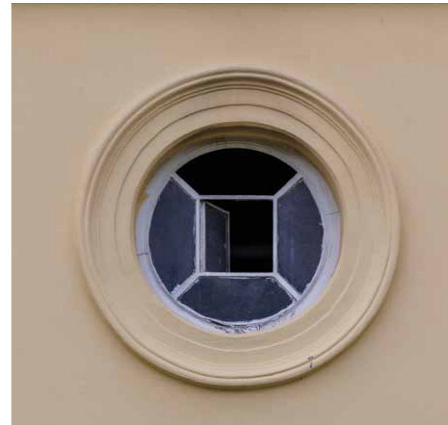
Okrugli prozor na sjevernom pročelju
