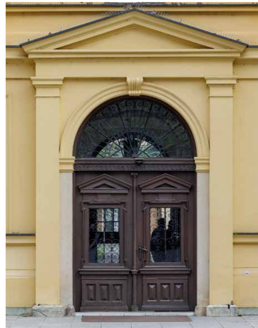
Glavni ulaz u zgradu
