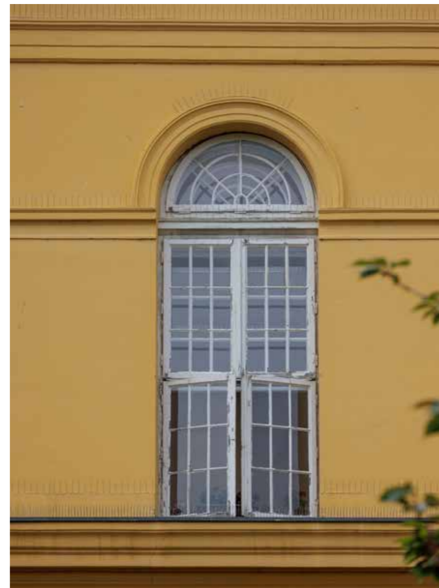
Prozor nekadašnje svečane dvorane na sjevernom pročelju
