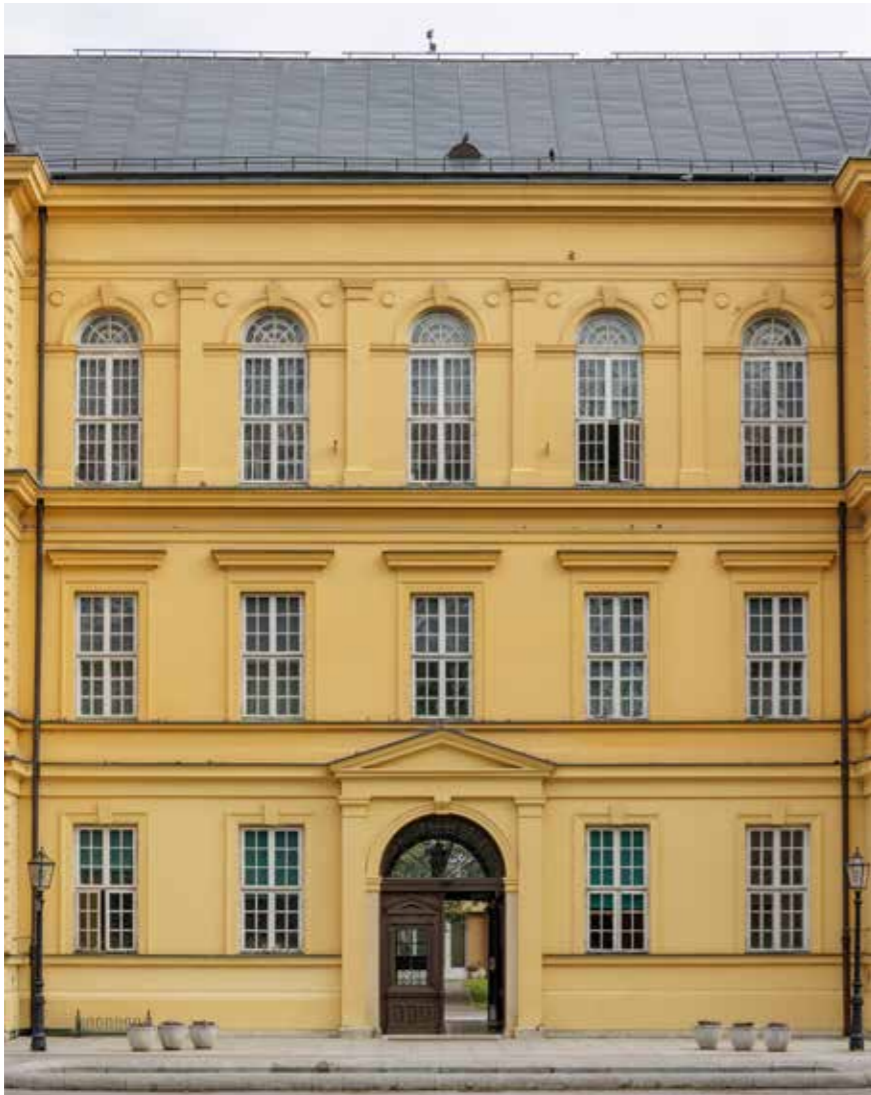
Središnji dio južnog pročelja
