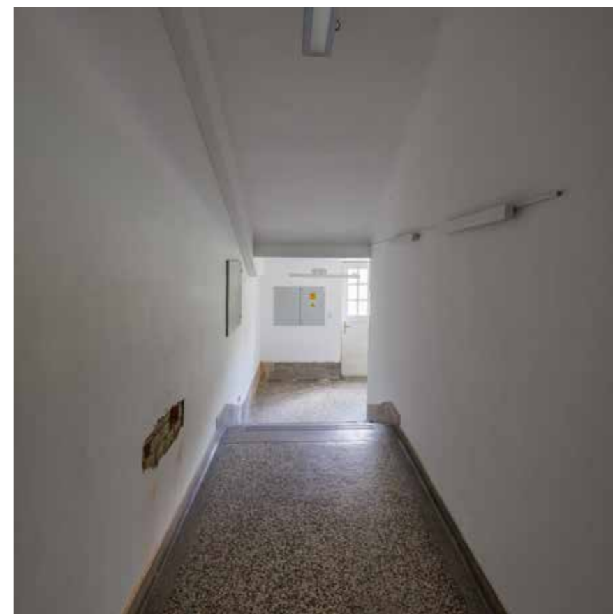
Zapadno stubište iz prizemlja u podrum
