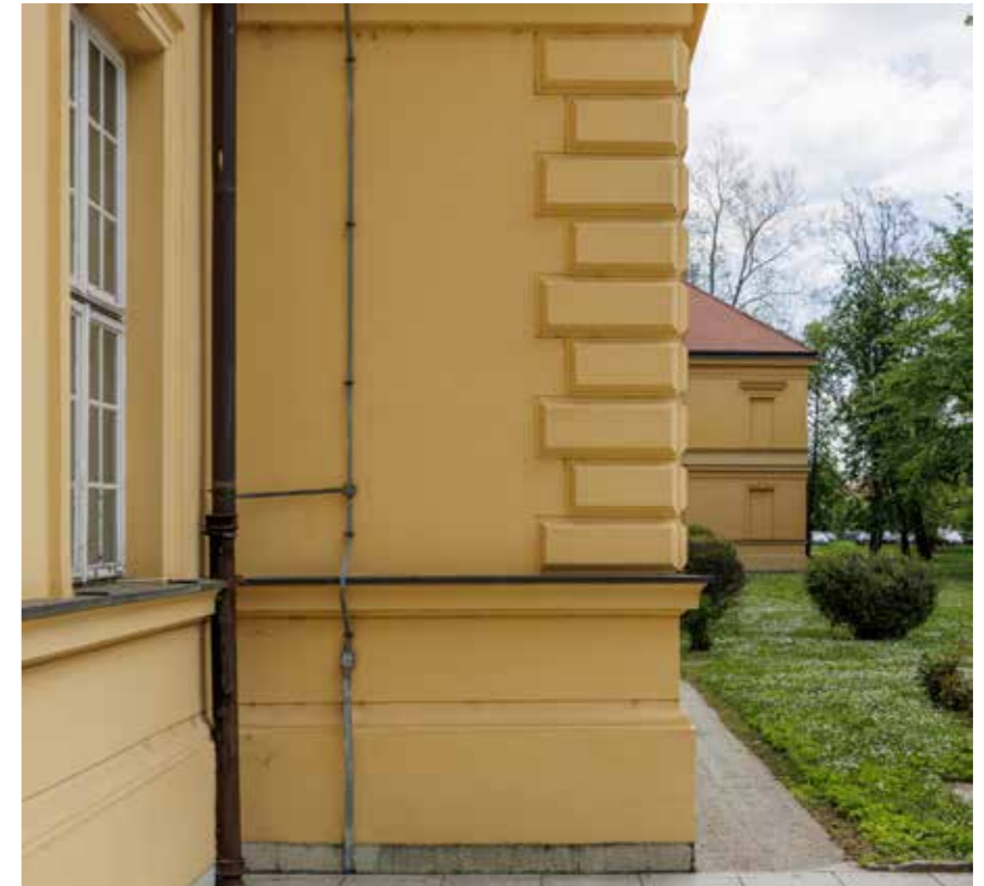
Južno pročelje, detalj
