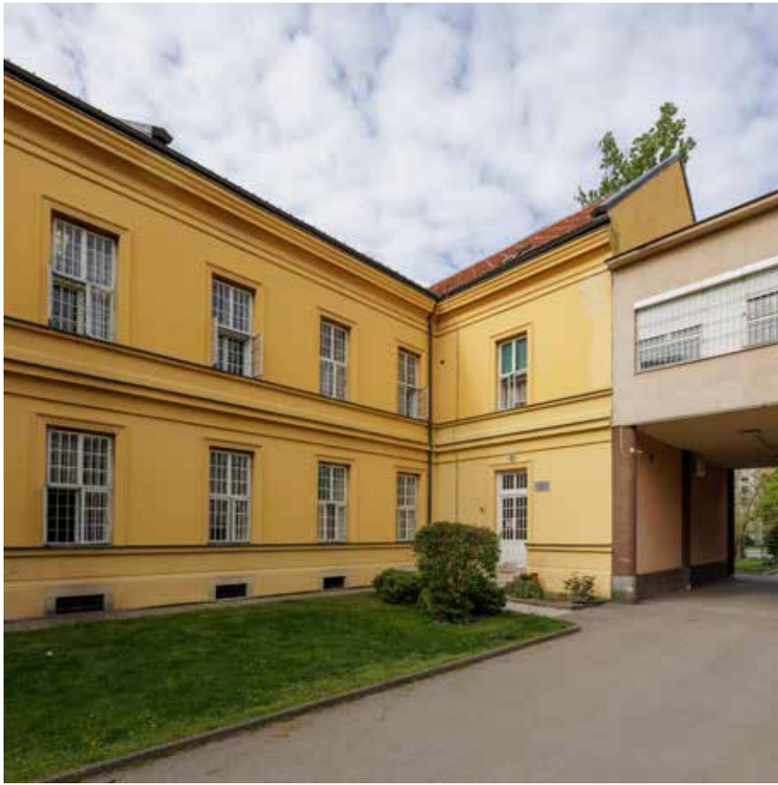
Spoj zapadnog krila i dogradnje
