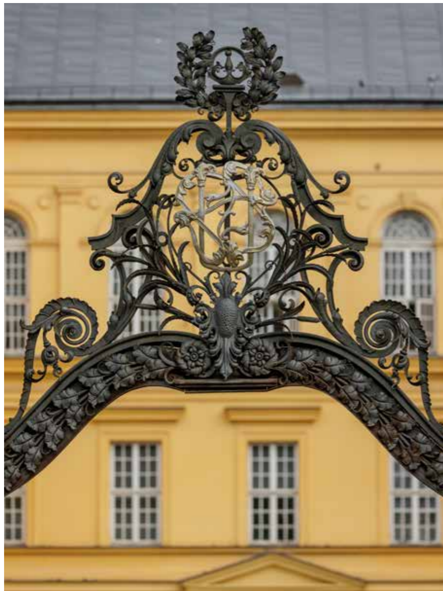
Ulazni portal u bolnički kompleks, detalji
