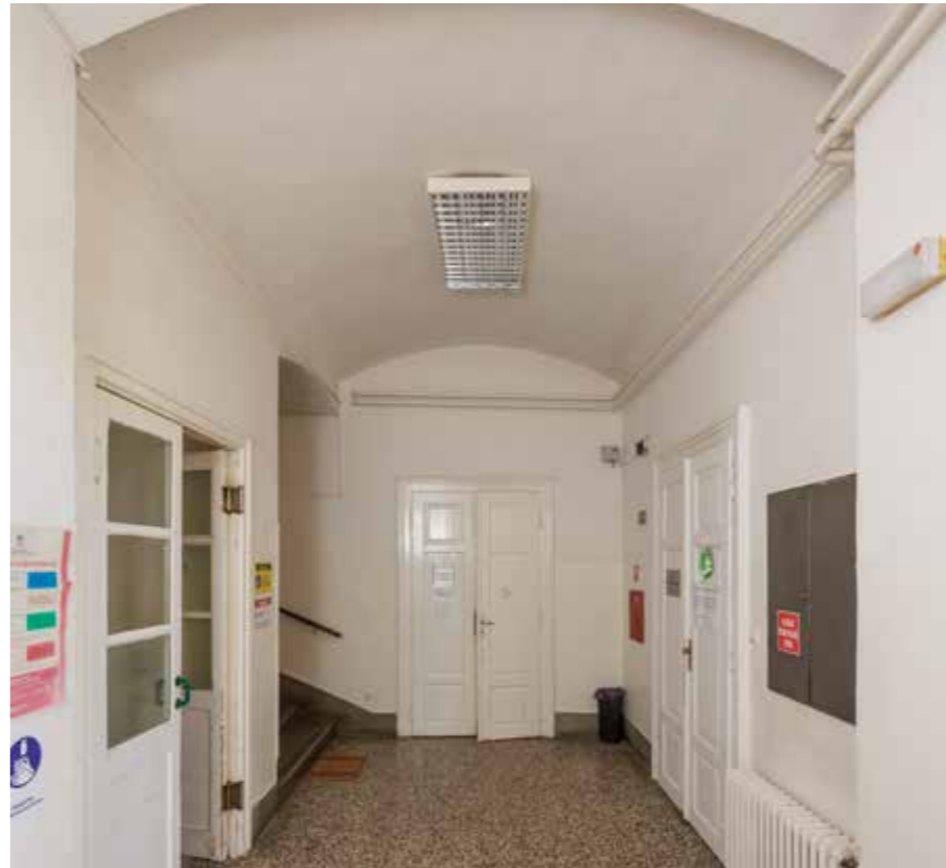
Hodnik ispred stubišta u bočnom istočnom krilu
