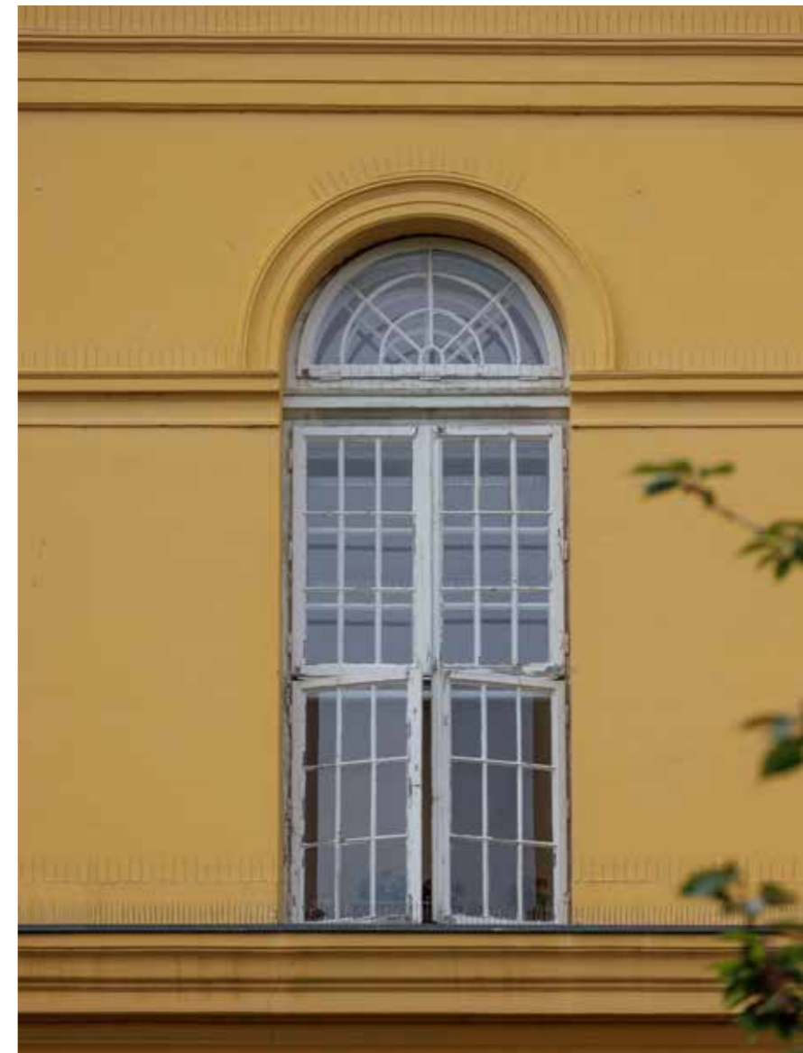
Prozor nekadašnje svečane dvorane na sjevernom pročelju
