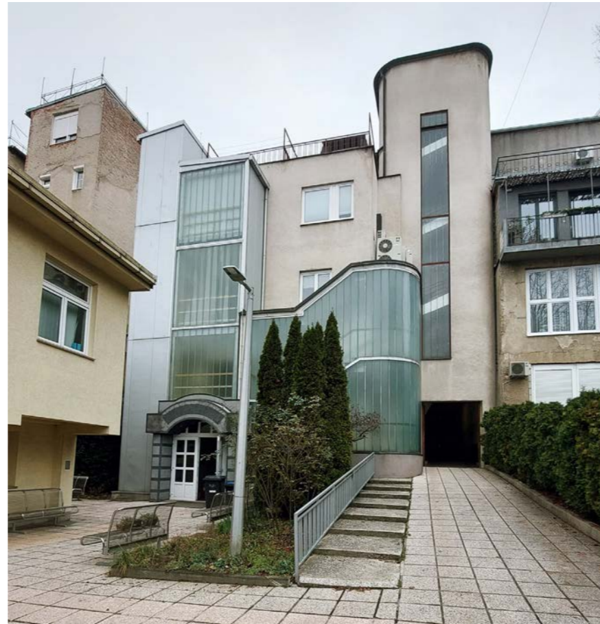
Sl. 5. Dvorišno pročelje glavne stambeno-poslovne trokatnice s dvoranom
