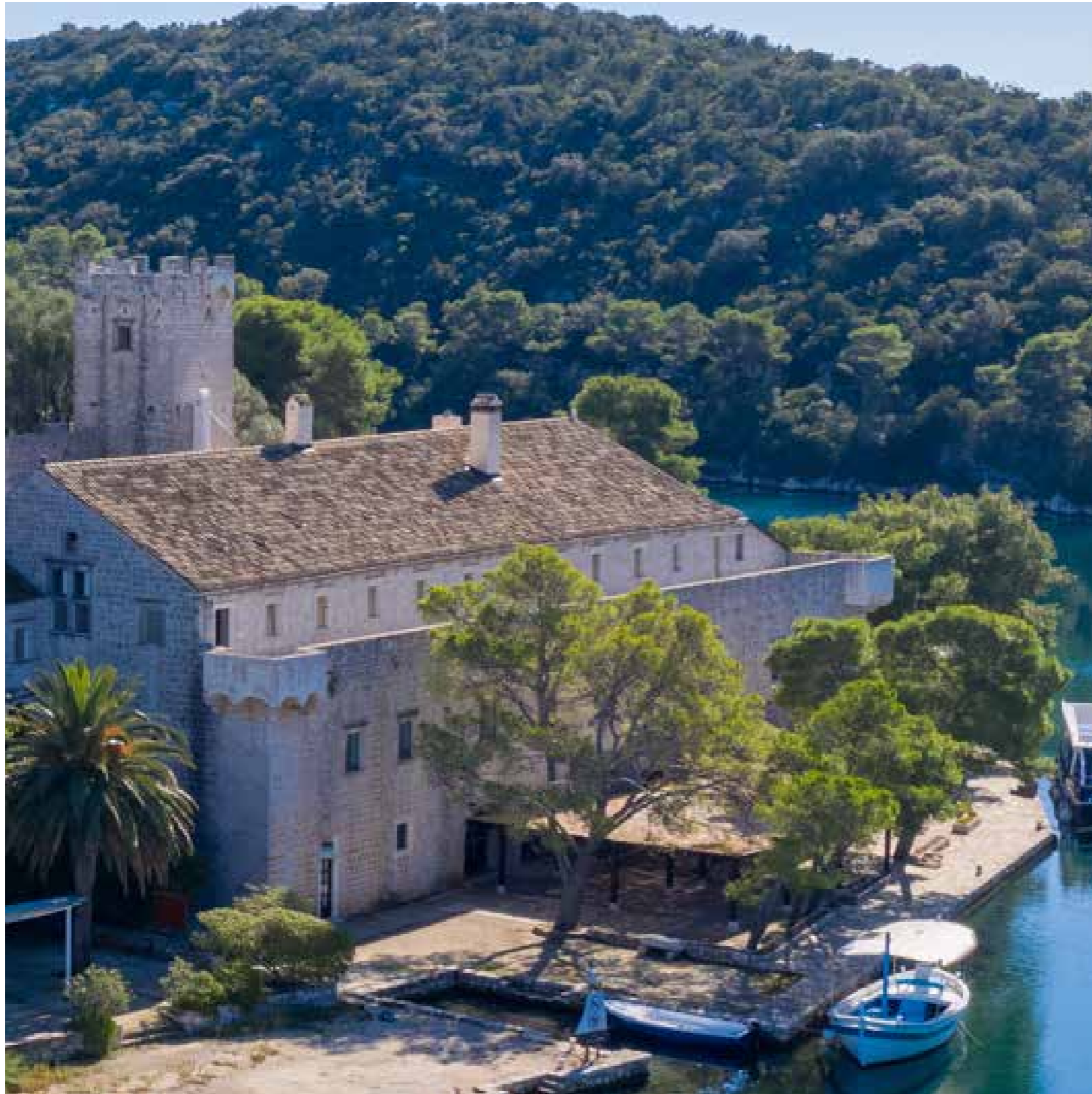
Pogled na zapadno krilo s terasom i ugaonim bretešama
