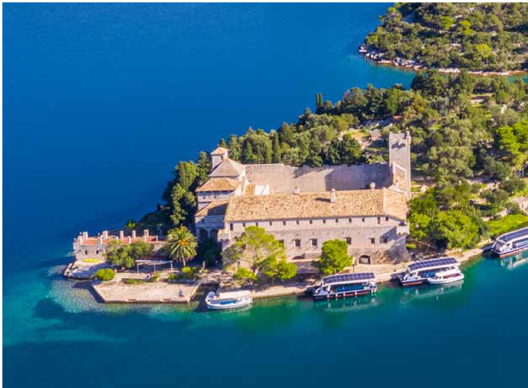
Zapadno krilo s terasom i ugaonim bretešama
