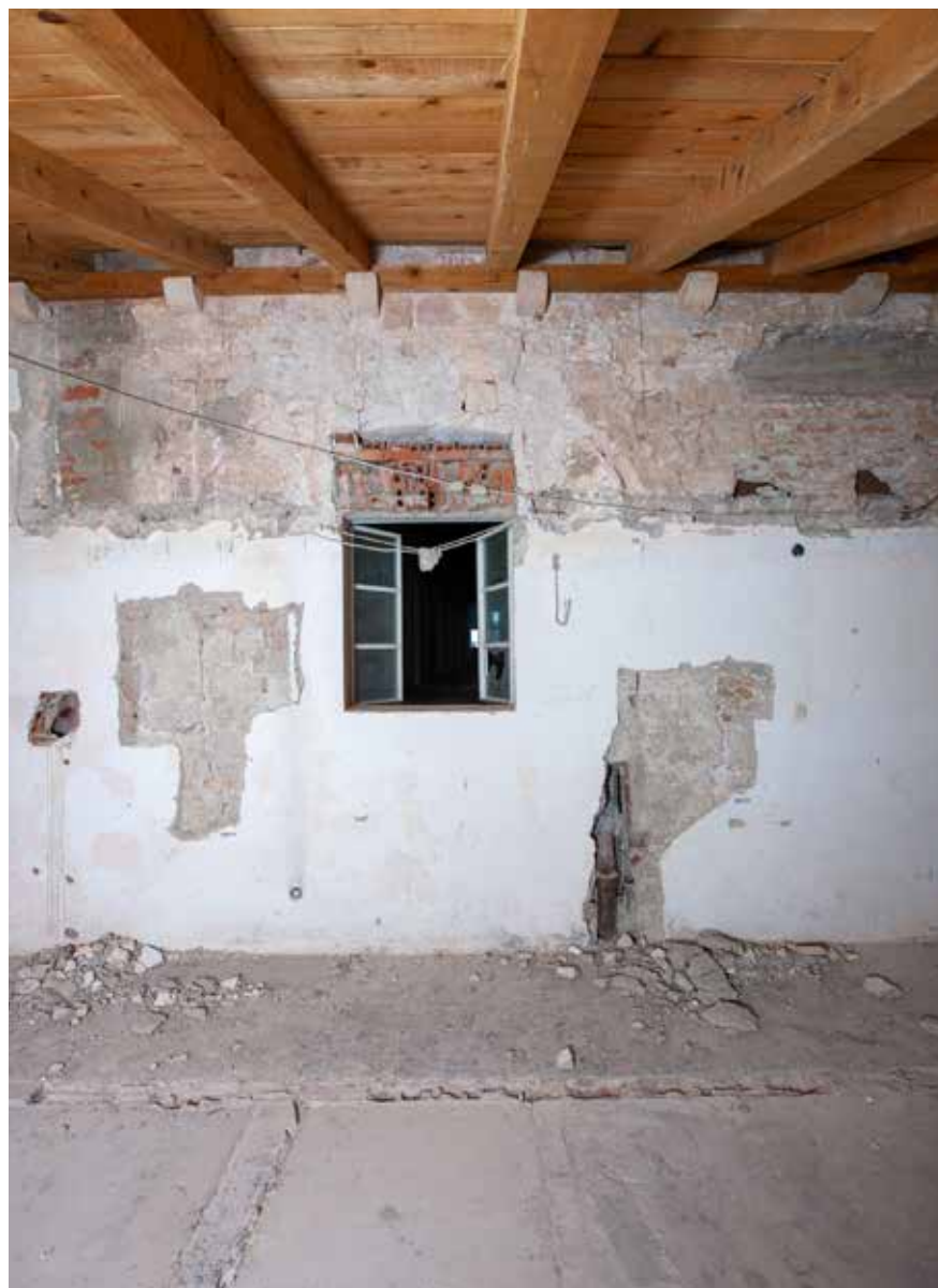
Južno krilo, gornja razina, pogled na zazidani lučni otvor zapadnog krila
