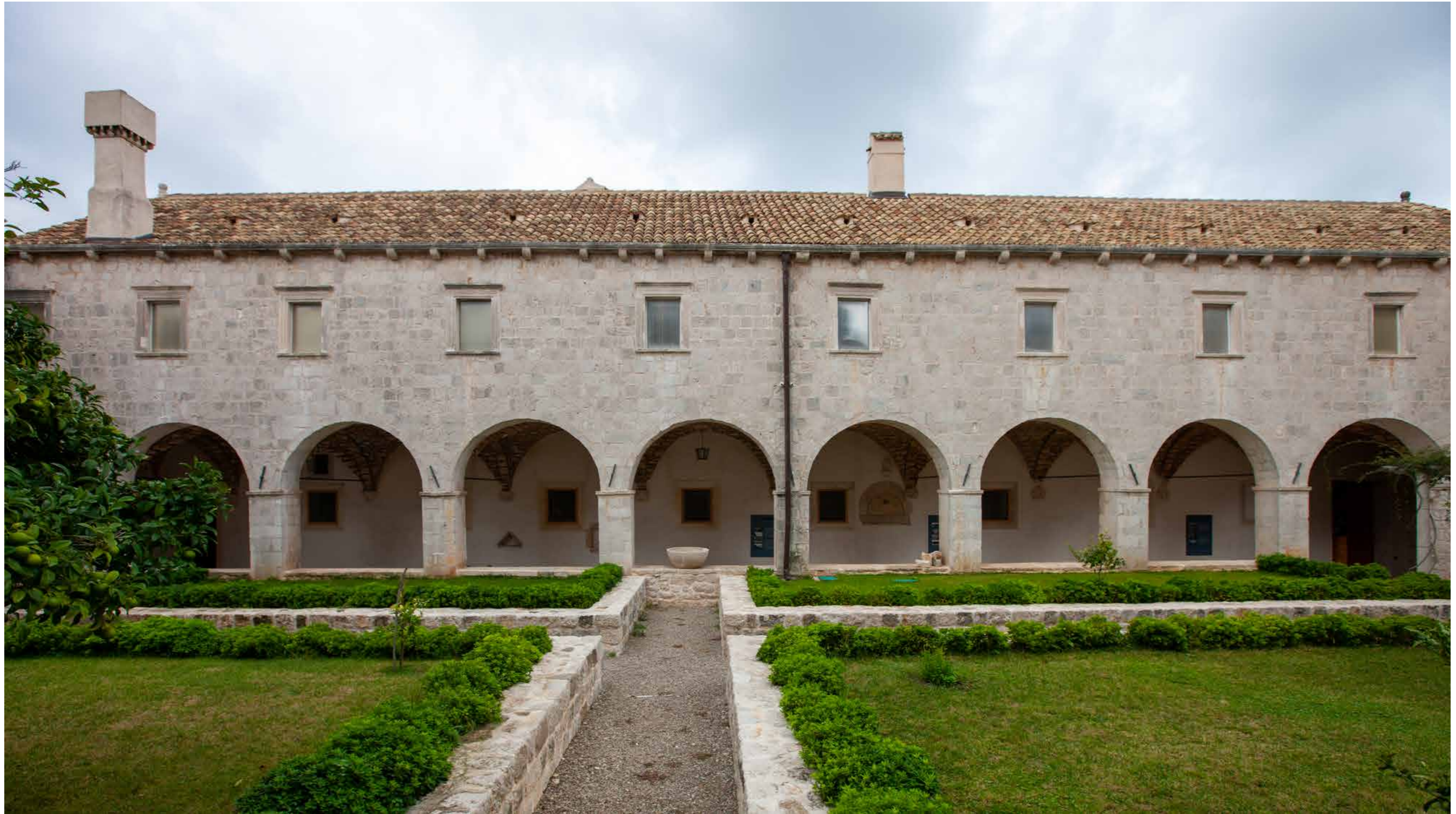
Zapadno krilo, istočno pročelje
