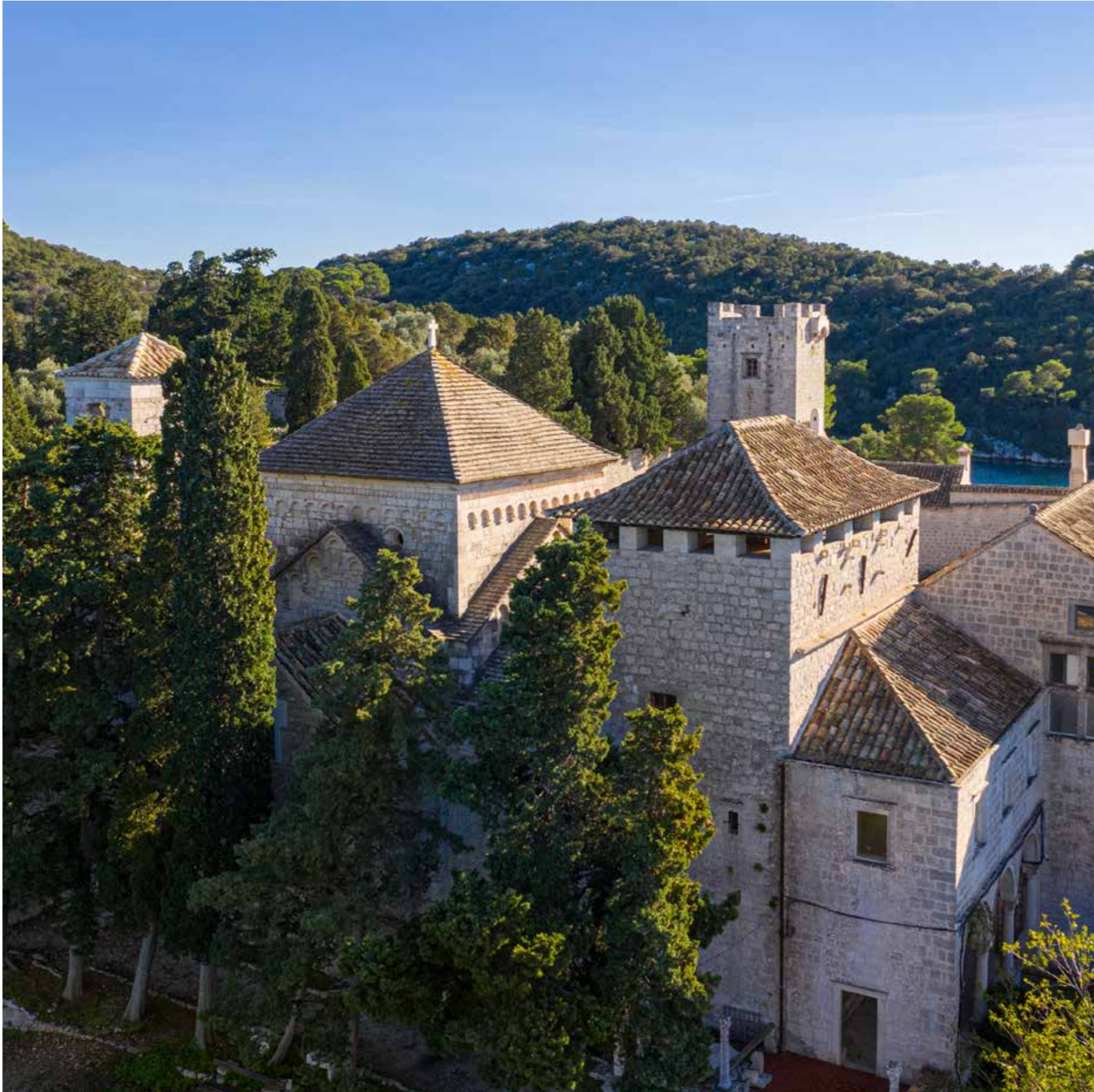
Crkva, predvorje s Gundulićevom kulom i ulazni trijem, pogled sa sjevera
