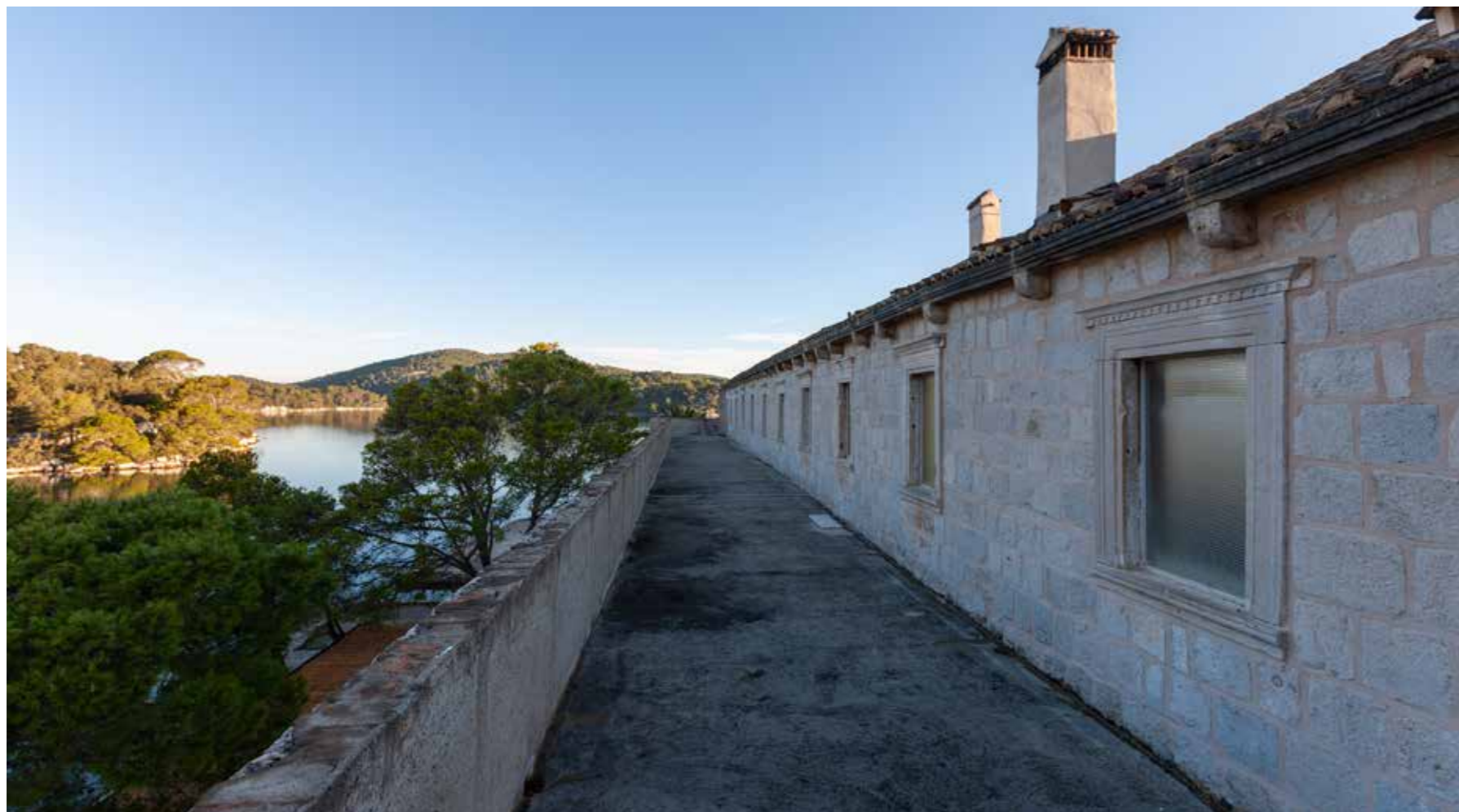
Zapadno krilo, terasa na gornjoj razini uz zapadno pročelje s prozorima ćelija
