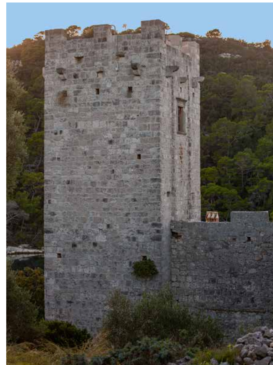
Jugoistočna kula, istočno i sjeverno pročelje
