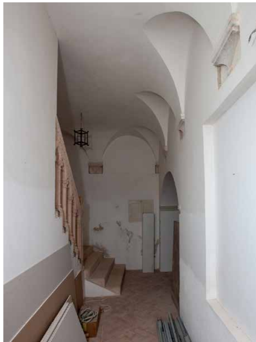
Svodovi uz stubište, detalji
