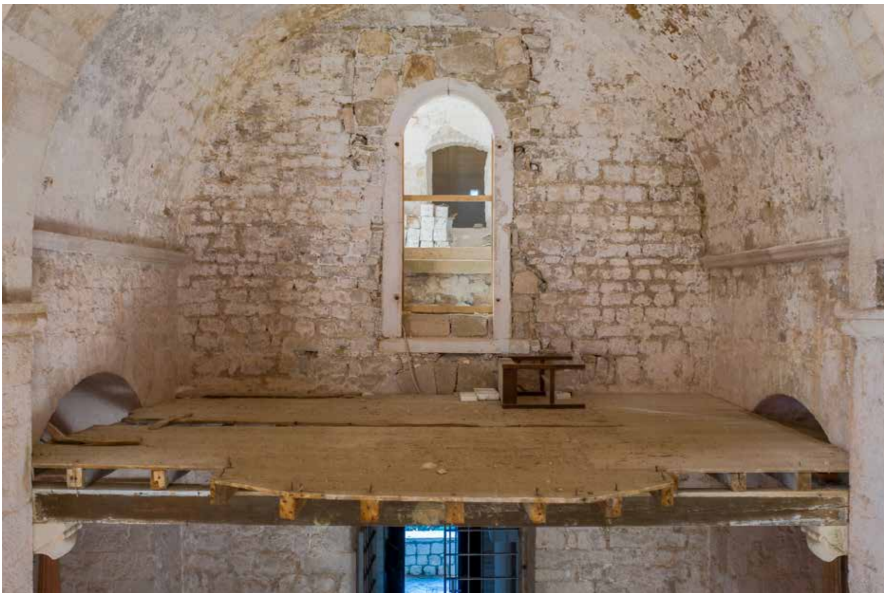
Pjevalište, stanje tijekom restauracije ograde
