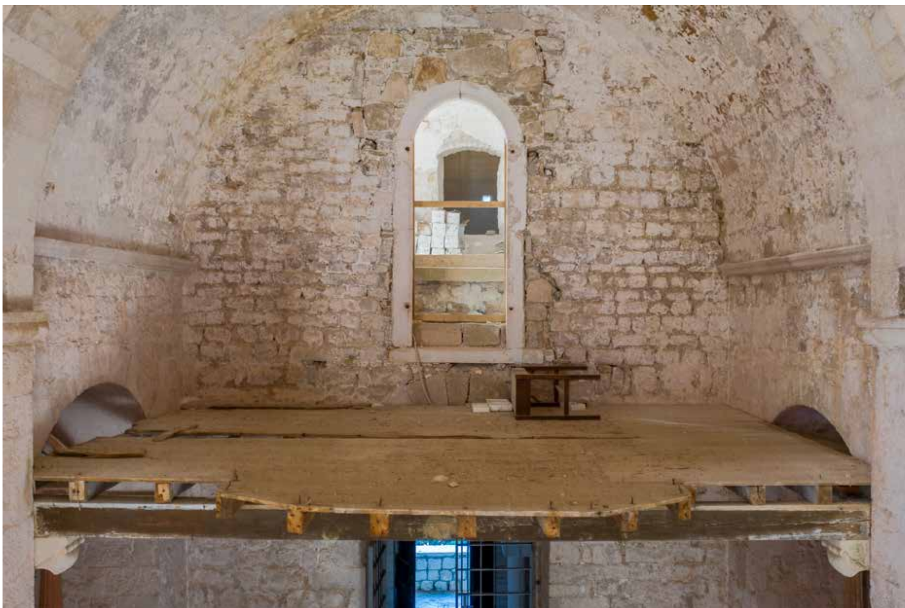
Pjevalište, stanje tijekom restauracije ograde
