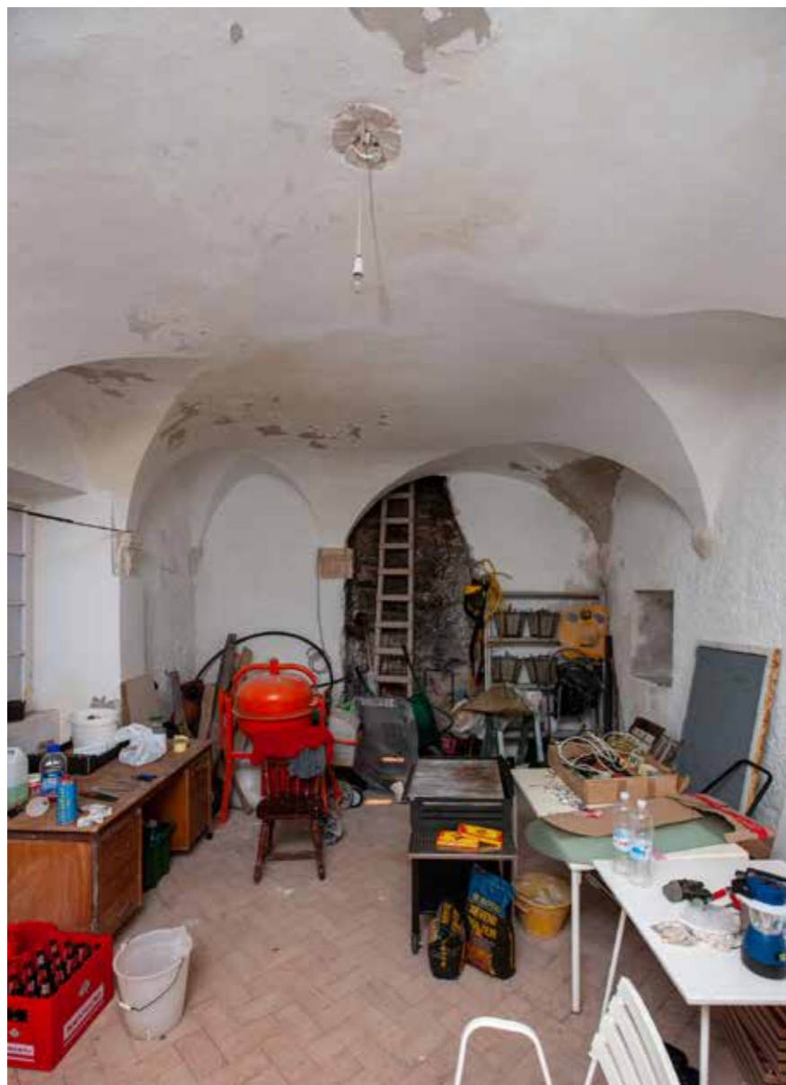
Južno krilo, nadsvođena prostorija u prizemlju
