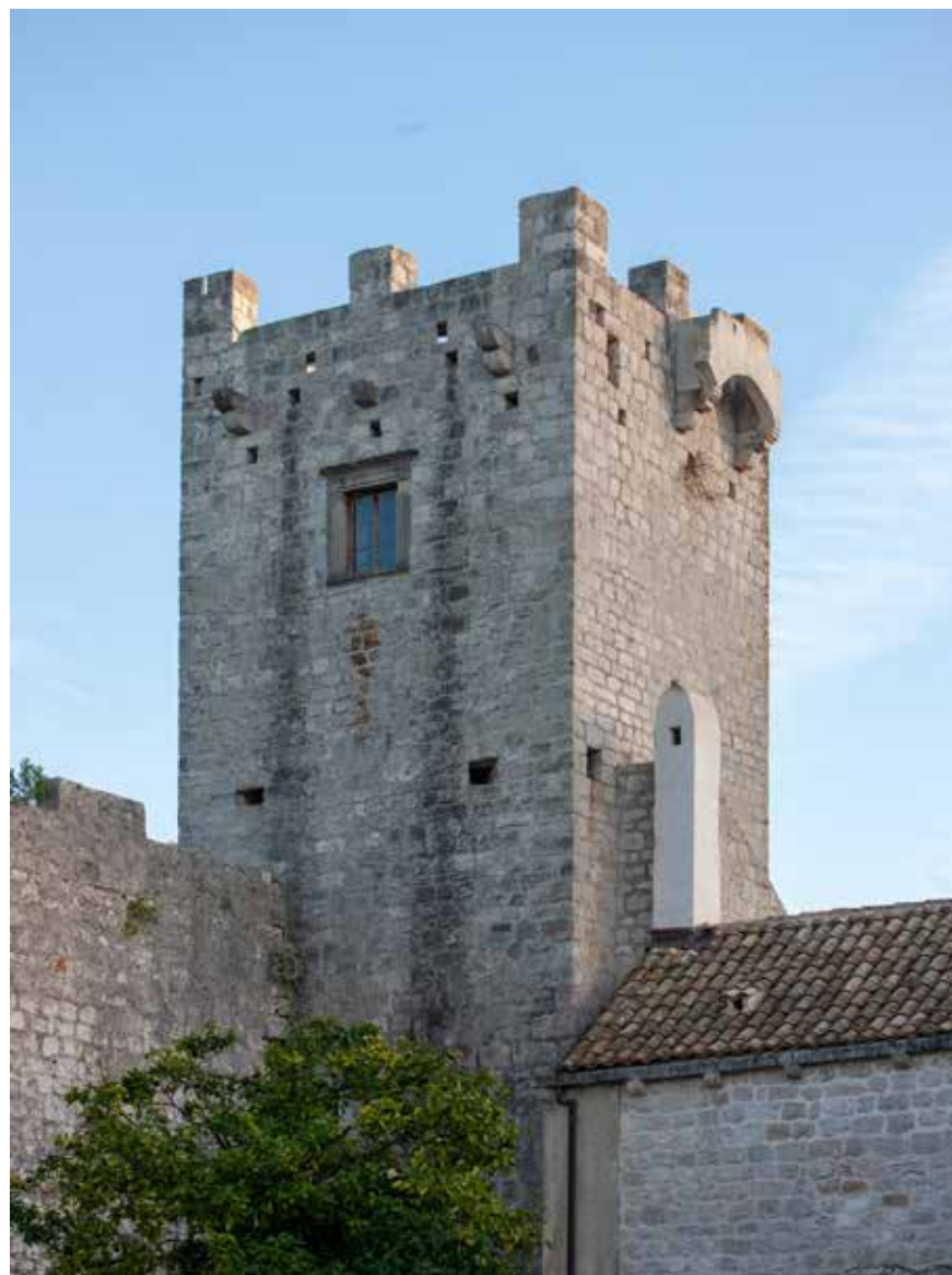
Jugoistočna kula, sjeverno i zapadno pročelje
