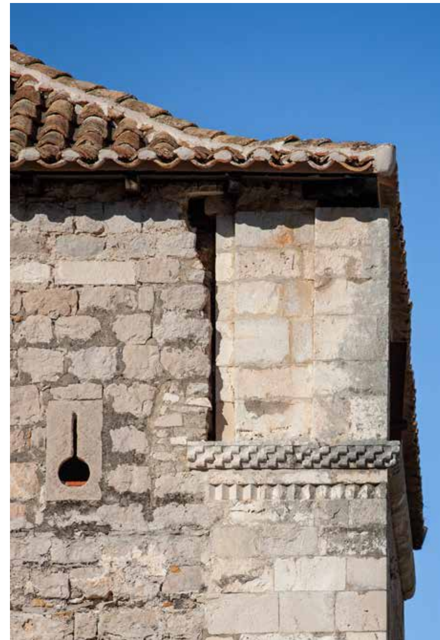
Gundulićeva kula, detalj s ostacima bifore gotičkog zvonika i renesansnom puškarnicom u obliku ključanice
