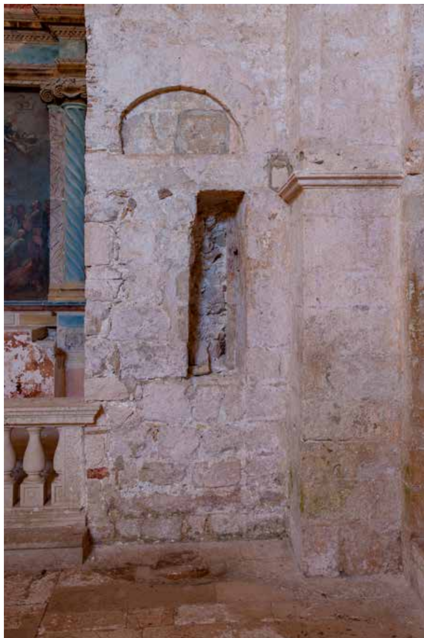
Sjeverni romanički bočni portal
