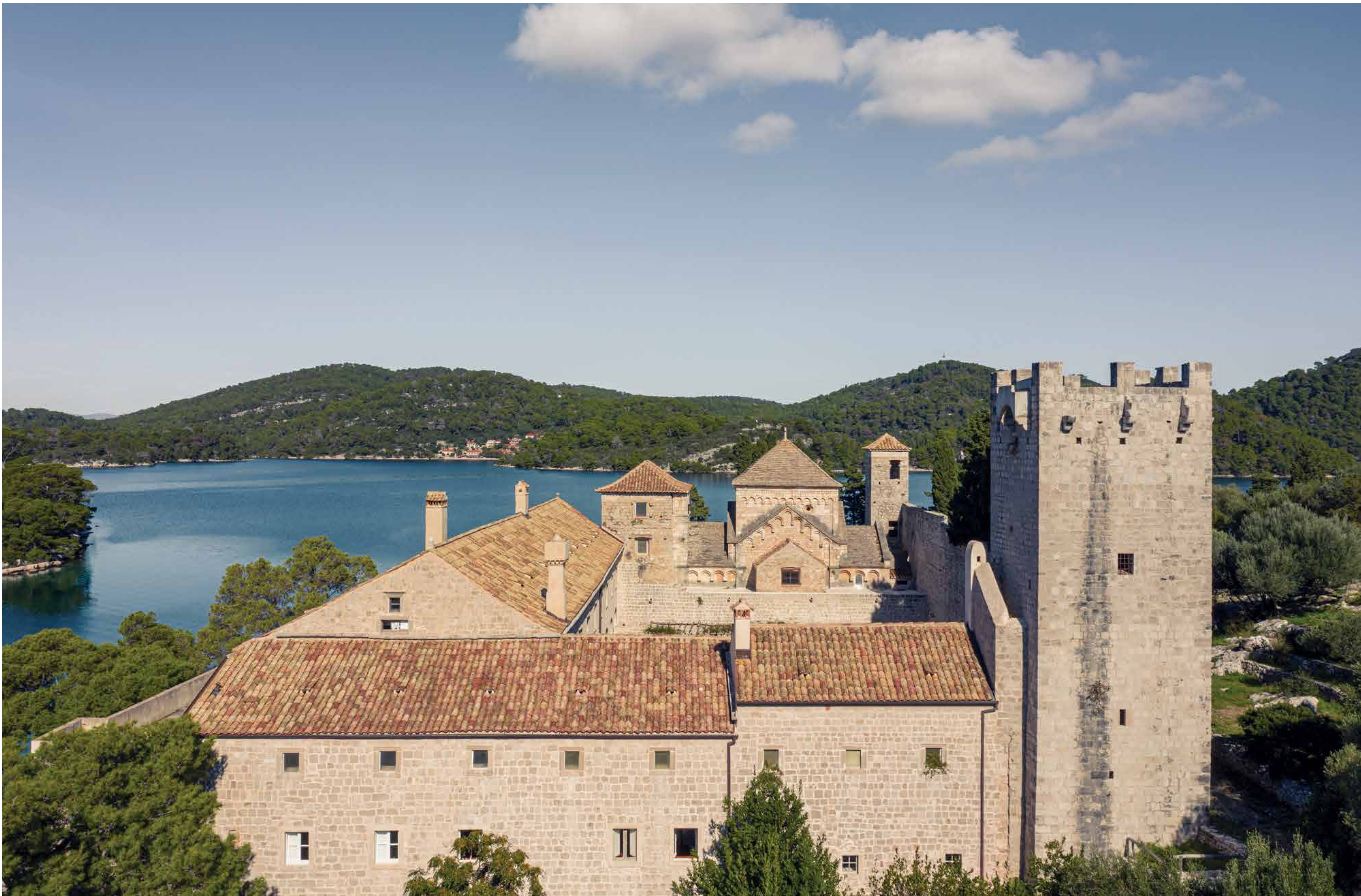
Pogled na samostan s južnim krilom u prvom planu
