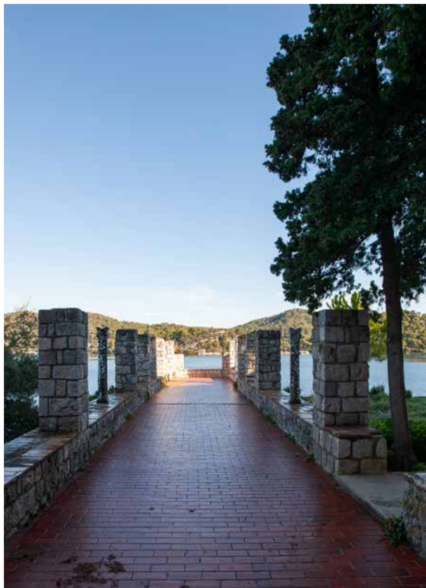
Sjeverni aneks sa šetnicom, pogled prema sjeveru
