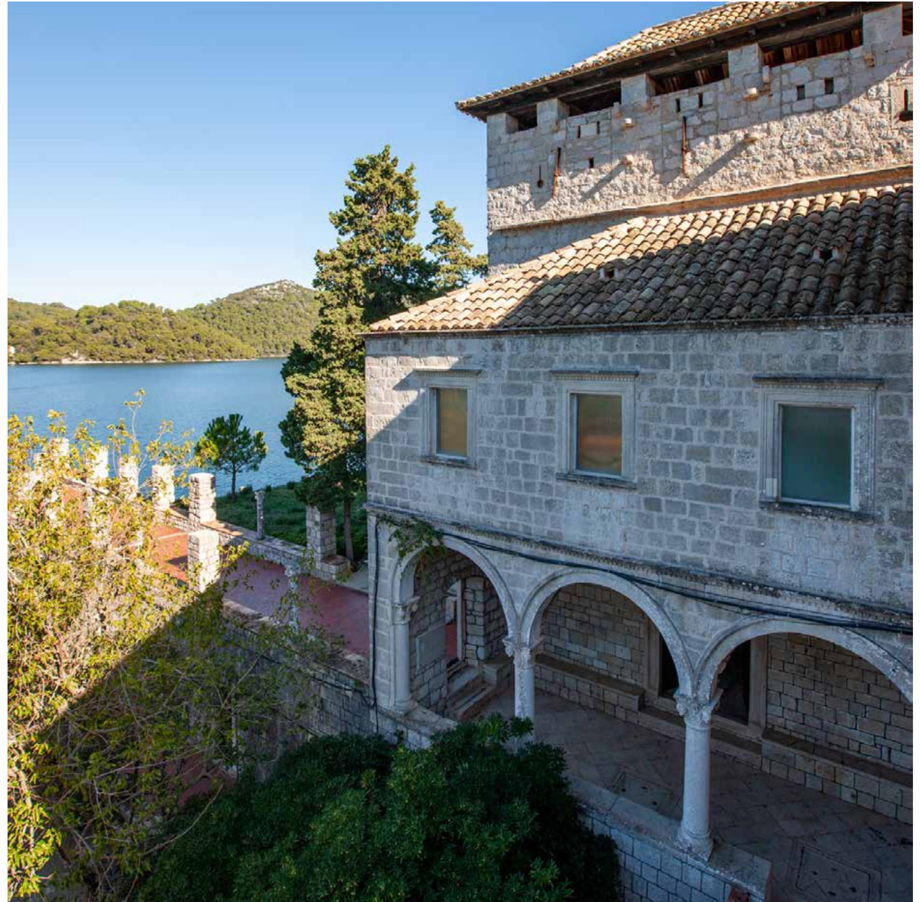
Ulazni trakt s trijemom i opatovom sobom na katu
