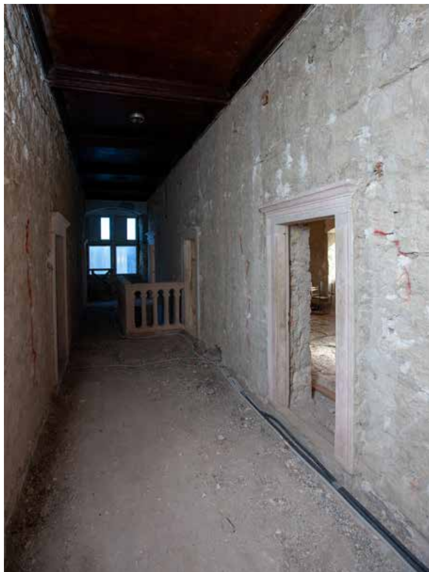
Središnji hodnik na gornjoj razini, pogled prema sjevernoj strani sa stubištem
