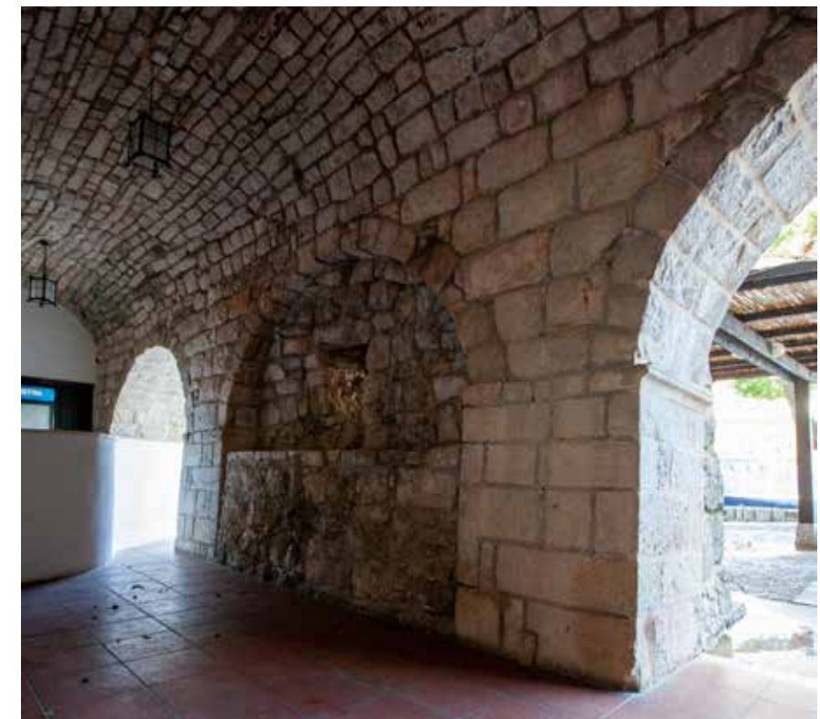
Zapadno krilo samostana, hodnik na prvoj razini sa zazidanim lučnim otvorima
