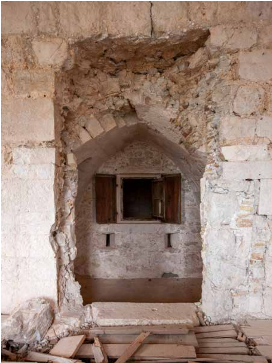
Zazidani otvor polukata s puškarnicama prema predvorju
