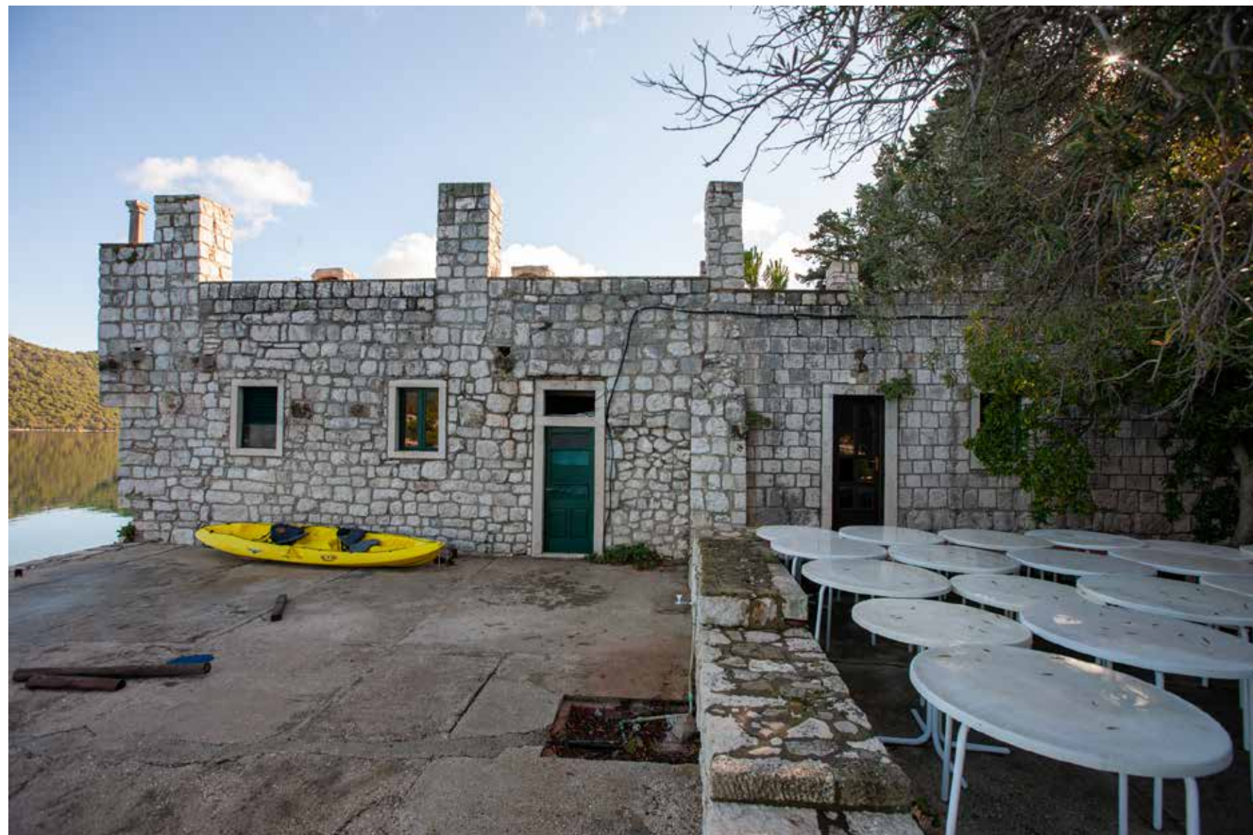
Sjeverni aneks, zapadno pročelje
