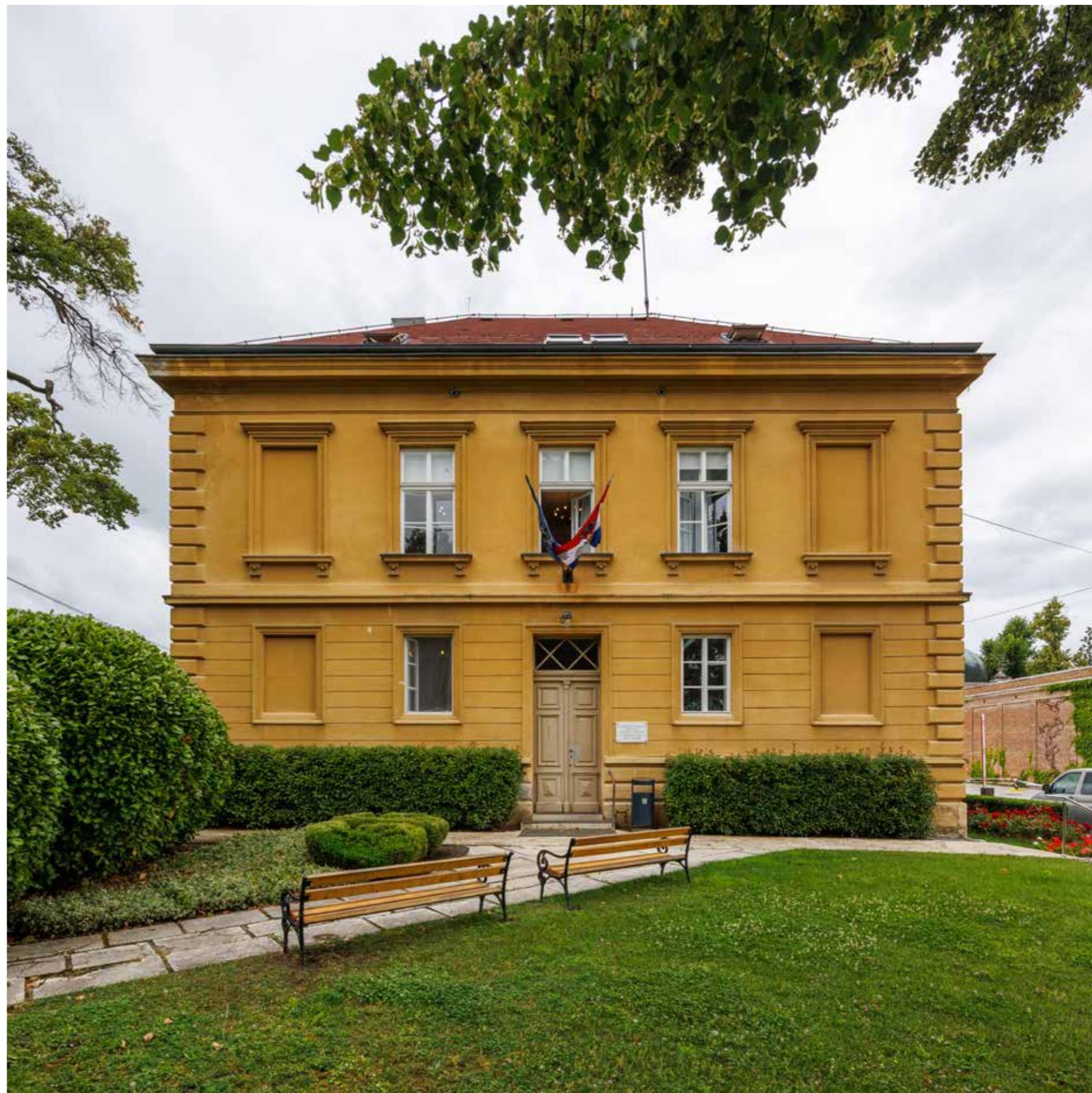
Južno, glavno pročelje
