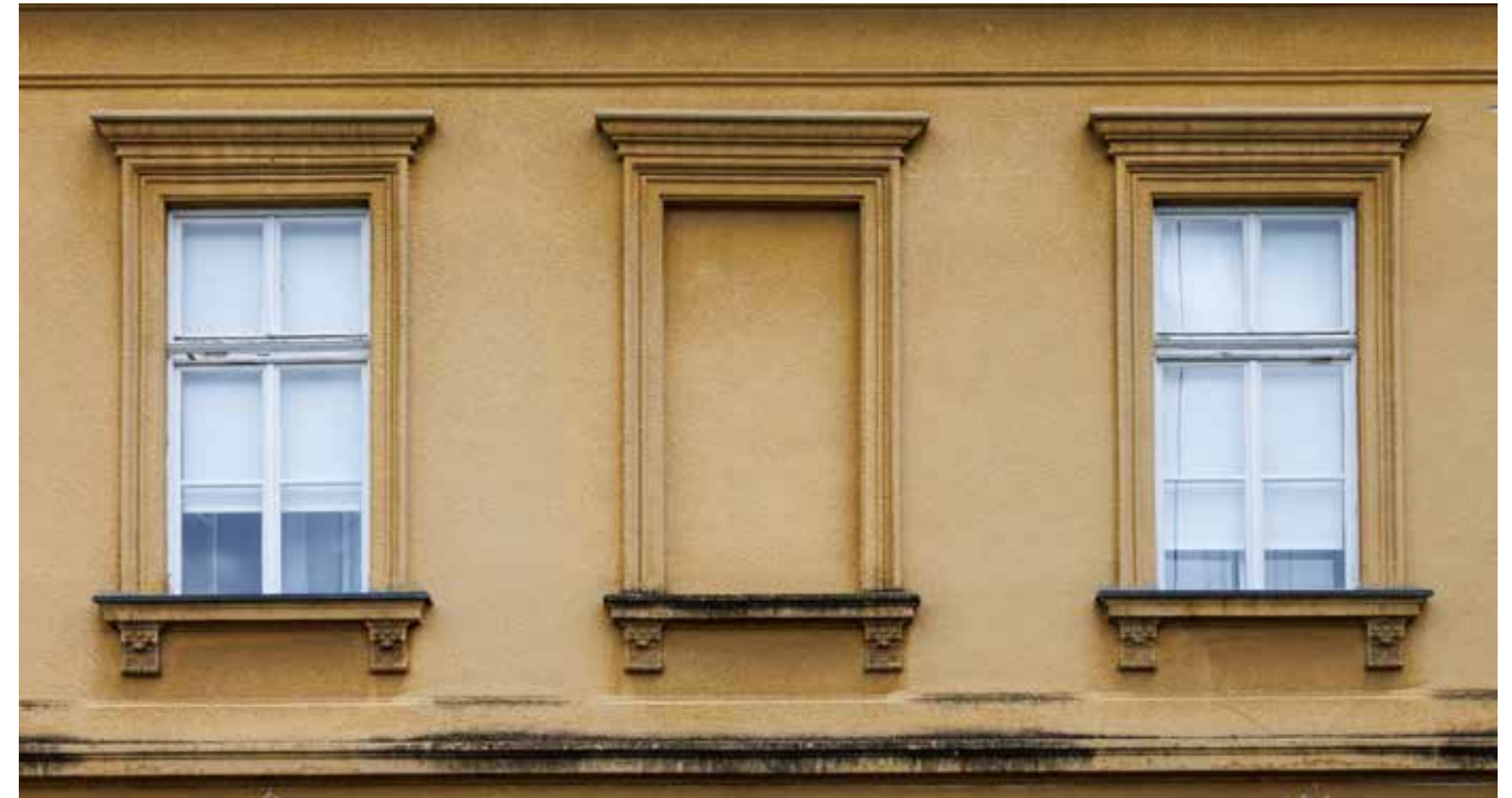
Prozori prvog kata istočnog pročelja
