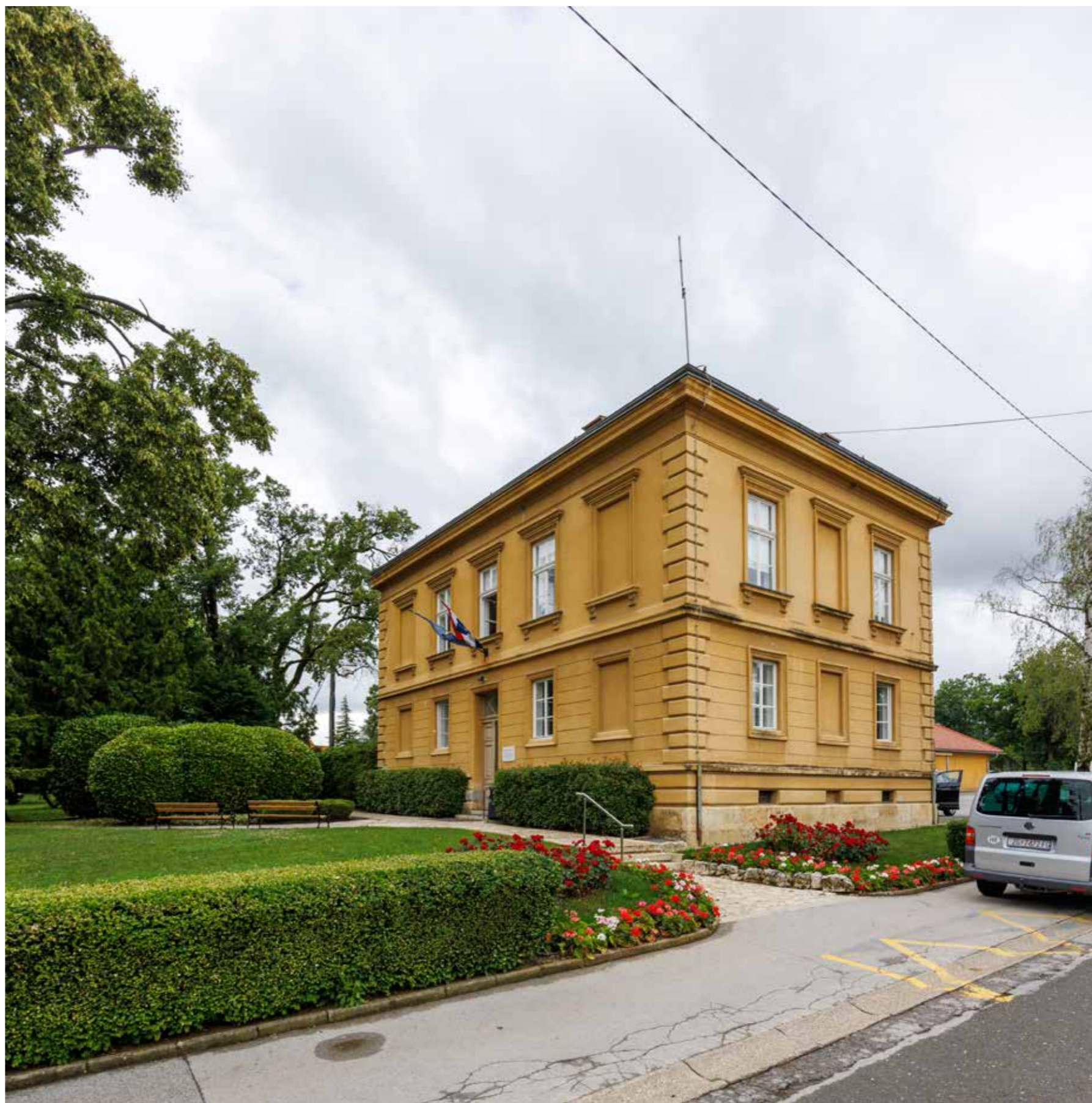
Upravna zgrada groblja Mirogoj
