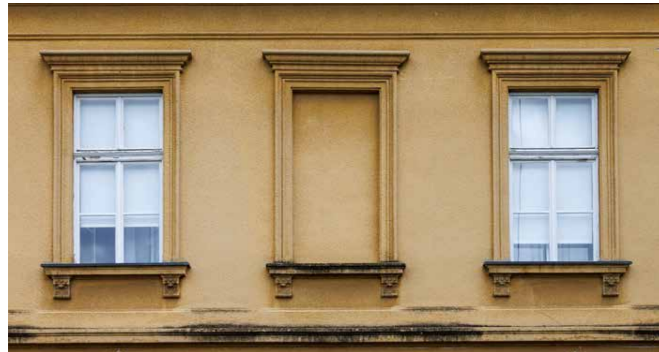
Prozori prvog kata istočnog pročelja
