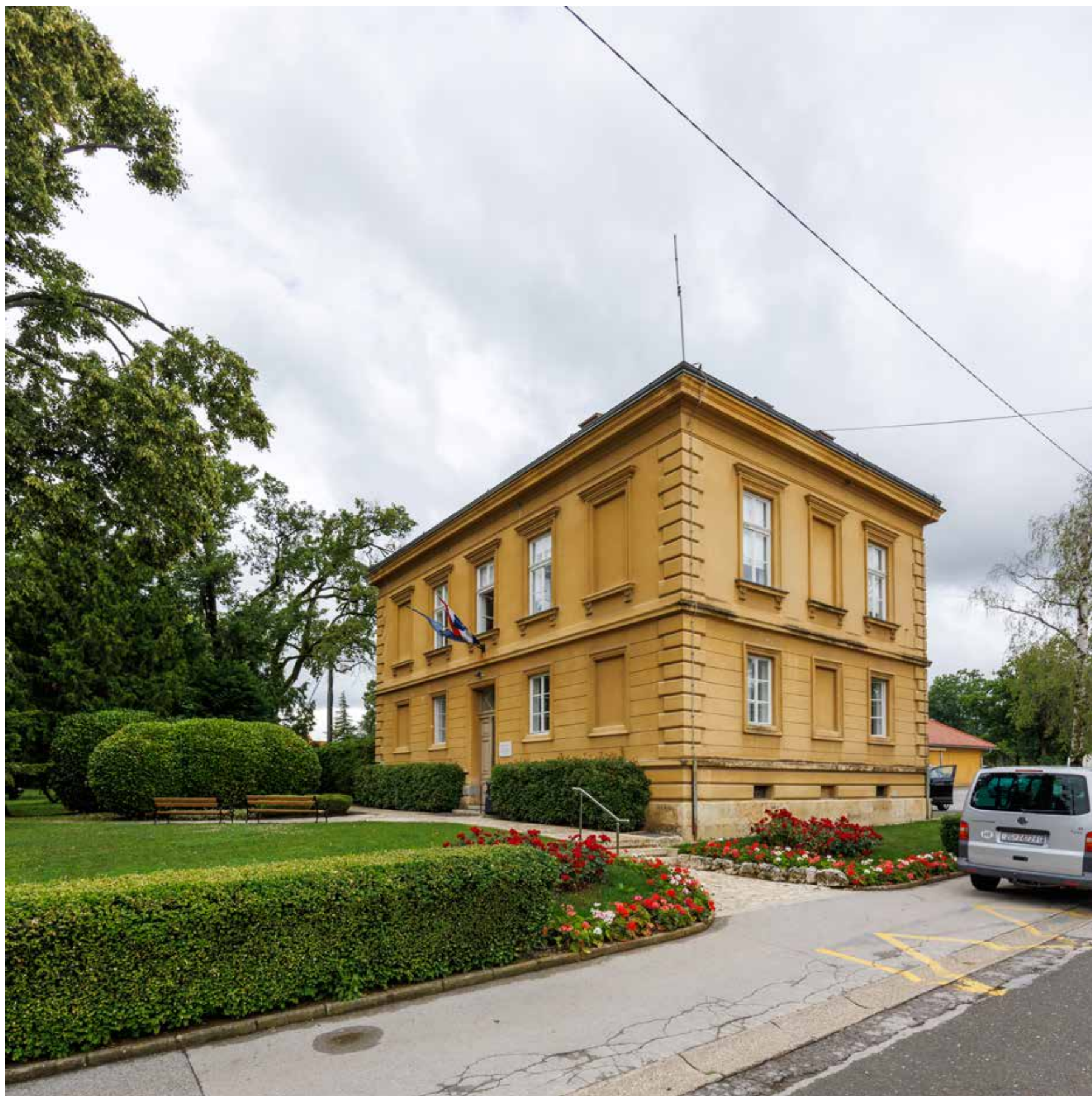
Upravna zgrada groblja Mirogoj
