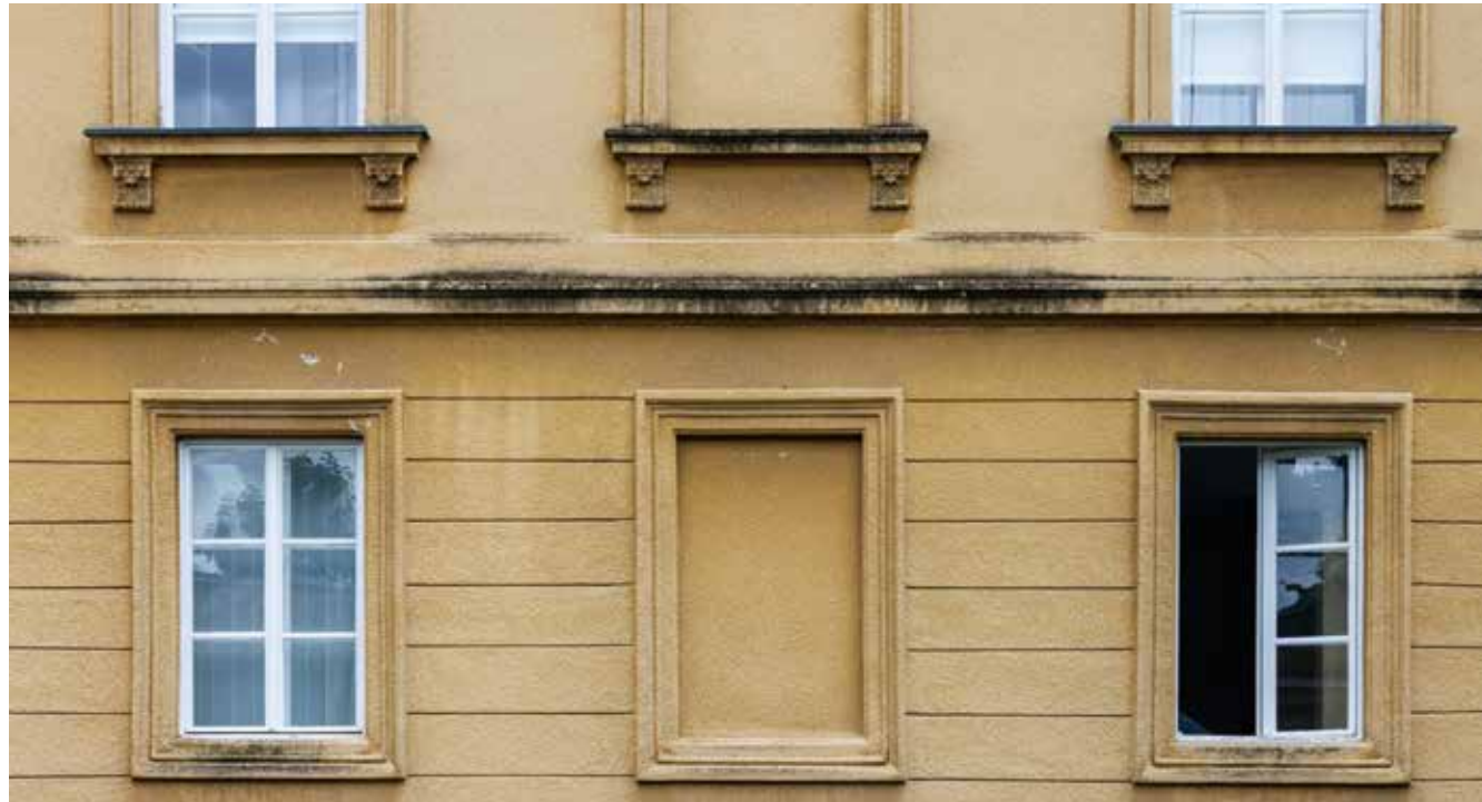
Prozori visokog prizemlja istočnog pročelja
