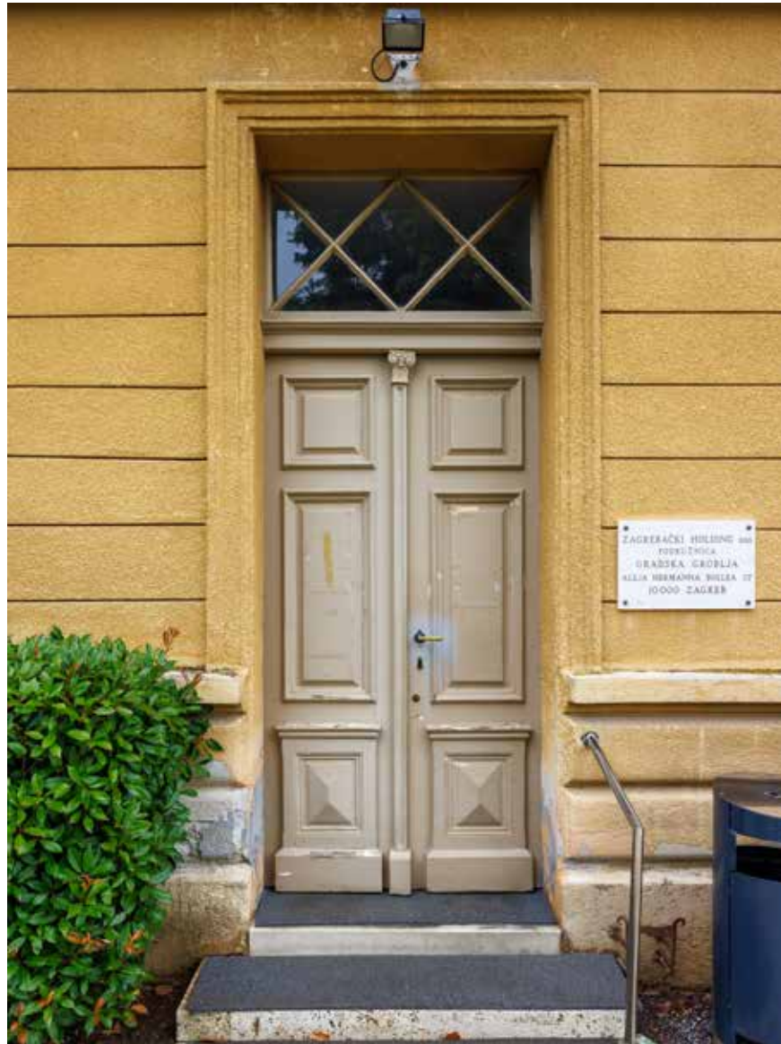
Ulazna vrata na glavnom pročelju
