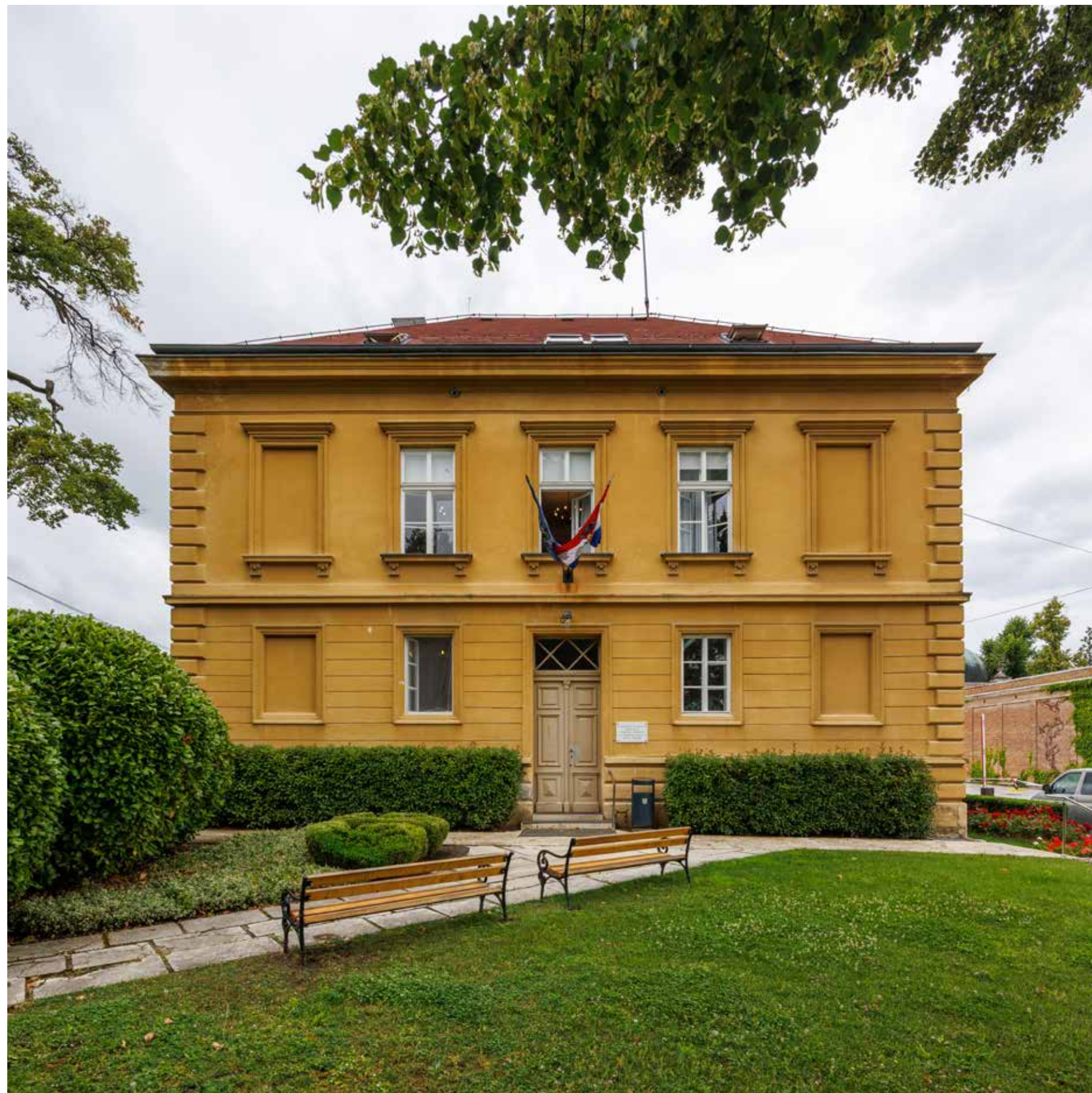
Južno, glavno pročelje
