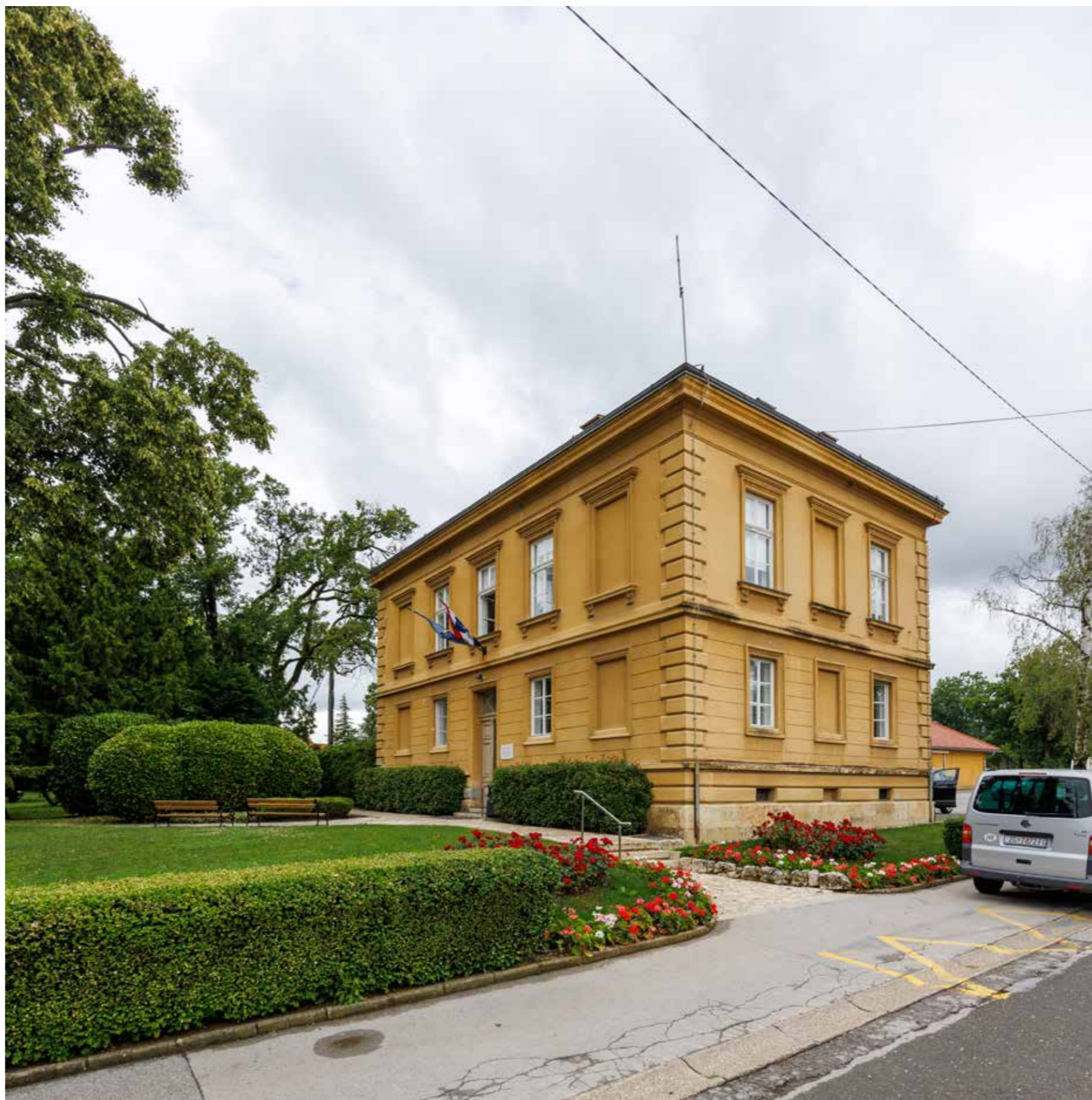
Upravna zgrada groblja Mirogoj
