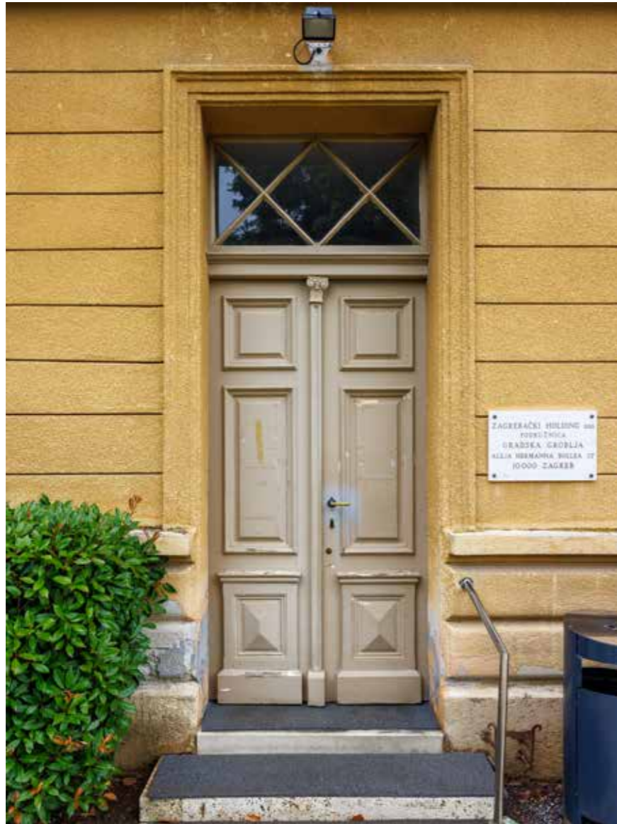
Ulazna vrata na glavnom pročelju
