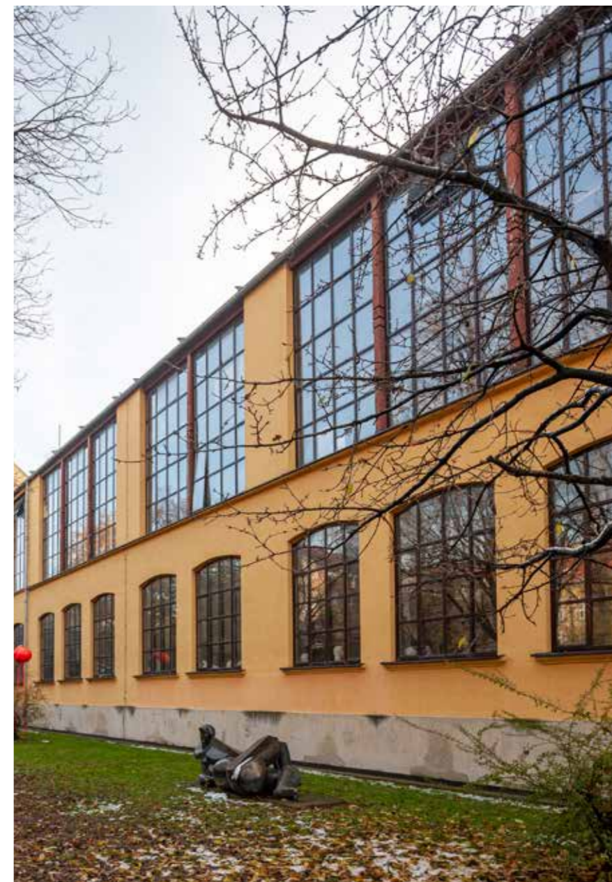
Akademija likovnih umjetnosti u Zagrebu, sjeverno pročelje, pogled na prvu zgradu Umjetničkih atelijera prema projektu Hermana Bolléa
