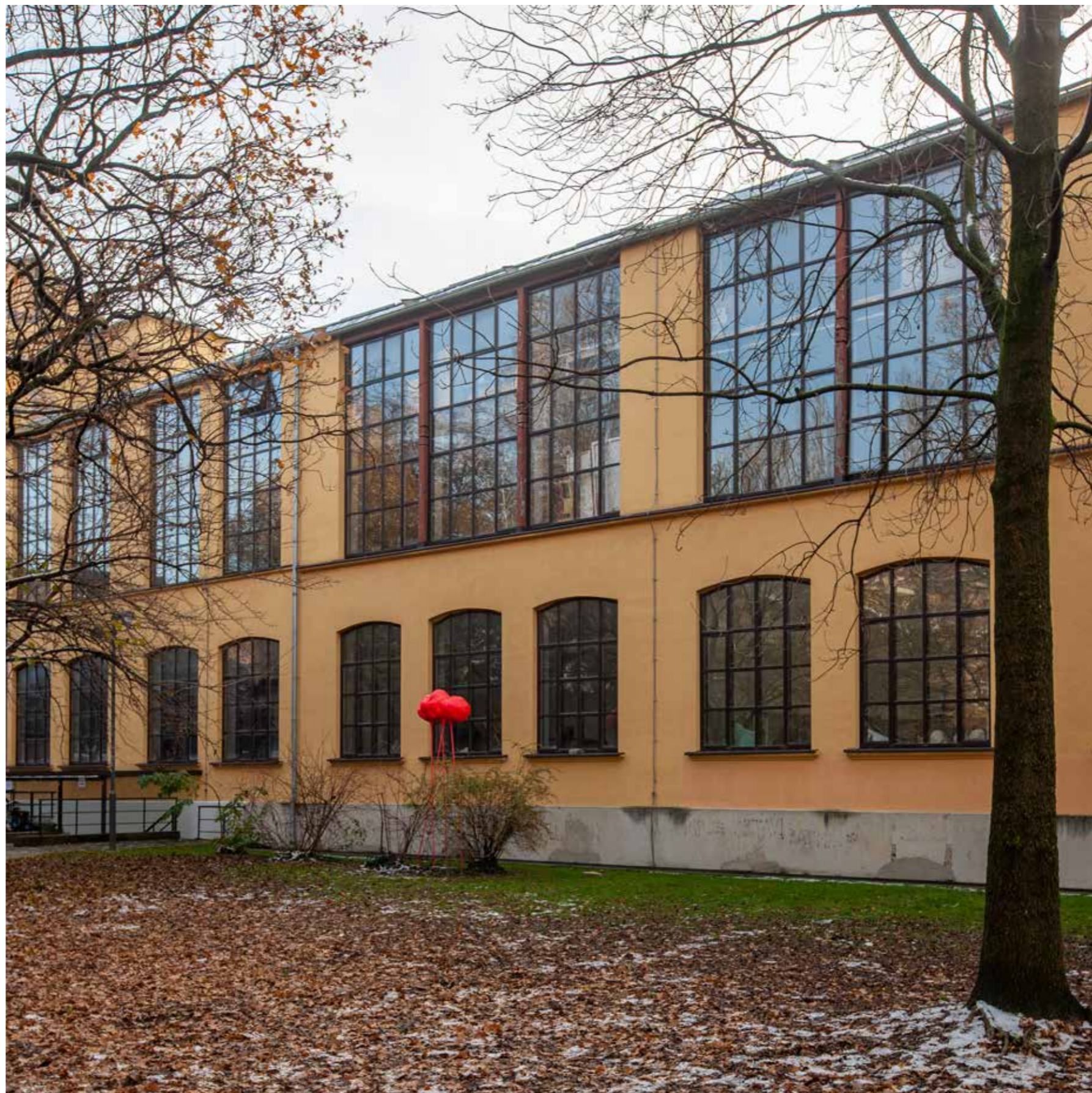
Spoj Bolléove i Grossove zgrade
