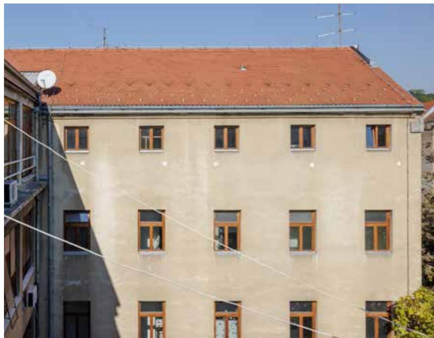
Južno pročelje Ivekovićeve zgrade
