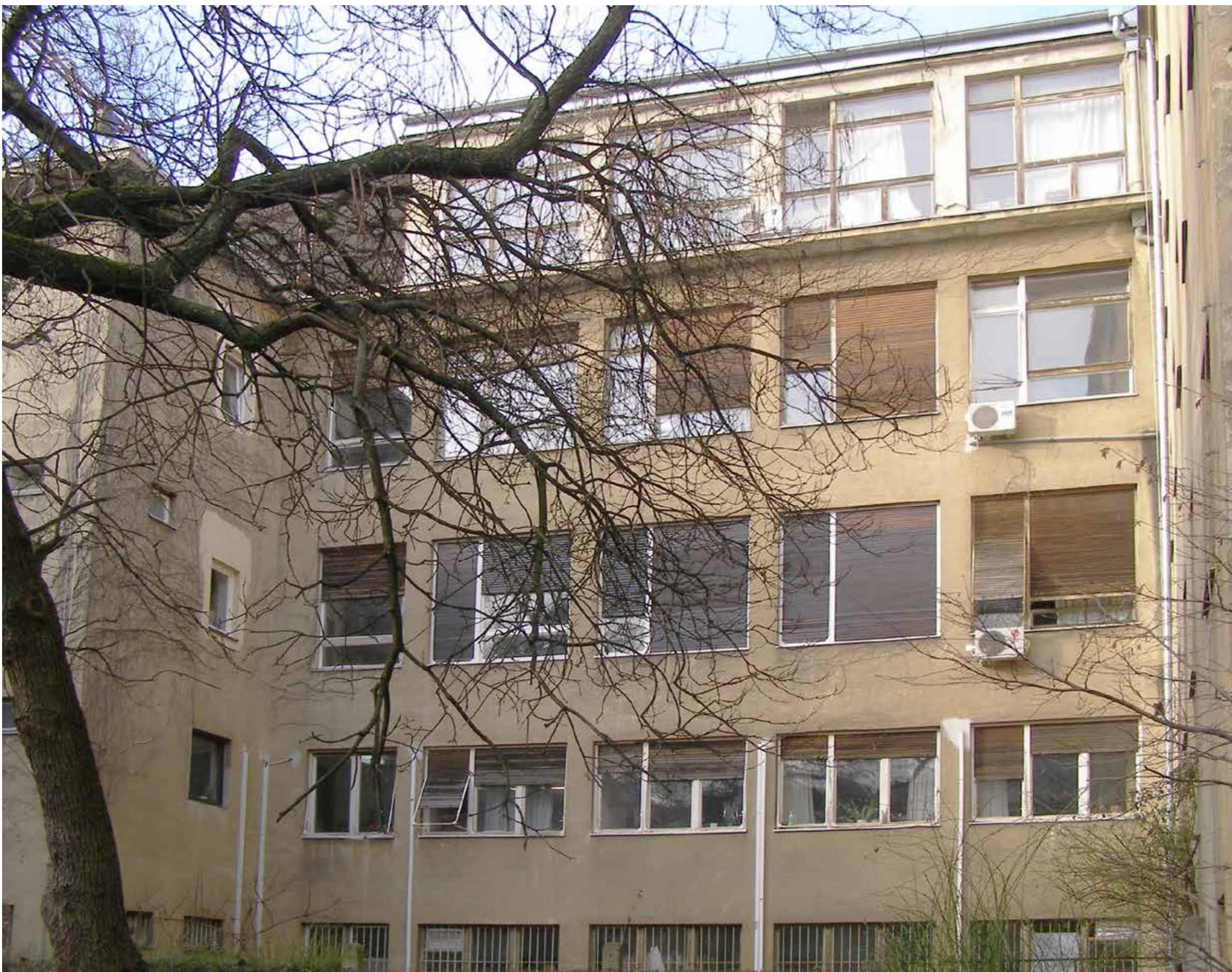
Istočno pročelje dogradnje prema projektu Ive Geršića, 1953.–1957.
