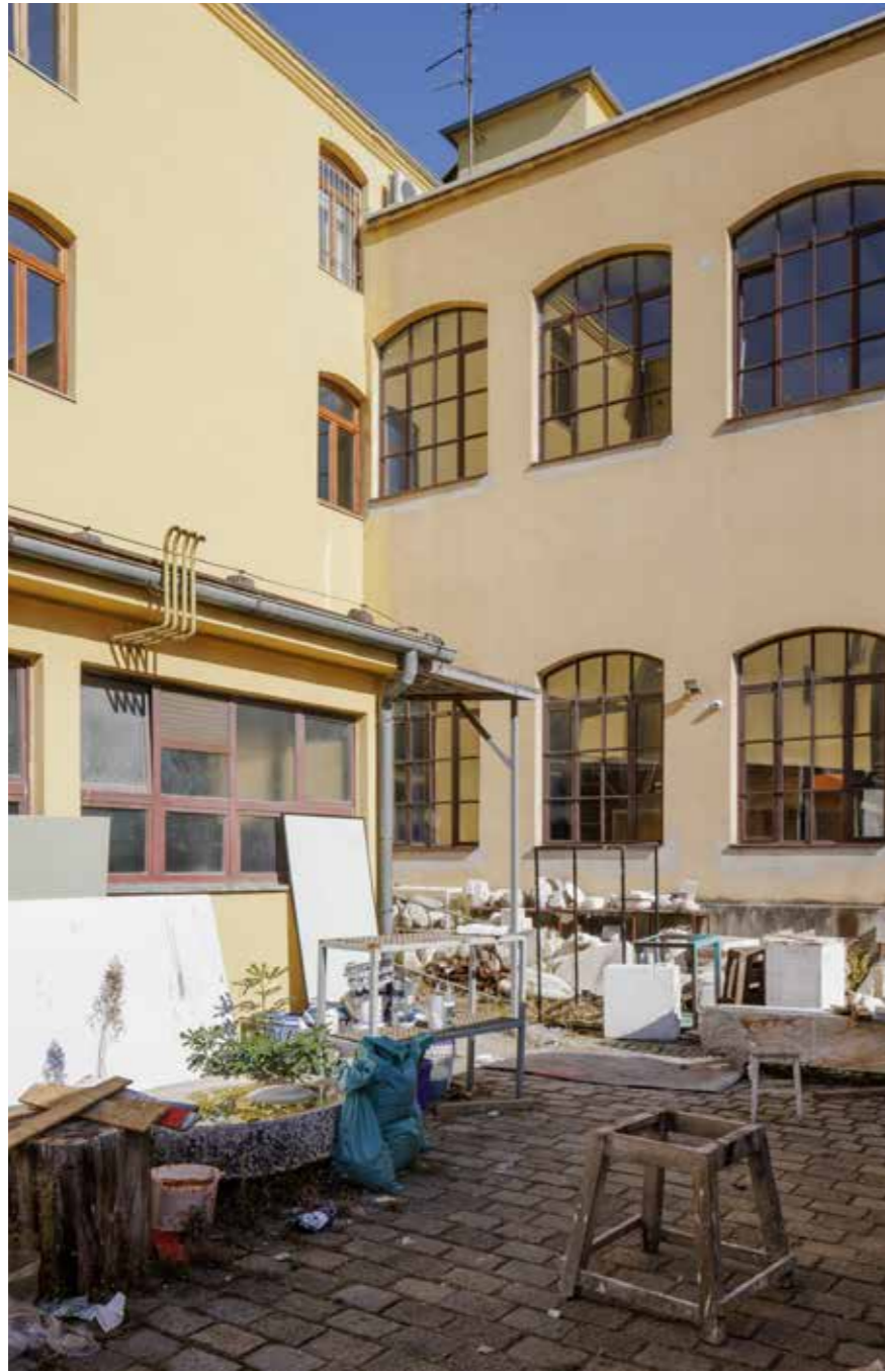
Spoj Grossove zgrade i južnog aneksa Pogled na prozore u atelijeru južnog aneksa Pogled na prozor u atelijeru Ivekovićeve zgrade
