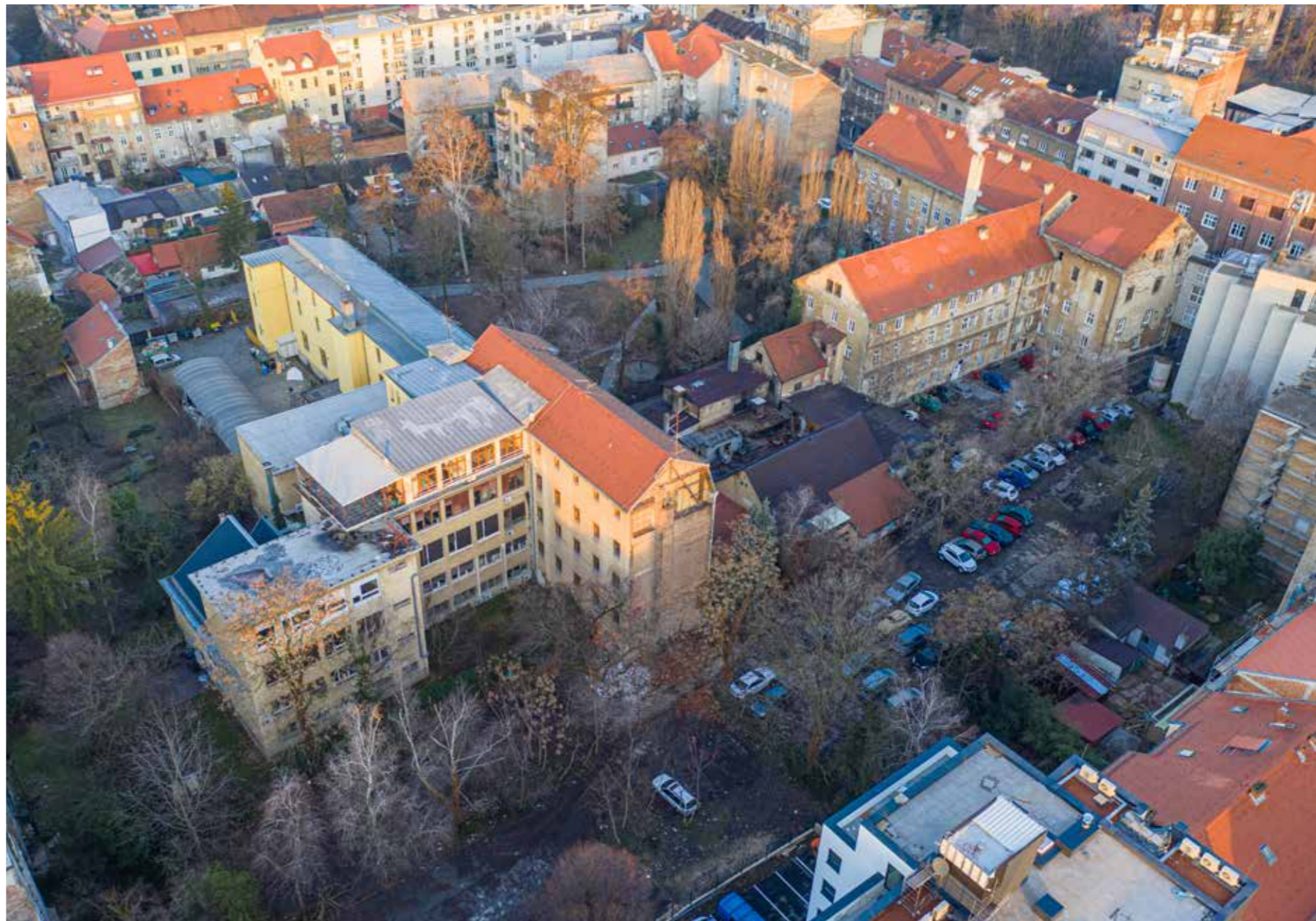
Pogled na jugoistočno pročelje Akademije likovnih umjetnosti u Zagrebu, 2020.
