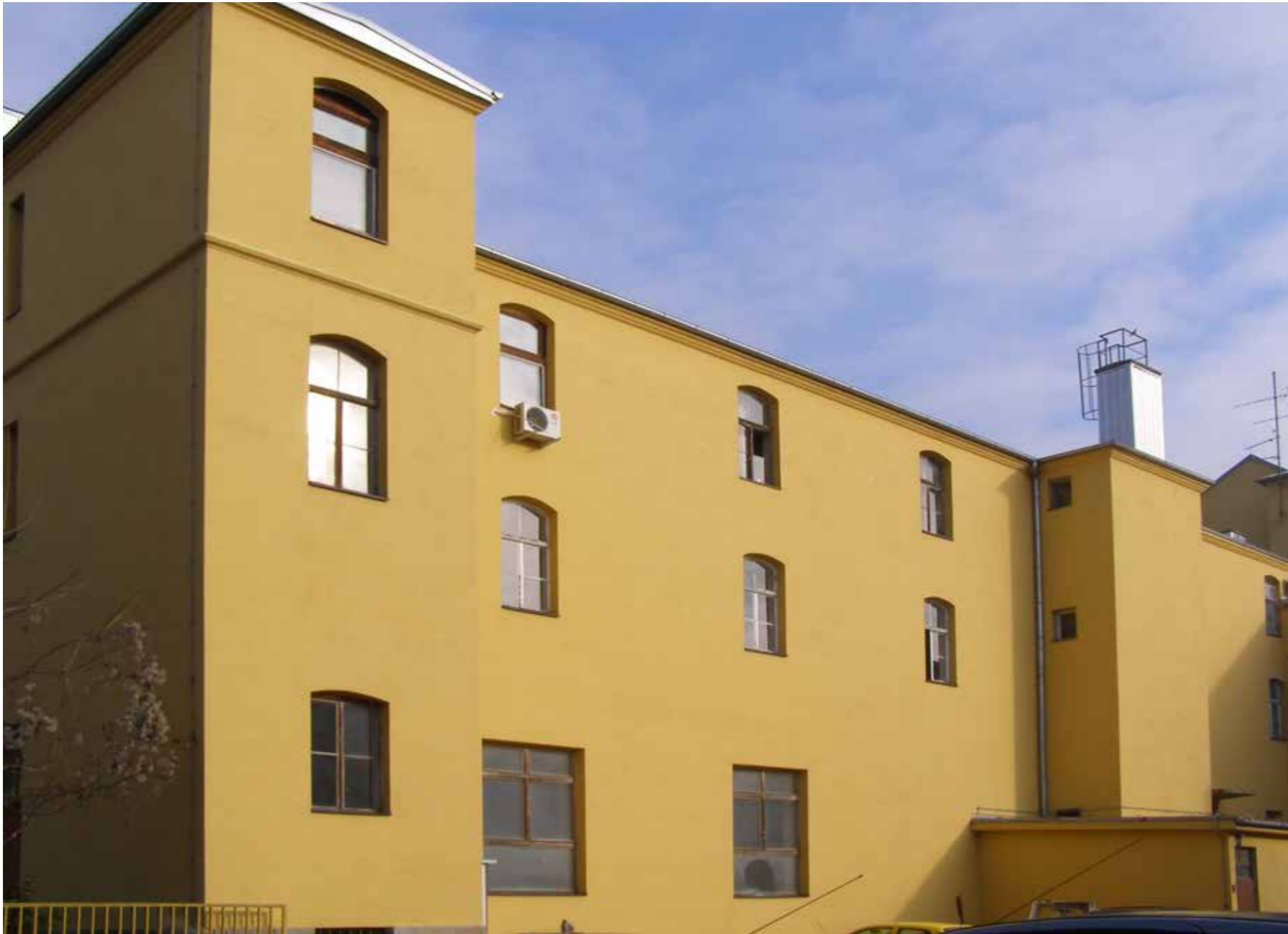
Akademija likovnih umjetnosti u Zagrebu, južno pročelje, pogled na prvu zgradu Umjetničkih atelijera prema projektu Hermana Bolléa
