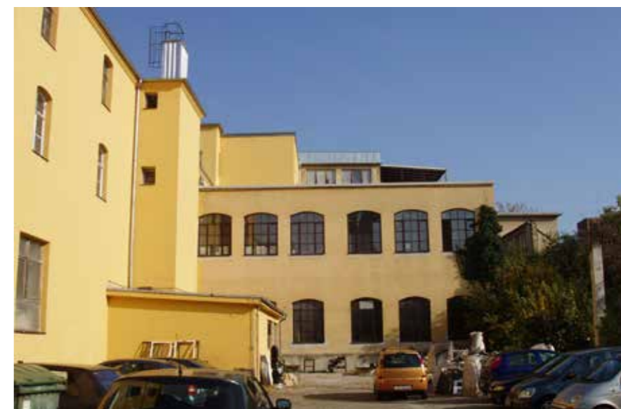
Južni aneks izgrađen 1908., stanje prije obnove 2010., Grad Zagreb, Gradski zavod za zaštitu spomenika kulture i prirode (foto: S. Novak)
