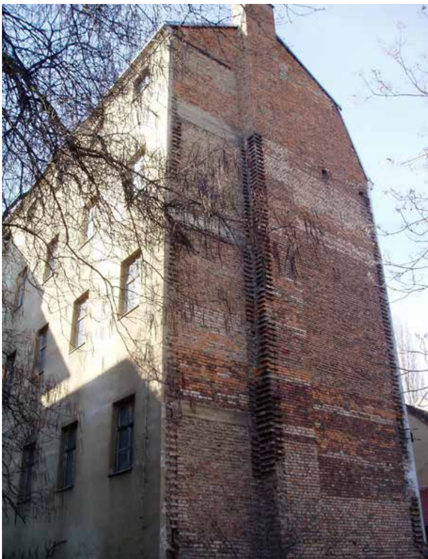
Istočno nedovršeno pročelje Ivekovićeve zgrade
