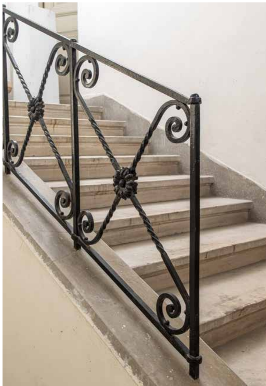
Ograda stepaništa na zapadnoj strani zgrade prema zamisli Hermana Bolléa
