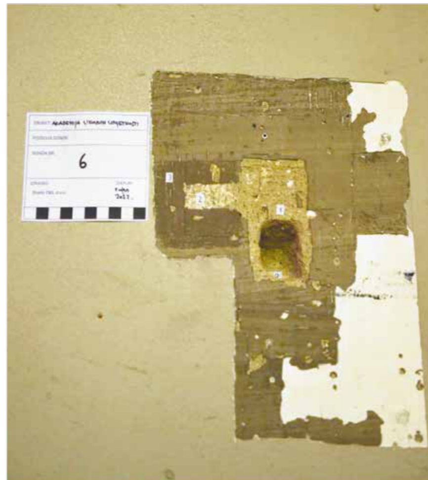
Sonda br.6 I kat, zapadno krilo, atelje, zid između ateljea i hodnika
