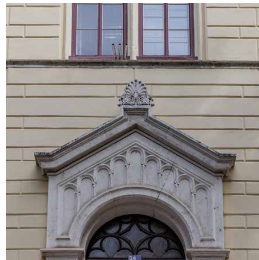
Detalj glavnog portala i bifora
