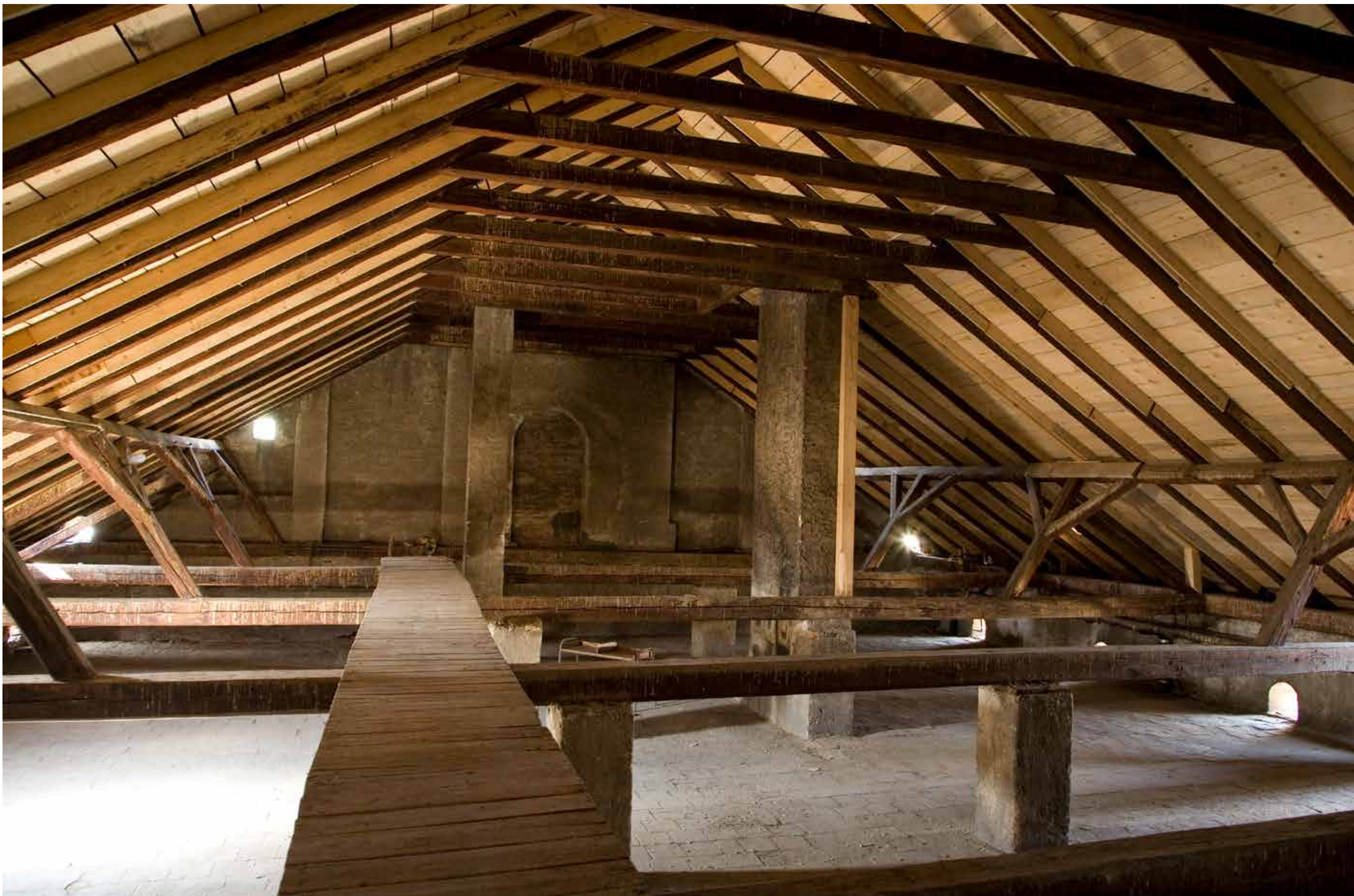
Krovište istočnog krila
