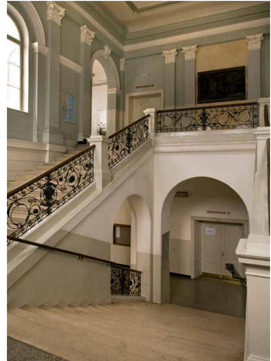
Glavno stubište prije obnove 2009., foto: Danilo Balaban, 2008.
