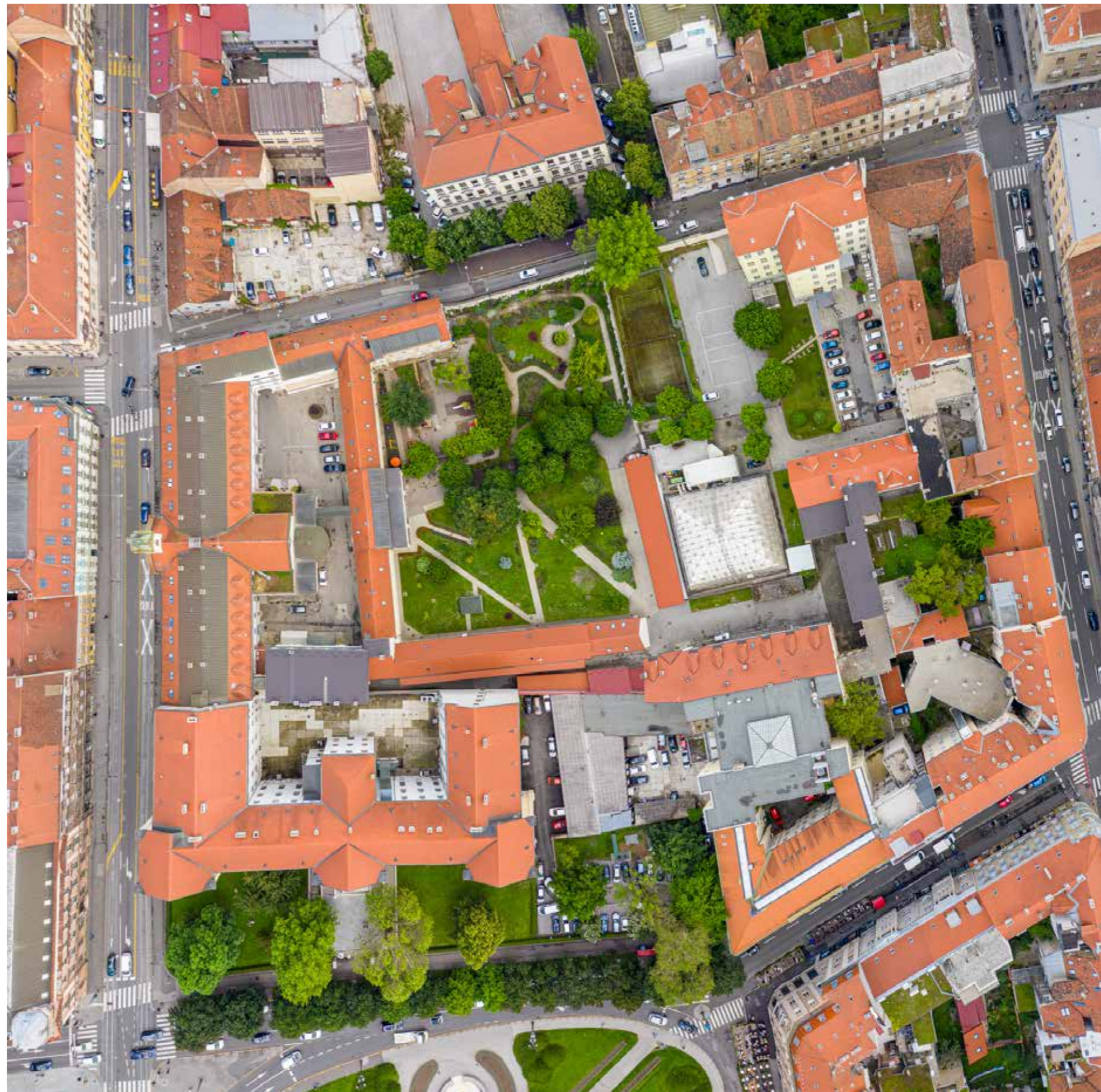
Blok između Gundulićeve, Varšavske, Frankopanske i Trga Republike Hrvatske sa zgradom Sveučilišta u jugozapadnom dijelu
