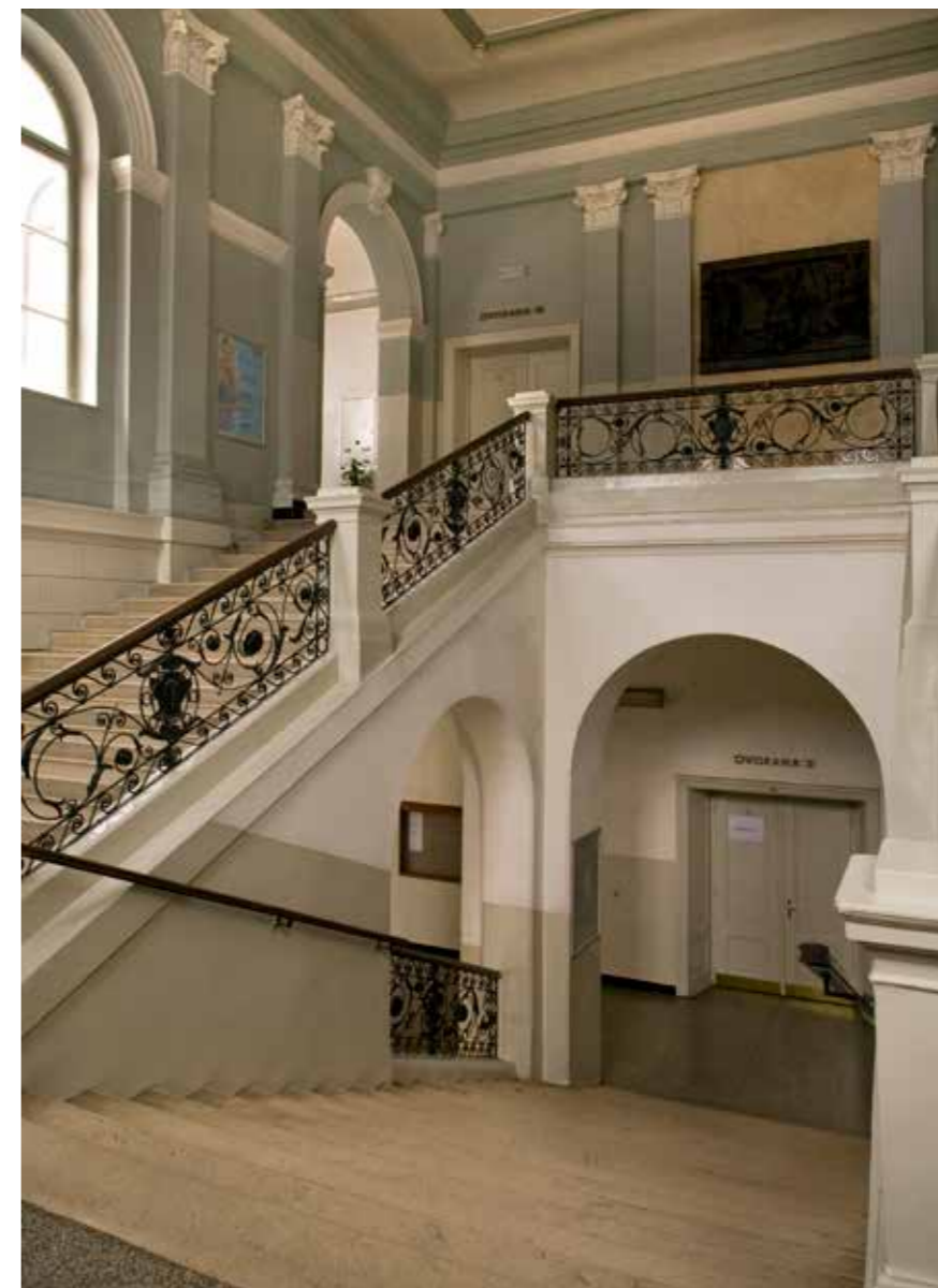
Glavno stubište prije obnove 2009., foto: Danilo Balaban, 2008.
