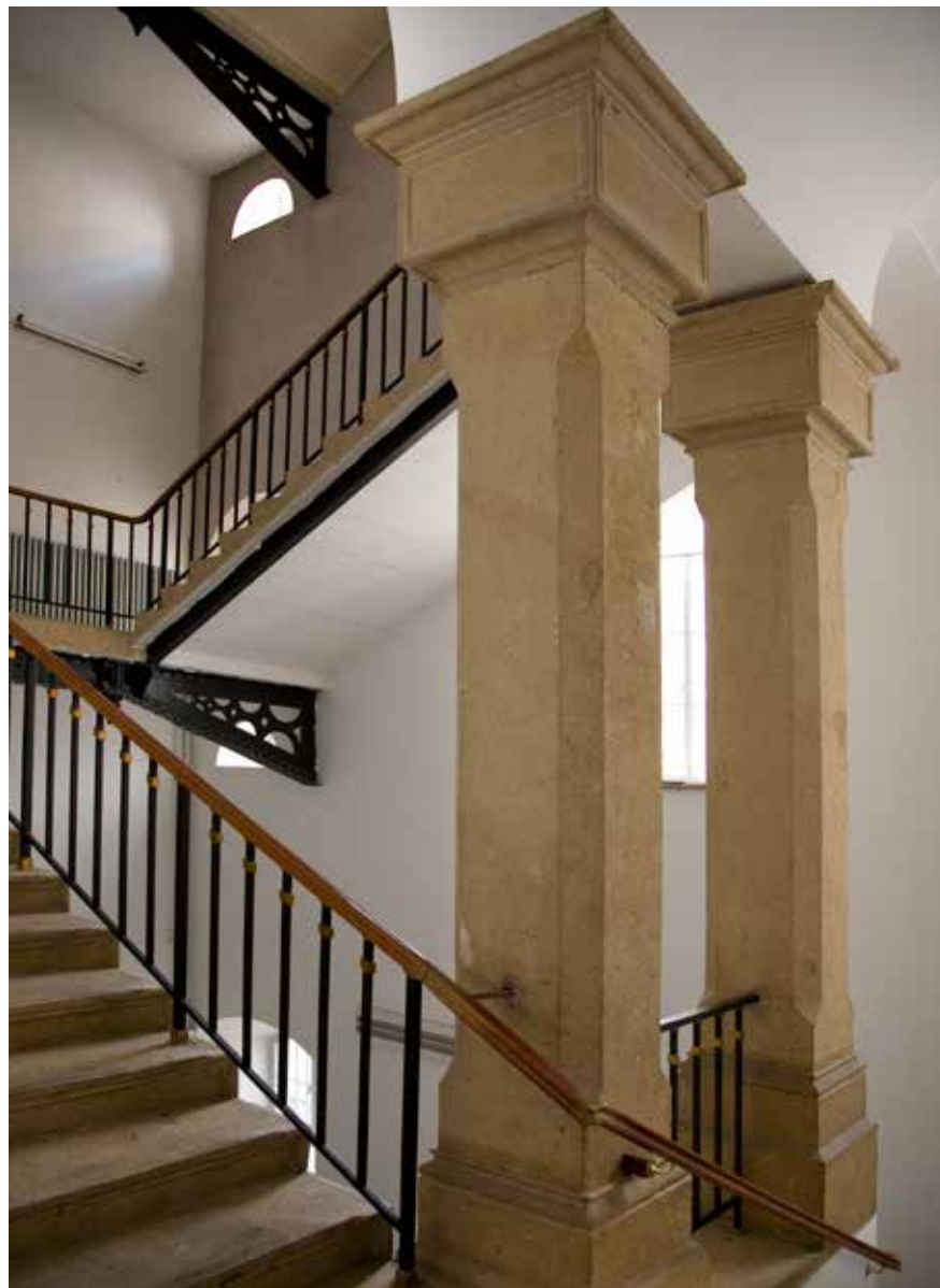
Bočno stubište prije obnove 2009., foto: Danilo Balaban, 2008.
