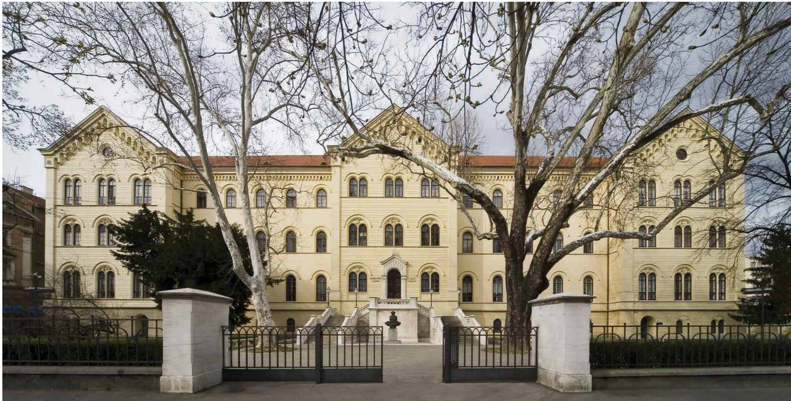
Južno pročelje, foto: Filip Beusan, 2008.
