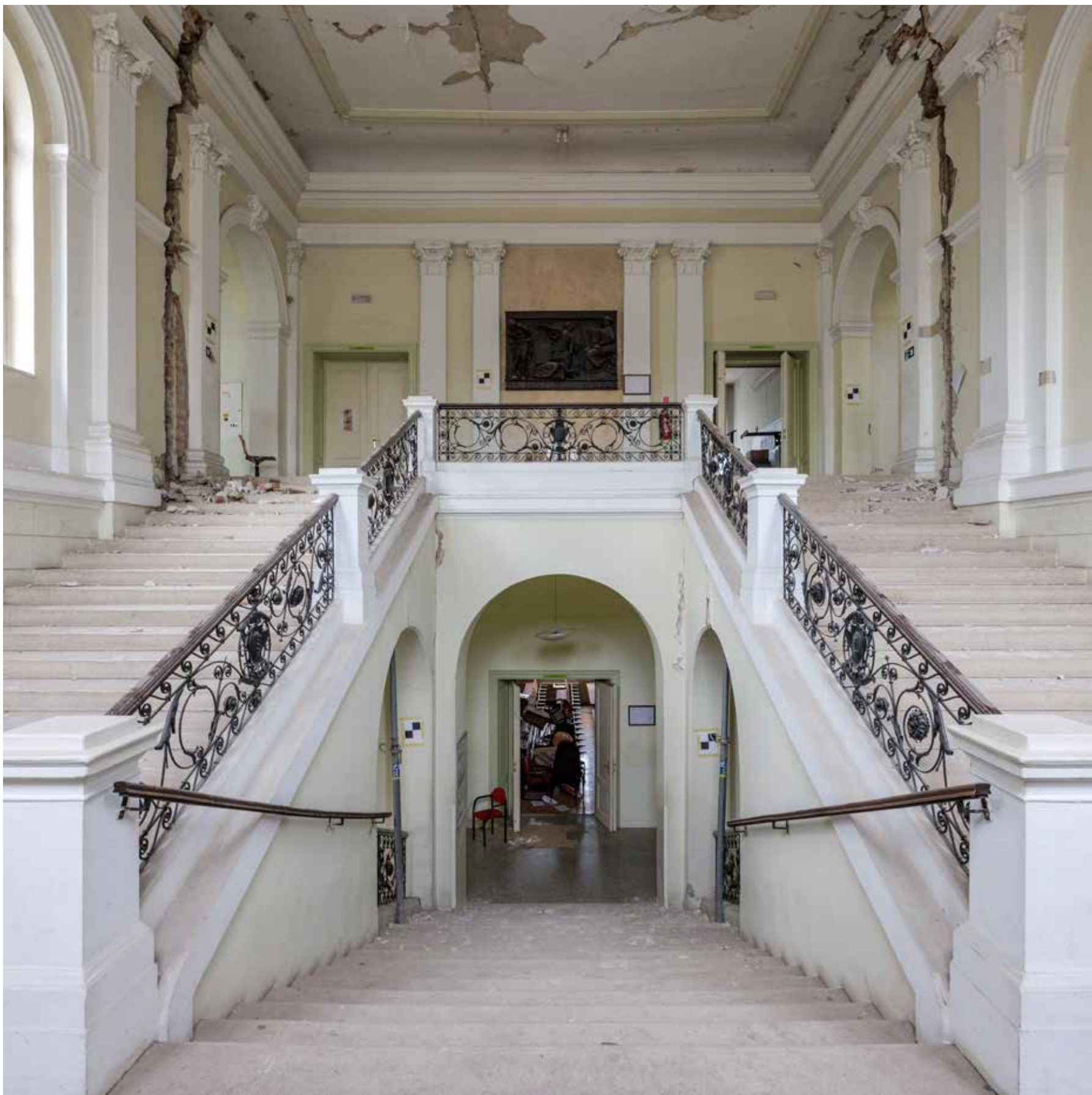
Glavno stubište, dio između prvog i drugog kata
