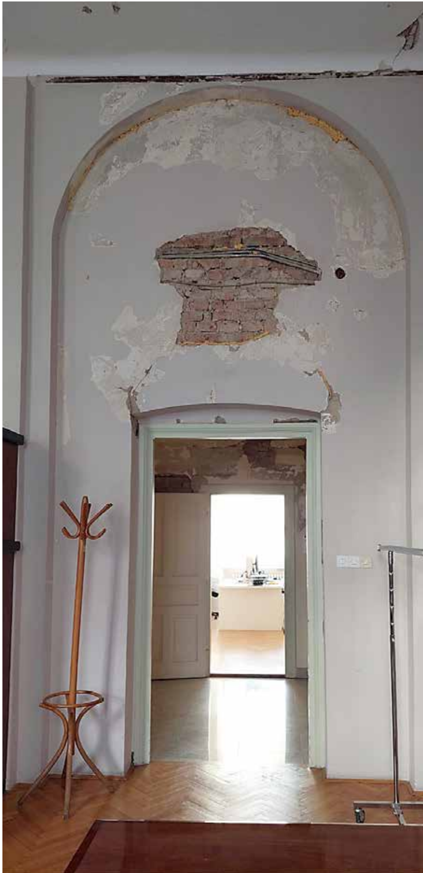
Zazidani luk prema nekadašnjem bočnom stubištu u istočnom krilu
