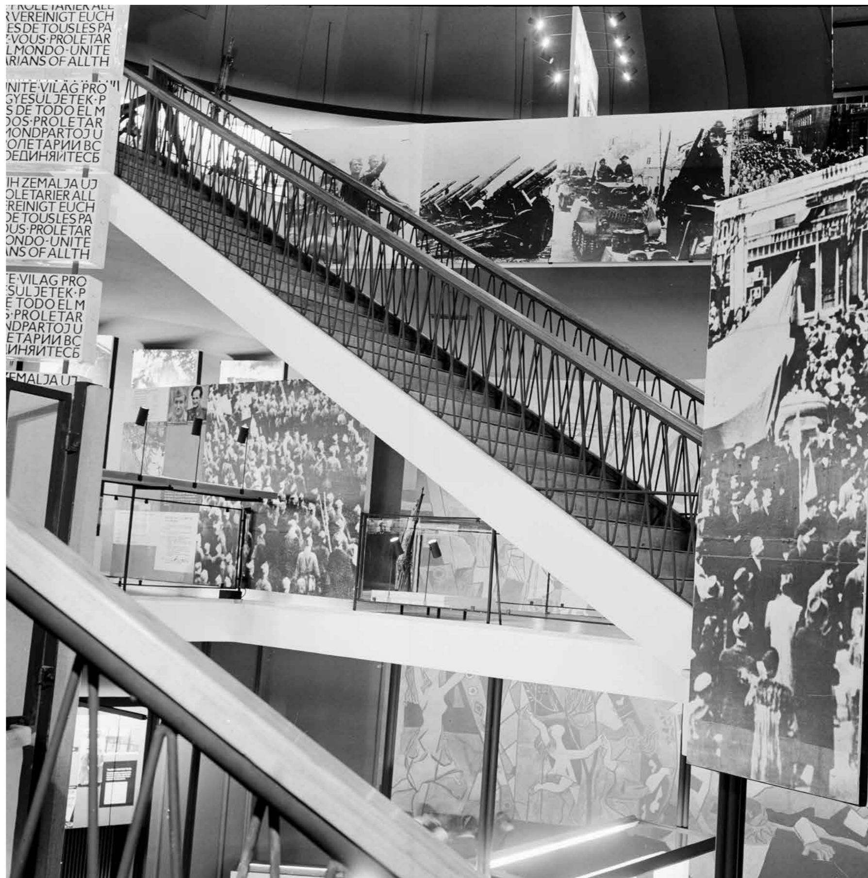
Montažne stepenice prema nacrtu Vjenceslava Richtera, HDA
