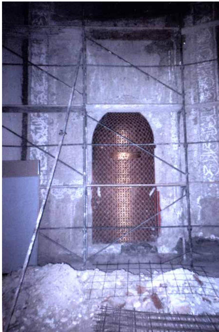
Mihrab prilikom demontaže i uklanjanja, 2003., GZZSKP
