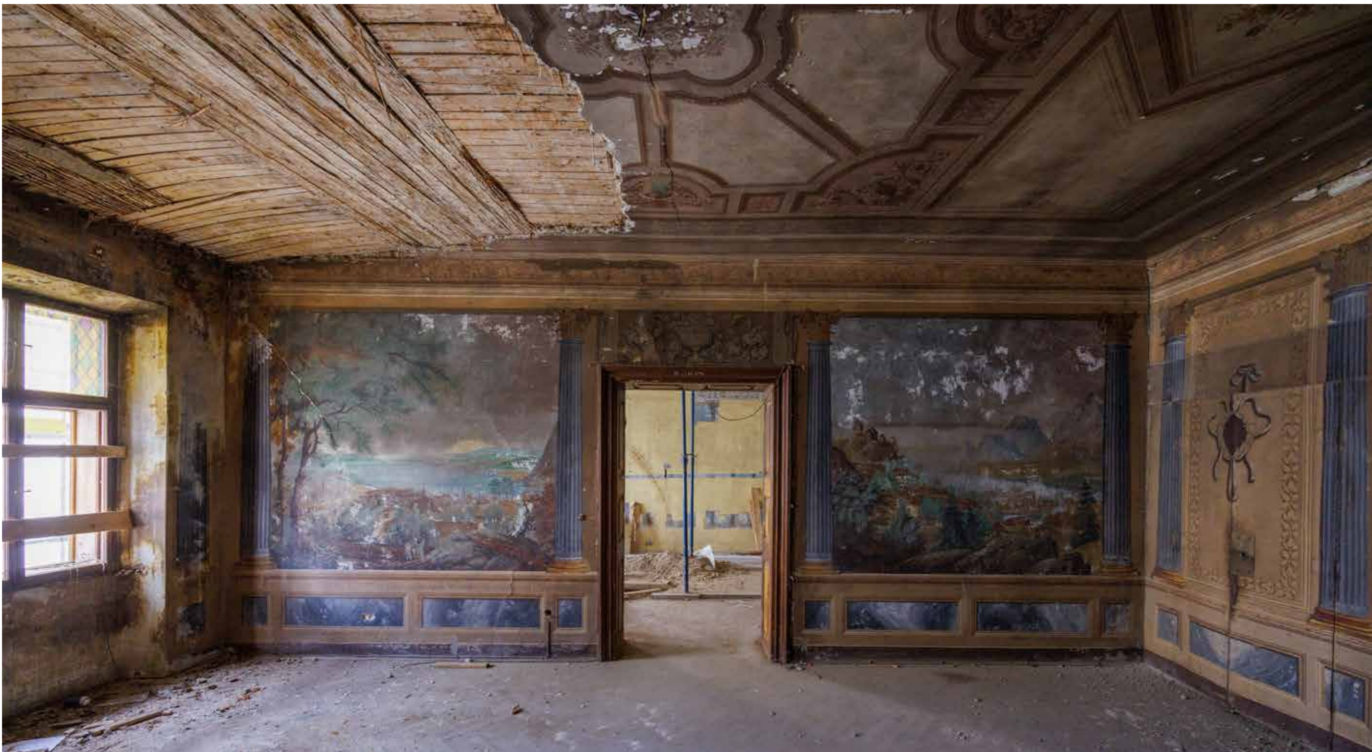
Prostorije na katu sa zidnim slikama
