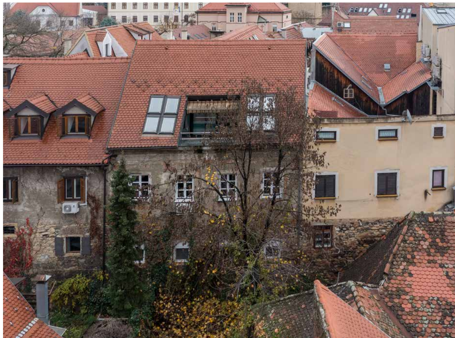
Zapadno začelje na gradskom zidu
