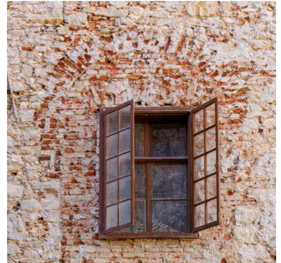
Detalj zazidanoga lučnog otvora trijema na katu
