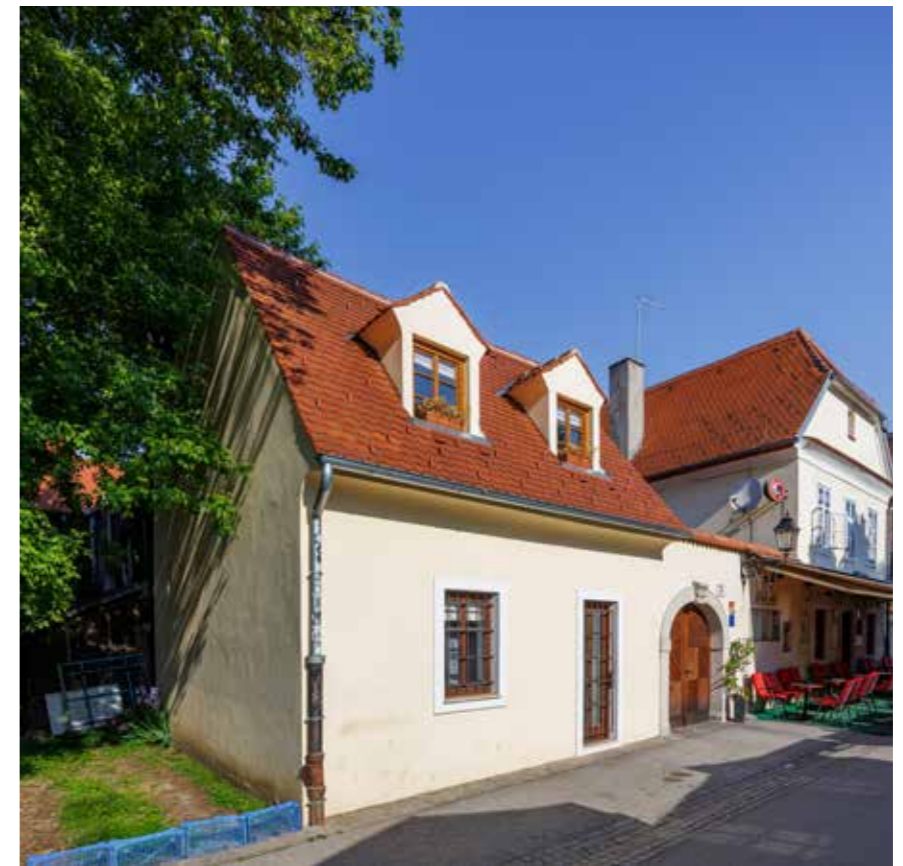
Istočno pročelje bočnog krila
