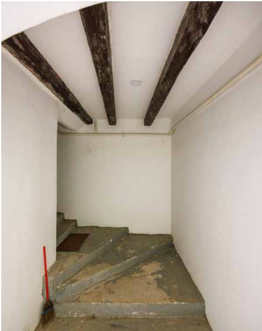
Svod u prizemlju Stubište
