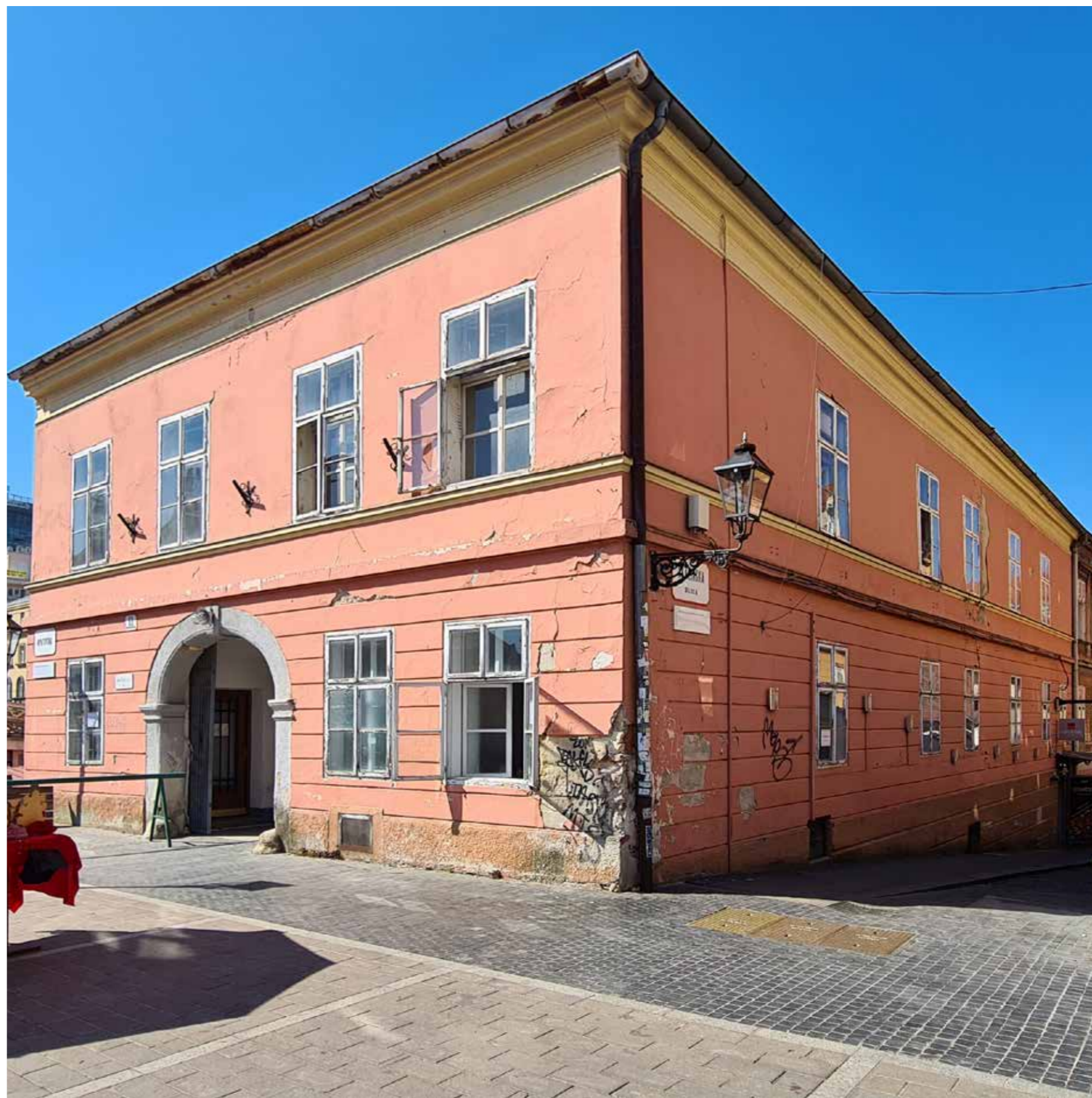
Istočno i sjeverno pročelje
