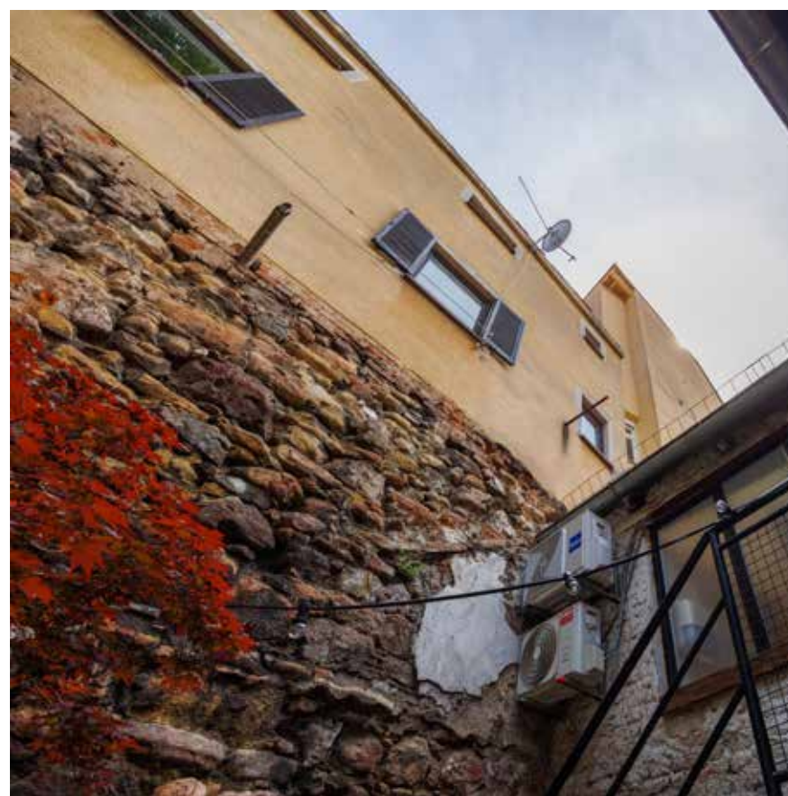
Gradski zid i začelje kuće (kbr. 15)
