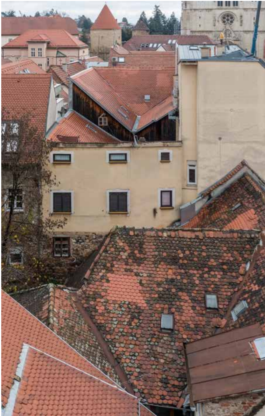
Zapadno začelje na gradskom zidu
