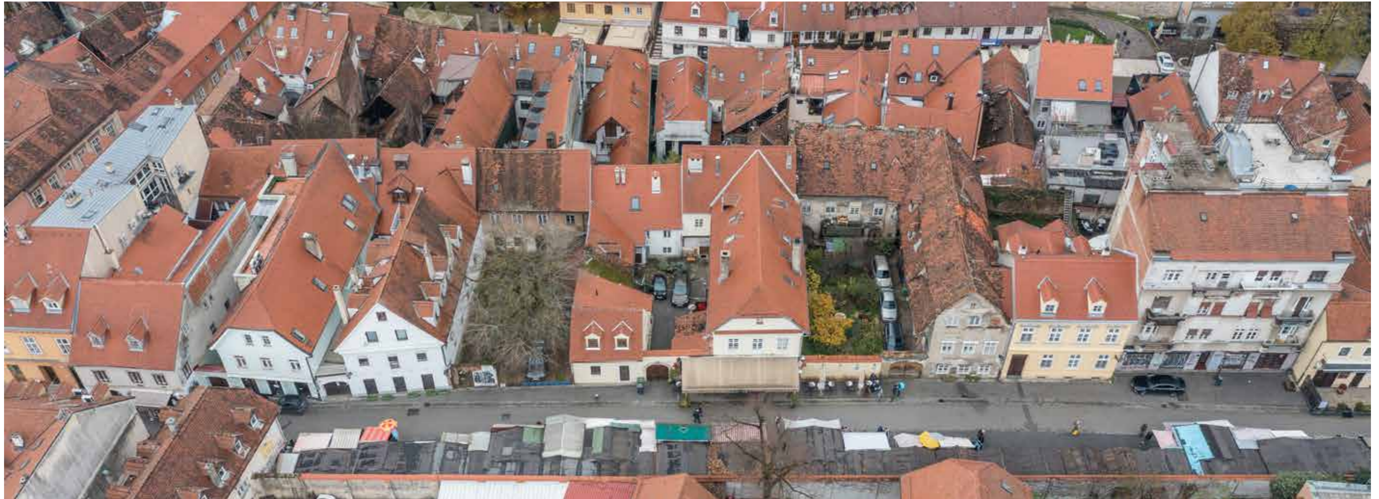
Opatovina, pogled s istoka (kbr. 15–29)
