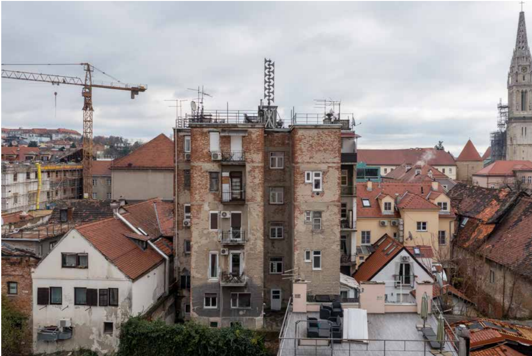
Zapadno začelje poviše gradskog zida
