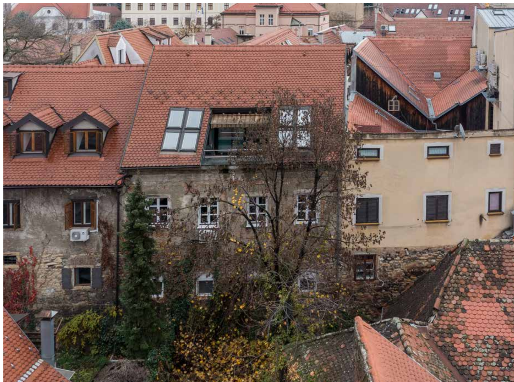
Zapadno začelje na gradskom zidu
