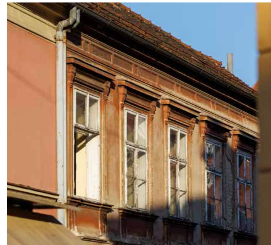
Sjeverno pročelje, dograđeno krilo
