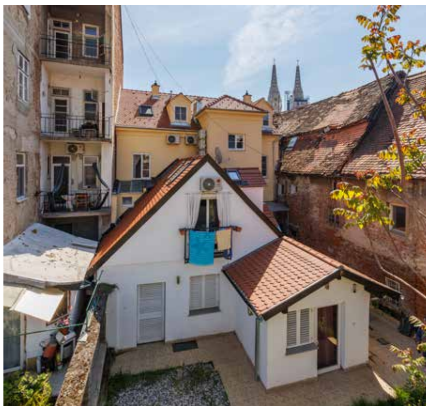
Zapadno začelje Dvorišna kuća
