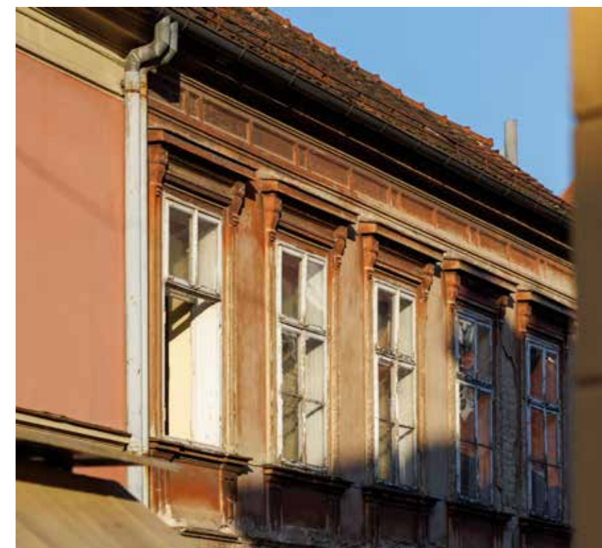
Sjeverno pročelje, dograđeno krilo
