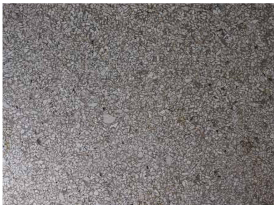
Popločenje poda u stubištu, detalji
