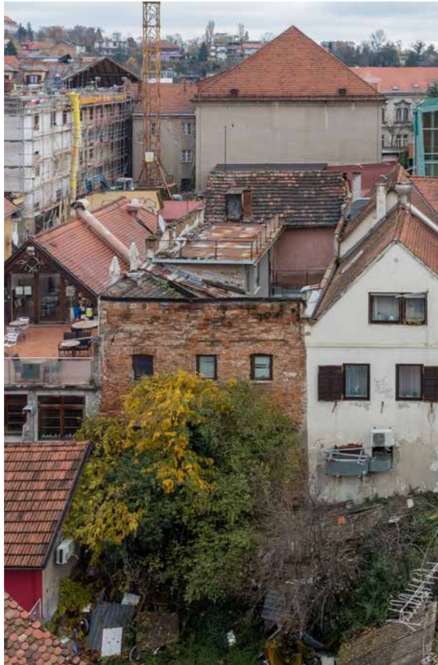
Zapadno začelje na gradskom zidu
