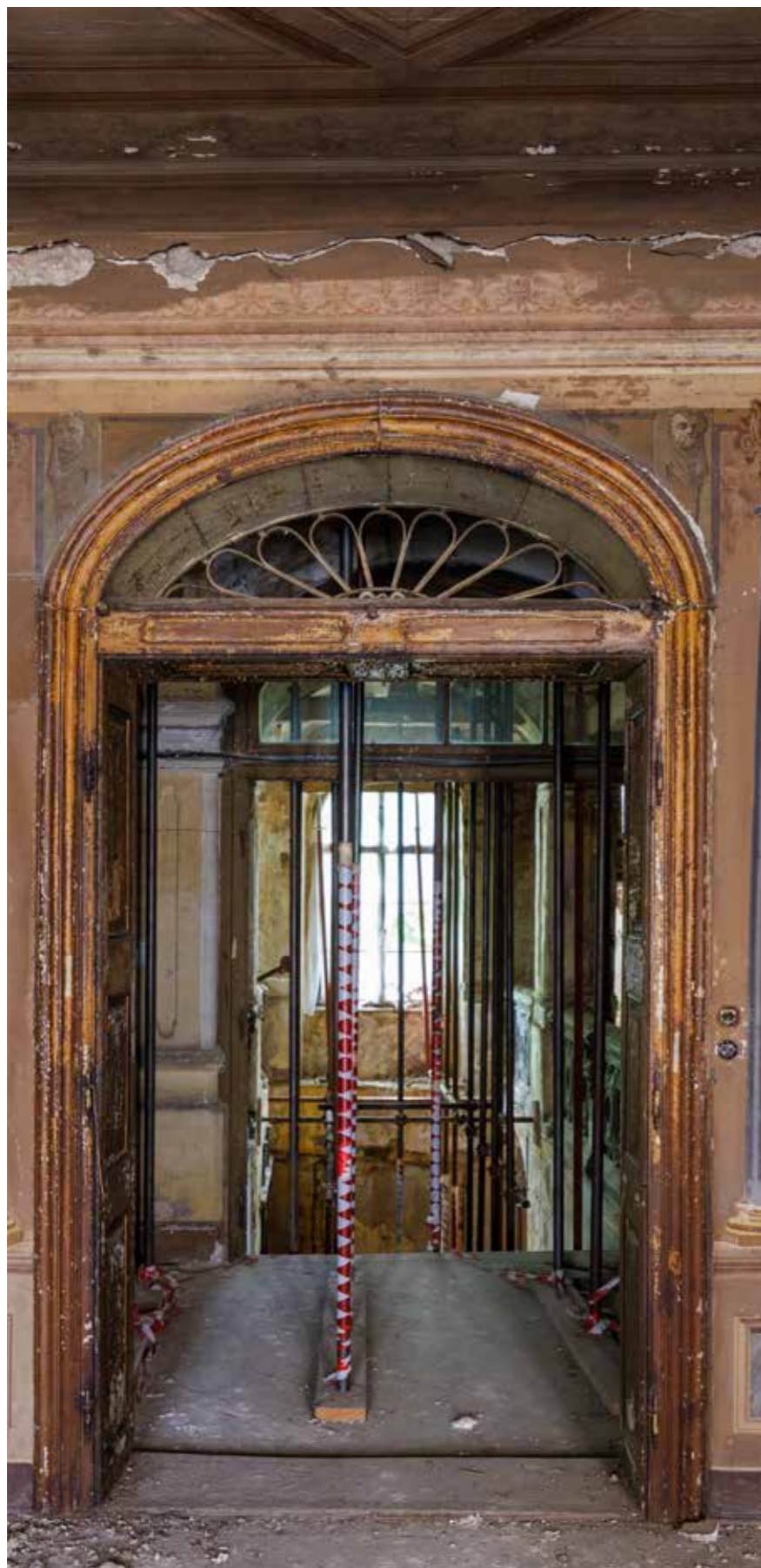
Vrata prema stubištu
