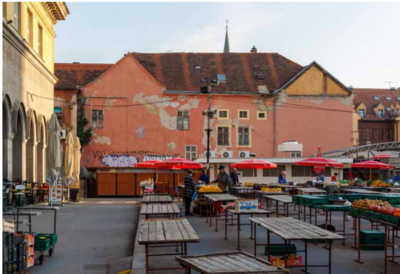
Južno pročelje (oslobođeno rušenjem kuća na Dolcu 1925.)
