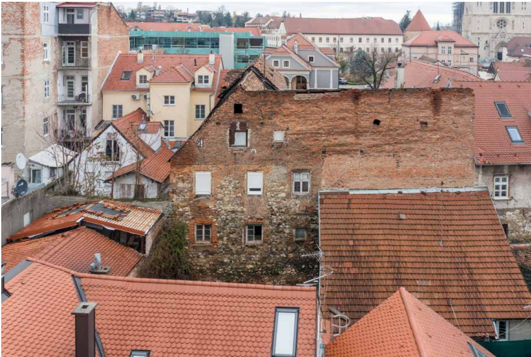
Zapadno začelje na gradskom zidu
