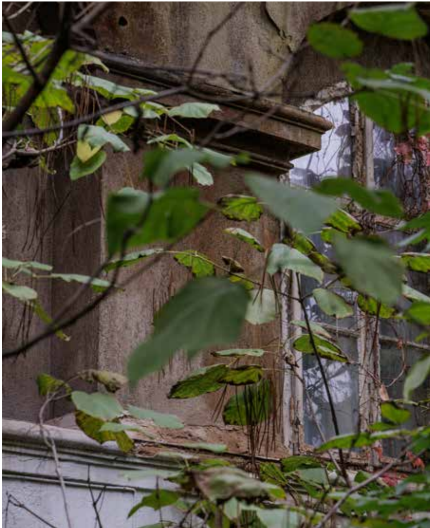
Trijem na dvorišnom pročelju, detalj
