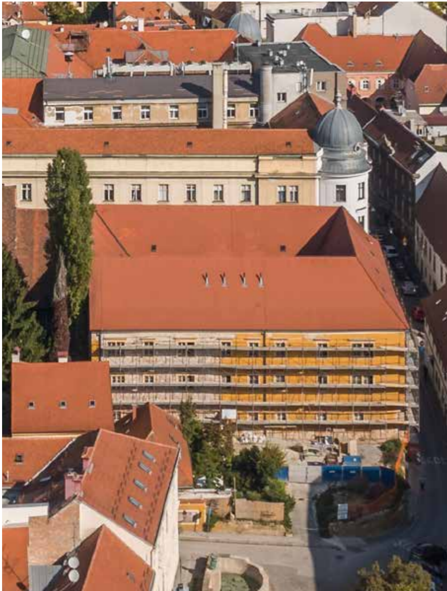
Pogled na dvorišnu kuću
