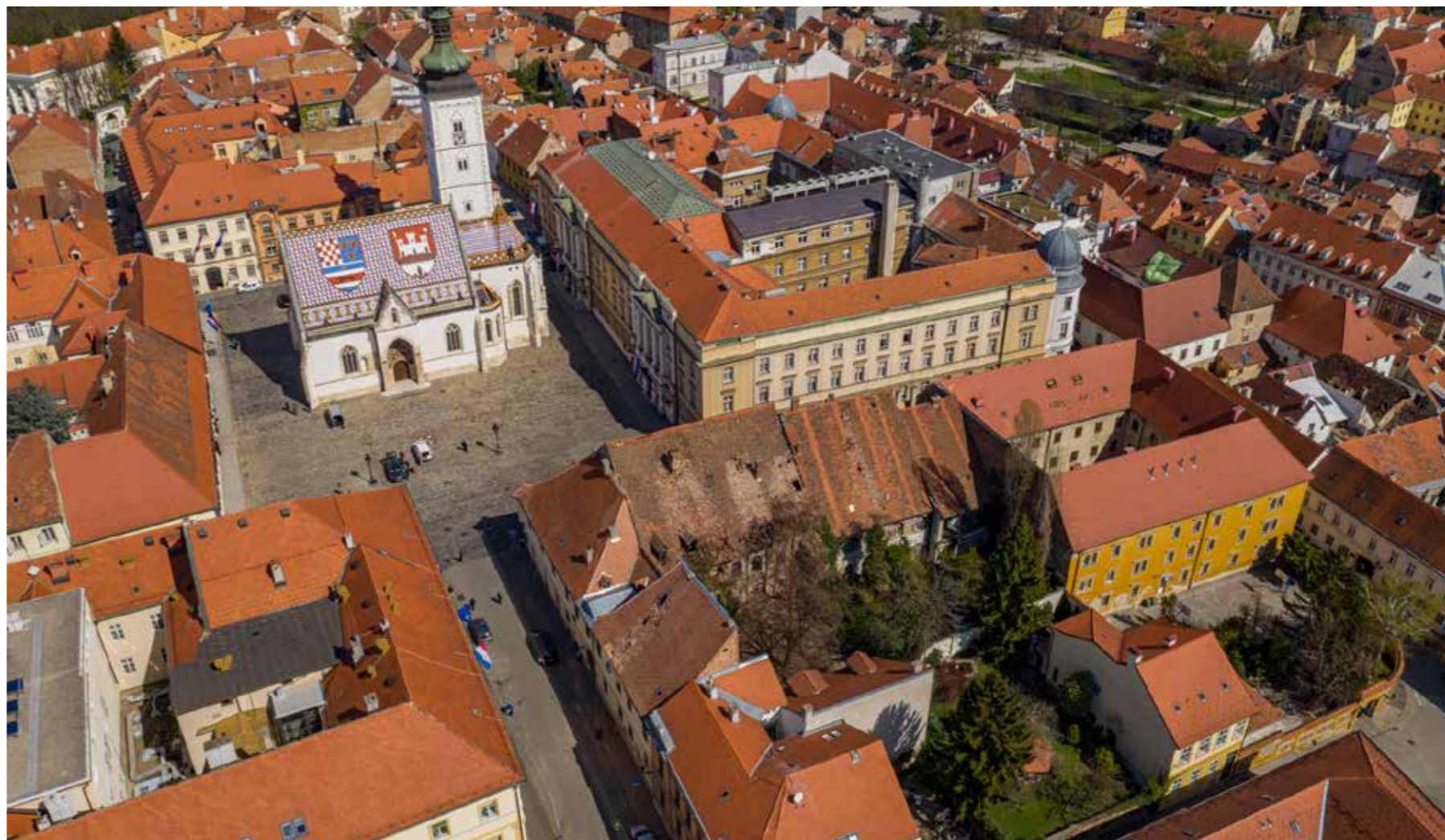
Blok 11, pogled s jugozapada
