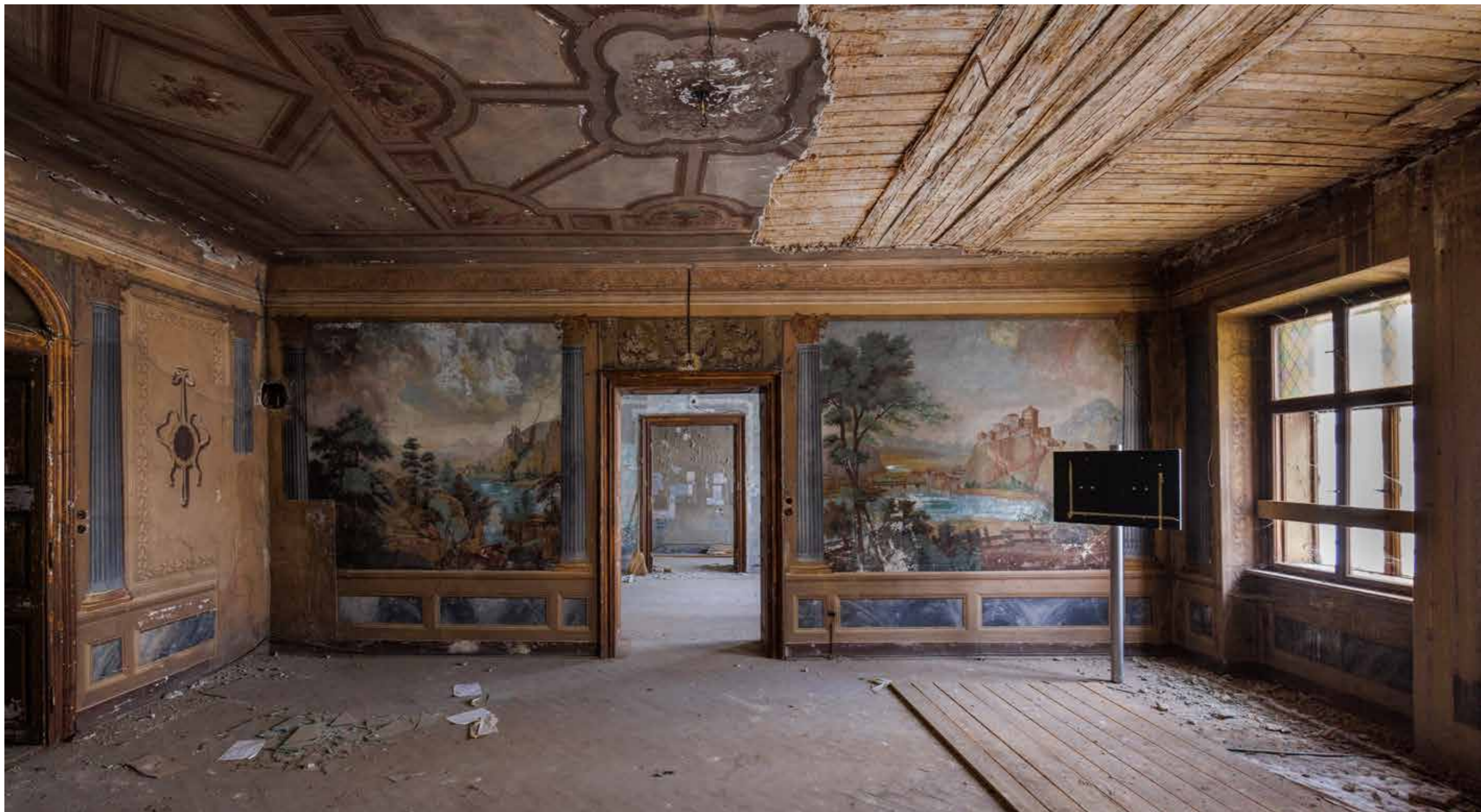
Prostorije na katu sa zidnim slikama
