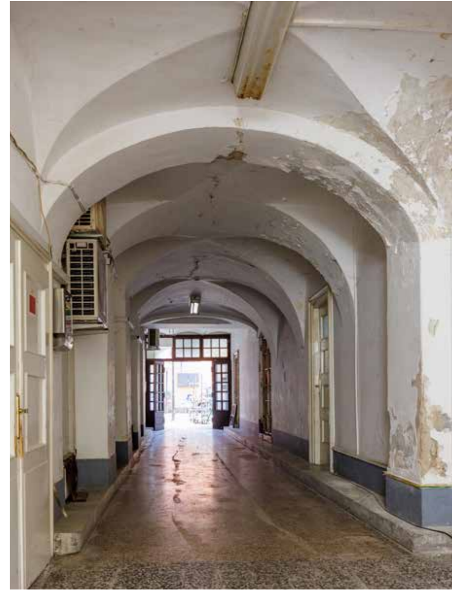
Kuća Miletić, veža
