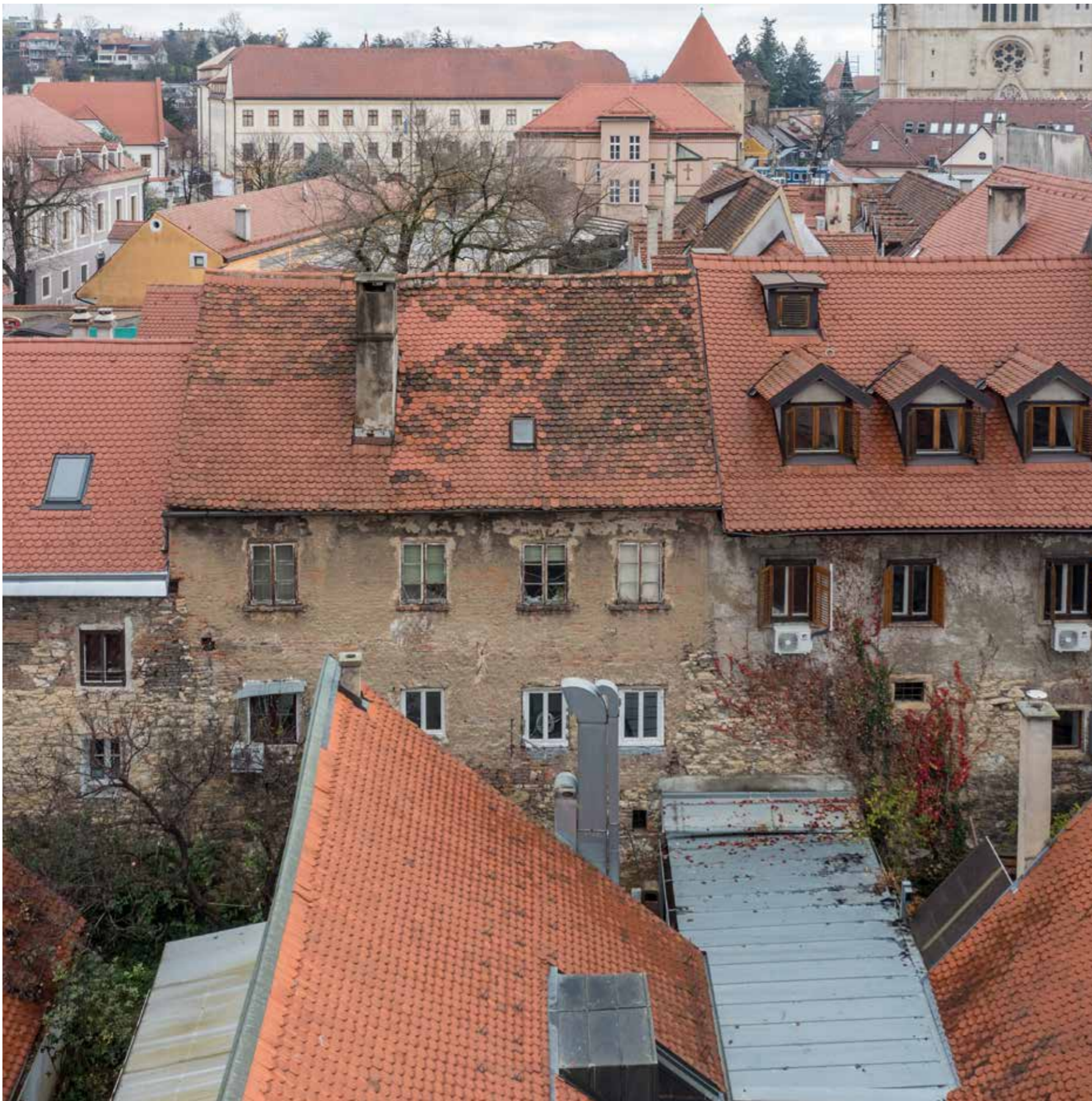
Zapadno začelje na gradskom zidu
