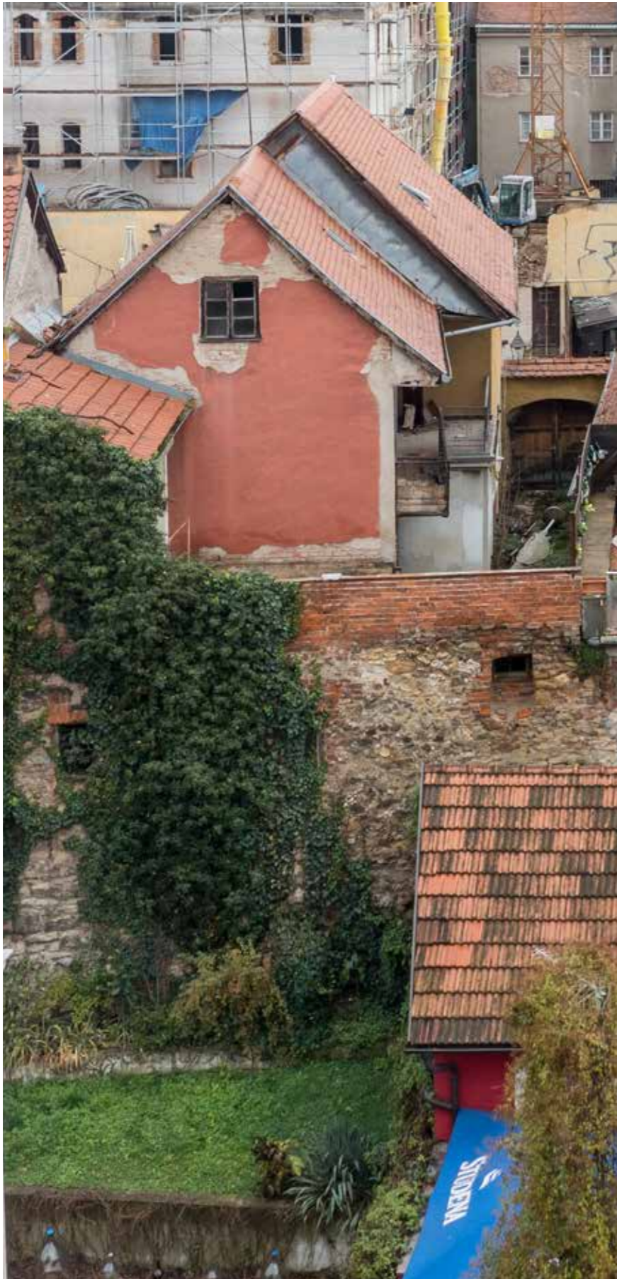
Zapadno začelje na gradskom zidu
