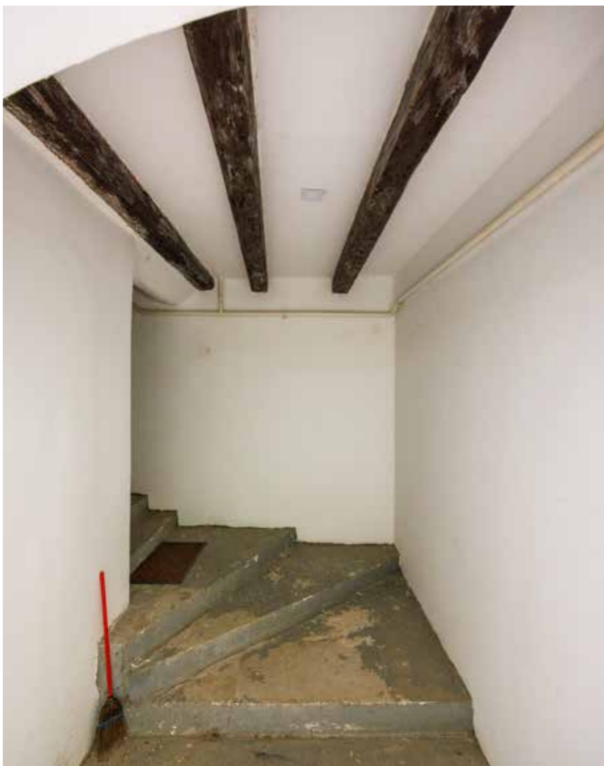
Svod u prizemlju Stubište
