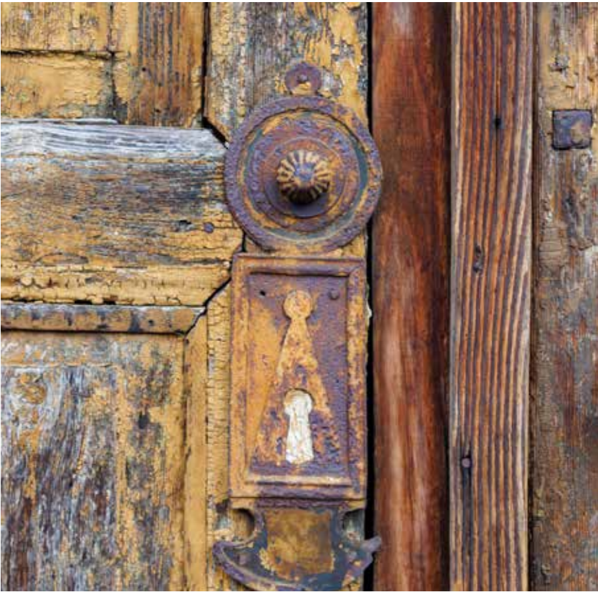
Ulaz u dvorište, detalji vratnica
