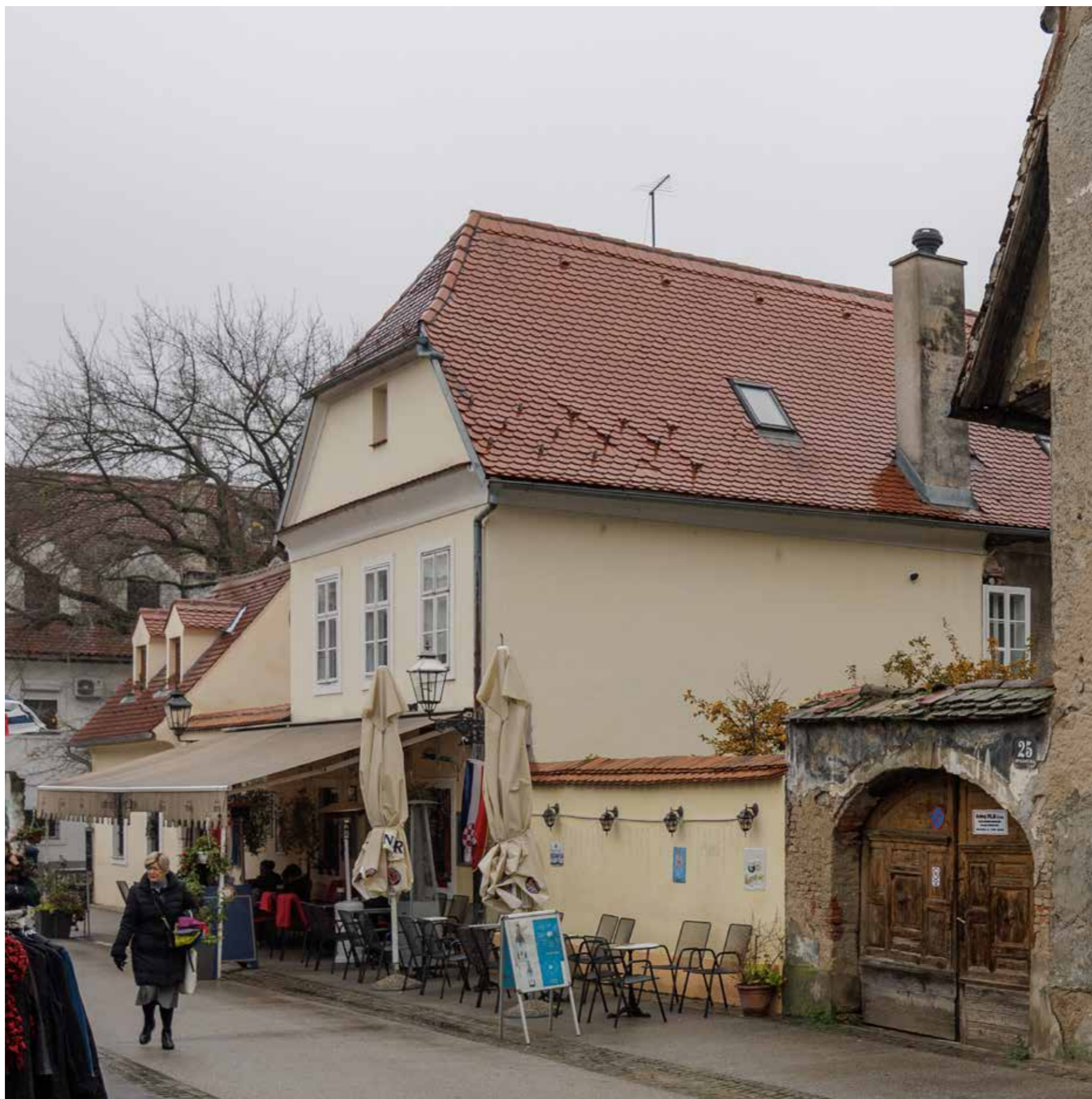
Istočno pročelje glavne kuće
