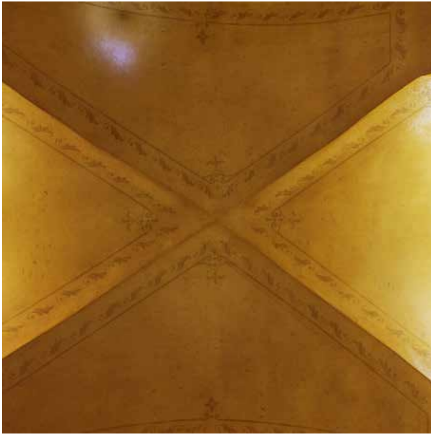
Svod u prizemlju
