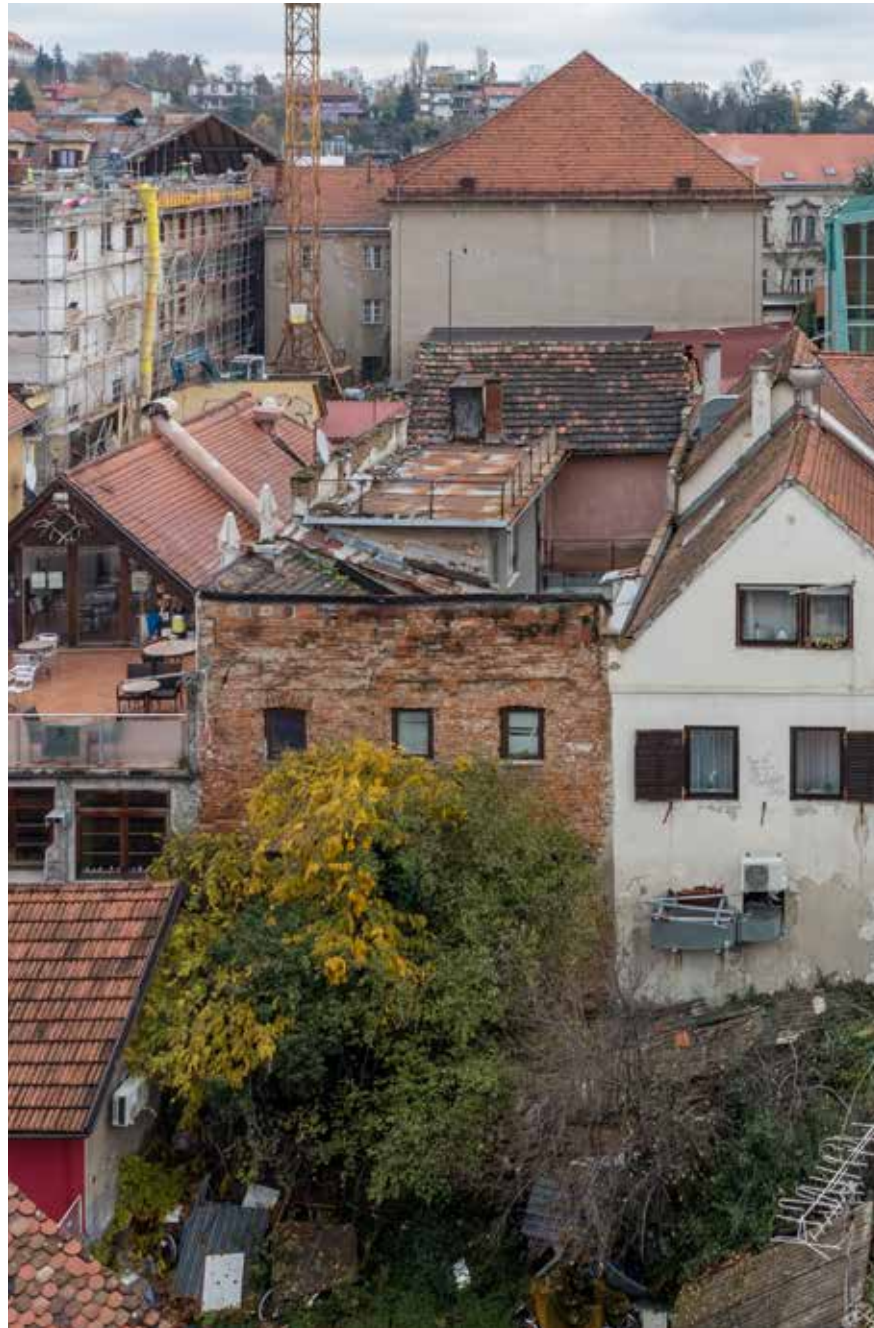
Zapadno začelje na gradskom zidu
