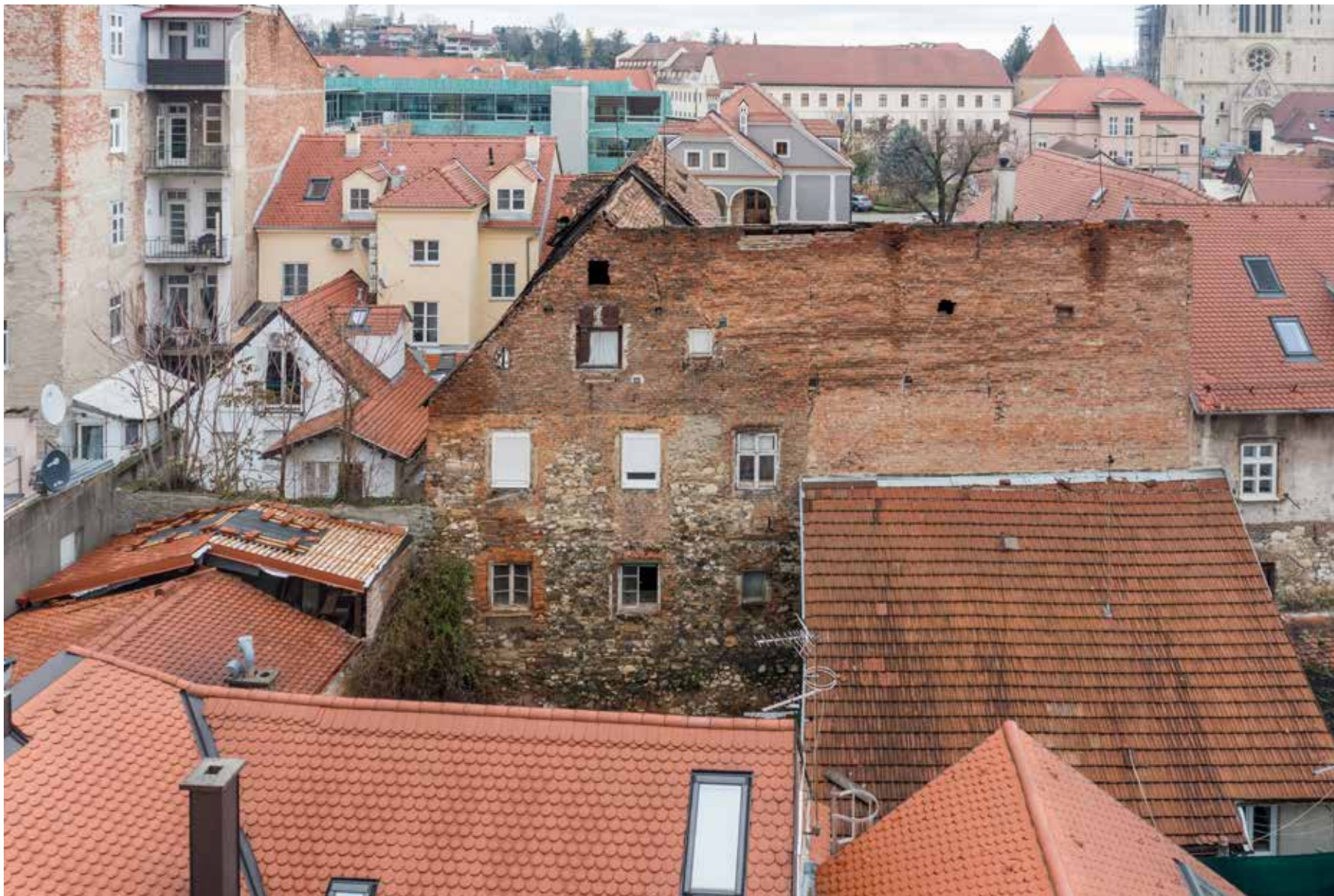
Zapadno začelje na gradskom zidu
