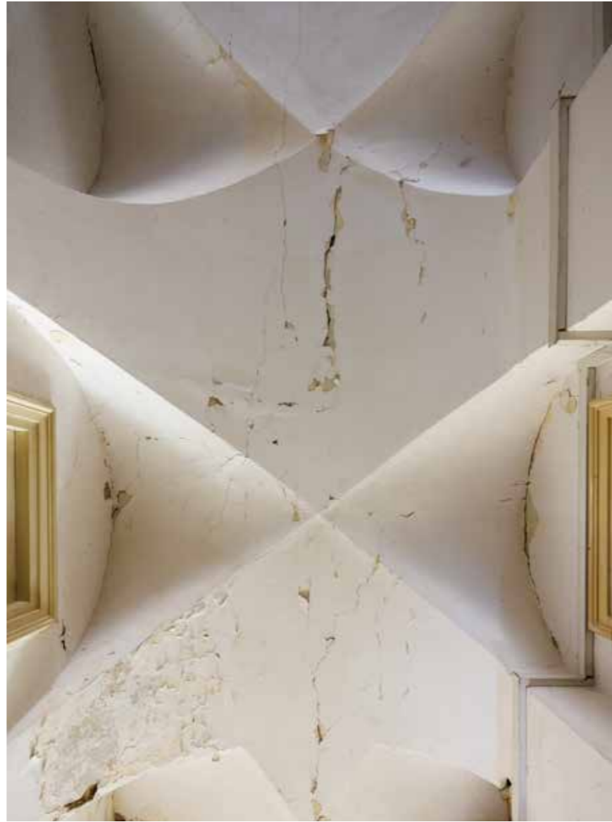
Kuća Miletić (kbr. 11), svodovi u veži
