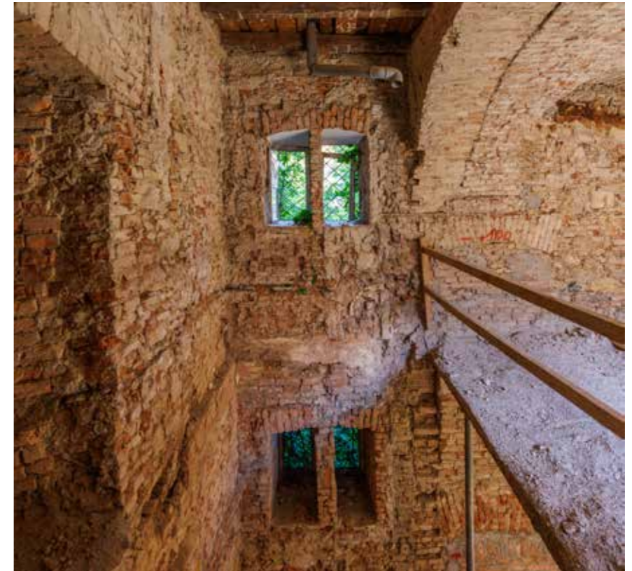
Otvori na katu
