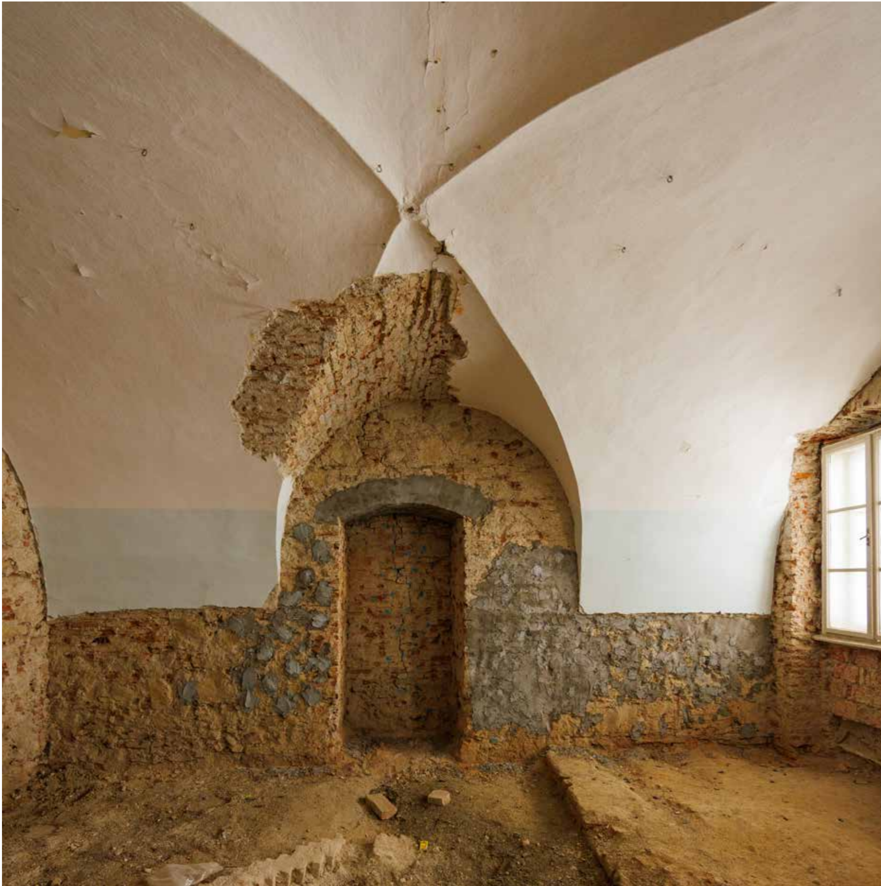
Svod u prizemlju
