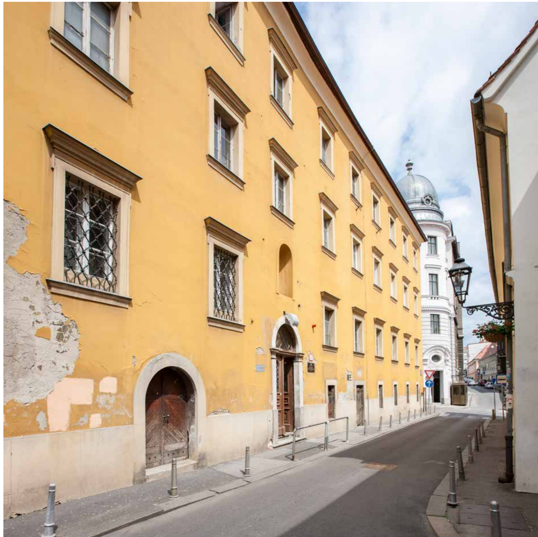
Isusovačko sjemenište sv. Josipa, pročelje u Habelićevoj ulici
