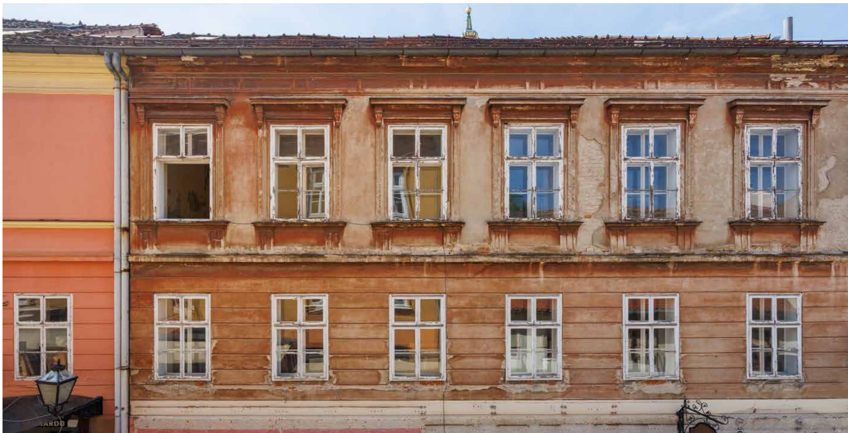
Kuća Miletic (kbr. 11), pročelje dograđenog krila u Skalinskoj ulici, Janko Jambrišak, 1881.
