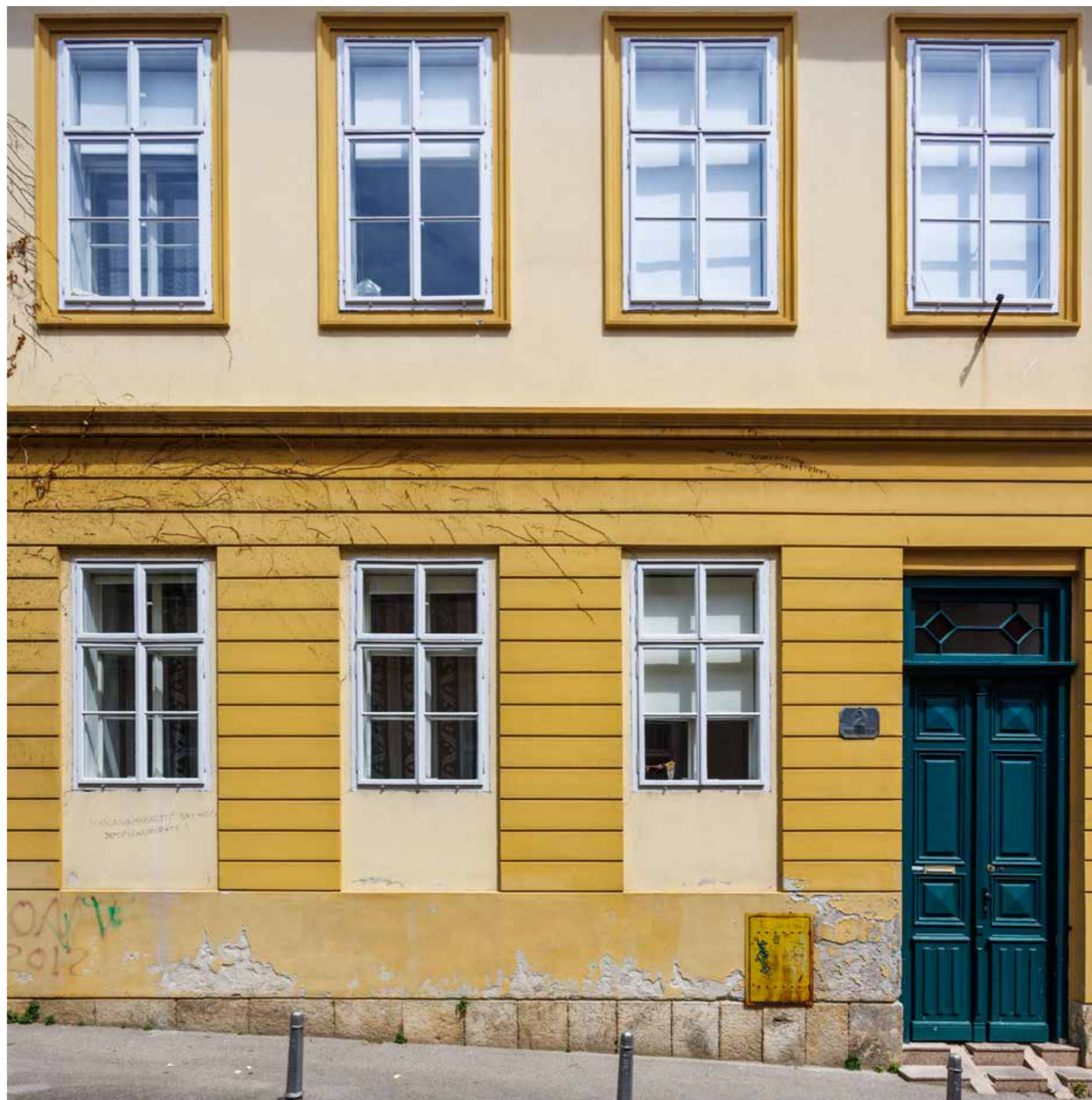
Južno pročelje, detalj
