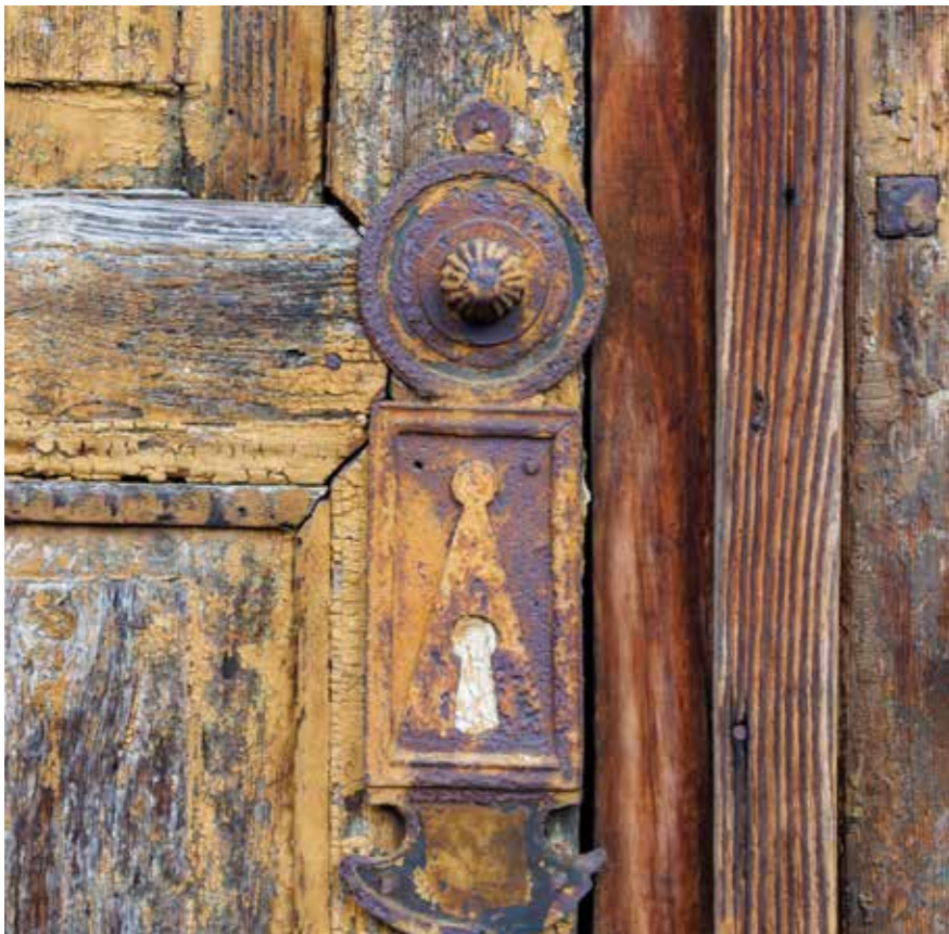
Ulaz u dvorište, detalji vratnica
