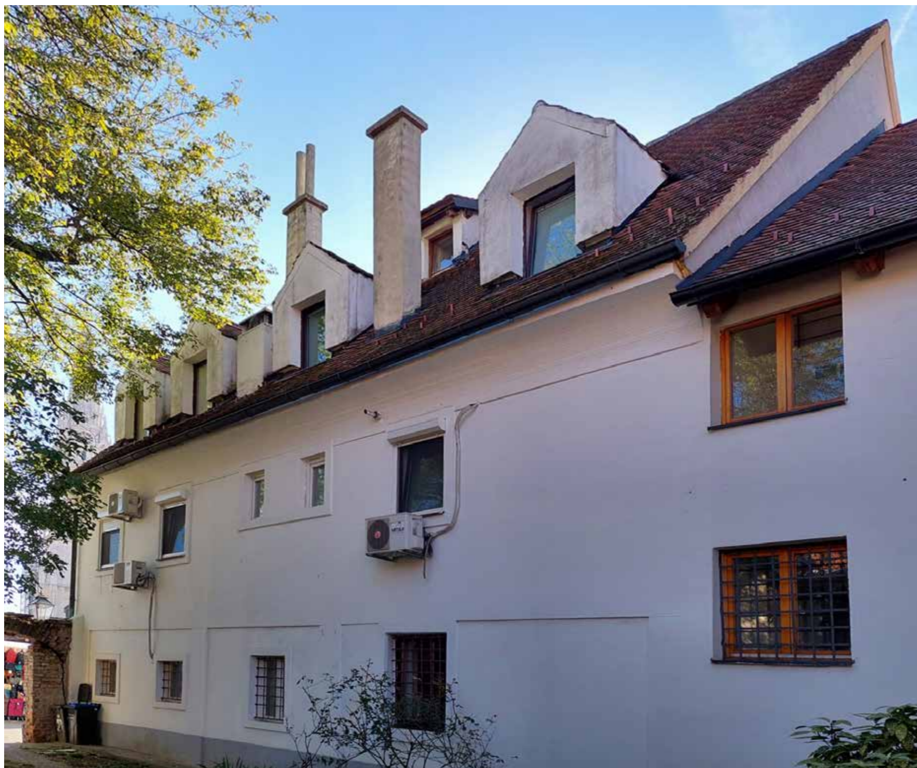
Sjeverno pročelje u dvorištu susjedne kuće
