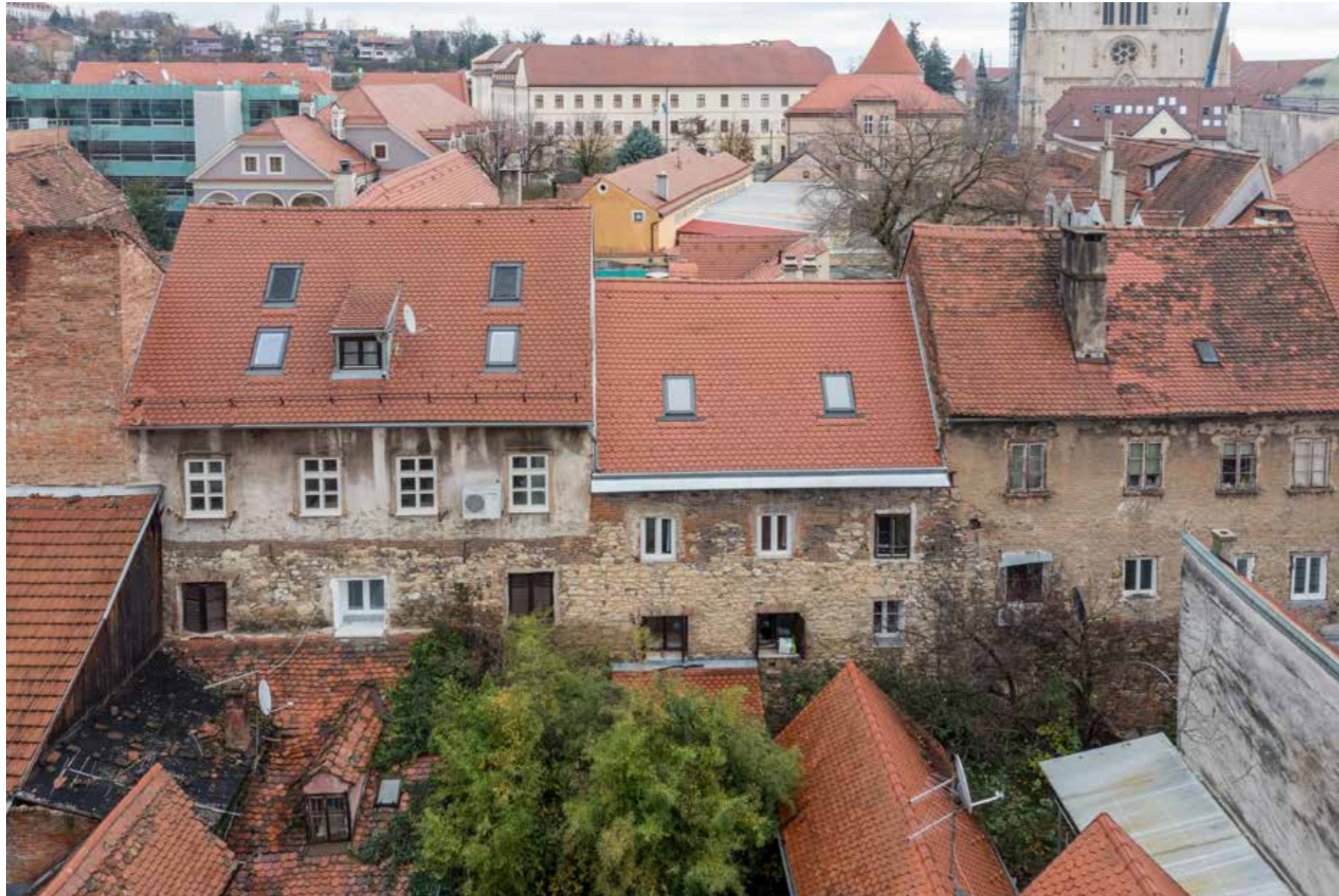
Zapadno začelje na gradskom zidu
