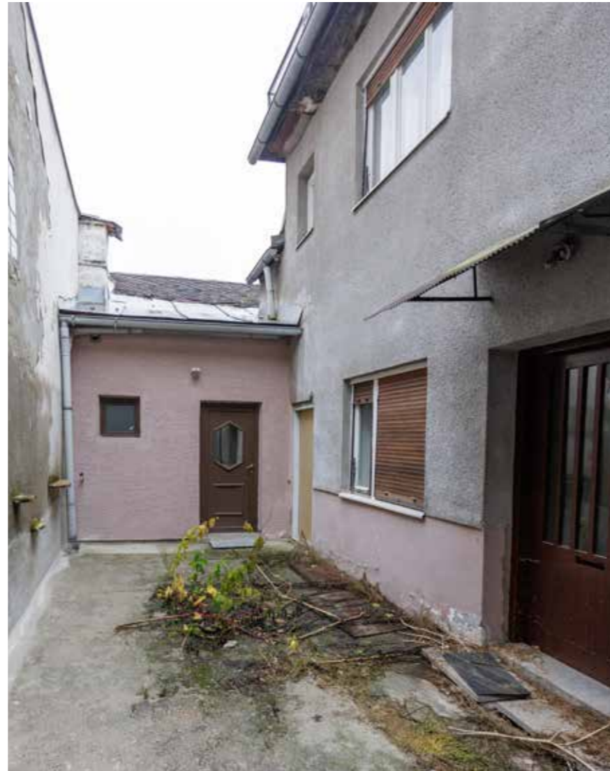
Južno pročelje i prigradnja u dvorištu
