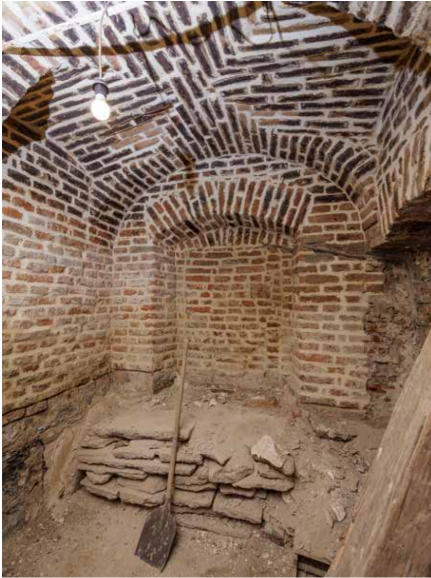
Kuća Fuchs-Devidé (kbr. 25), nadsvođena prostorija u podrumu
