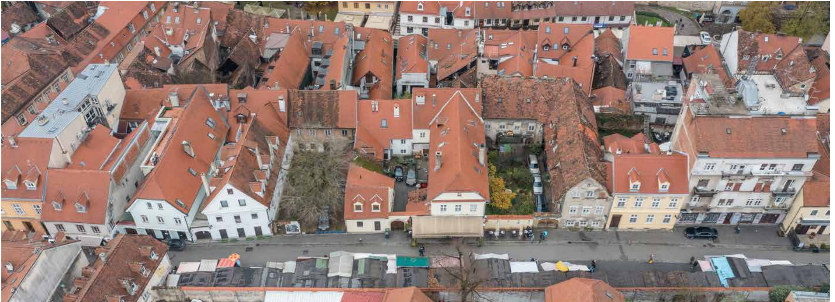
Opatovina, pogled s istoka (kbr. 15–29)
