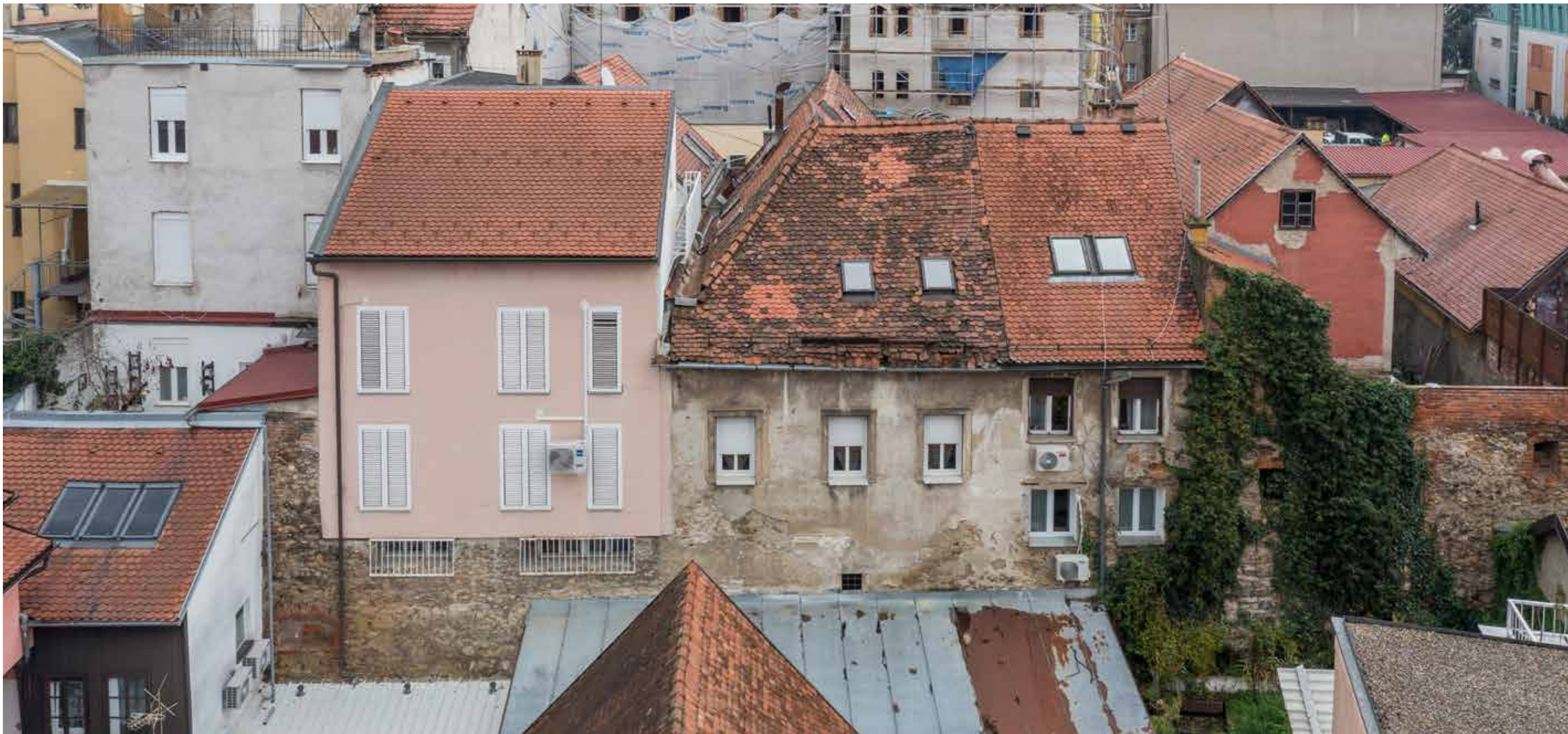
Zapadno začelje na gradskom zidu
