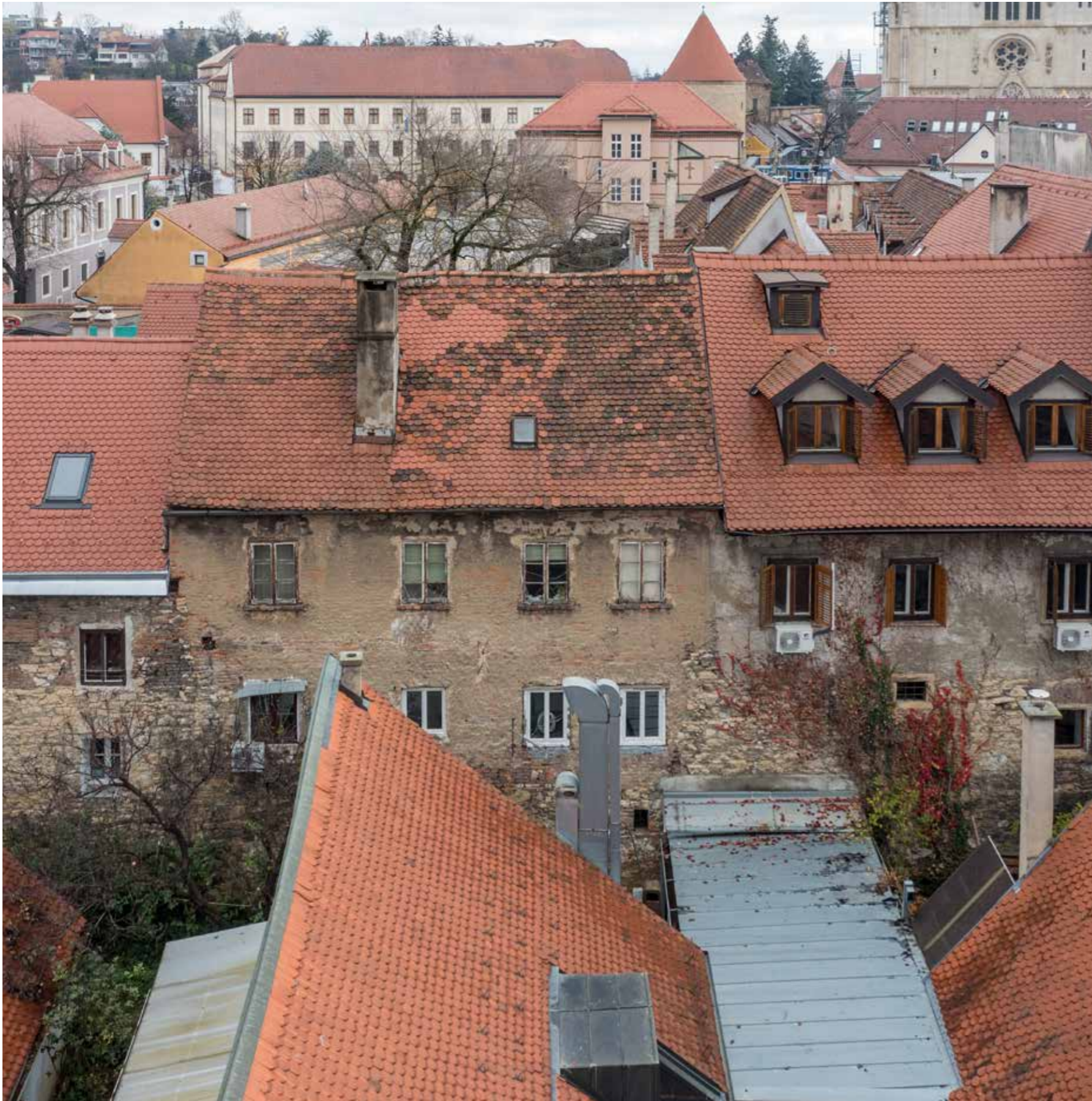
Zapadno začelje na gradskom zidu
