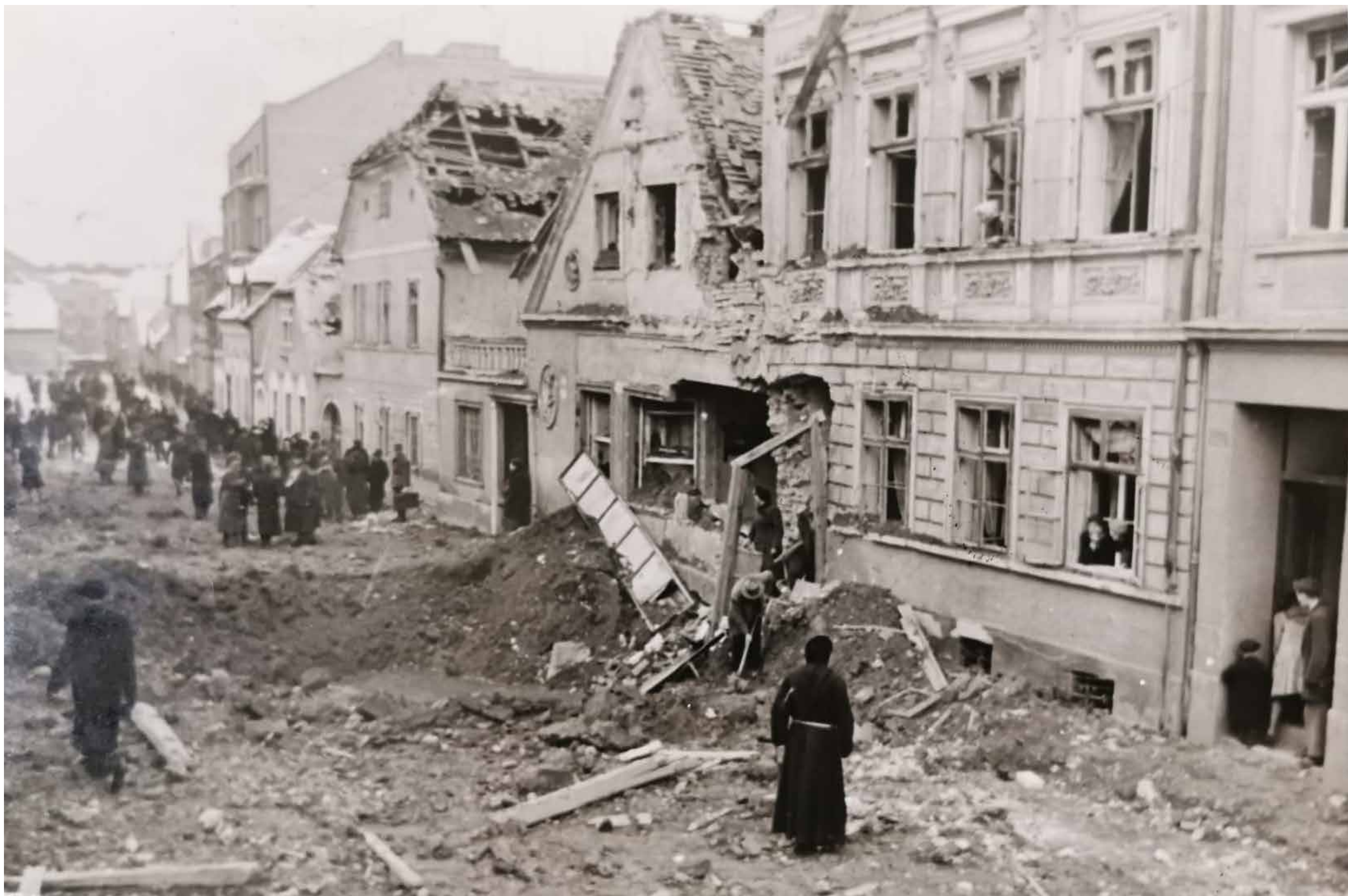
Opatovina (kbr. 31–37), oštećenja nastala u bombardiranju 1944. godine
