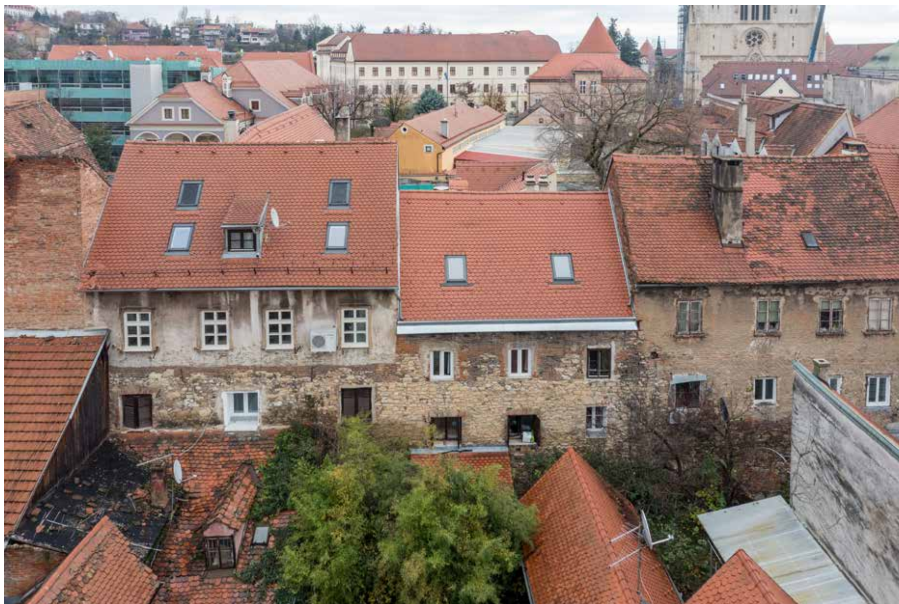
Zapadno začelje na gradskom zidu
