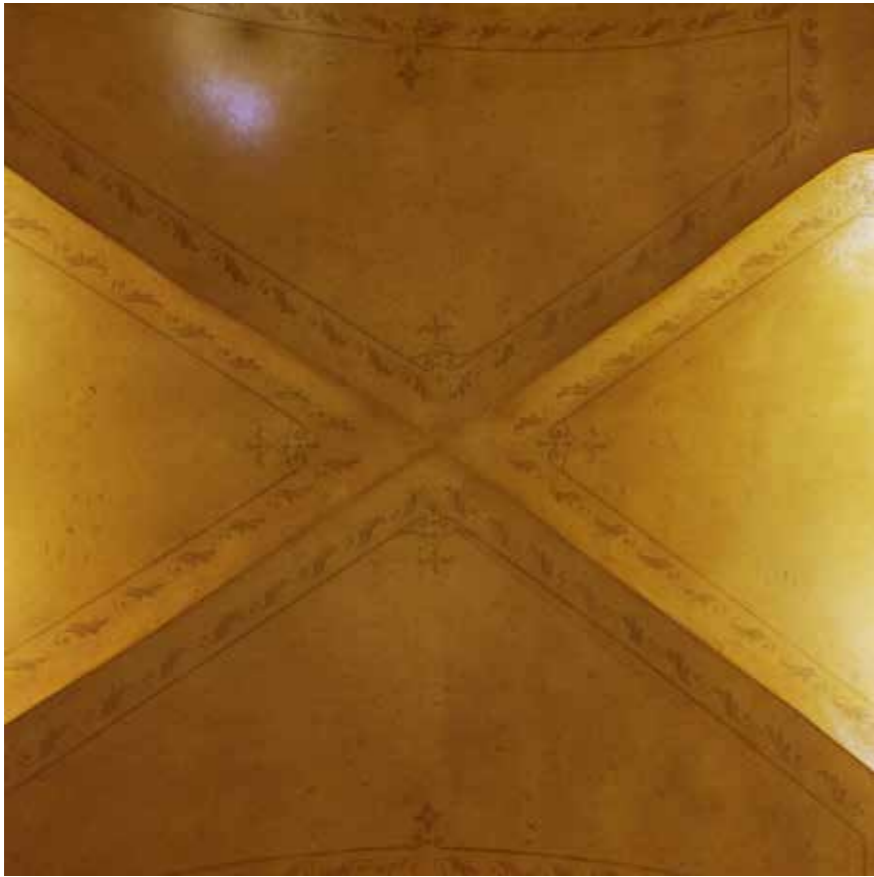
Svod u prizemlju
