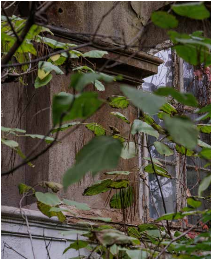
Trijem na dvorišnom pročelju, detalj
