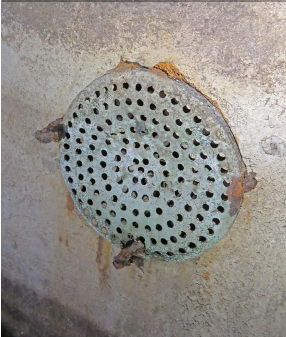
Odvodna cijev za željeznicu na sniženoj razini u malom (južnom) spremniku. (foto: G. Nikšić)
