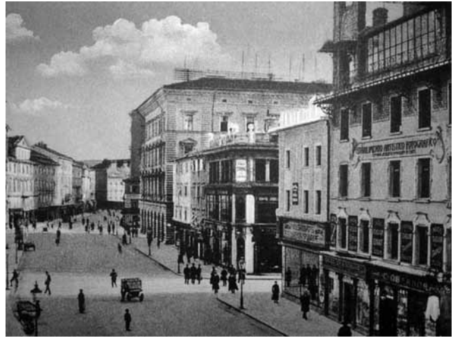
2. Kuća Schittar u Rijeci s ostakljenom atikom potkrovlja za smještaj fotoateljea; autor projekta adaptacije E. Ambrosini (iz zbirke V. Hreljanovića)
