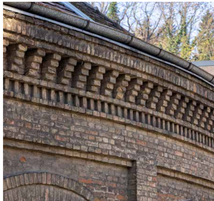
Sjeverna zgrada Šibenik, detalj vijenca
