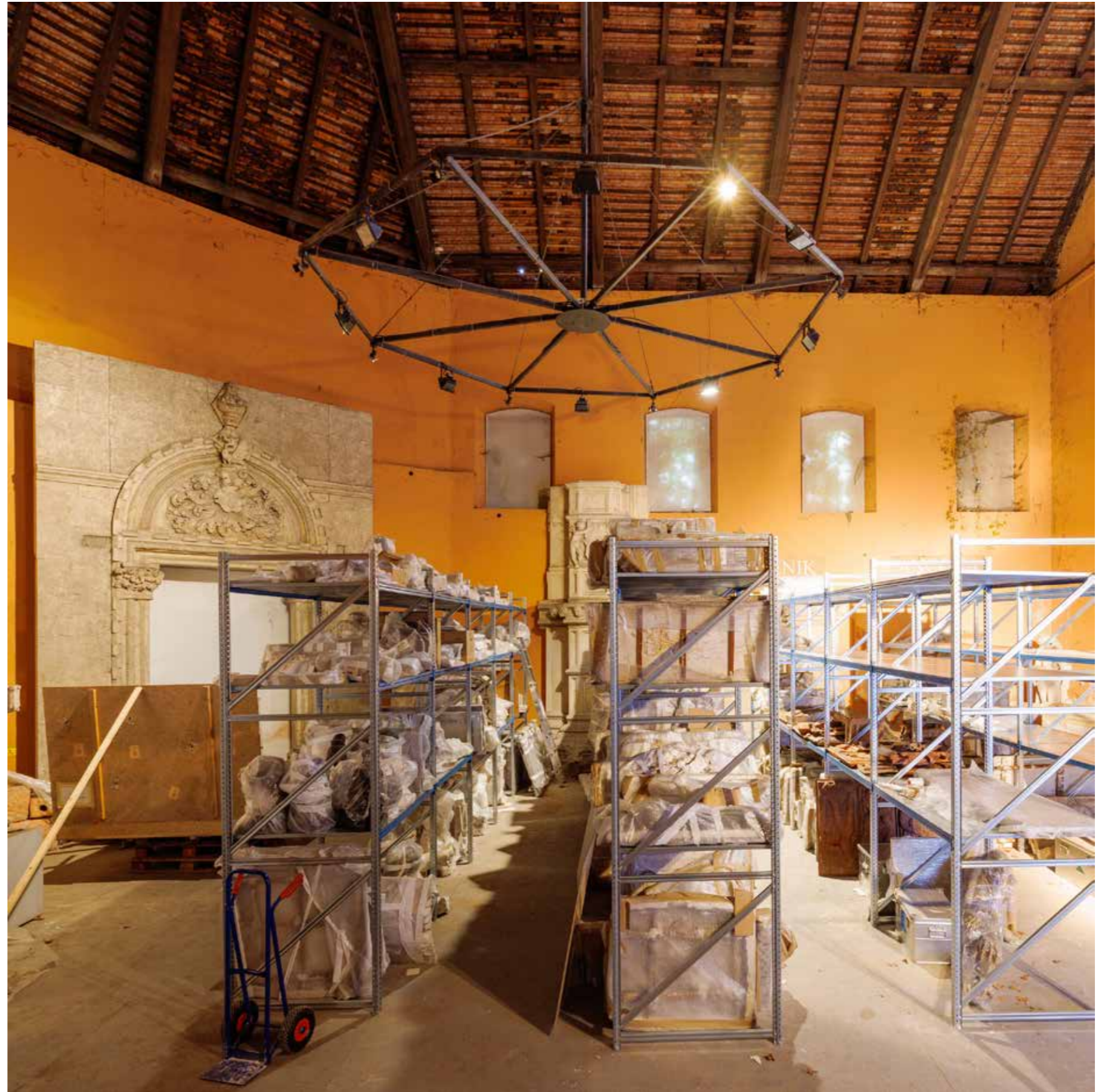
Sjeverna zgrada Šibenik, krovšte objekta kotlovnice
