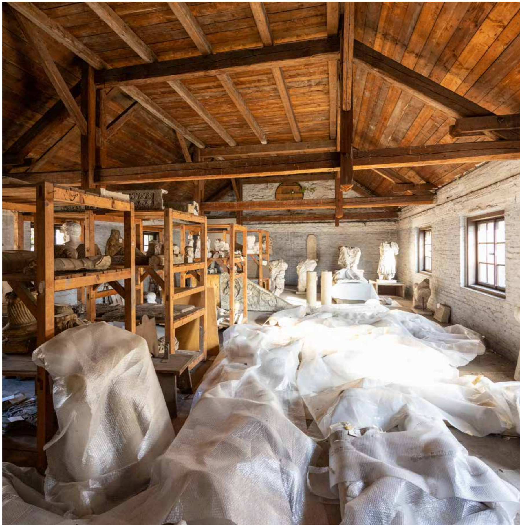
Južna zgrada Antika, krovništvo južnog krila
