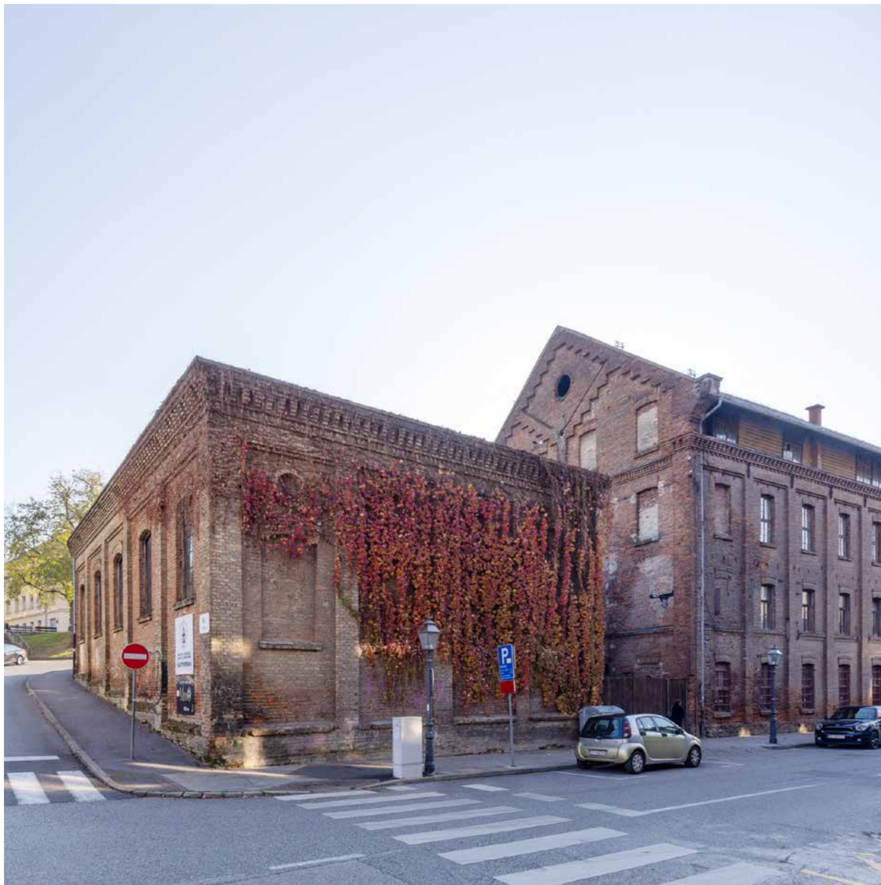
Sjeverna zgrada Šibenik, pogled na zapadno i sjeverno pročelje sa zapada
