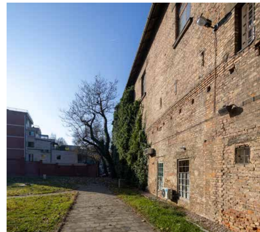
Južna zgrada Antika, pogled na južno pročelje
