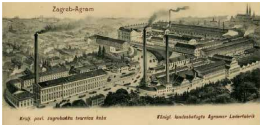
Zagrebačka tvornica kože, foto: Rudolf Mosinger, oko 1900. MGZ-fot-4500
