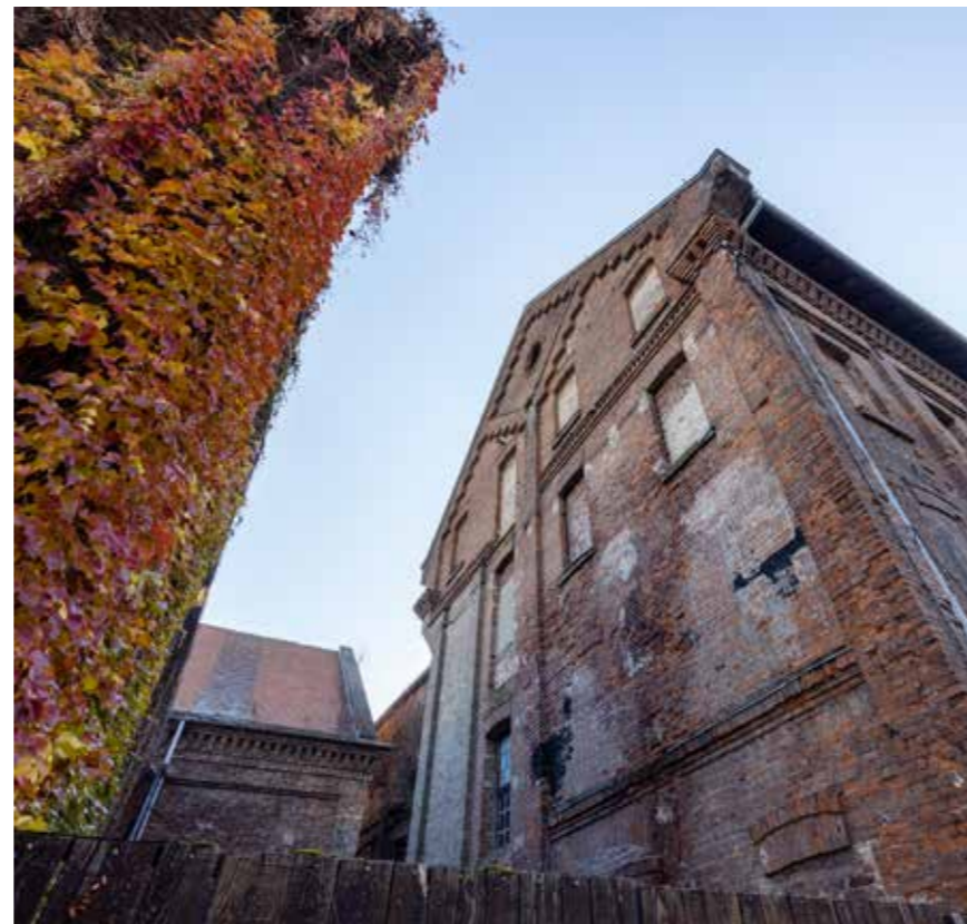
Zapadna ulična zgrada, pogled na sjeverno pročelje
