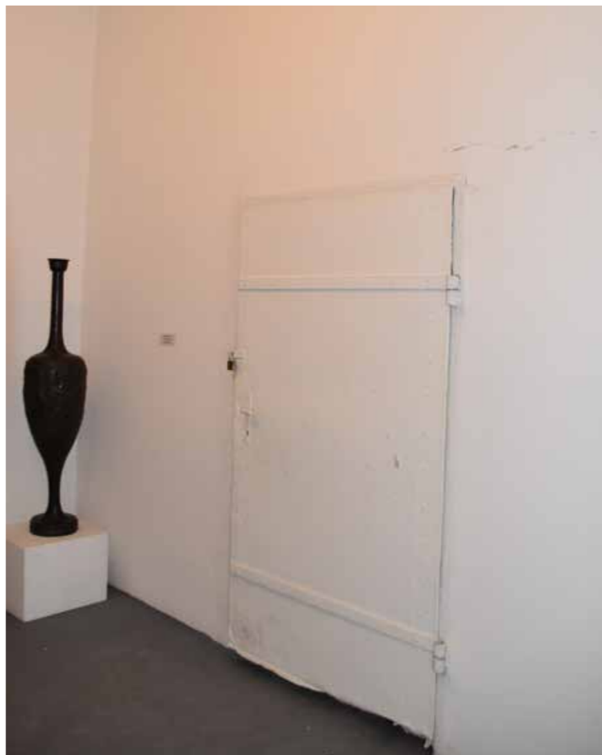
Željezna vrata, istočna zgrada
