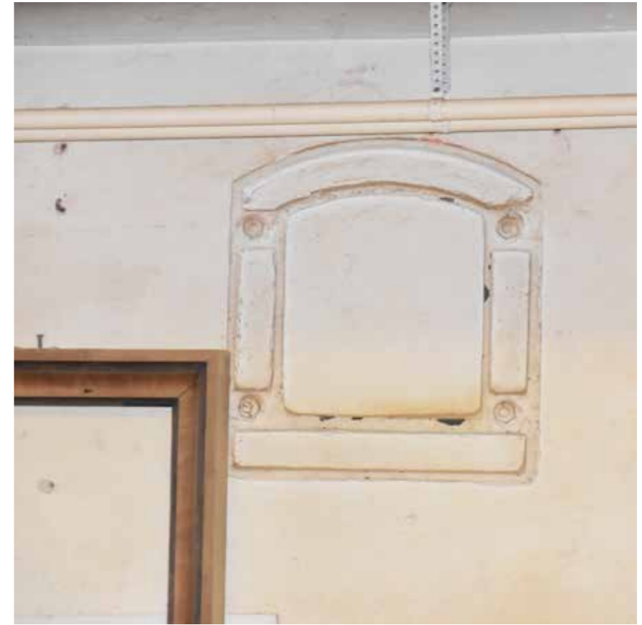
Željezni otvor, zapadna zgrada
