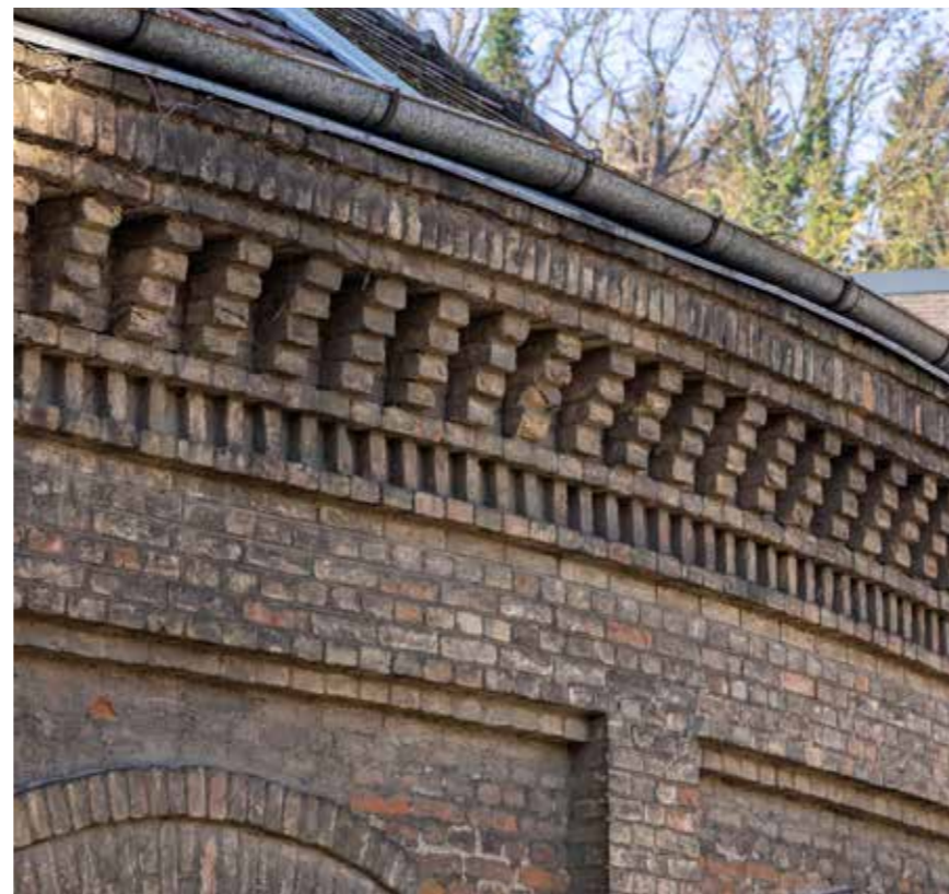
Sjeverna zgrada Šibenik, detalj vijenca
