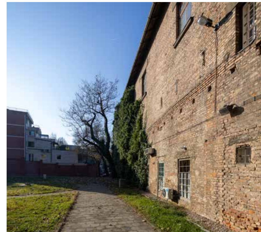
Južna zgrada Antika, pogled na južno pročelje
