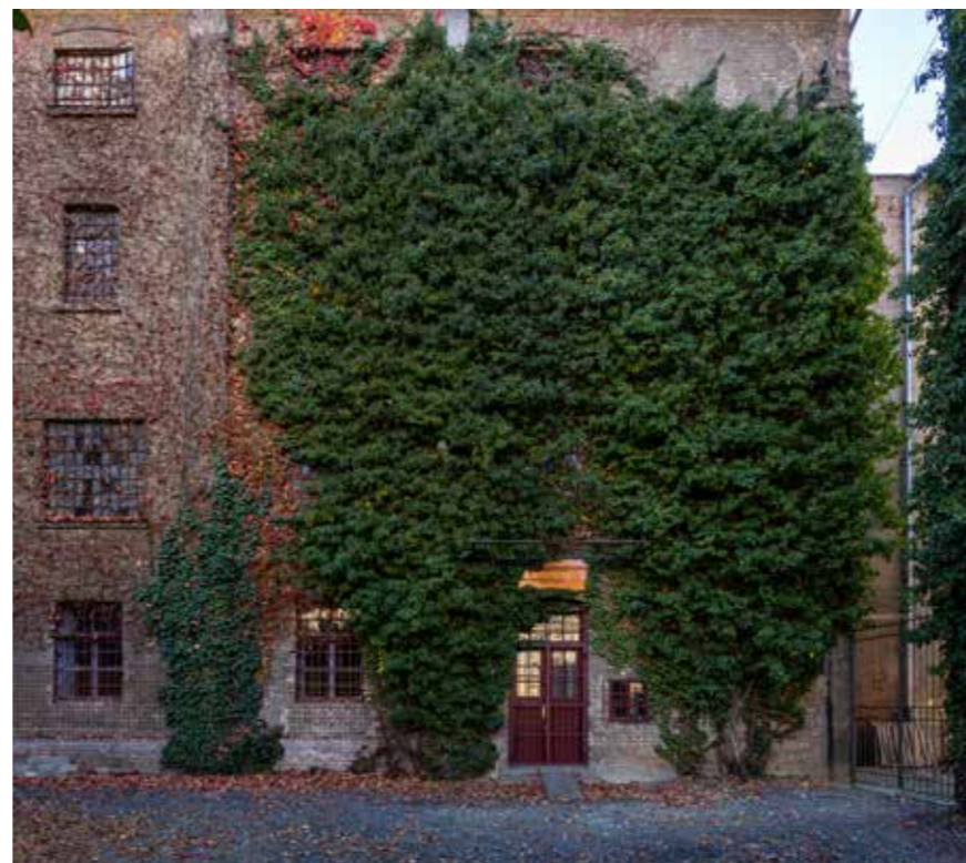
Istočna dvorišna zgrada, pogled na ulaz u prizemne dvorane središnjeg krila
