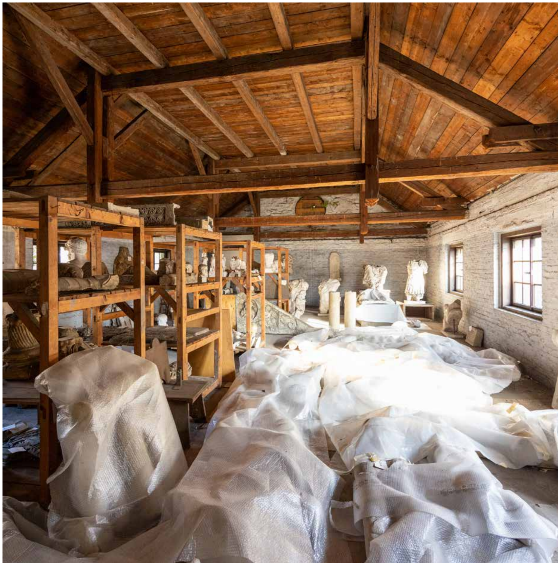
Južna zgrada Antika, krovništvo južnog krila
