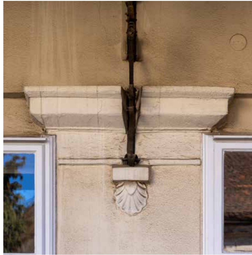
Zapadno pročelje, detalj prizemlja središnjeg rizalita
