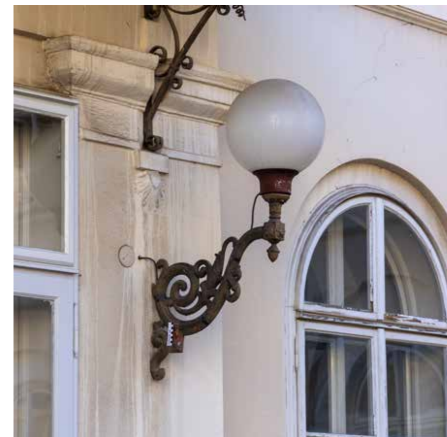
Zapadno pročelje, detalj prizemlja središnjeg rizalita
