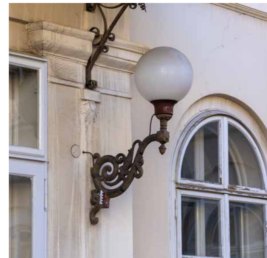
Zapadno pročelje, detalj prizemlja središnjeg rizalita
