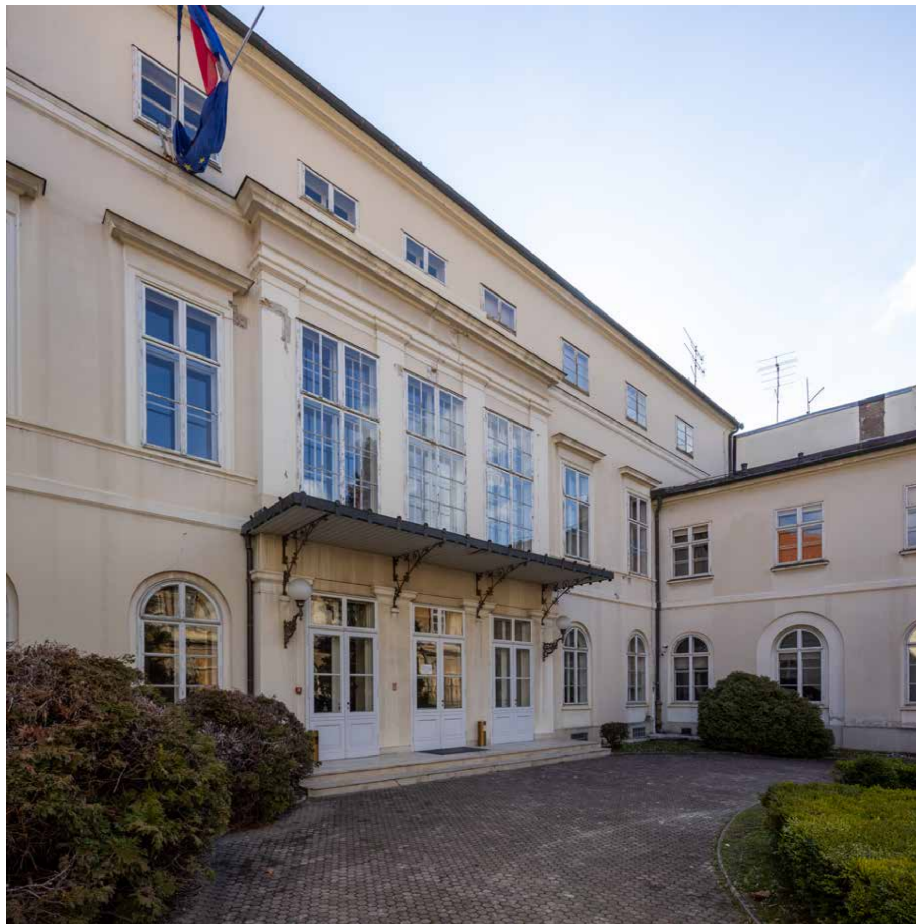
Pogled na zapadno pročelje
