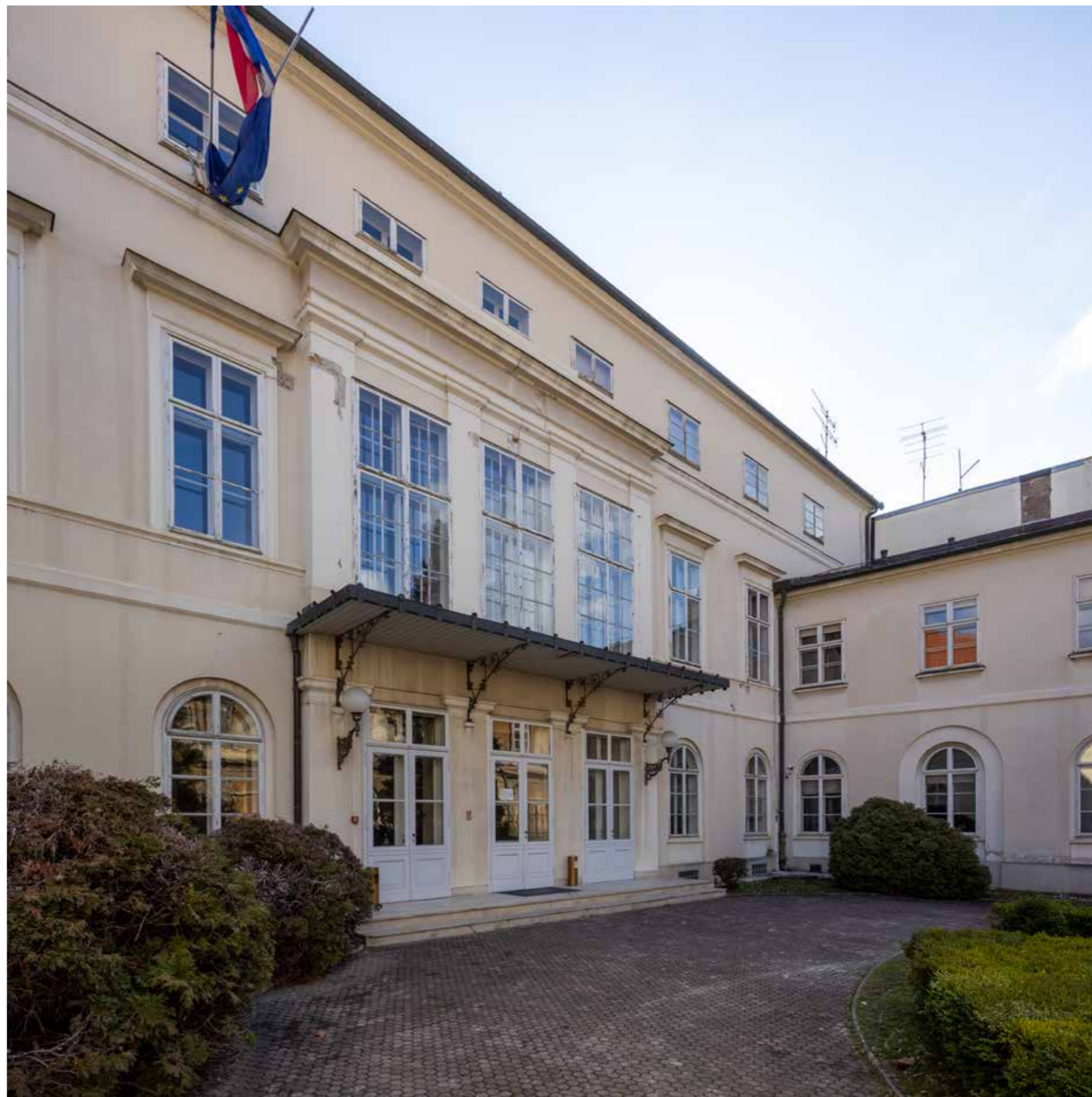
Pogled na zapadno pročelje
