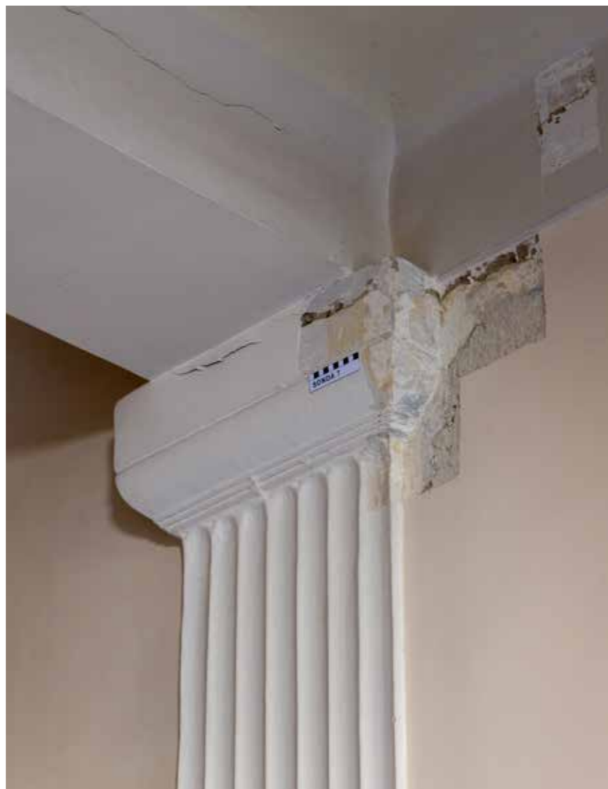
Arhitektonska plastika južnog zida predvorja, detalj kapitela pilastra
